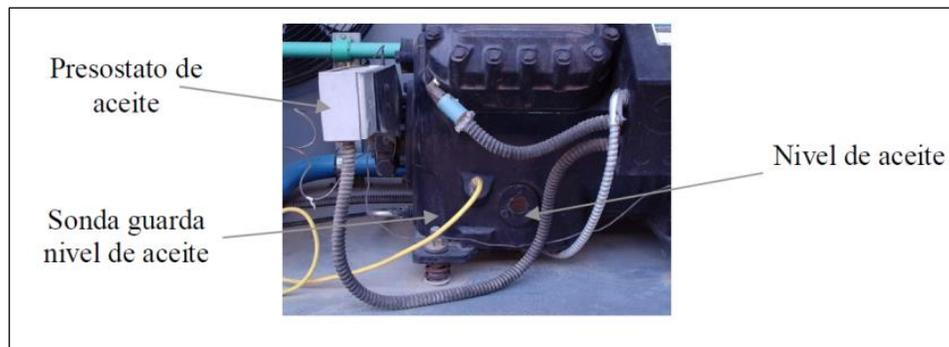
*Nota:* Componentes de un sistema de control de aceite en un compresor.
