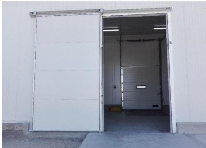
*Nota:* Las puertas frigoríficas correderas pueden ser apertura manual o apertura motorizada, según el requerimiento y la necesidad. Fuente: Infracá.
