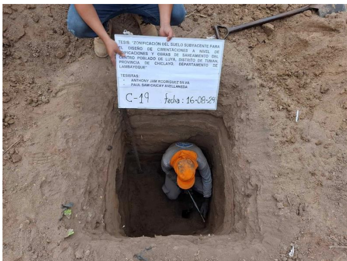
Foto N°9: Uso de posteadora en calicata 19.
