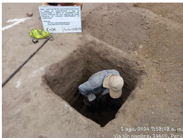
Foto N°3: Excavación de calicata 1.
