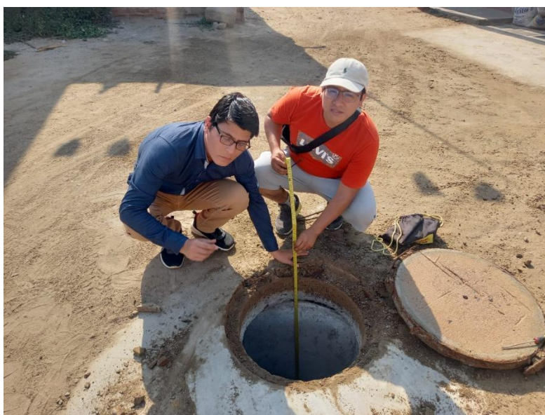
Foto N°18: Medición de la profundidad de los buzones de desagüe en C.P. Luya – Tumán.
