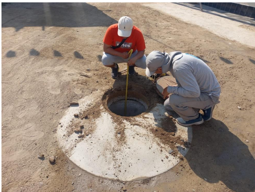
Foto N°17: Medición de la profundidad de los buzones de desagüe en C.P. Luya – Tumán.
