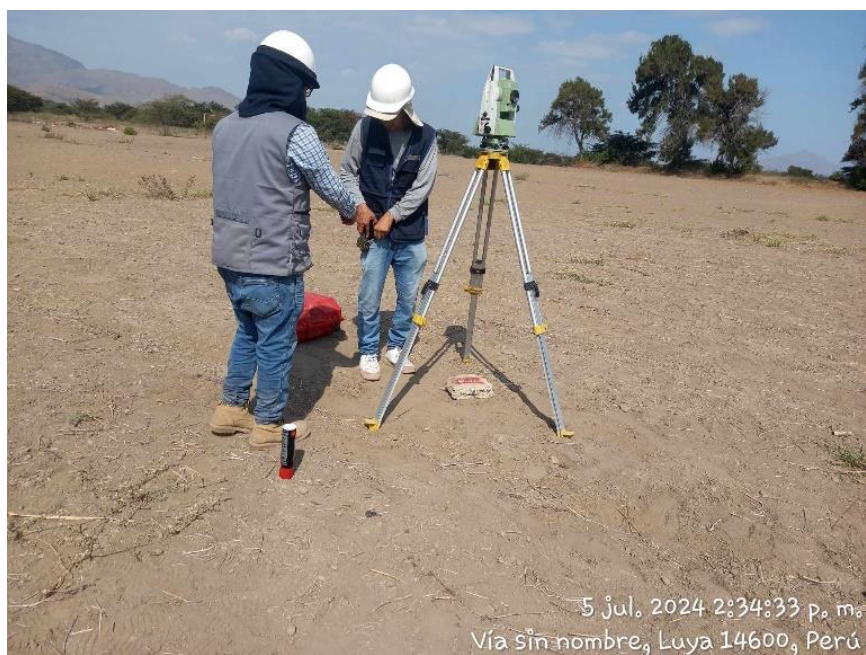
Foto N°1: Levantamiento Topográfico C.P. Luya – Tumán.
