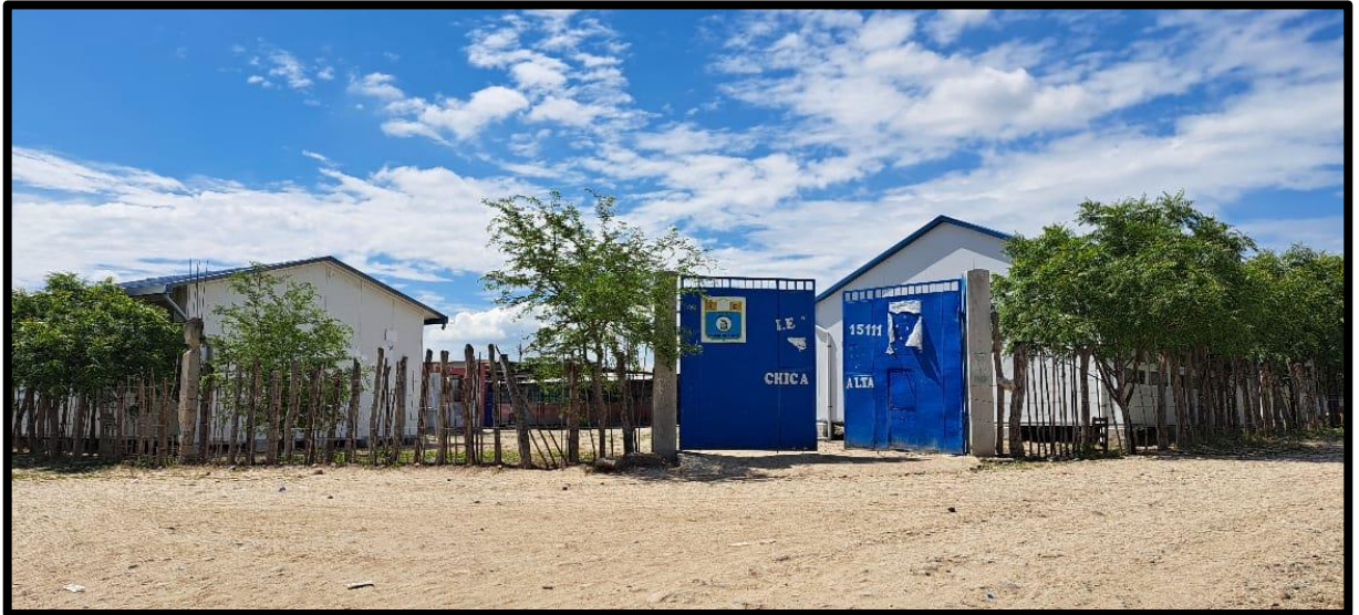
Portón de acceso del local del nivel primario
