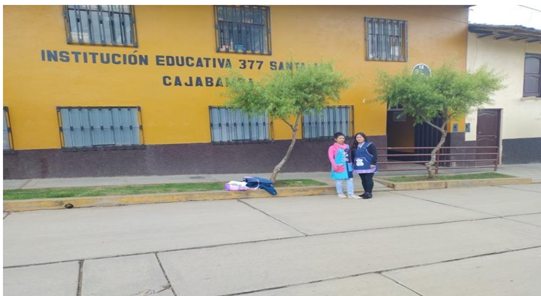
Figura N. 8 En la Fachada del colegio
