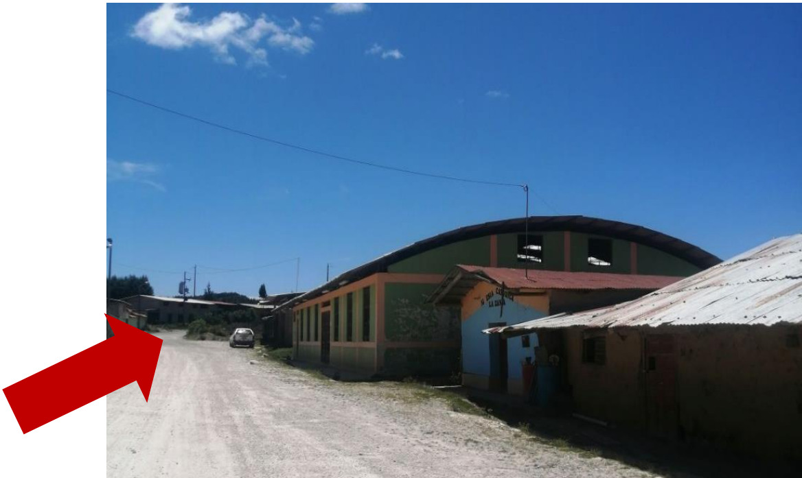
Nota: Entrada al Caserío La Zanja
