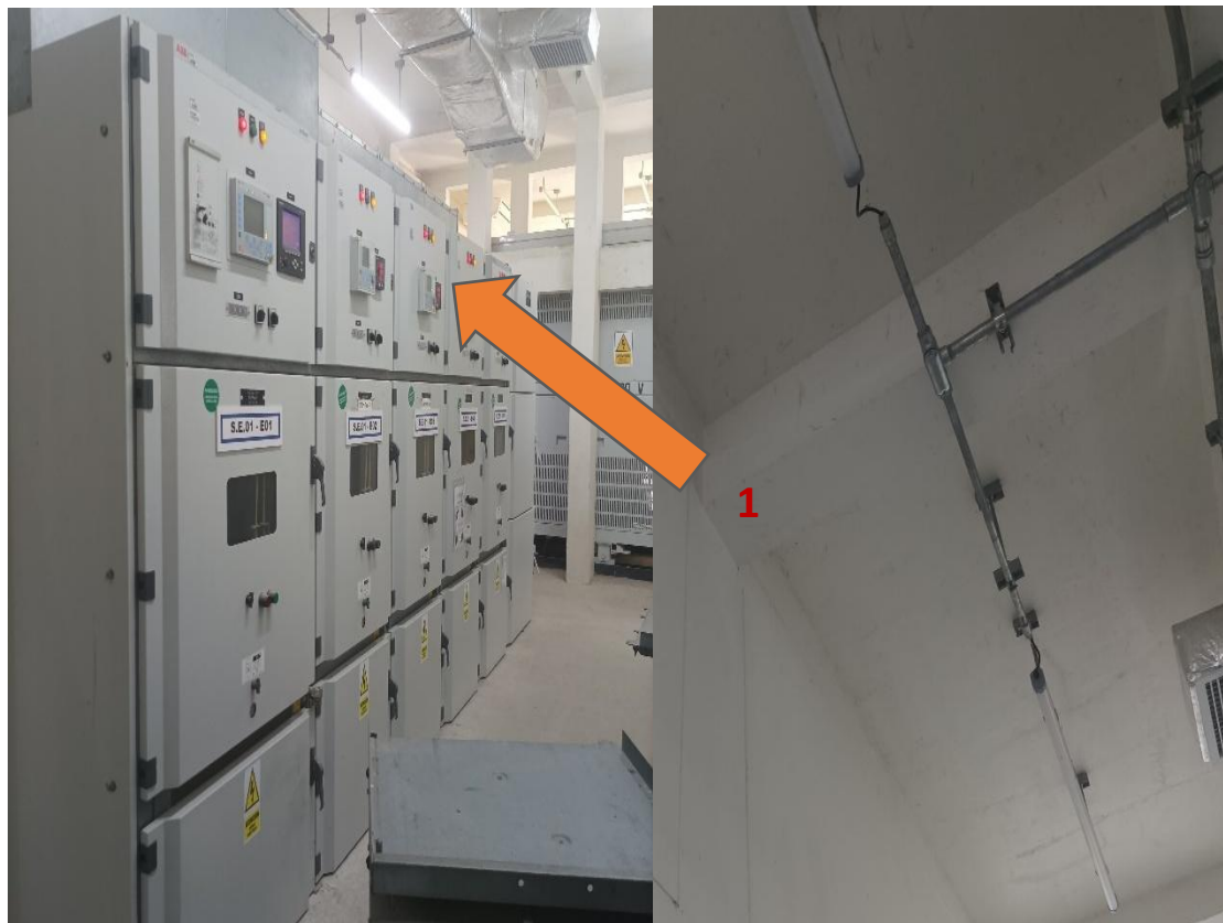
Figura 40. Ubicación para Cámara N°1 en Sala Eléctrica
