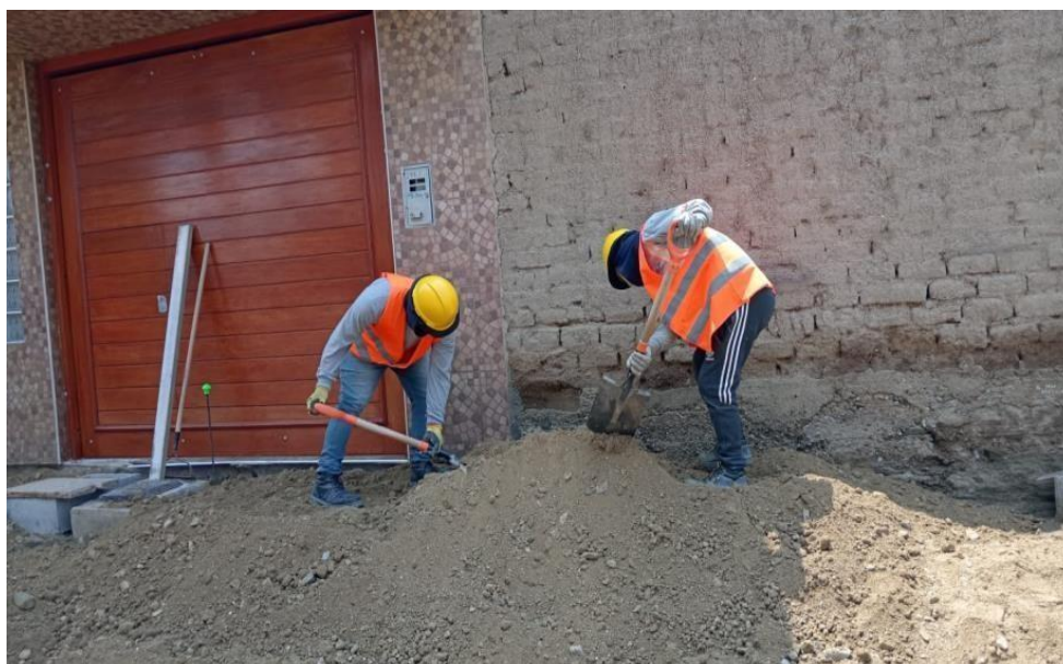
Fotografía 30: NIVELACION Y COMPACTACION DE TERRENO NATURAL
