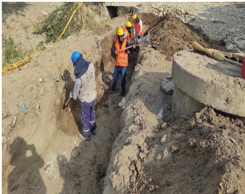
Fotografía 45: CORTE SUPERFICIAL MANUAL SARDINEL DE CONTENCIÓN
