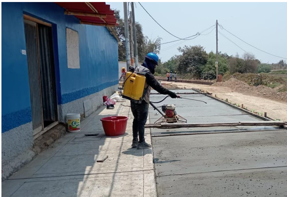
Fotografía 28: CURADO DE CONCRETO CON ADITIVO SIK
