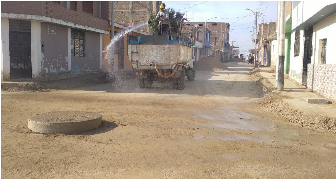
Fotografía 12: RIEGO CON CISTERNA EN CAPA DE AFIRMADO.
