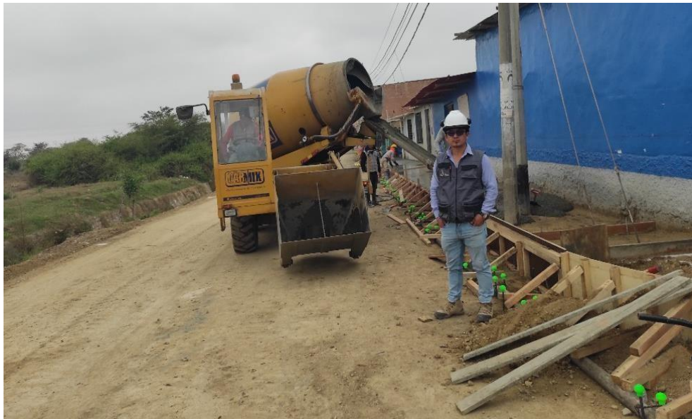
Fotografía 38: VACIADO DE CONCRETO f'_c=175 kg/cm 2 PARA VEREDAS
