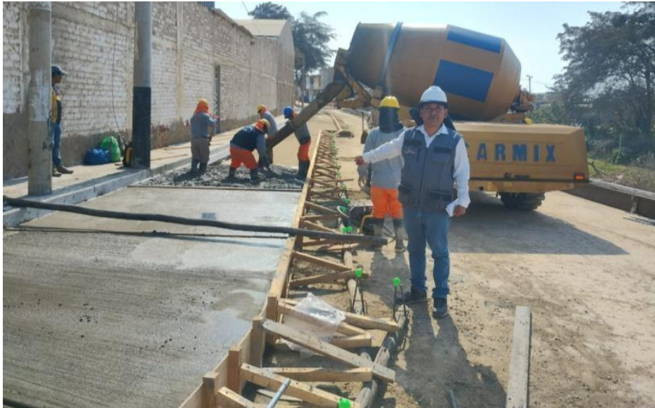
Fotografía 25: VACIADO DE MEZCLA DE CONCRETO F'C = 210 \text{ KG/CM}^2 EN PAVIMENTOS E = 0.20 \text{ M}
