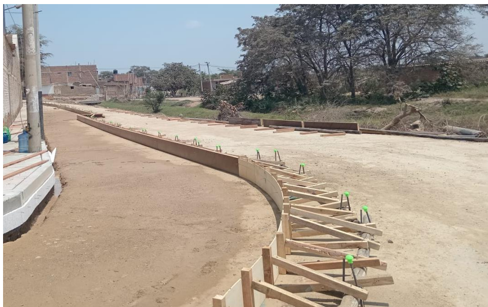
Fotografía 16: ENCOFRADO Y DEENCOFRADO DE PAVIMENTOS
