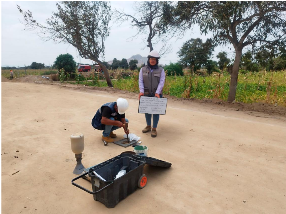
Fotografía 15: DENSIDAD DE CAMPO- EN BASE DE PAVIMENTO
