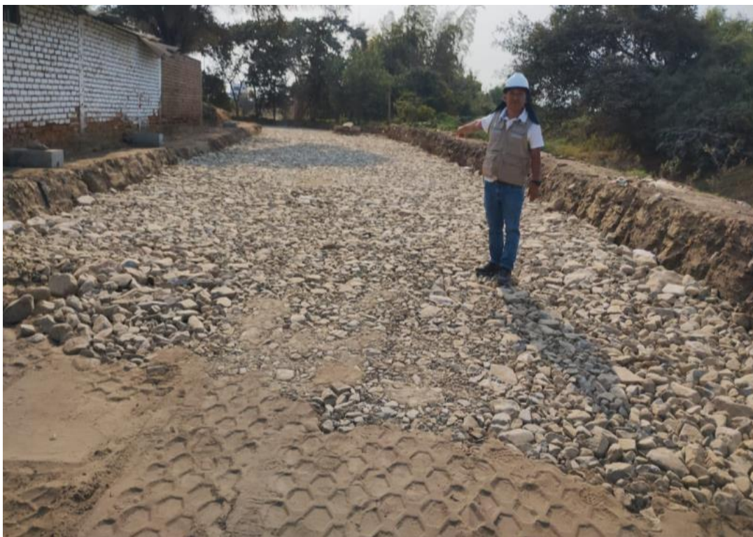
Fotografía 08: MEJORAMIENTO DE SUBRASANTE CON MATERIAL DE PRÉSTAMO OVER Y ARENA FINA PARA RELLENAR LOS VACIOS, LUEGO COMPACTADO C/EQUIPO RODILLO 10 TN.
