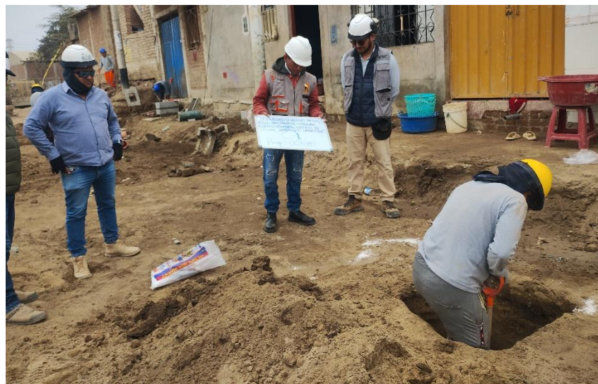
Figura 25. Calle Hipólito Unanue - Calicata N°01
