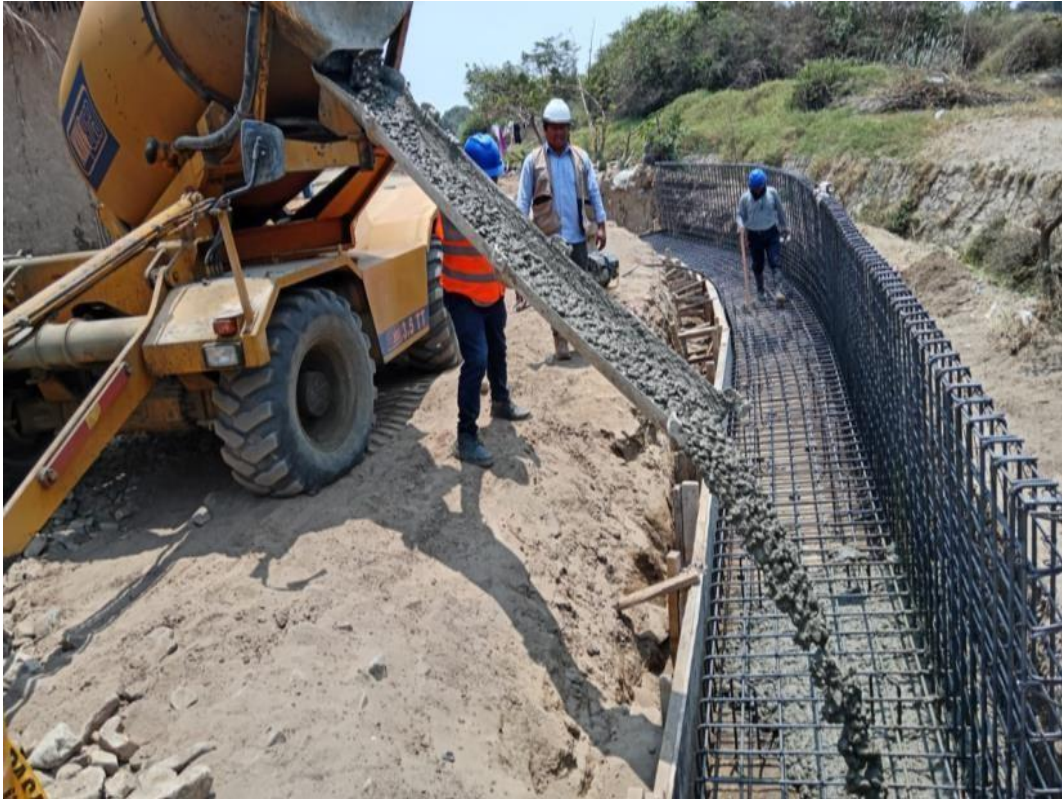
Fotografía 49: VACIADO DE CONCRETO 210KG/CM 2 EN SARDINEL DE CONTENCIÓN
