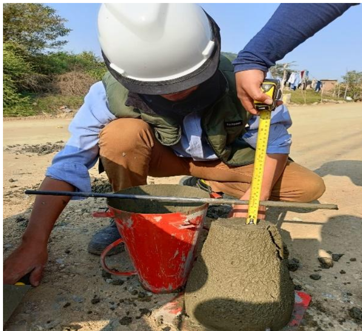
Fotografía 23: REALIZACIÓN DEL ENSAYO DEL CONO DE ABRAHAMS PARA VER EL ASENTAMIENTO DEL CONCRETO PARA PAVIMENTO.
