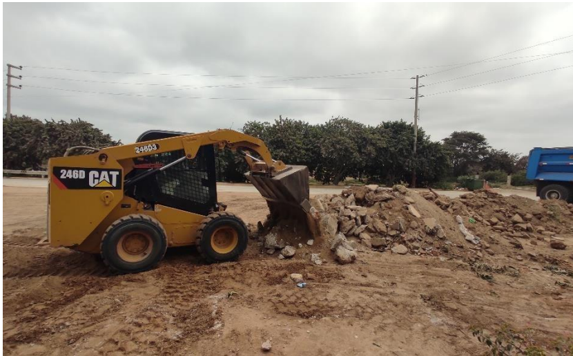
Fotografía 03: ELIMINACIÓN DE MATERIAL DE DEMOLICIÓN.
