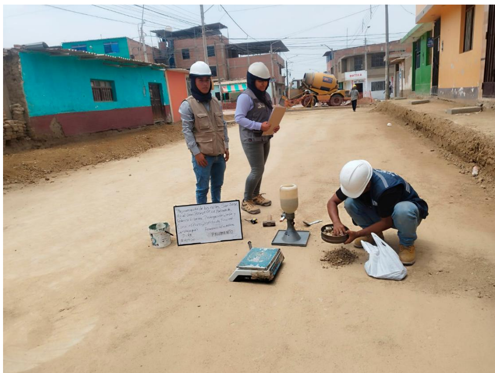
Fotografía 14: DENSIDAD IN SITU - EN BASE GRANULAR DE PAVIMENTO.
