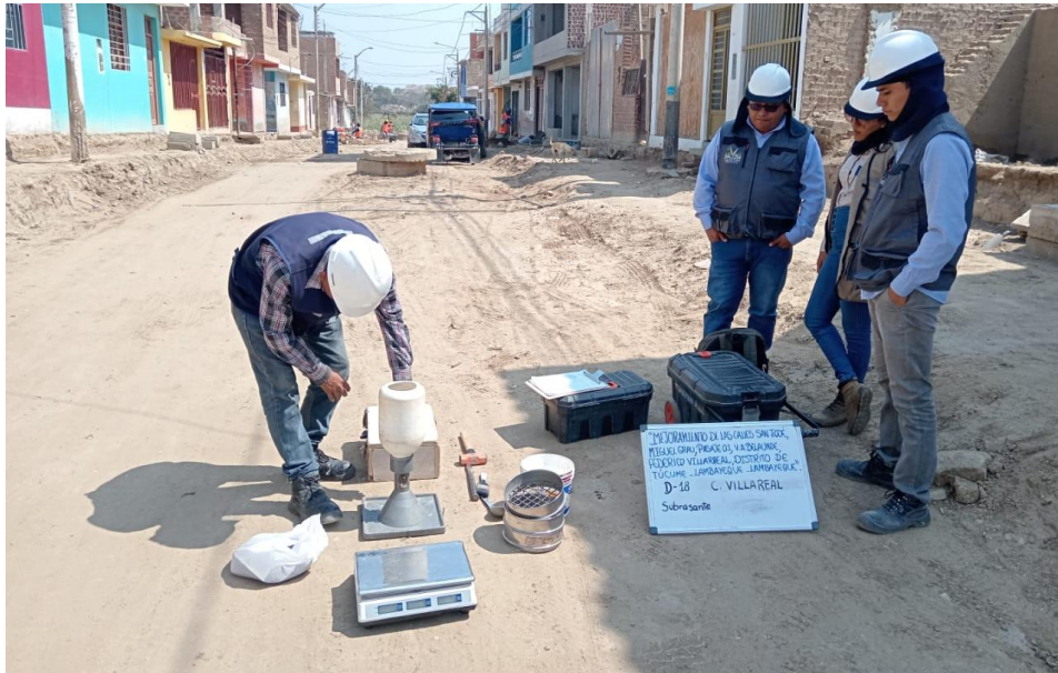
Fotografía 08: MEJORAMIENTO DE SUBRASANTE CON MATERIAL DE PRÉSTAMO OVER Y ARENA FINA PARA RELLENAR LOS VACIOS, LUEGO COMPACTADO C/EQUIPO RODILLO 10 TN.
