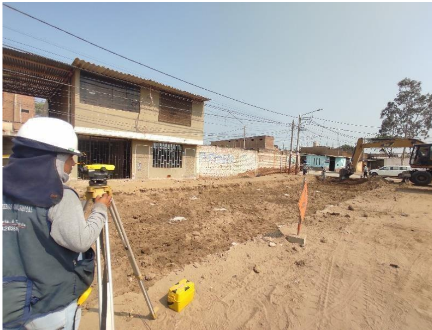
Fotografía 04: TRAZO Y REPLANTEO TOPOGRÁFICO
