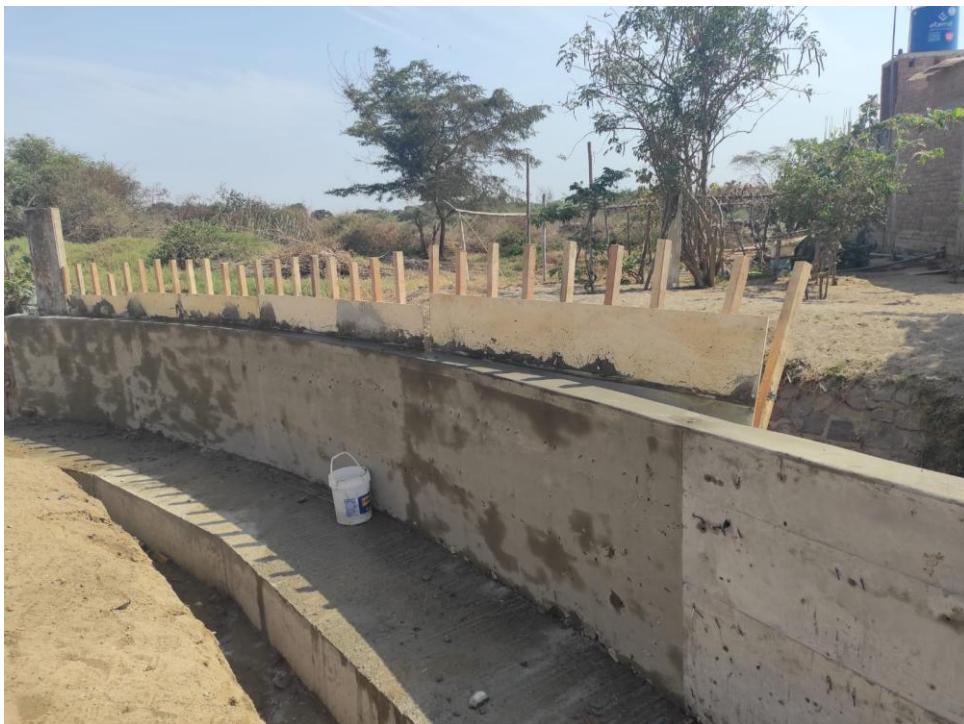
Fotografía 50: DESENCOFRADO Y CURADO CON ADITIVO QUIMICO
