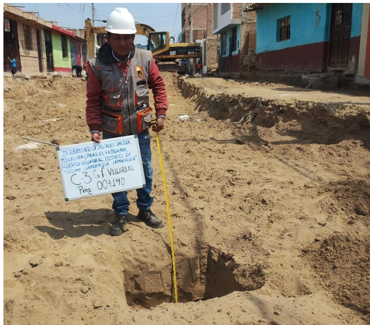
Figura 27. Calle Federico Villarreal - Calicata N°03
