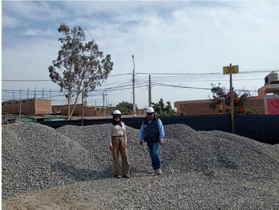
Fotografía 17: VERIFICACIÓN DE AGREGADOS EN ACOPIOS.
