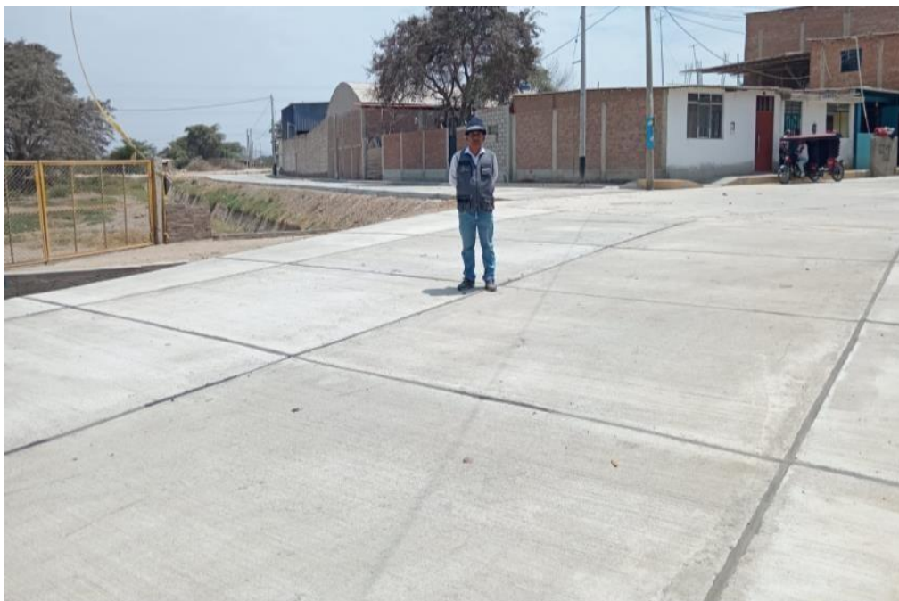
Fotografía 54: JUNTAS DE CONSTRUCCION E=1" - CON ASFALTO.
