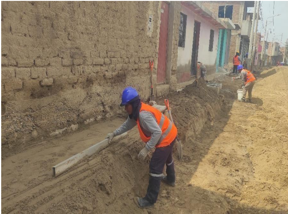
Fotografía 35: CONFORMACION, NIVELADO Y COMPACTADO CON ARENILLA, E=0.10m
