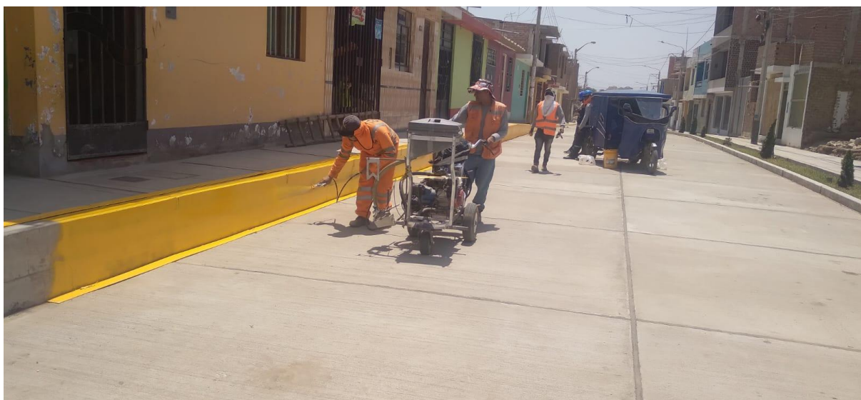
Fotografía 58: PINTURA EN VEREDAS ALTAS
