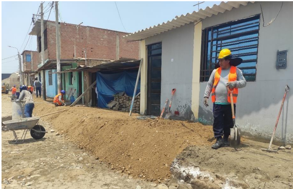
Fotografía 36: CONFORMACION, NIVELADO Y COMPACTACIÓN DE AFIRMADO, E=0.10m .
