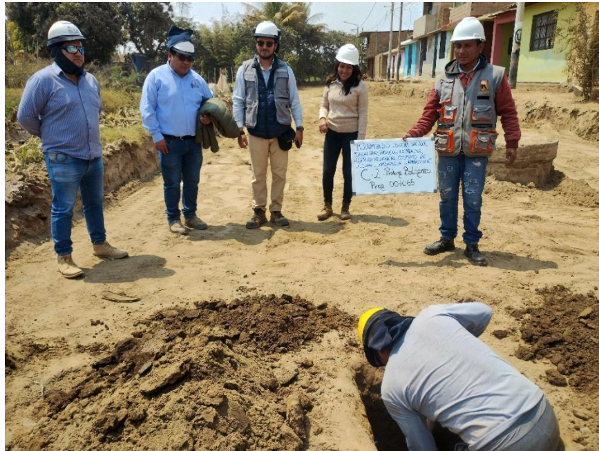
Figura 26. Calle Prolongación Bolognesi - Calicata N°02
