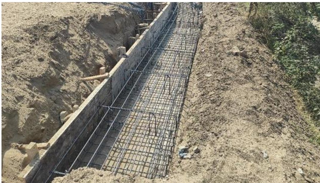
Fotografía 48: HABILITACIÓN Y COLOCACIÓN DE ACERO EN SARDINEL DE CONTENCIÓN
