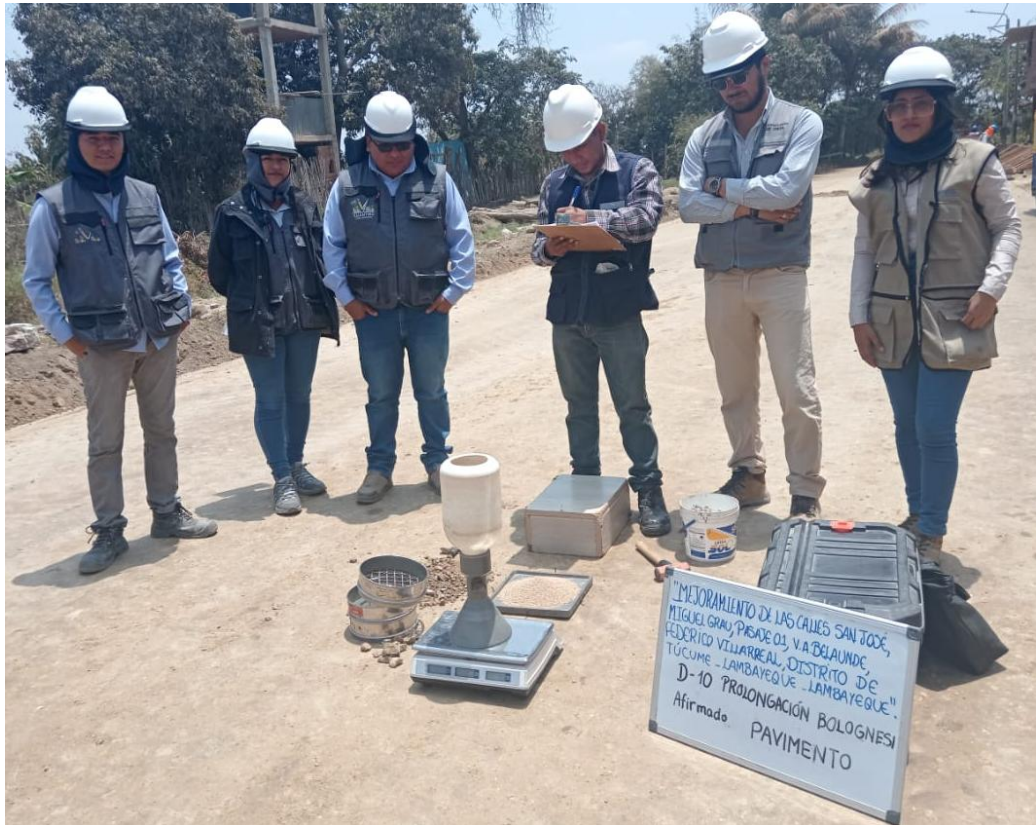
Fotografía 13: DENSIDAD DE CAMPO – AFIRMADO PAVIMENTO
