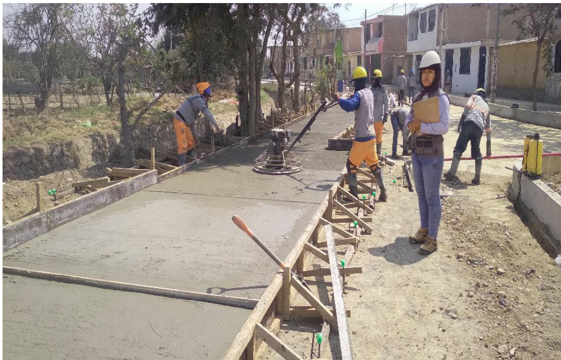
Fotografía 26: PLANCHADO (TIPO FROTACHADO) CON ALISADORA SIMPLE C/DISCO
