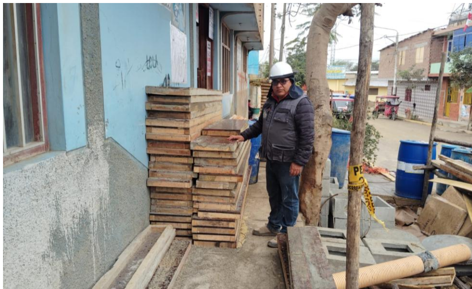
Fotografía 18: INSPECCIÓN DE LA CALIDAD DE LOS FENÓLICOS PARA ENCOFRADOS.
