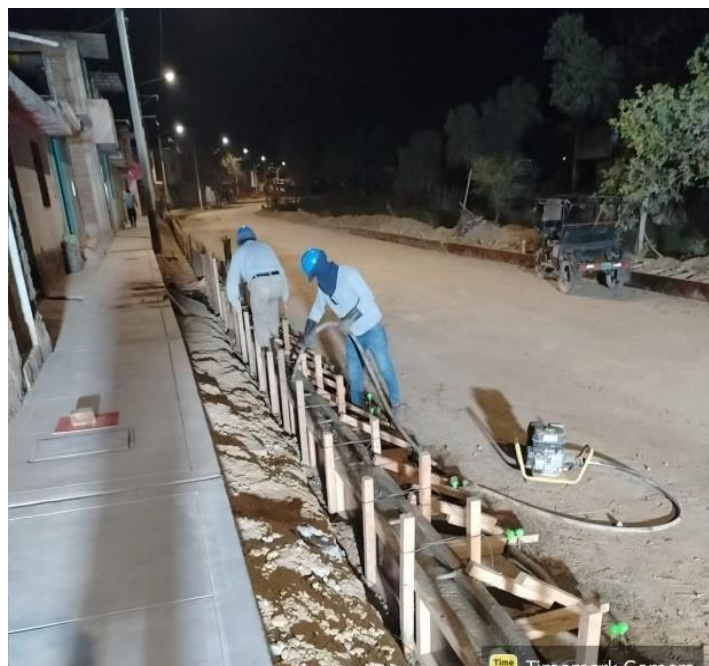
Fotografía 44: VIBRADO DE CONCRETO EN SARDINELES
