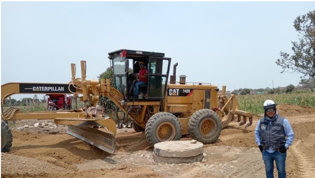
Fotografía 09: COLOCACION DE AFIRMADO (MATERIAL GRANULAR) COMO BASE.
