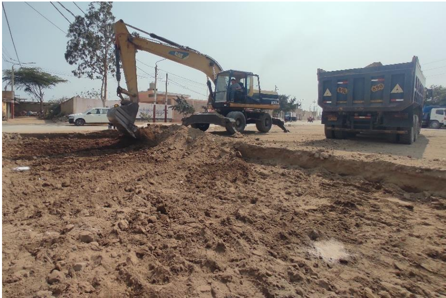
Fotografía 05: CORTE A NIVEL DE SUB RASANTE CON MAQUINARIA
