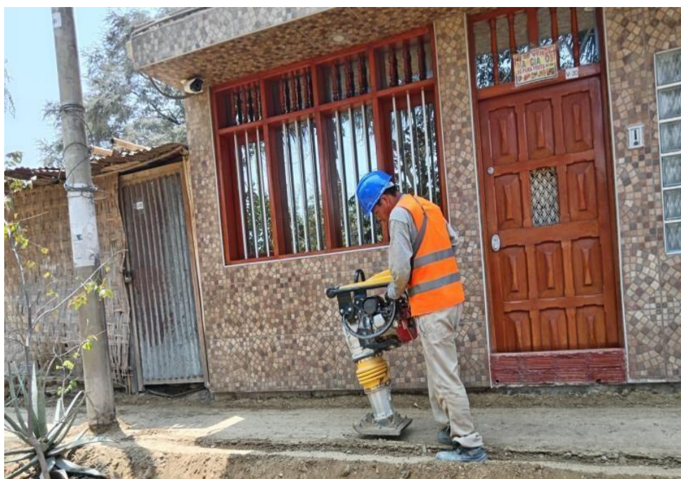
Fotografía 30: NIVELACION Y COMPACTACION DE TERRENO NATURAL
