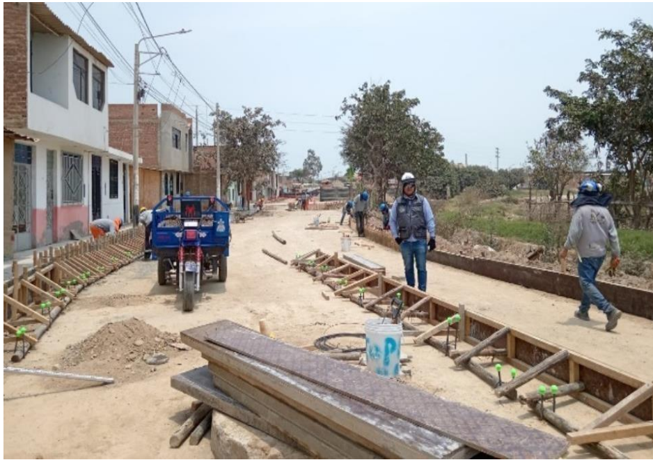
Fotografía 41: ENCOFRADO DE SARDINELES INDEPENDIENTES.
