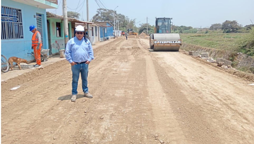
Fotografía 11: COMPACTACIÓN DE BASE - AFIRMADO E= 0.20m.
