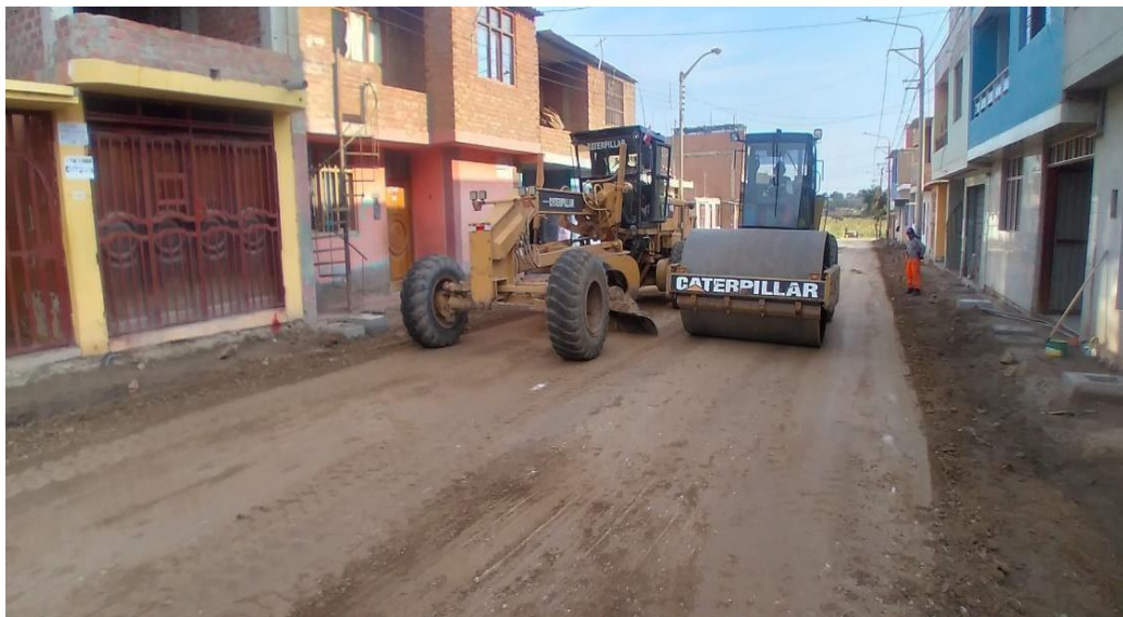
Fotografía 06: NIVELACION Y COMPACTACION DE TERRENO NATURAL
