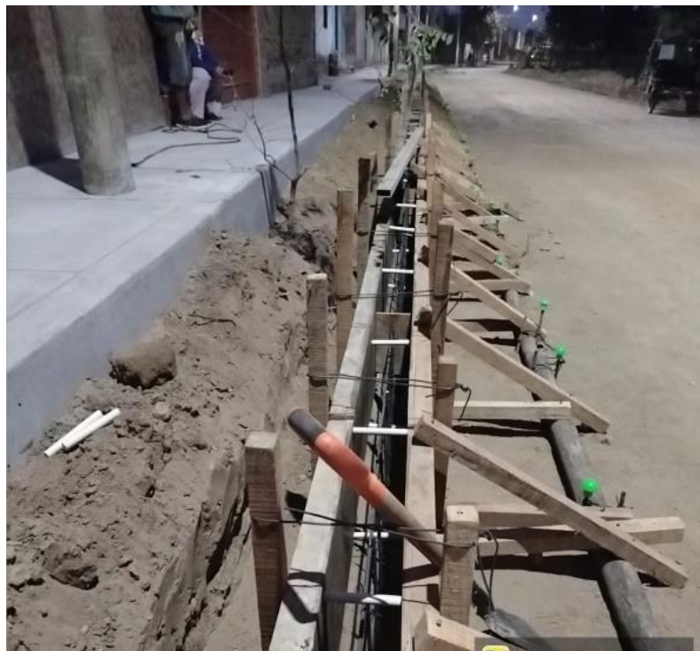
Fotografía 42: HABILITACIÓN Y COLOCACIÓN DE ACERO EN SARDINELES INDEPENDIENTES.
