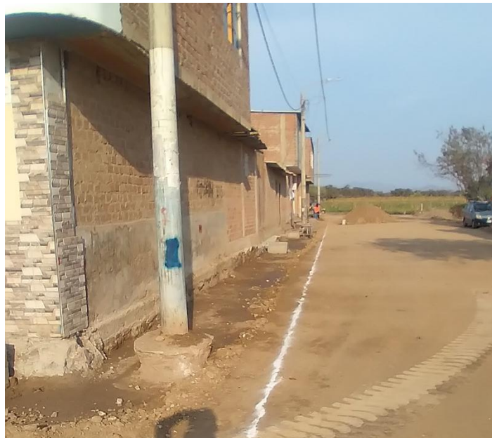
Fotografía 02: TRAZO Y REPLANTEO TOPOGRÁFICO.
