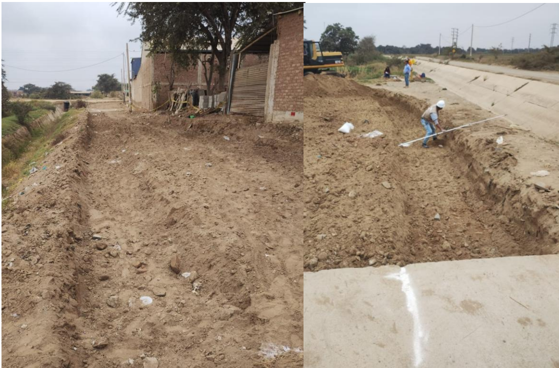
Figura 23. Calle Santa Rosa: Se observa un suelo arenoso con presencia de salitre y restos orgánicos-basura
