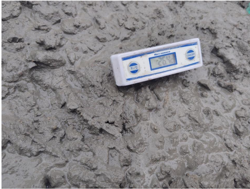
Fotografía 51: MEDIDA DE TEMPERATURA DEL CONCRETO FRESCO CON TERMOMETRO DIGITAL
