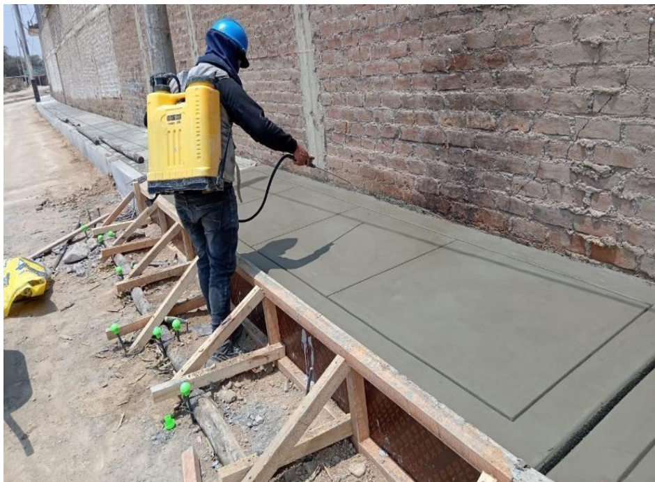
Fotografía 40: ACABADO PULIDO Y BRUÑADO EN RAMPAS PEATONALES
