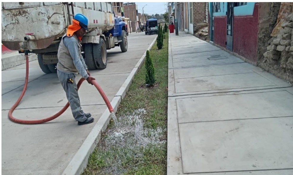
Fotografía 55: SEMBRADO DE GRASS NATURAL, RIEGO Y ARBORIZACIÓN
