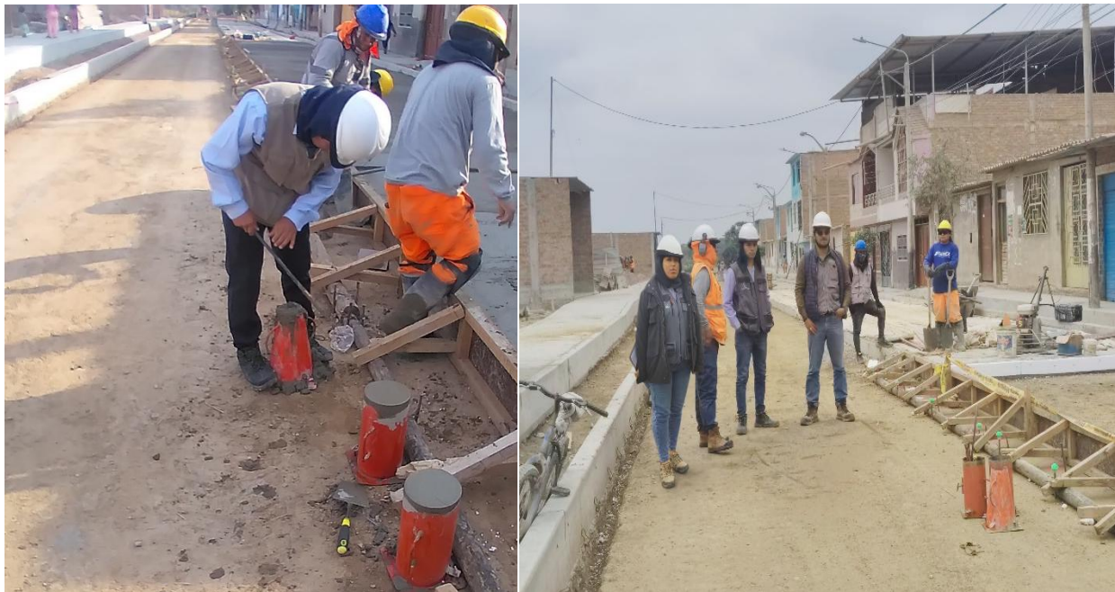
Fotografía 24: LLENADO DE PROBETAS PARA ENSAYOS DE RESISTENCIA DEL CONCRETO DEL PAVIMENTO.
