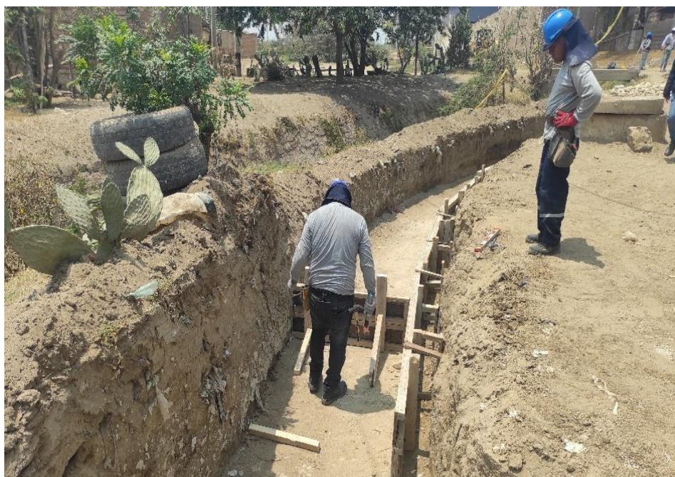
Fotografía 46: ENCOFRADO DE SARDINEL DE CONTENCIÓN
