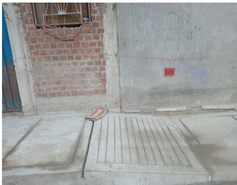
Fotografía 40: ACABADO PULIDO Y BRUÑADO EN RAMPAS PEATONALES
