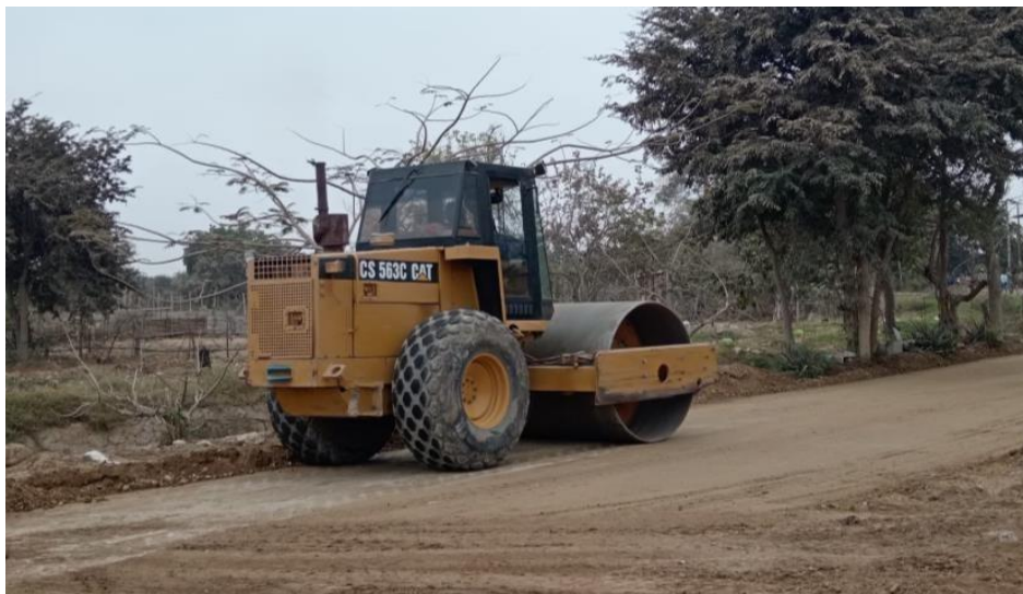
Fotografía 10: CONFORMACION, NIVELADO Y COMPACTACIÓN DE AFIRMADO - BASE E= 0.20m
