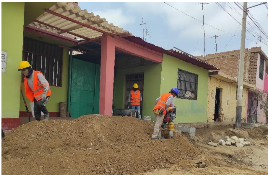
Fotografía 32: RELLENO MANUAL CON AFIRMADO
