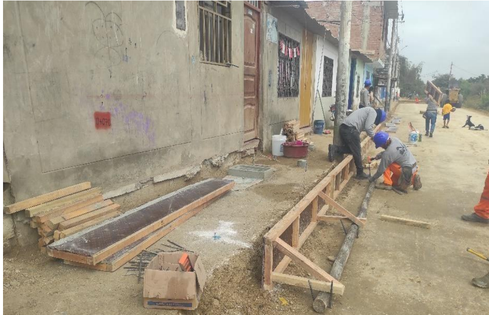
Fotografía 37: ENCOFRADO DE VEREDAS.
