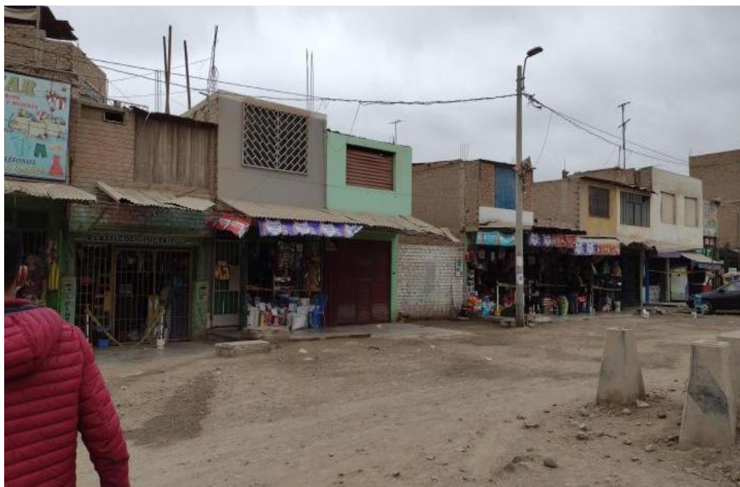
Figura 12. Vías en el Distrito de Motupe
