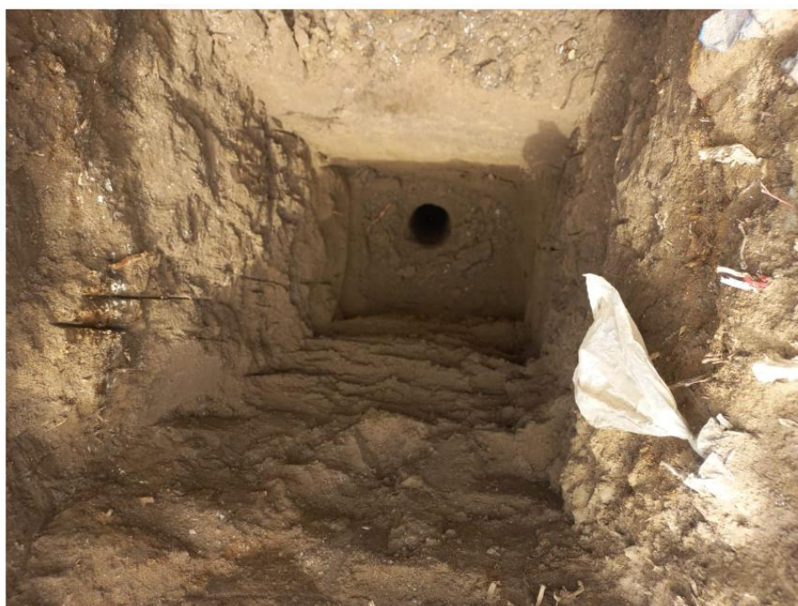
Fig. . 16.- Calicatas terminada de donde se recolectó muestra
