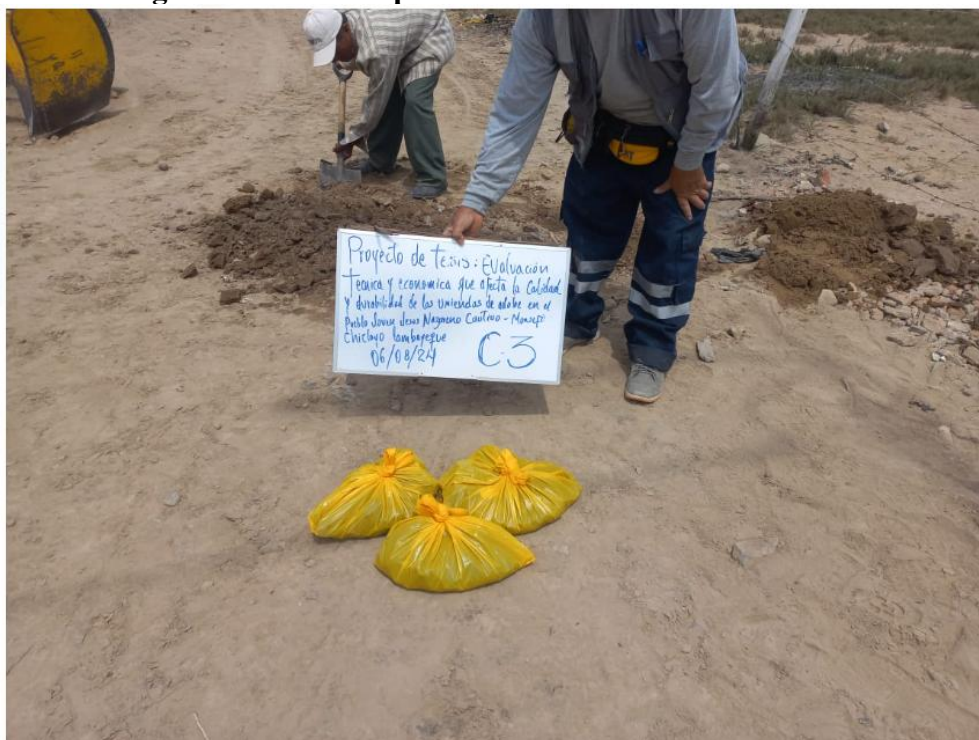
Fig. . 15.- Calicatas para estudio de mecánica de suelos
