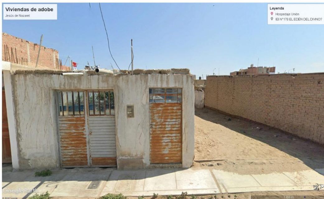
Fig 13.- Viviendas con deterioros
