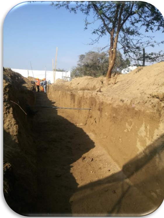
Imagen 09: Se puede apreciar la zanja excavada para cimentación de muro de contención.
