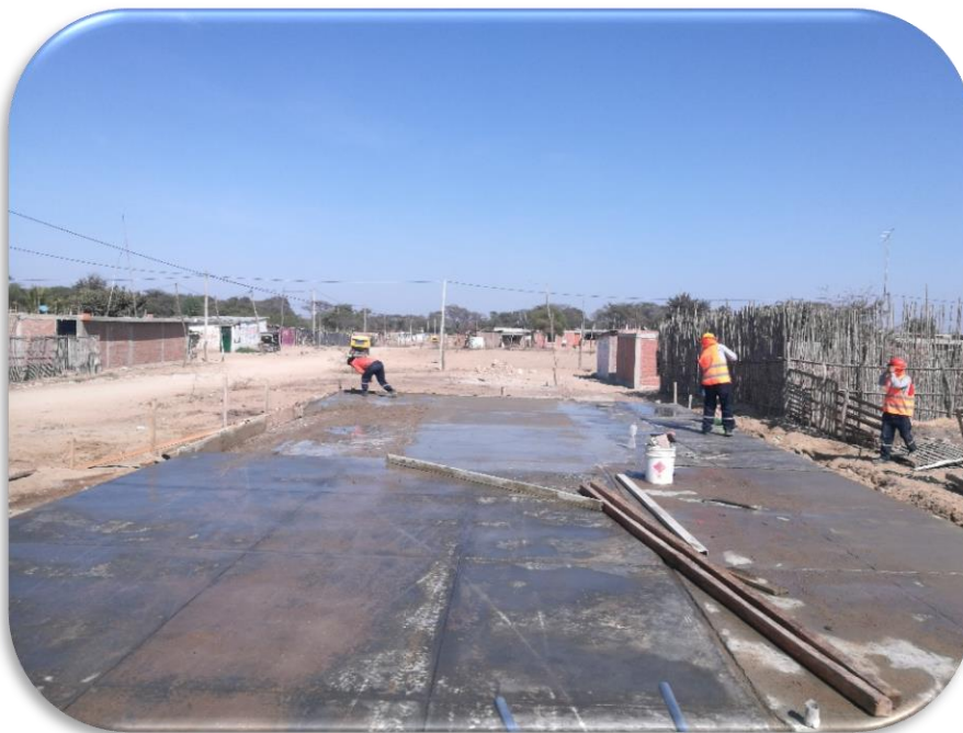
Imagen 04: Vaceado de concreto en plataforma de contingencia.
