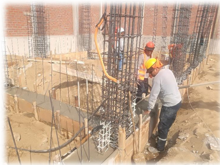
Imagen 26: Vaceado de concreto en vigas de cimentación, en Bloque 01
