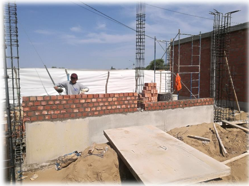
Imagen 25: Asentado de ladrillo tipo sogá, en Bloque 01
