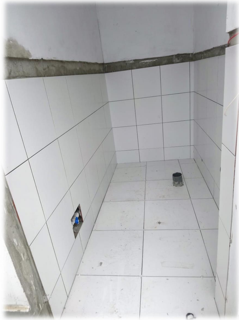
Imagen 42 y 43: Proceso de tarrajeo y colocación de cerámica en SS.H..
