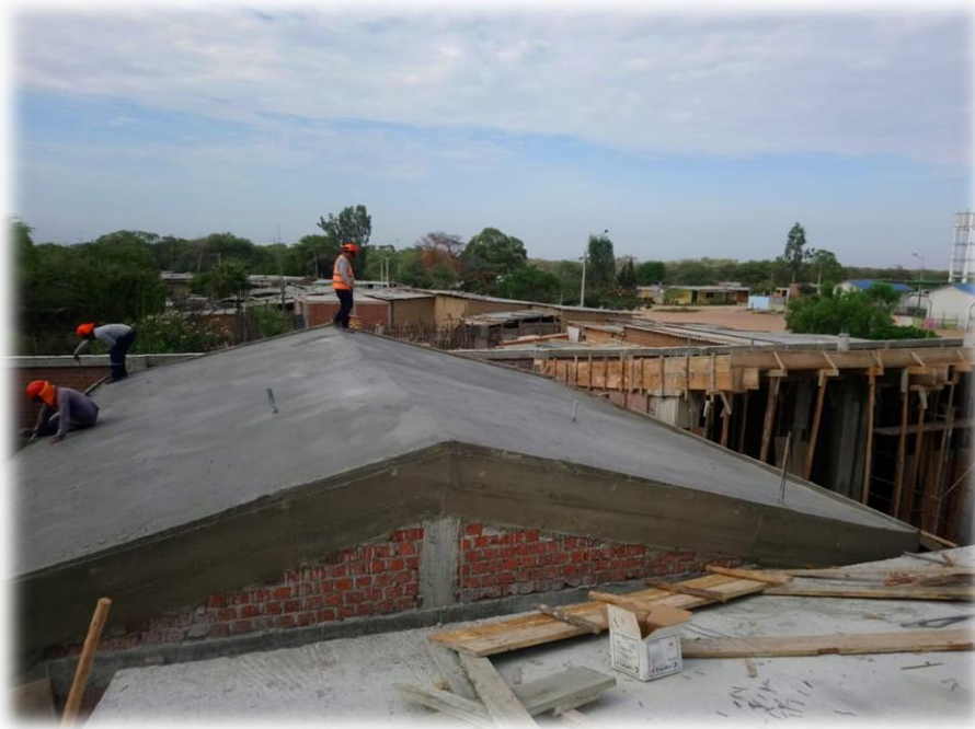
Imagen 35: Losa aligerada de bloque 02 culminada
