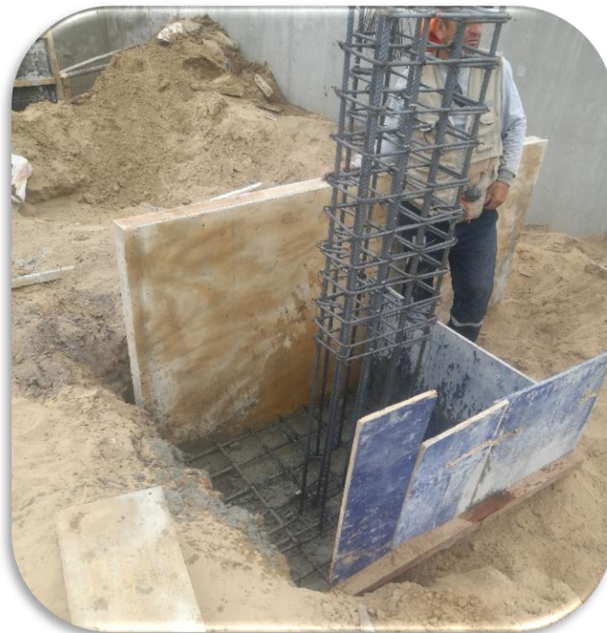
Imagen 22: Encofrado, y vaceado de zapata.
