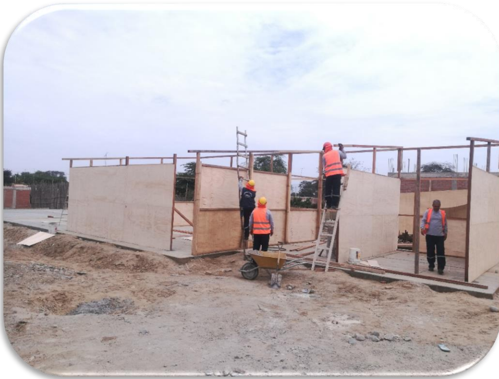
Imagen 05 y 06: Proceso de construcción de Módulos de Aula de Contingencia.
