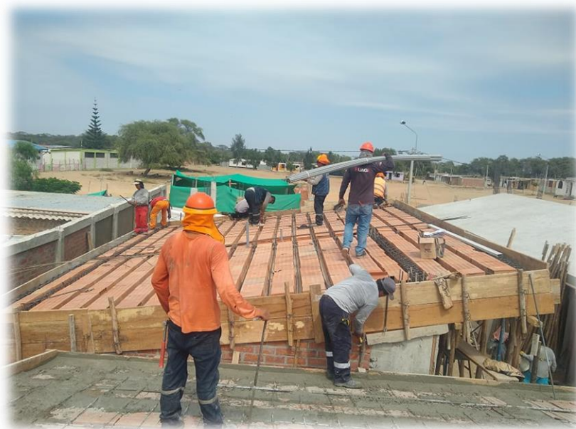
Imagen 30: Proceso de encofrado, colocación de acero, ladrillo para techo, en Bloque 03
