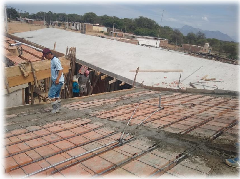
Imagen 31: Vaceado de concreto en losa aligerada, en Bloque 02
