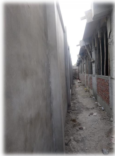
Imagen 37: Tarrajeo interior de cerco perimétrico en sector calle 02.
