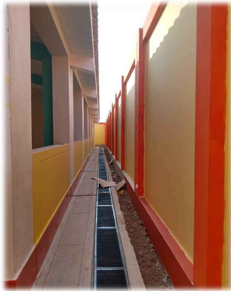
Imagen 52: Pintura interior en cerco perimétrico e instalación de rejilla metálica en canaletas.
