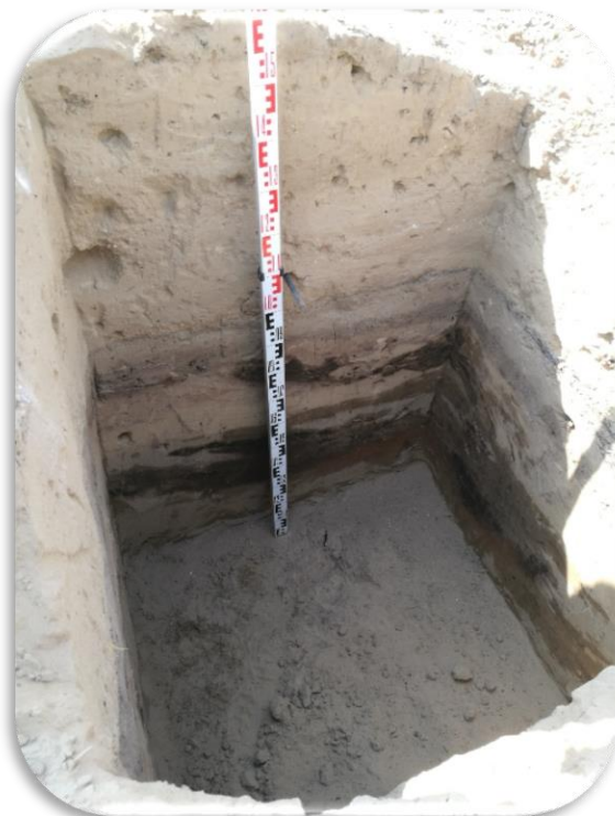
Imagen 20: Zanja para zapatas.
