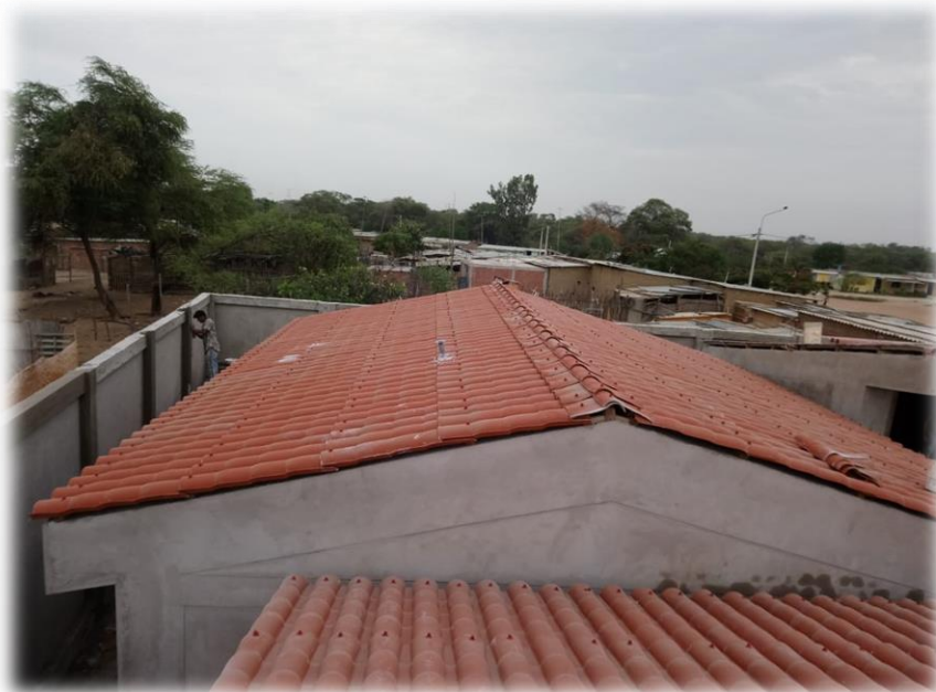
Imagen 40: Colocación finalizada de cobertura tipo teja en módulos.
