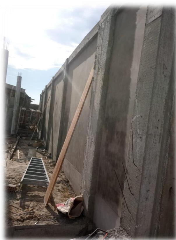
Imagen 38: Tarrajeo interior de cerco perimétrico en sector colindancia con propiedad de terceros 01.
