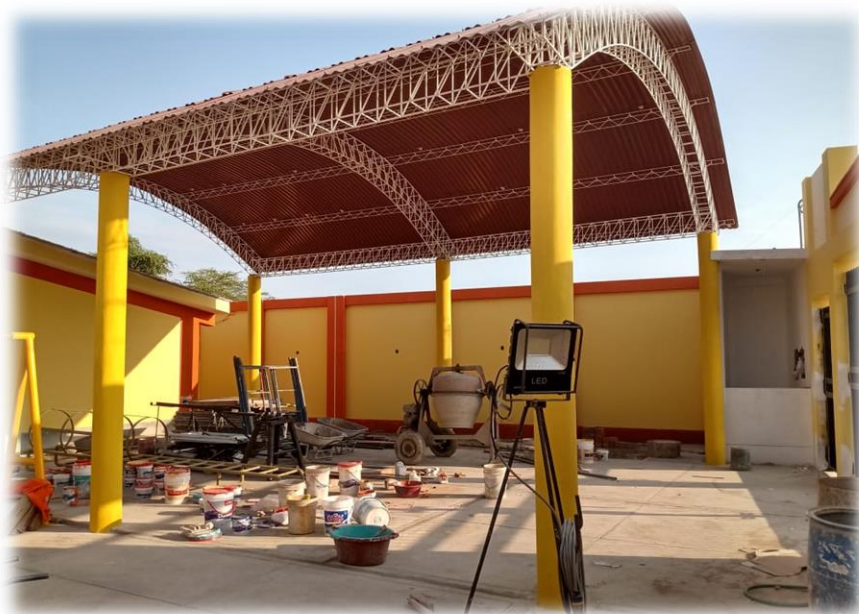
Imagen 53: Pintura en columnas en cobertura de patio..
