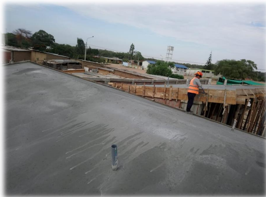
Imagen 34: Losa aligerada de bloque 01 culminada
