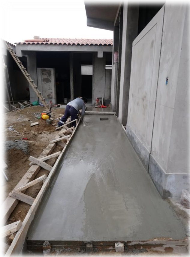
Imagen 39: Se aprecia concreto en vereda y su posterior pulido.
