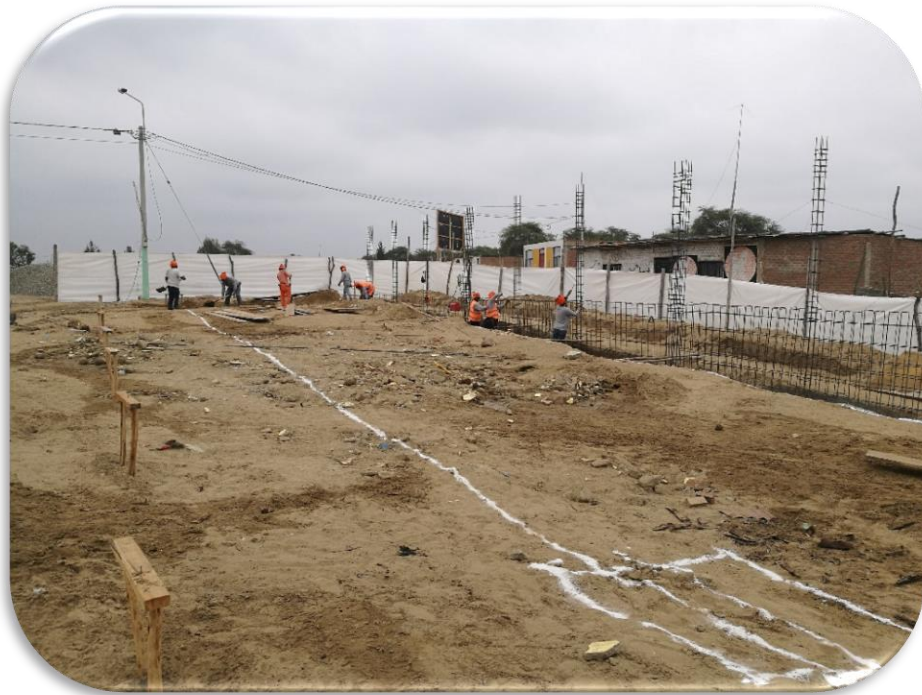
Imagen 17: Trazo para excavación en bloque 01
