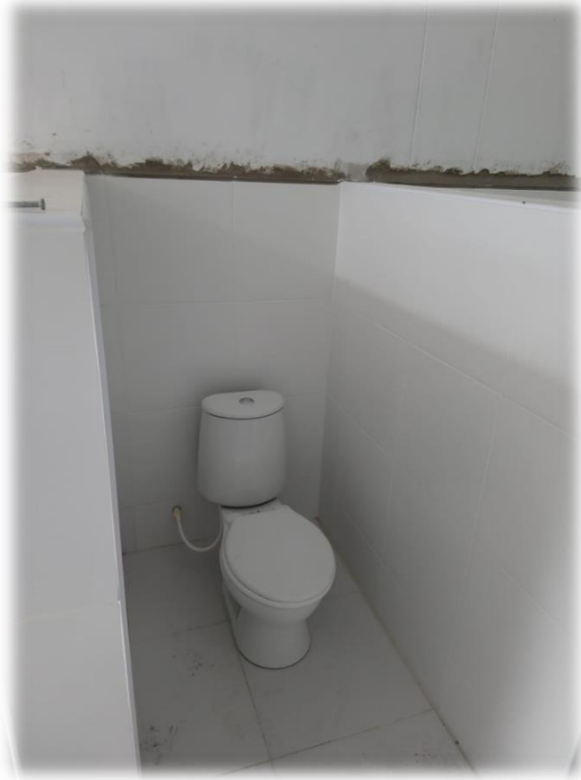
Imagen 44: Colocación de enchape de cerámica en cocina e instalación de aparatos sanitarios.
