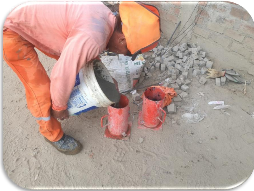
Imagen 21: Proceso de elaboración de testigos de concreto.
