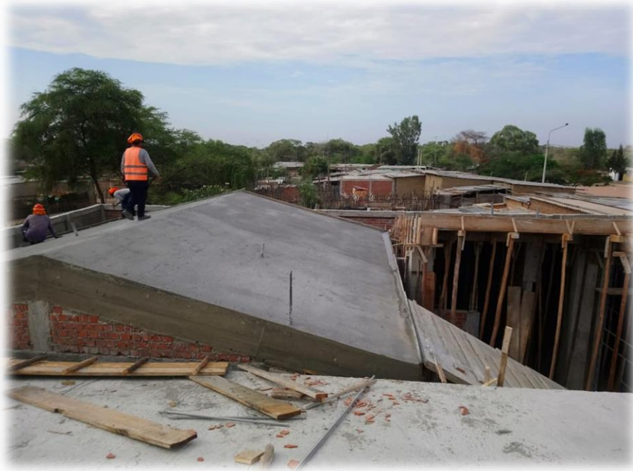
Imagen 33: losa aligerada de bloque 02 culminada
