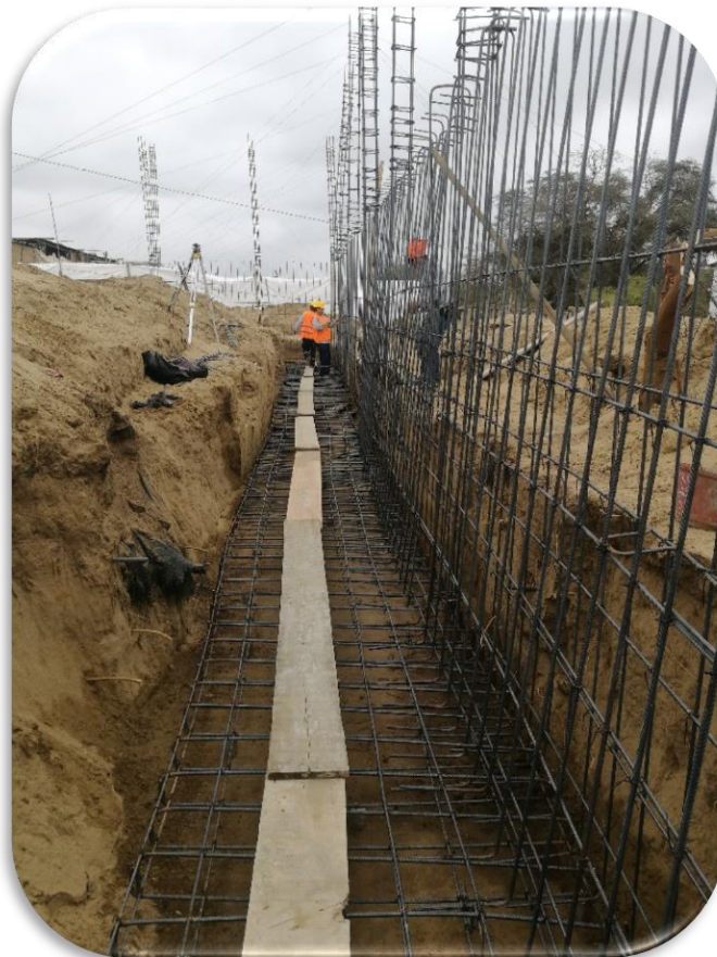
Imagen 13 y 14: Colocación de Acero en Muro de Contención.
