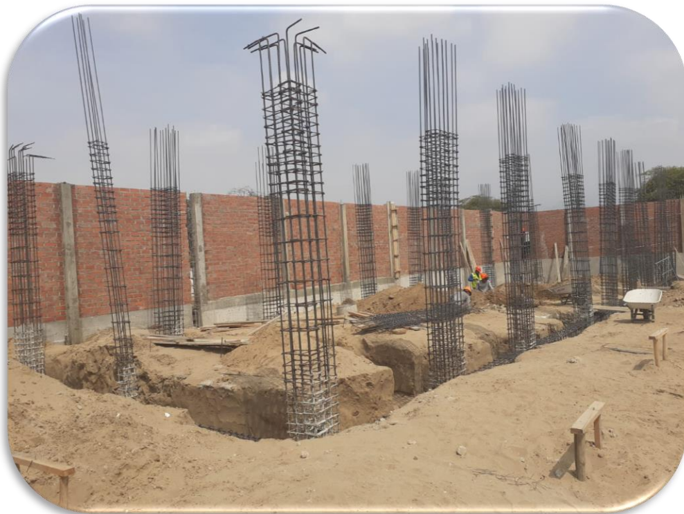
Imagen 24: Izaje de columnas
