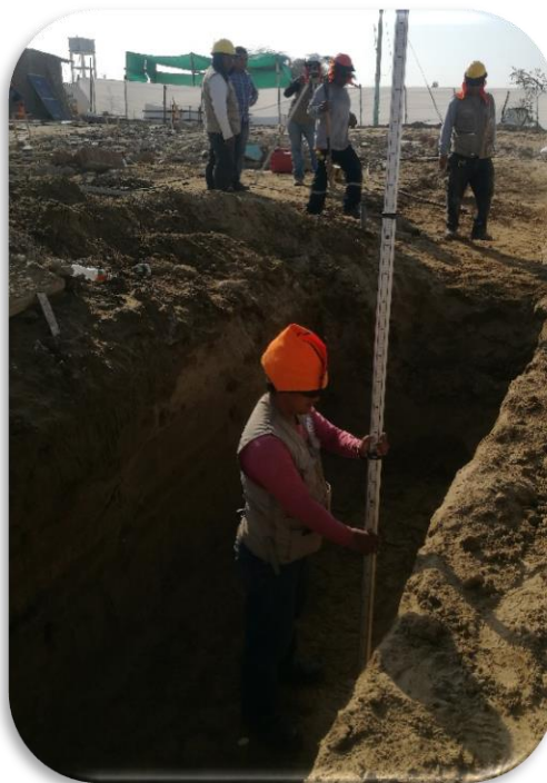
Imagen 09: Se puede apreciar la zanja excavada para cimentación de muro de contención.
