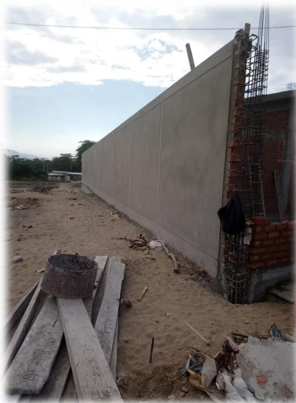
Imagen 36: Tarrajeo exterior de cerco perimétrico en sector calle 02.
