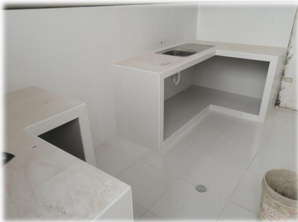
Imagen 49: Enchape de cerámica en cocina.
