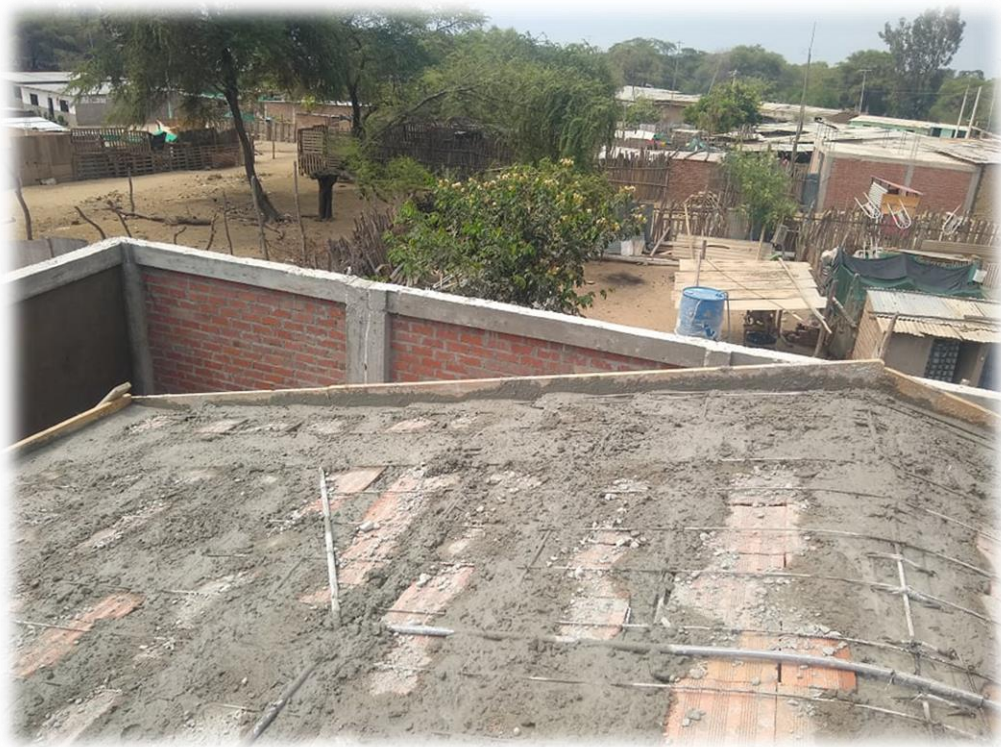
Imagen 32: Vaceado de concreto en losa aligerada, en Bloque 02
