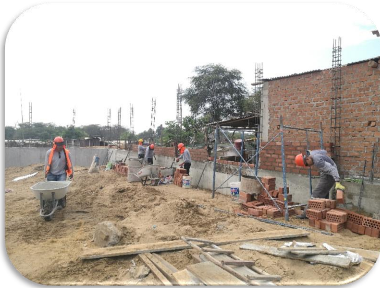
Imagen 23: Asentado de Ladrillo en cerco perimétrico.
