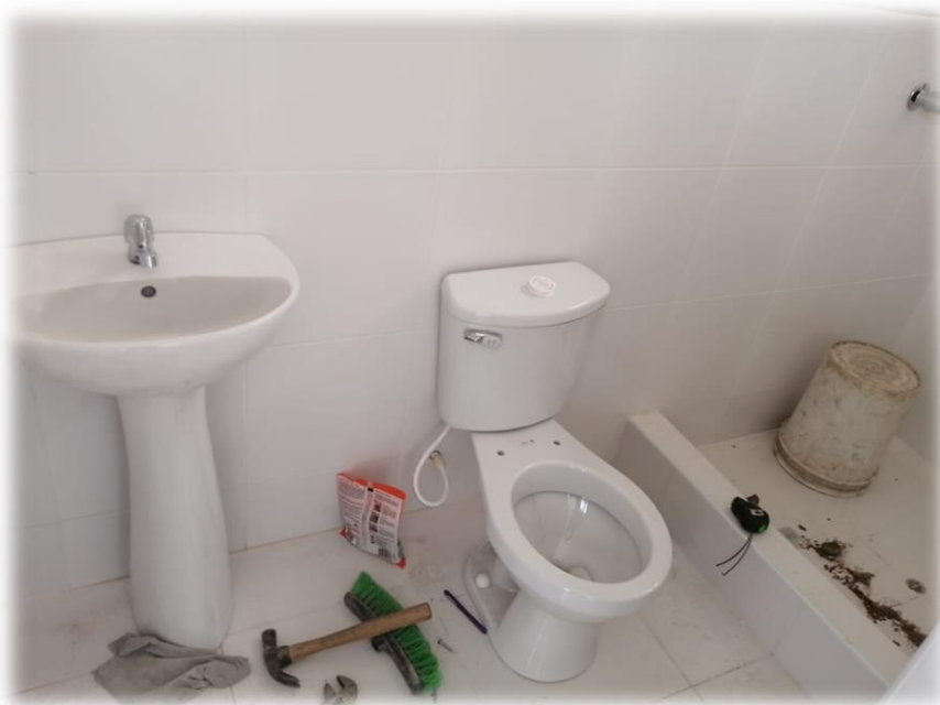
Imagen 46 y 47: Colocación de aparatos sanitarios en SS.HH.
