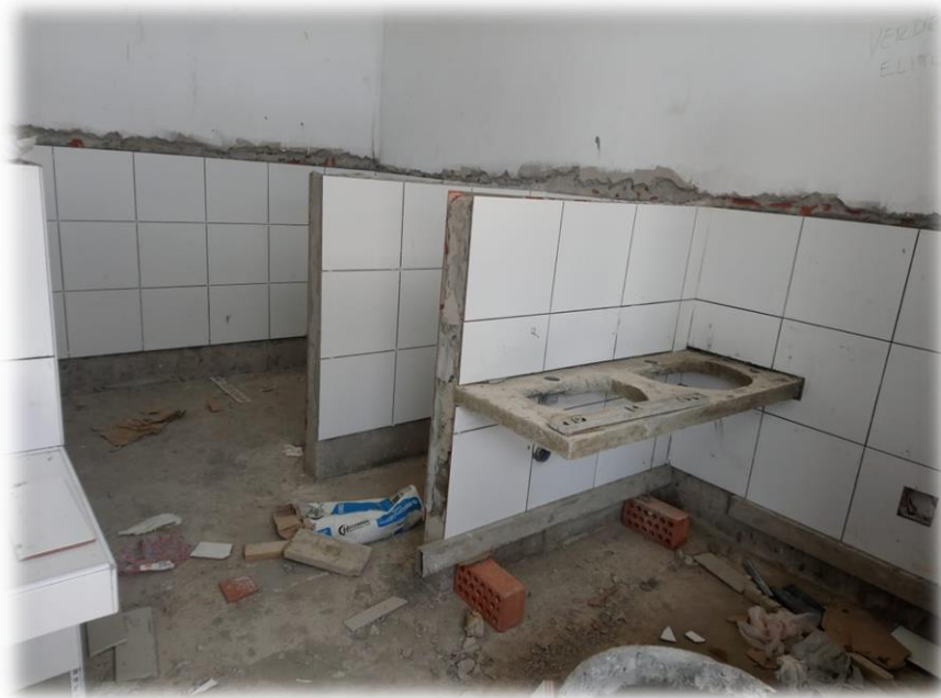
Imagen 45: Colocación de enchape de cerámica en SS.HH.
