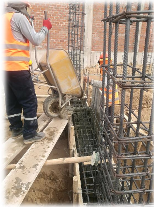
Imagen 29: Proceso de vaceado de concreto en vigas de cimentación en bloque 02.
