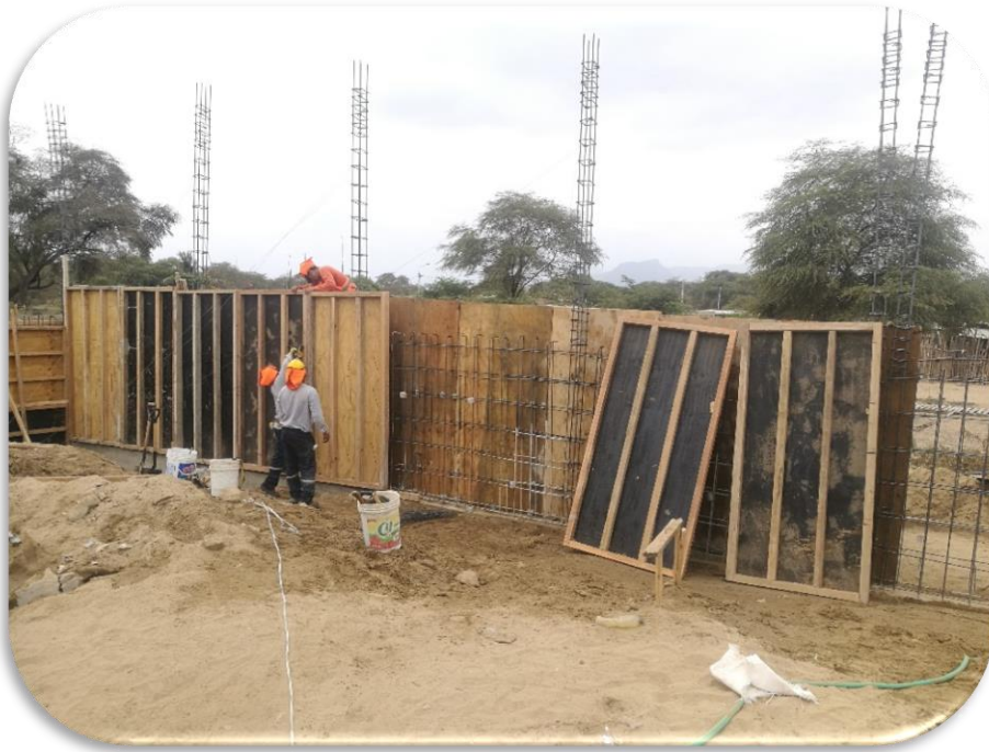
Imagen 15: Proceso de Encofrado en Muro de Contención.
