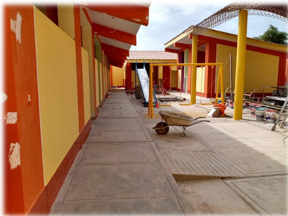
Imagen 51: Pintura exterior en módulos de aulas.
