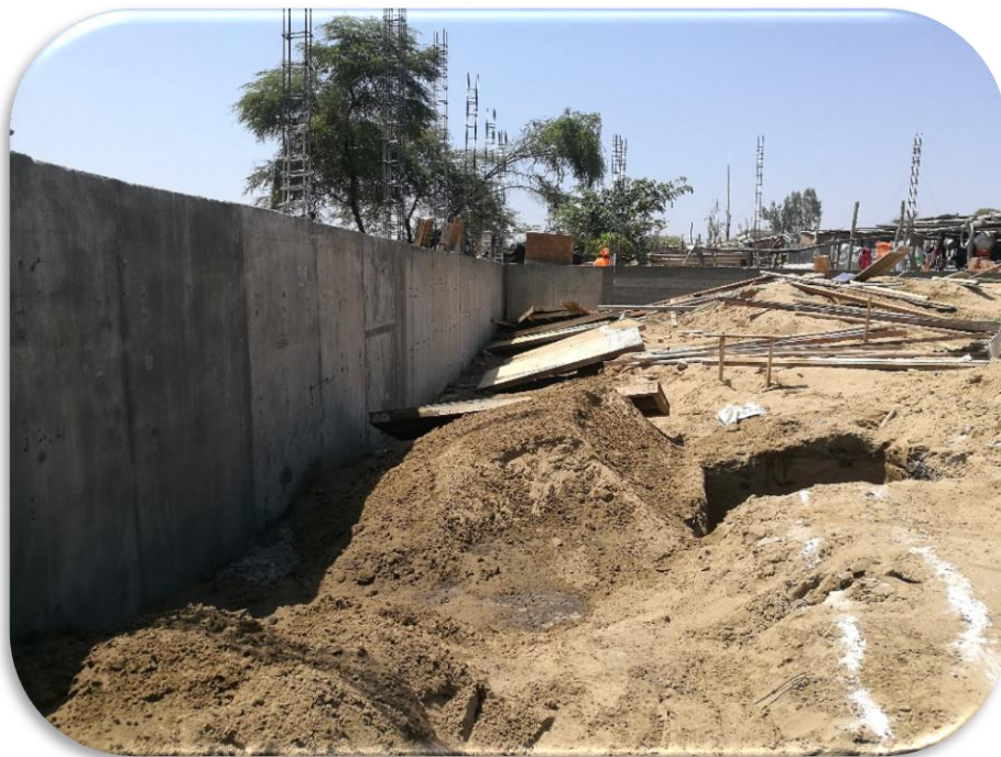
Imagen 18: Concreto en Muro de contención
