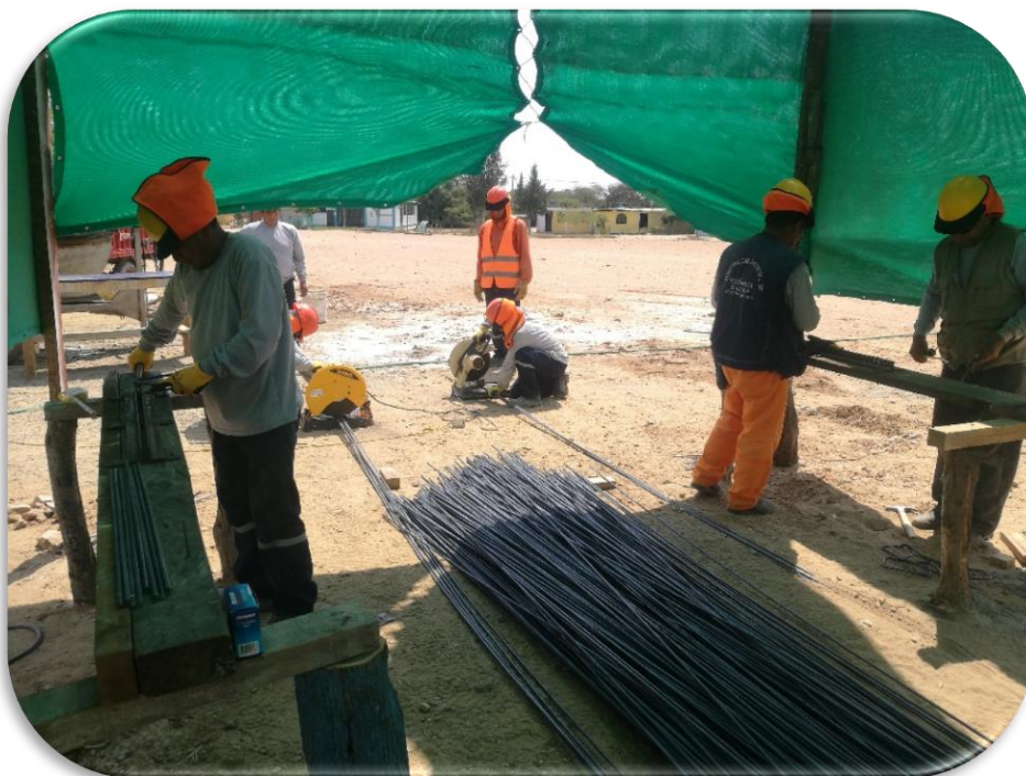
Imagen 12: Corte y Habilitación de Acero.
