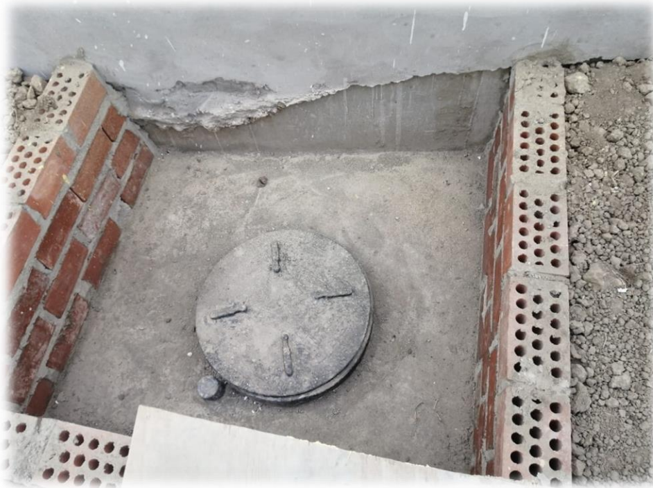
Imagen 48: Colocación de biodigestor.
