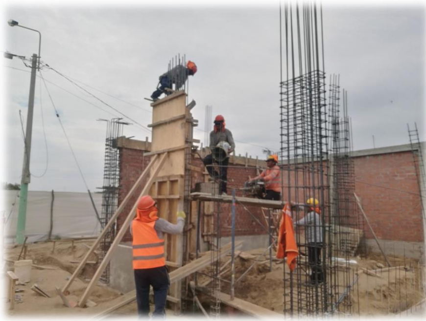
Imagen 27: Vaceado de concreto en Columnas tipo Tee, en Bloque 01
