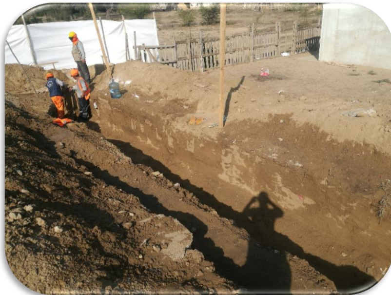
Imagen 07 y 08: Excavación de zanja para Muro de Contención.
