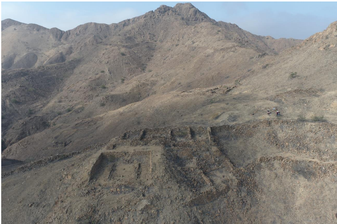
Imagen N°6: Vista panorámica de norte a sur del conjunto arquitectónico 1, notase la estructura en U.
