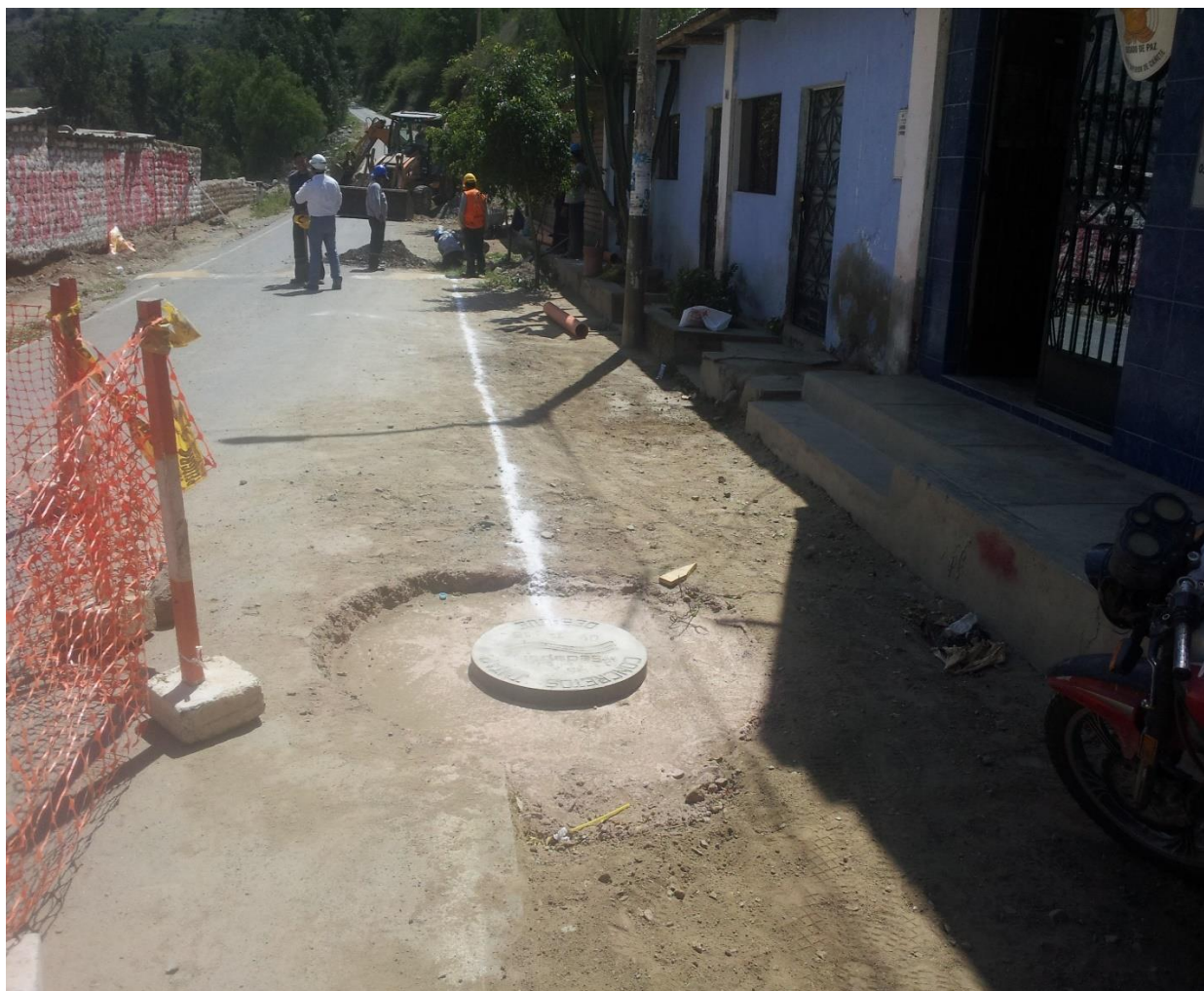
Figura G: Excavacion De Buzones Al Borde De La Vía.
