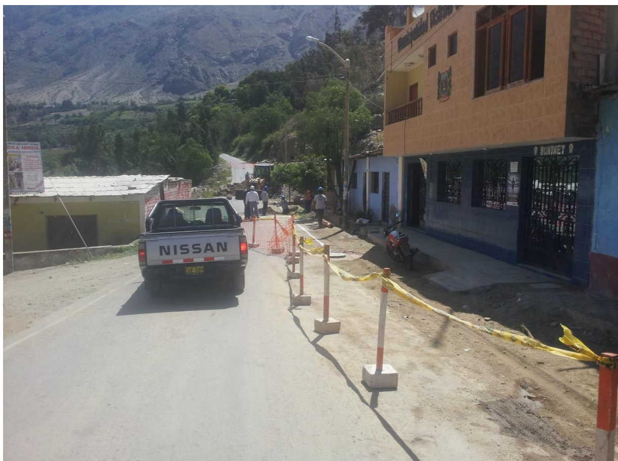
Figura F: Excavacion De Buzones Al Borde De La Vía.
