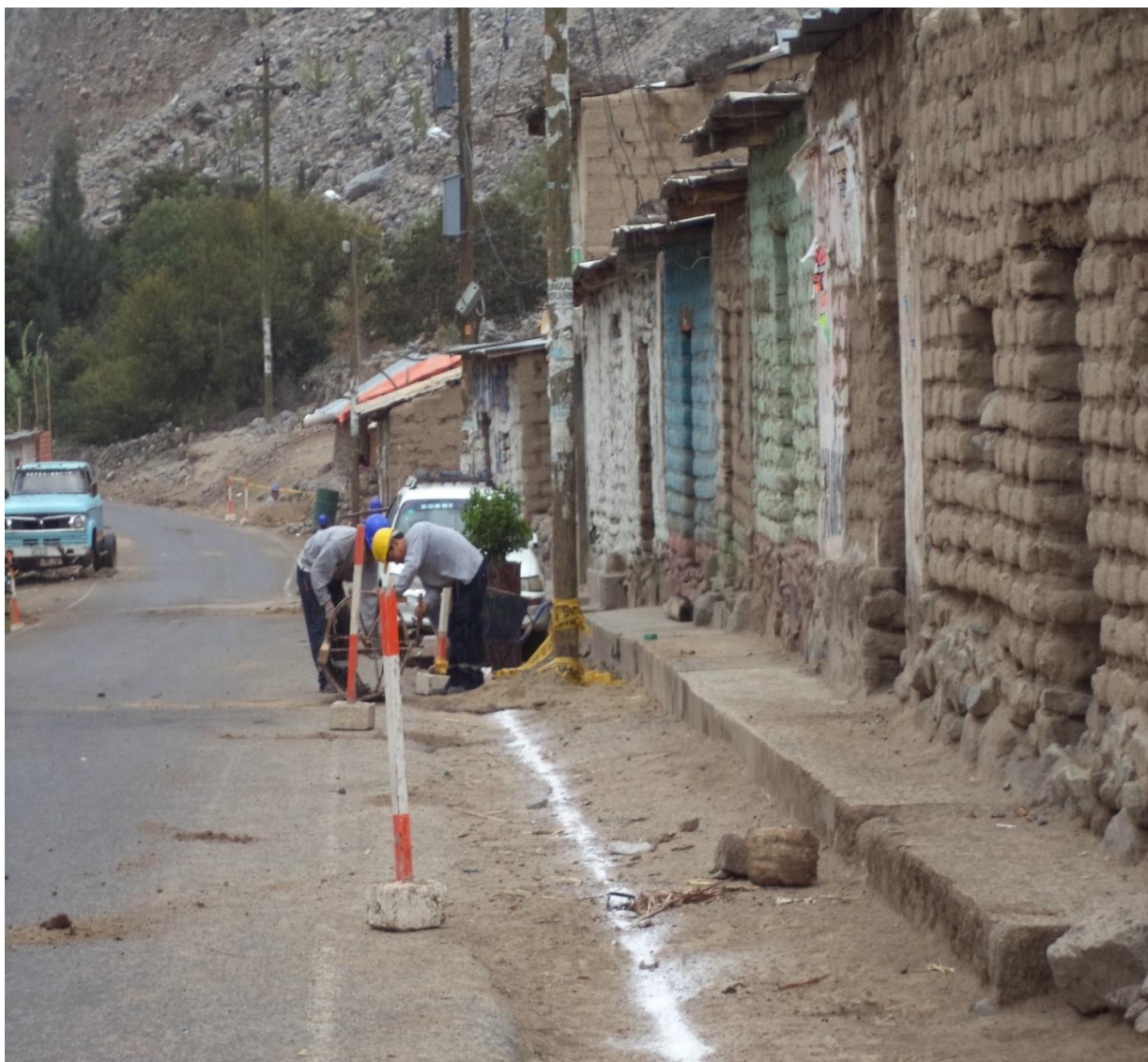
Figura D: Excavacion De Buzones Al Borde De La Vía.
