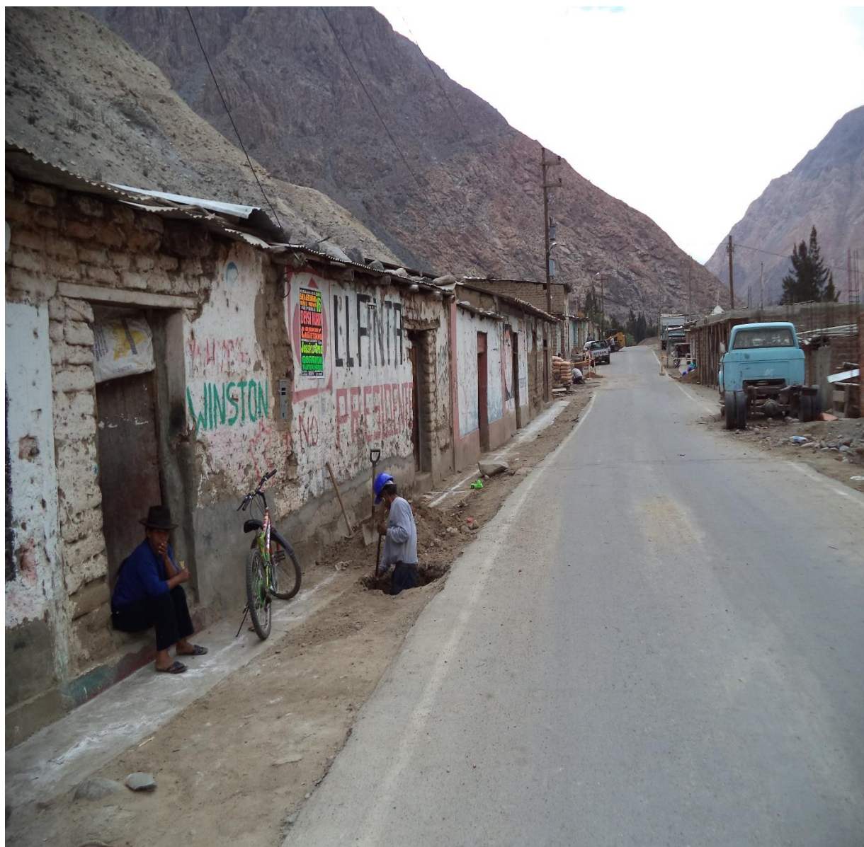
Figura B: Excavacion De Buzones Al Borde De La Vía.
