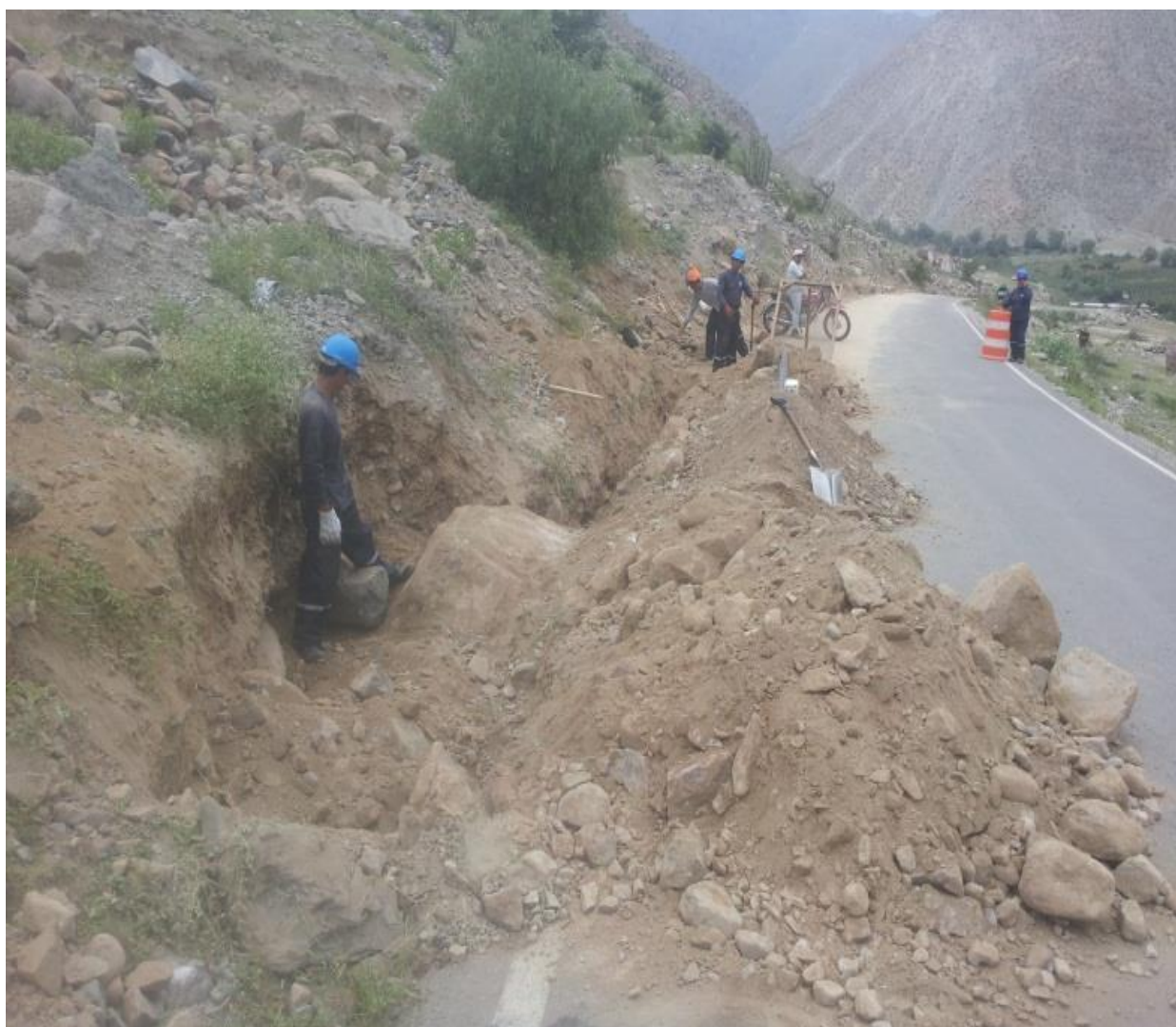
Figura E: Excavacion De Buzones Al Borde De La Vía.
