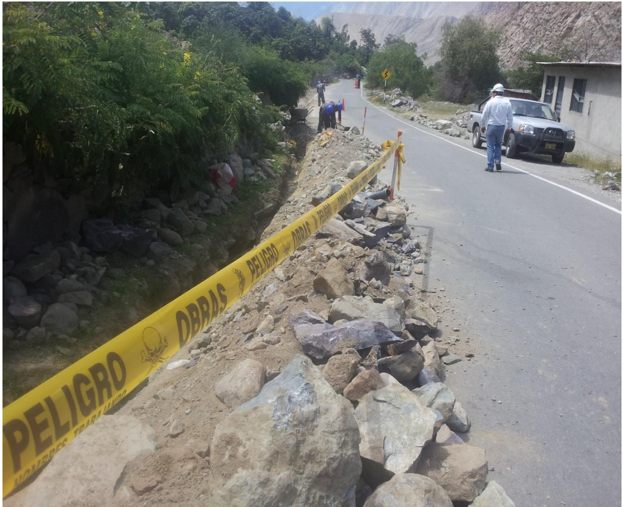
Figura H: Excavacion De Buzones Al Borde De La Vía.
