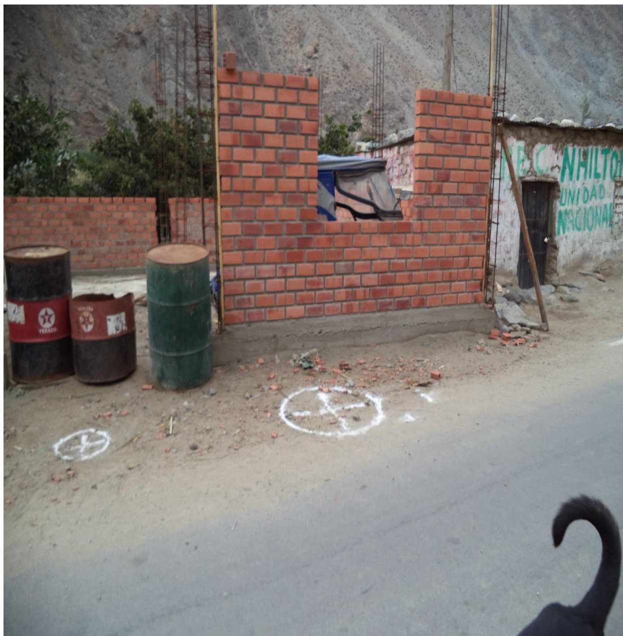
Figura C: Excavacion De Buzones Al Borde De La Vía.
