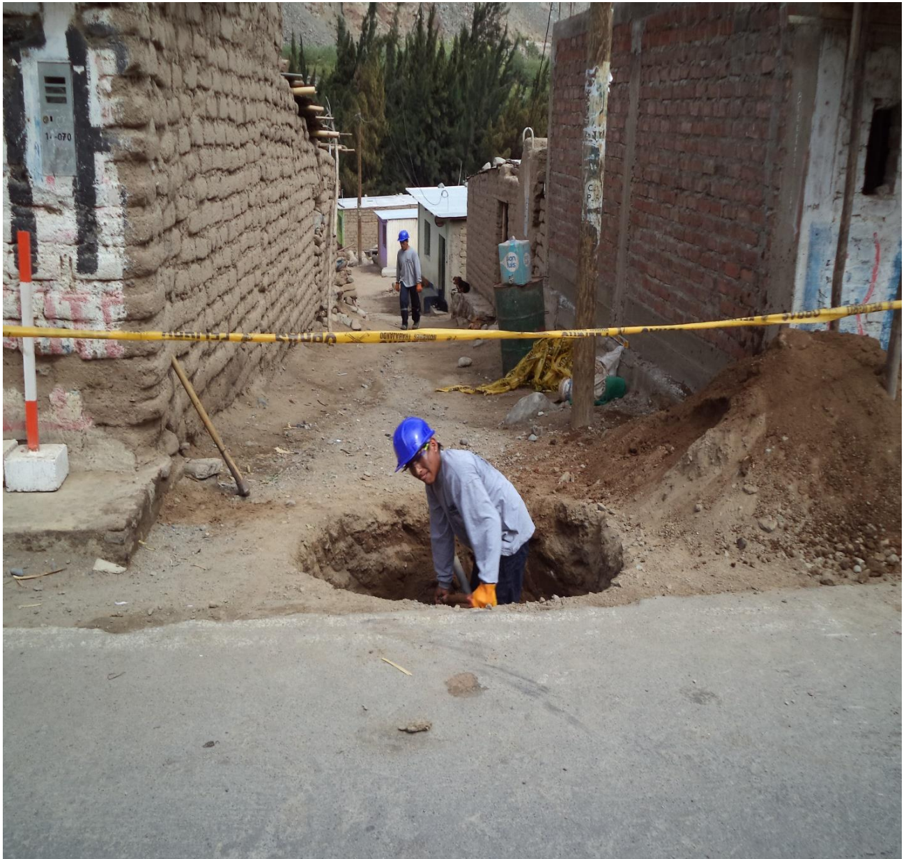
Figura A: Excavacion De Buzones Al Borde De La Vía.
