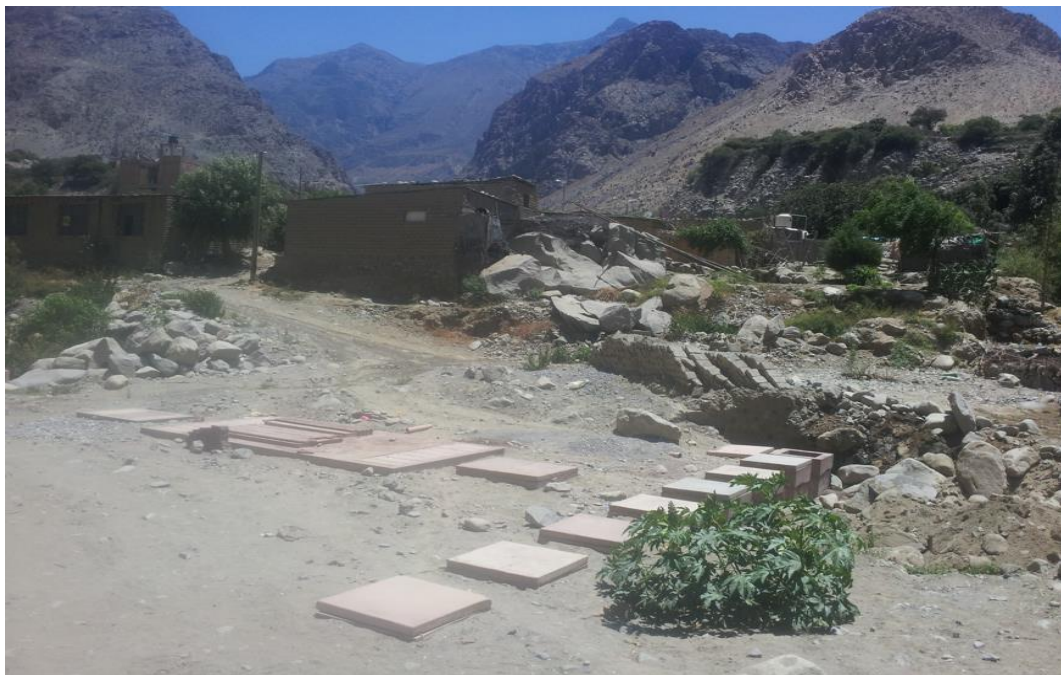
Figura N° 23: Planta de tratamiento abandonada
