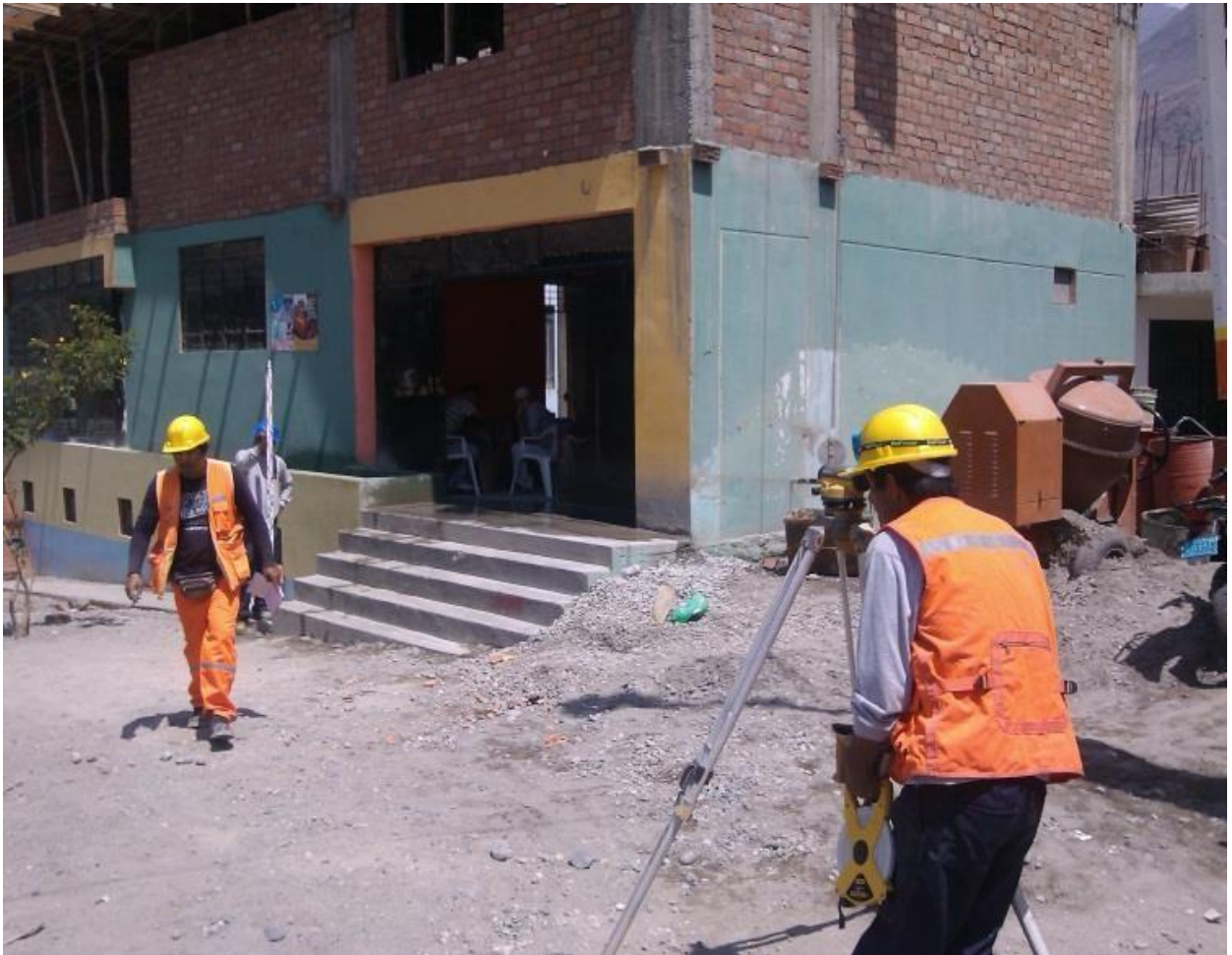
Figura I: Levantamiento Topográfico Del Nuevo Trazo Para La Propuesta Del Cambio De Distribución De Redes Permitió Cruzar La Vía Una Sola Vez En La Localiad De Catahuasi.
