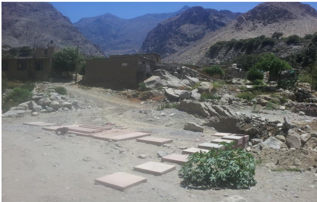
Figura N° 23: Planta de tratamiento abandonada
