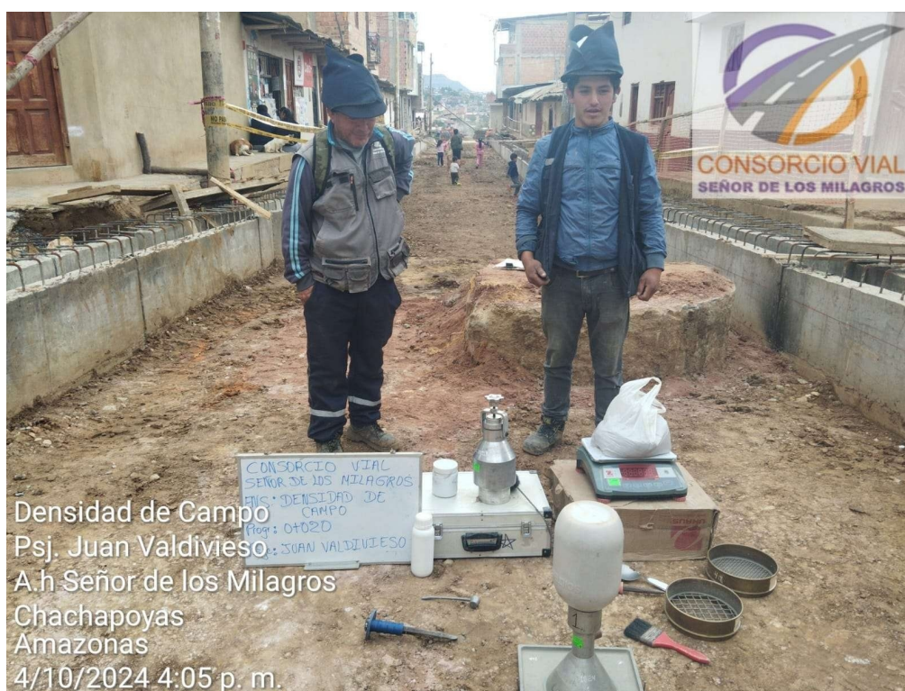
Realización de densidad de campo de subrasante en obra: “Construcción de pistas y veredas de la Av. Aeropuerto y calles afines de la ciudad de Chachapoyas,
