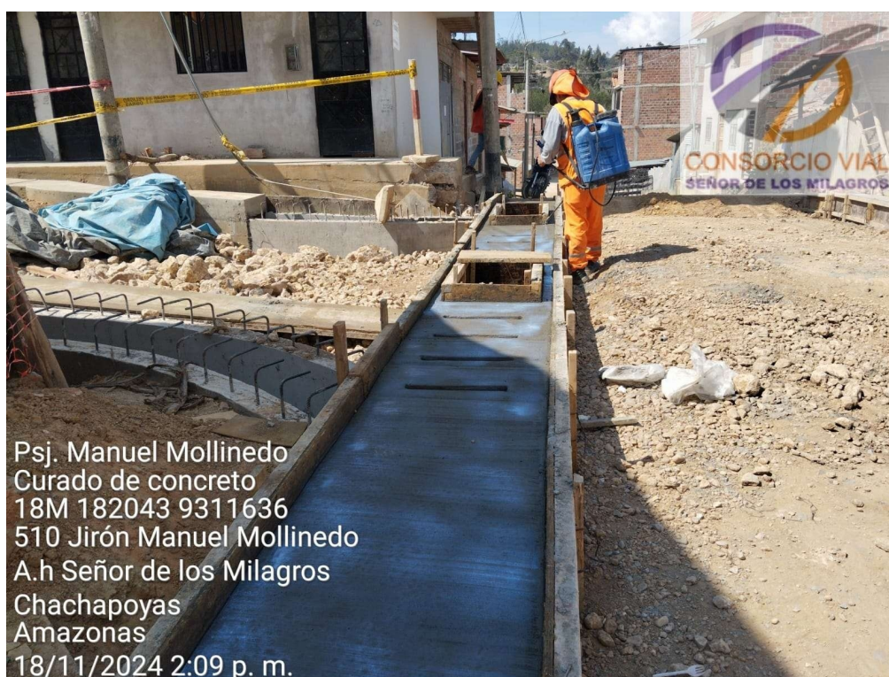
Curado de concreto con antisol en techo de cuneta en obra: “Construcción de pistas y veredas de la Av. Aeropuerto y calles afines de la ciudad de Chachapoyas,
