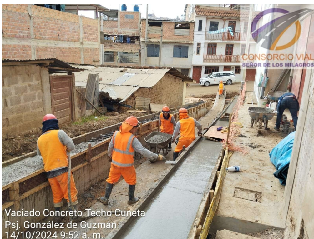
Vaciado de concreto en techo de cuneta en obra: “Construcción de pistas y veredas de la Av. Aeropuerto y calles afines de la ciudad de Chachapoyas, Provincia de
