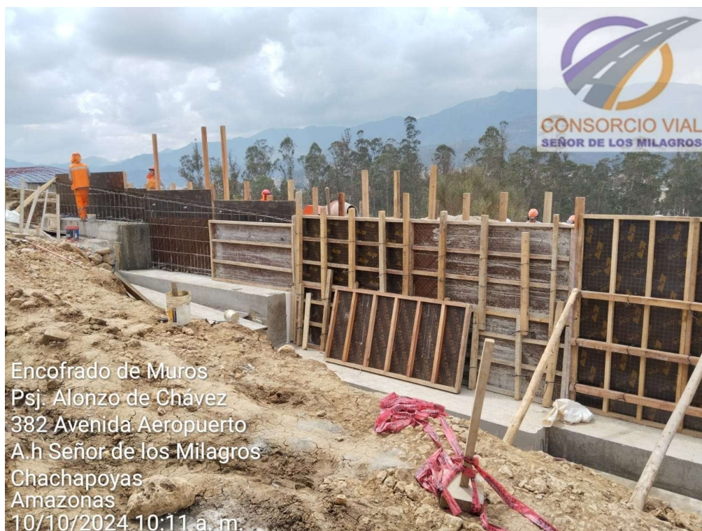
Encofrado de muro de contención en obra: “Construcción de pistas y veredas de la Av. Aeropuerto y calles afines de la ciudad de Chachapoyas, Provincia de
