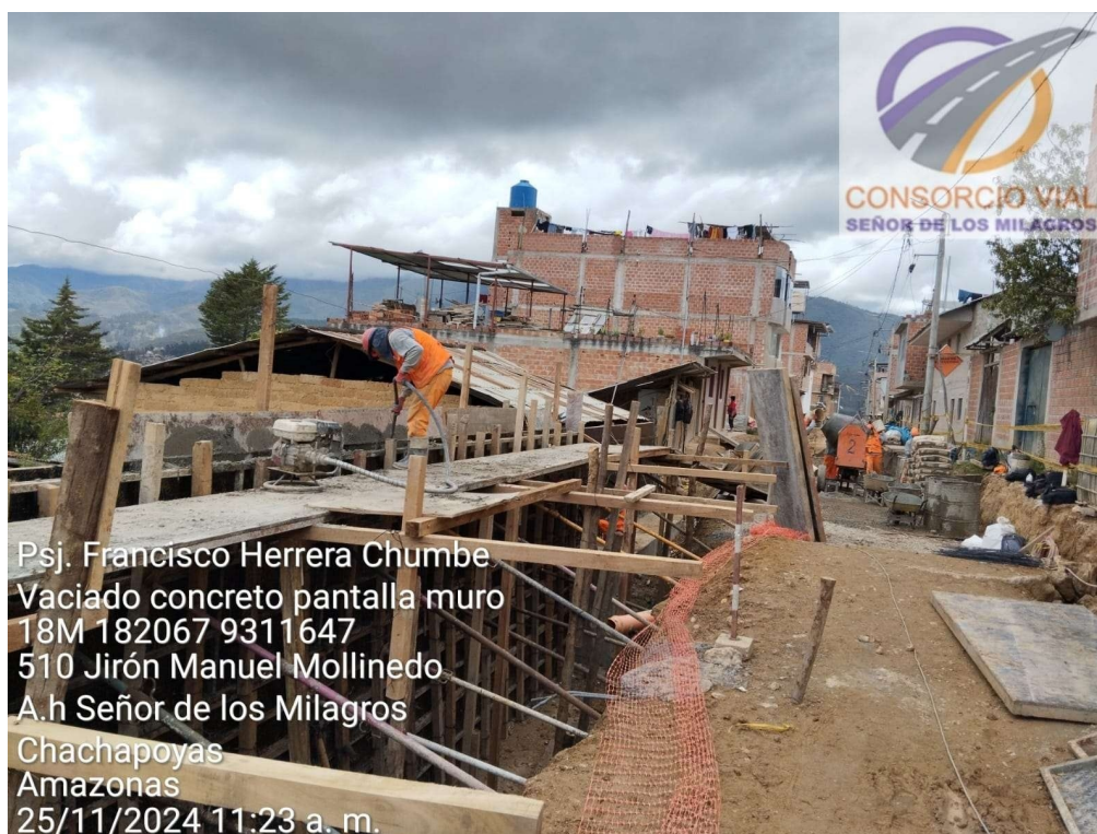
Vaciado de concreto en pantalla de muro de contención en obra: “Construcción de pistas y veredas de la Av. Aeropuerto y calles afines de la ciudad de Chachapoyas,
