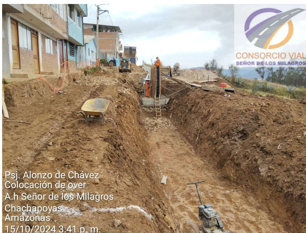
Colocación de material de mejoramiento con over en cimentación de muro contención en obra: “Construcción de pistas y veredas de la Av. Aeropuerto y calles
