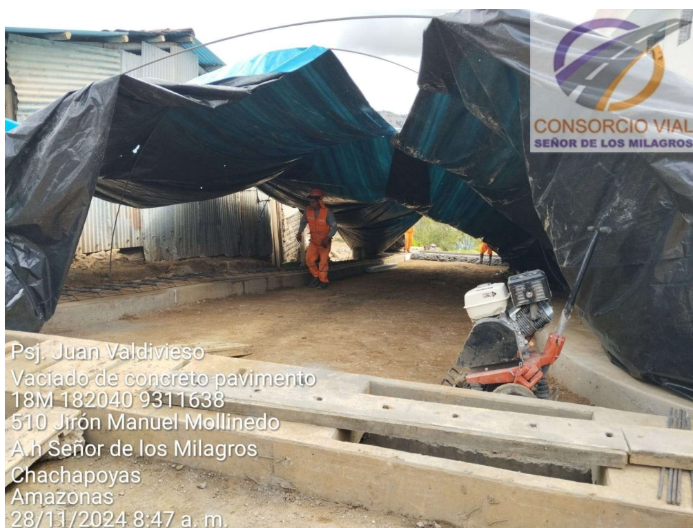
Preparación de base para vaciado de concreto en pavimento en obra: “Construcción de pistas y veredas de la Av. Aeropuerto y calles afines de la ciudad de
