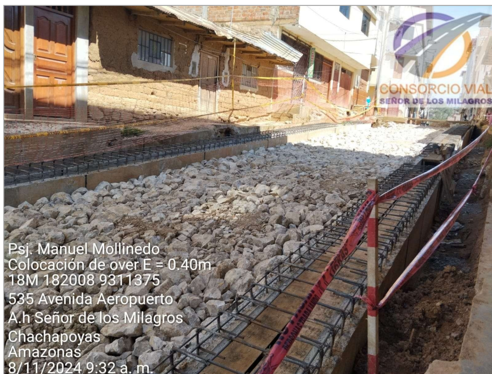
Colocación de material de mejoramiento con over en subrasante de pavimento en obra: “Construcción de pistas y veredas de la Av. Aeropuerto y calles afines de la ciudad
