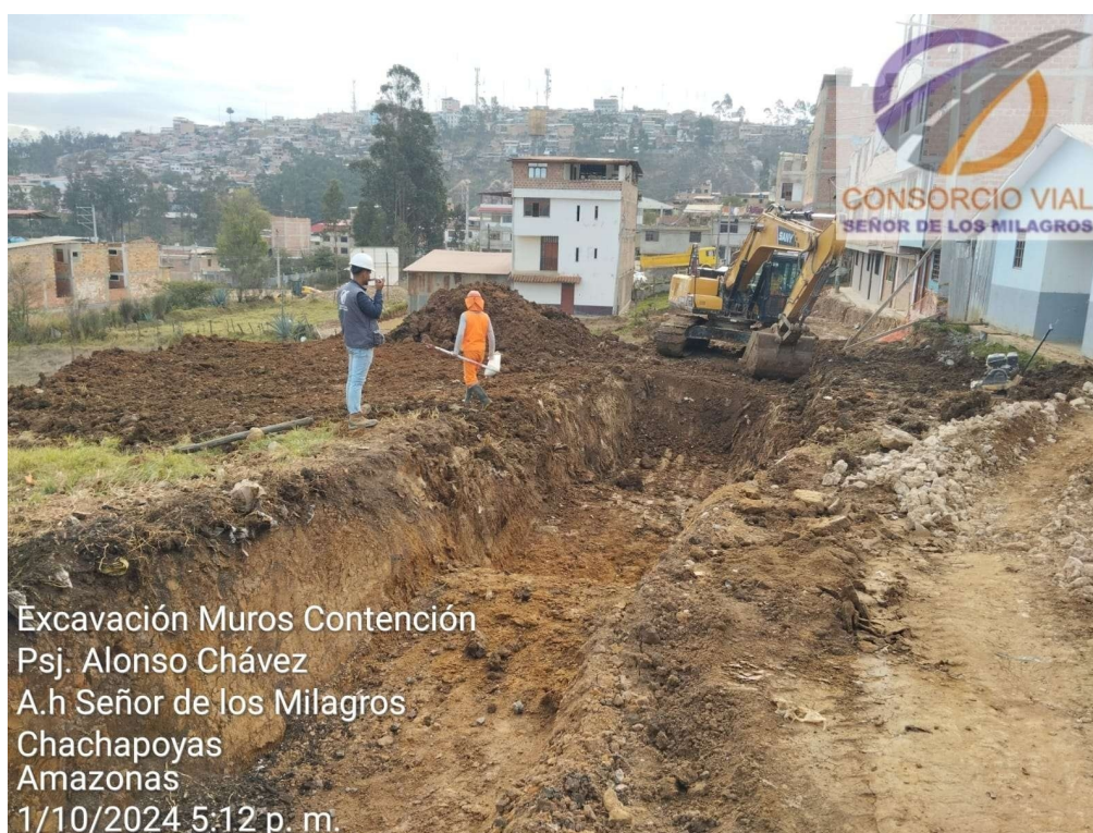
Excavación para cimentación de muro de contención en obra: “Construcción de pistas y veredas de la Av. Aeropuerto y calles afines de la ciudad de Chachapoyas,
