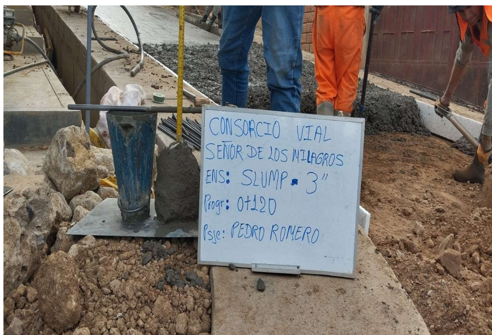
Realización de ensayo de Slump para concreto en pavimento en obra: “Construcción de pistas y veredas de la Av. Aeropuerto y calles afines de la ciudad de
