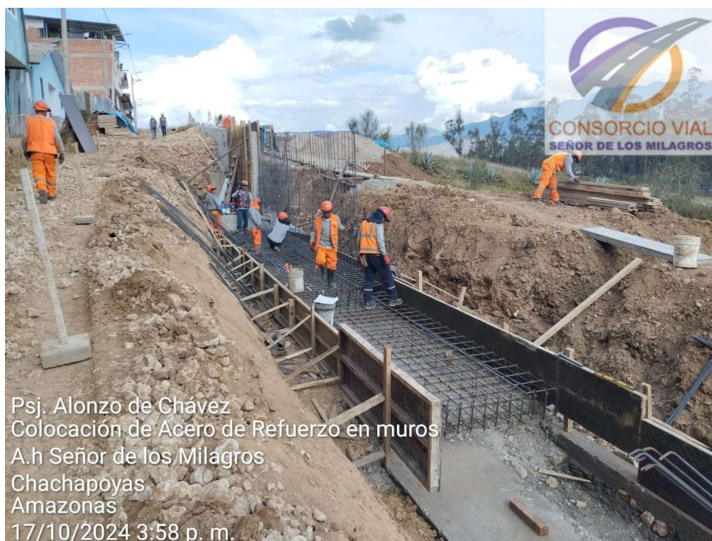
Colocación de acero de refuerzo en cimentación y pantalla de muro de contención en obra: “Construcción de pistas y veredas de la Av. Aeropuerto y calles afines de la
