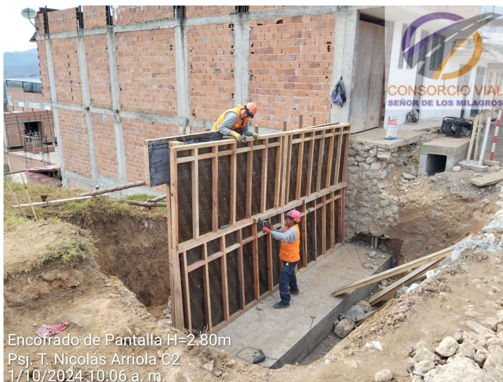
Encofrado de pantalla de muro de contención en obra: “Construcción de pistas y veredas de la Av. Aeropuerto y calles afines de la ciudad de Chachapoyas, Provincia de
