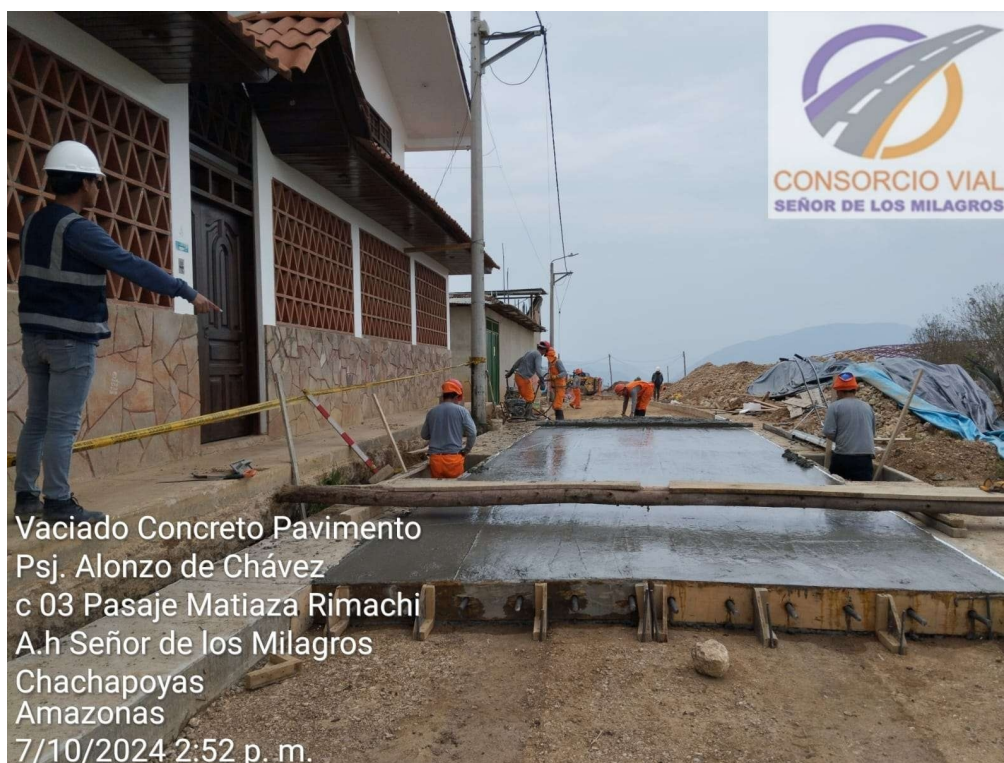
Vaciado de concreto para pavimento en obra: “Construcción de pistas y veredas de la Av. Aeropuerto y calles afines de la ciudad de Chachapoyas, Provincia de
