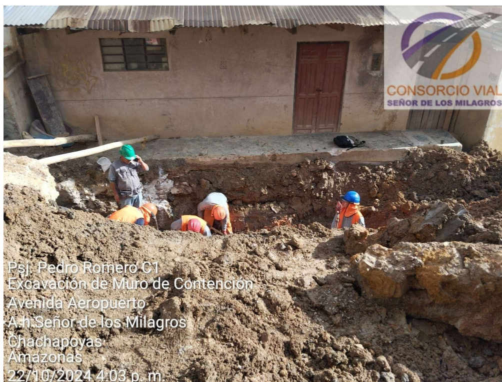
Excavación de cimentación de muro de contención en obra: “Construcción de pistas y veredas de la Av. Aeropuerto y calles afines de la ciudad de Chachapoyas,
