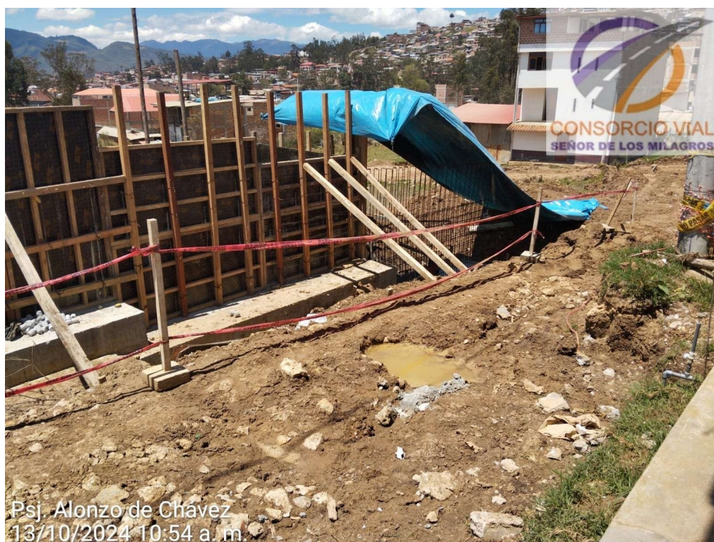
Encofrado de pantalla de muros de contención en obra: “Construcción de pistas y veredas de la Av. Aeropuerto y calles afines de la ciudad de Chachapoyas, Provincia de
