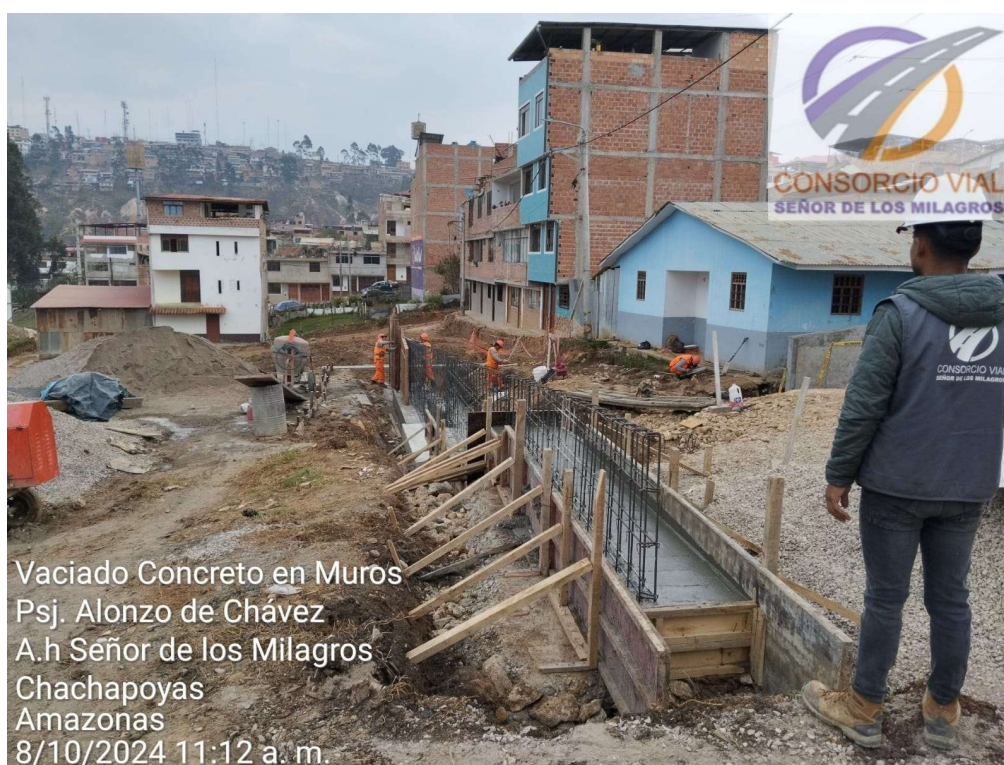
Vaciado de cimentación de muro de contención en obra: “Construcción de pistas y veredas de la Av. Aeropuerto y calles afines de la ciudad de Chachapoyas, Provincia
