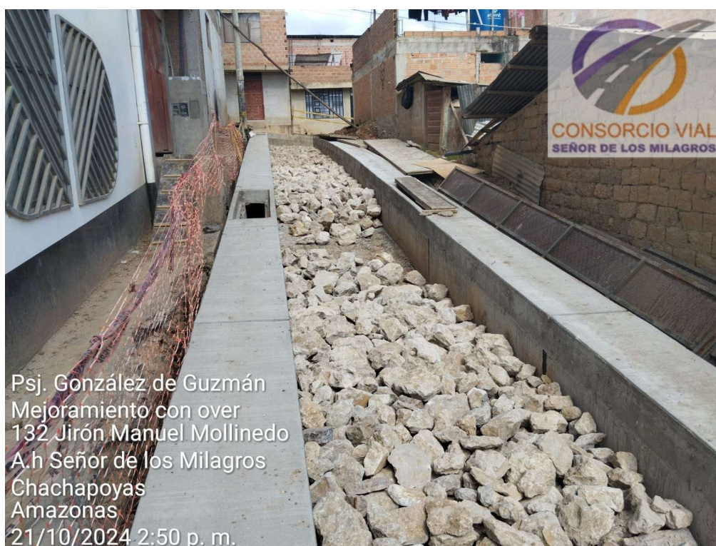
Colocación de capa de mejoramiento con over 2” a 8” en obra: “Construcción de pistas y veredas de la Av. Aeropuerto y calles afines de la ciudad de Chachapoyas,
