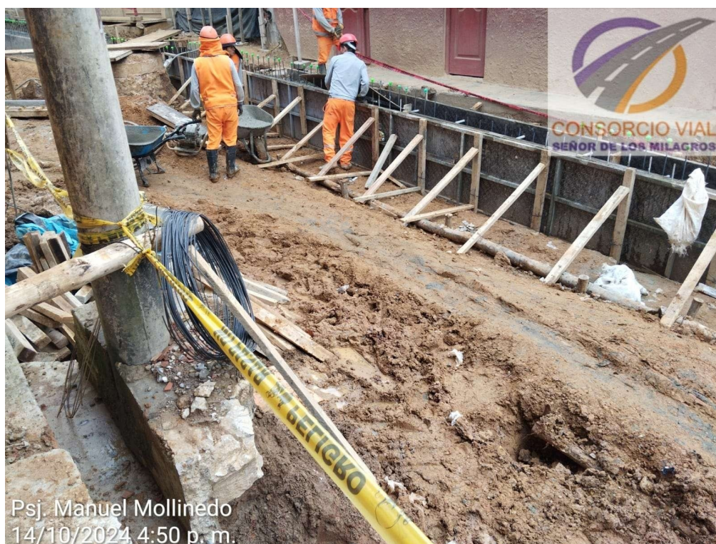
Vaciado de concreto en muros de cuneta en obra: “Construcción de pistas y veredas de la Av. Aeropuerto y calles afines de la ciudad de Chachapoyas, Provincia de
