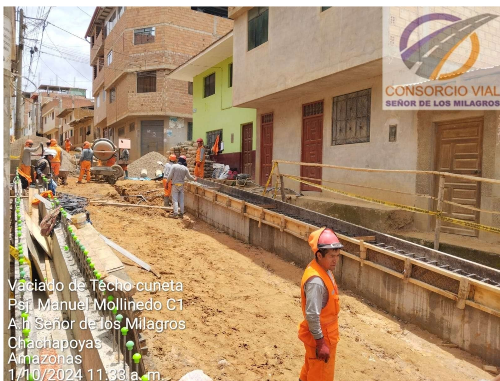
Vaciado concreto en techo de cuneta en obra: “Construcción de pistas y veredas de la Av. Aeropuerto y calles afines de la ciudad de Chachapoyas, Provincia de
