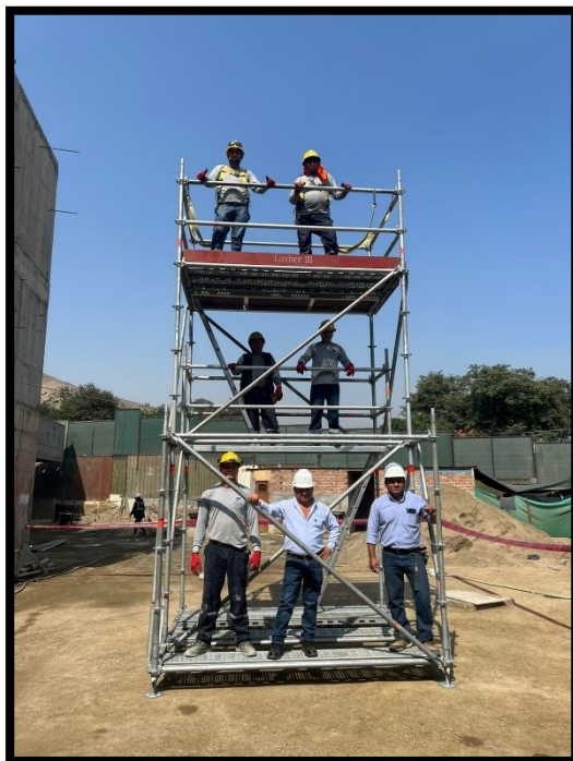
Fotografía 101 Capacitación de trabajos en altura y armado de andamios normados Layher
