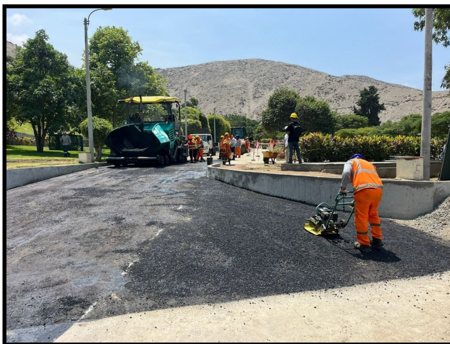
Fotografía 58 Colocación de asfalto y compactación con compactadora manual tipo plancha
