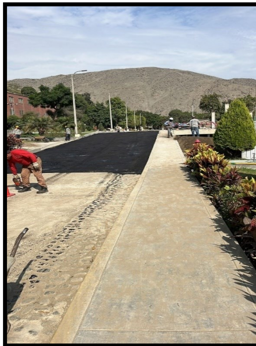
Fotografía 56 Imprimado y tendido de carpeta asfáltica en vía principal de ingreso del Colegio Villa María hacia el proyecto
