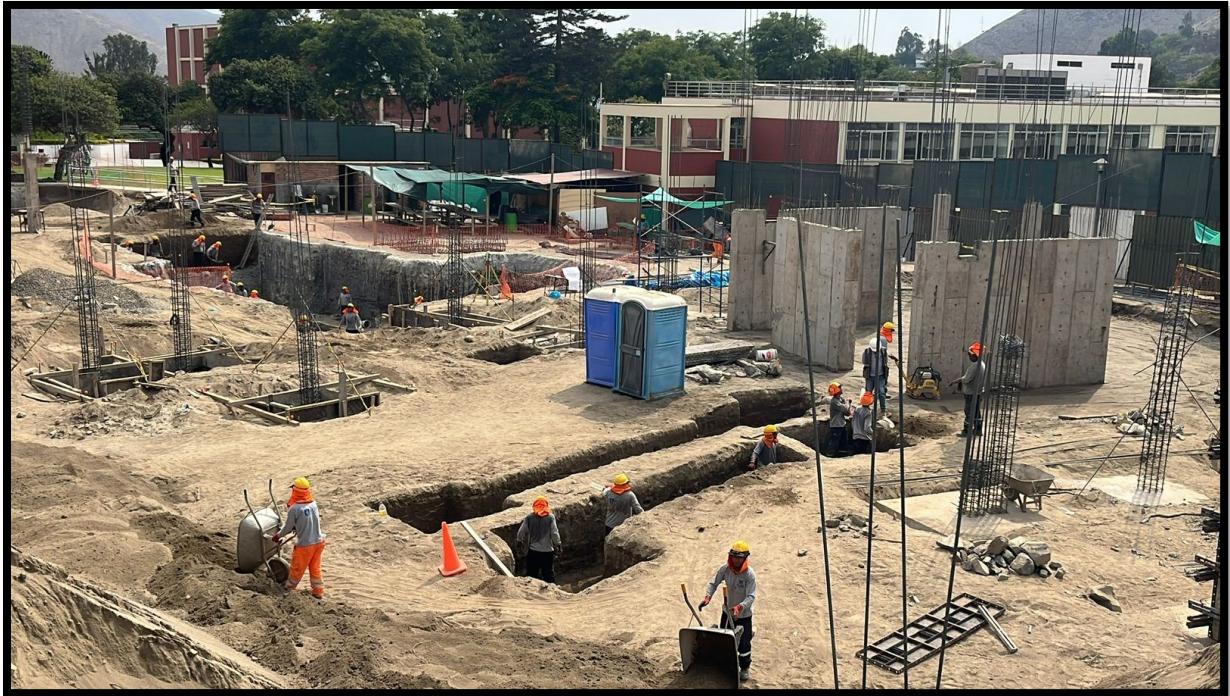
Fotografía 37 Vista panorámica donde se muestra sótano 2 y sótano 1, con elementos horizontales y verticales
