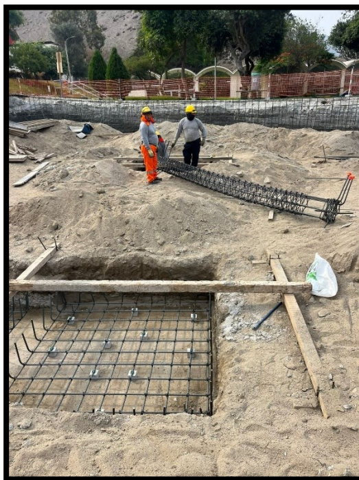
Fotografía 36 Se muestran operarios verificando área para izaje de columnas
