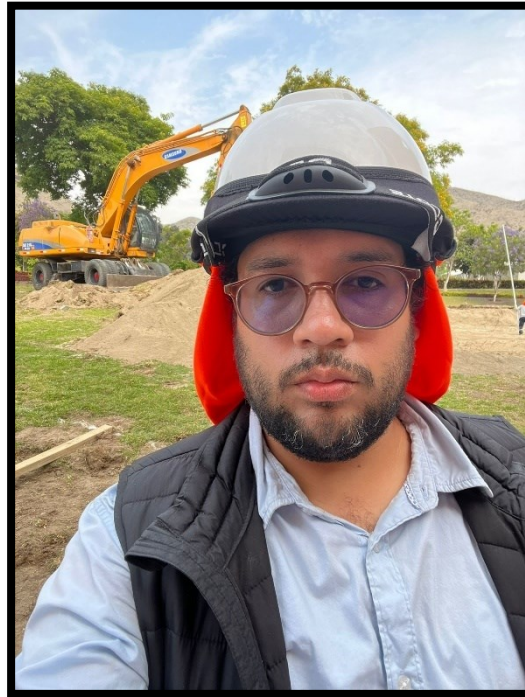
Fotografía 7 Supervisión en excavación masiva
