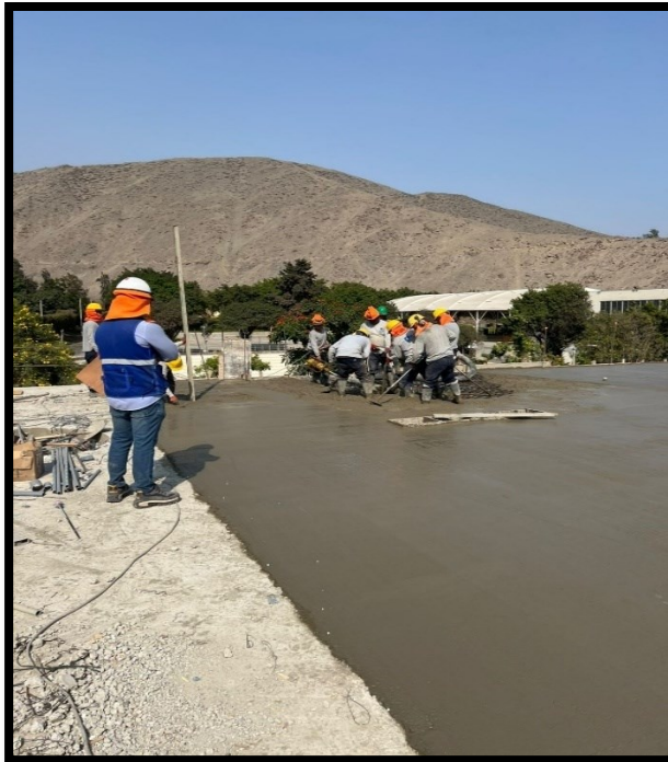
Fotografía 73 Vaciado de concreto para losa de piso 2
