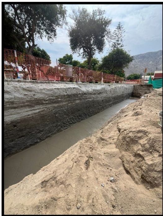
Fotografía 27 Se muestra vaciado de solado para colocación de muro de contención perimetral
