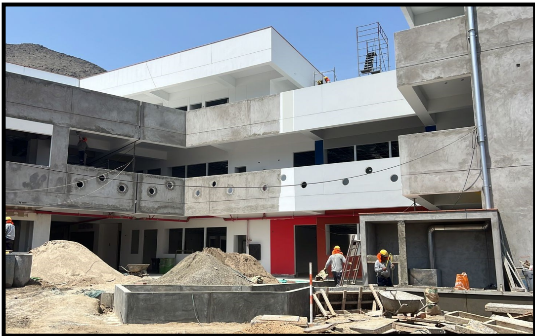
Fotografía 114 Vista de avance de obra, se evidencia etapa de pintado en fachada
