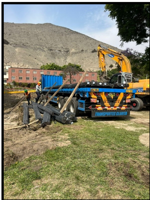
Fotografía 11 Llegada de material a obra, acero corrugado de refuerzo
