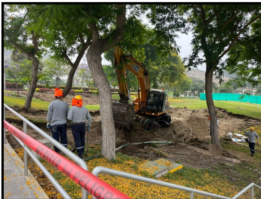
Fotografía 4 Se muestra excavación masiva y eliminación de árboles en el área de intervención
