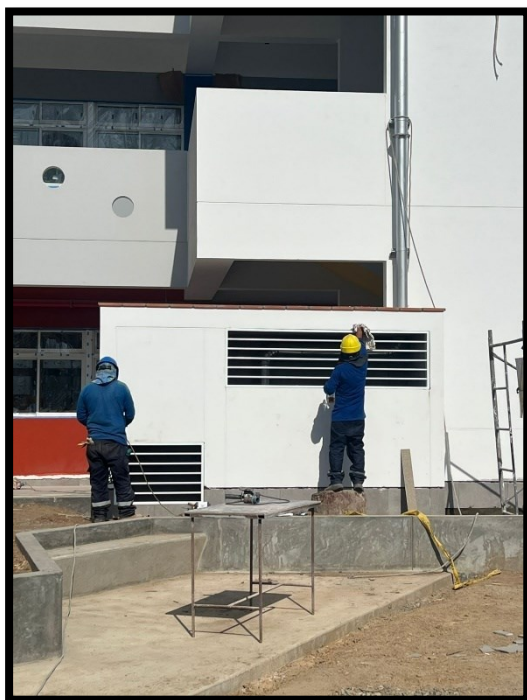
Fotografía 120 Colocación de rejillas en ducto del sótano 2 (grupo electrógeno, cuarto de bombas y cuarto de tableros)
