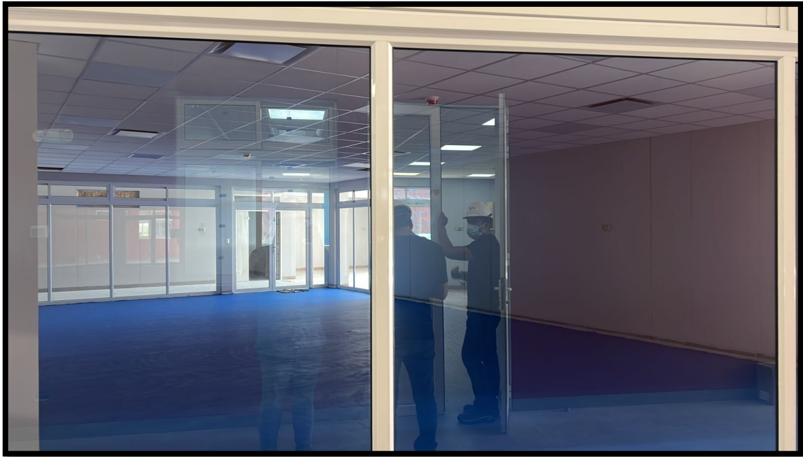
Fotografía 131 Instalación del sistema poliuretano en áreas de terapias ocupacionales, aula de psicomotricidad y patios
