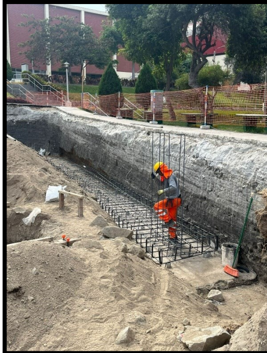
Fotografía 30 Colocación de acero vertical en muros de contención
