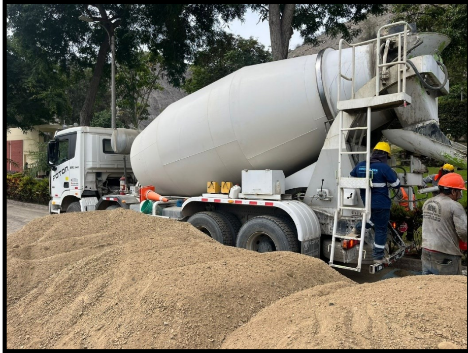
Fotografía 47 Llegada de camión mixer de concreto premezclado para el vaciado de losa maciza de sótano 1
