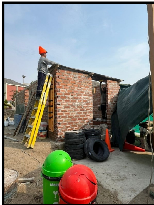
Fotografía 14 Instalación de techo de calamina en baños provisionales de obra
