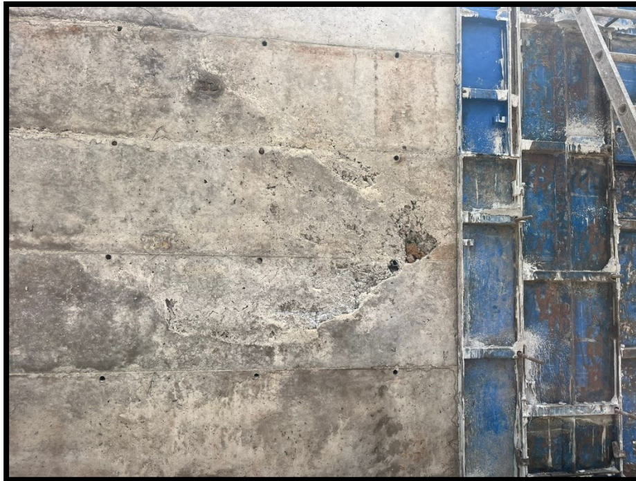
Fotografía 43 Se observa el desencofrado y la calidad del acabado del concreto vibrado en muro de contención
