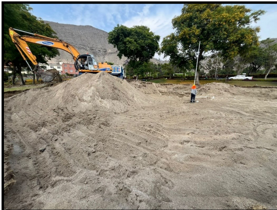
Fotografía 10 Se verifica niveles topográficos para definir altura de corte
