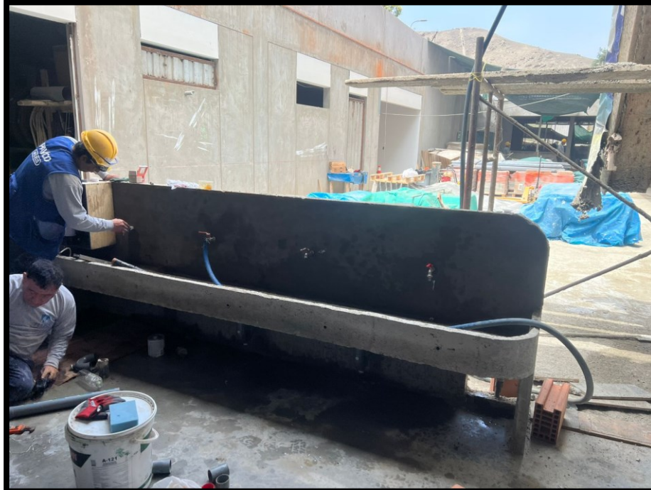
Fotografía 108 Instalación de trampas, sumideros y grifería (provisional) en lavamanos de taller de arte en sótano 1
