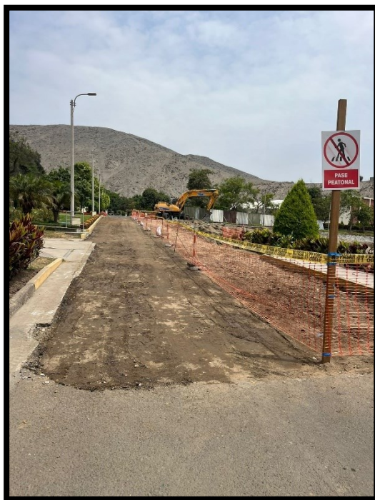
Fotografía 32 Señalización y cercamiento de vía principal interna del Colegio
