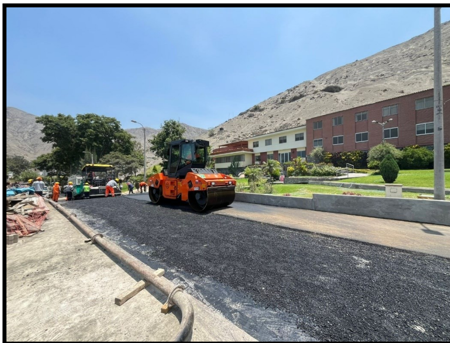
Fotografía 57 Compactación y nivelación de asfalto con rodillo nivelador
