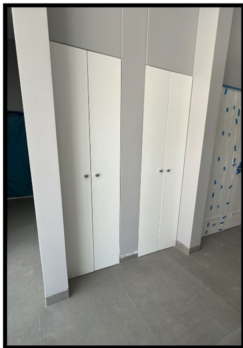
Fotografía 122 Instalación de puertas de melamina en ductos técnicos en todos los niveles del proyecto
