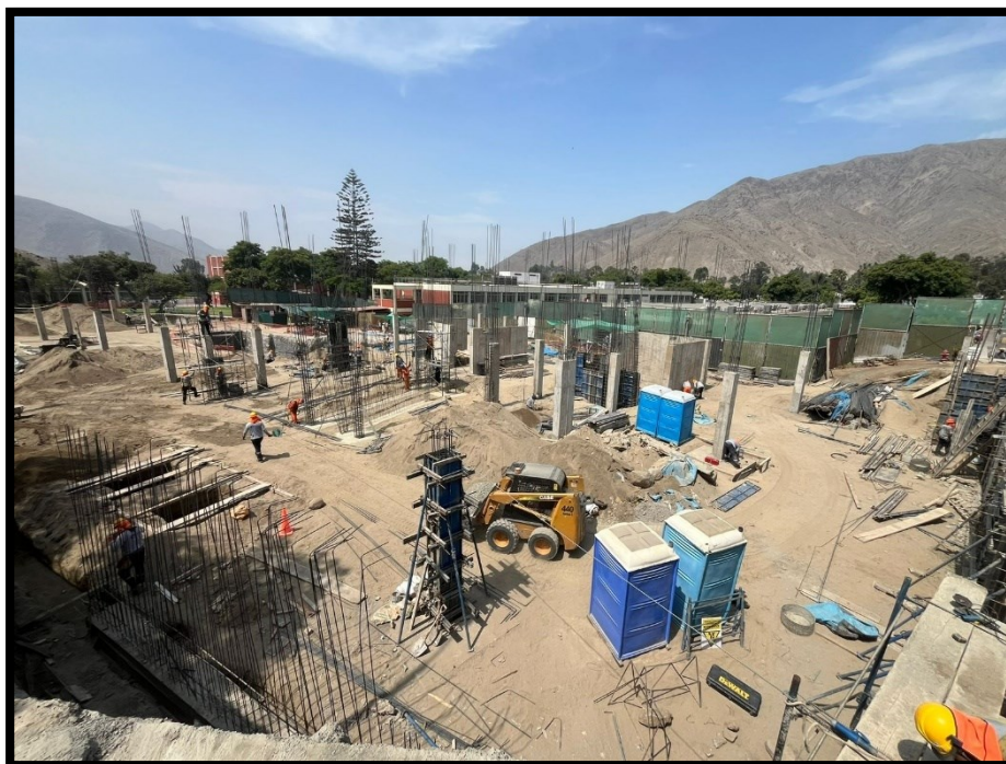
Fotografía 40 Vista amplia de elementos estructurales del sótano 2
