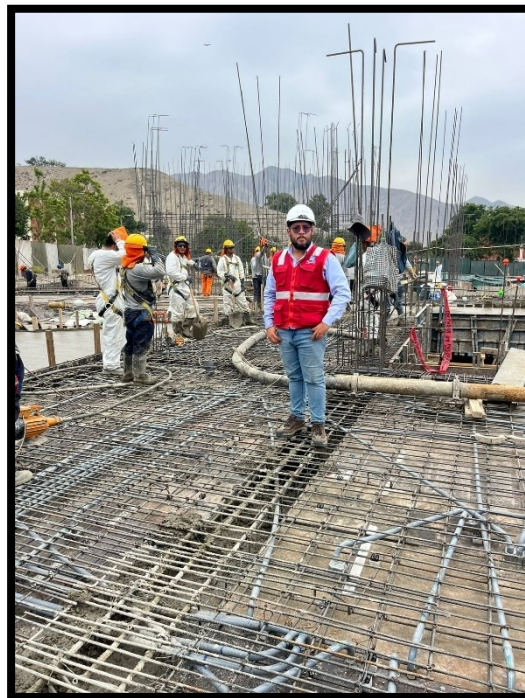
Fotografía 48 Verificación del correcto vaciado y vibrado de concreto en losa y vigas
