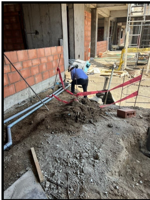
Fotografía 72 Se observa al maestro de obra verificando pendiente de tubería sanitaria
