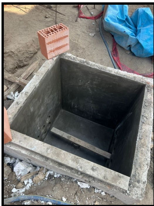
Fotografía 81 Pulido interior de buzones eléctricos en circulaciones y patio del proyecto
