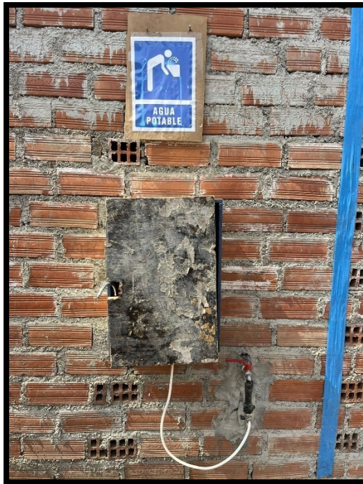
Fotografía 33 Instalación de puntos de hidratación
