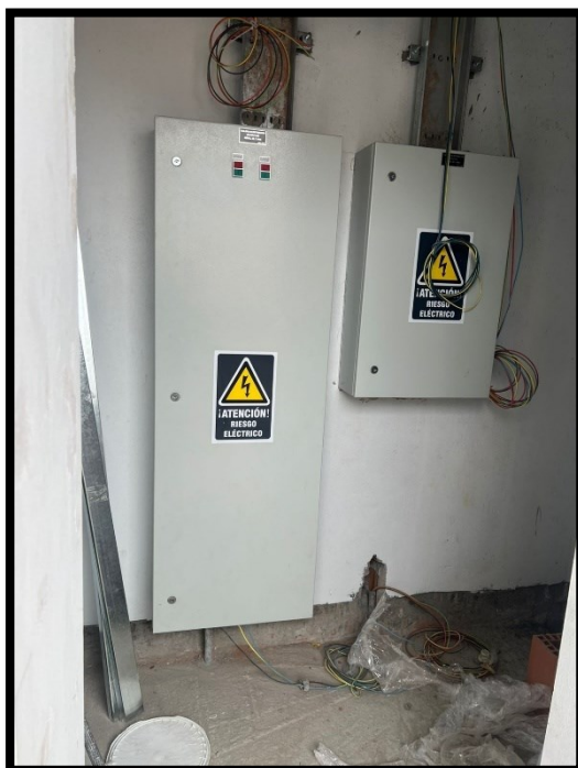
Fotografía 96 Montaje de tableros eléctricos en cuartos técnicos del sótano 2, sótano 1, piso 1, piso 2 y azotea
