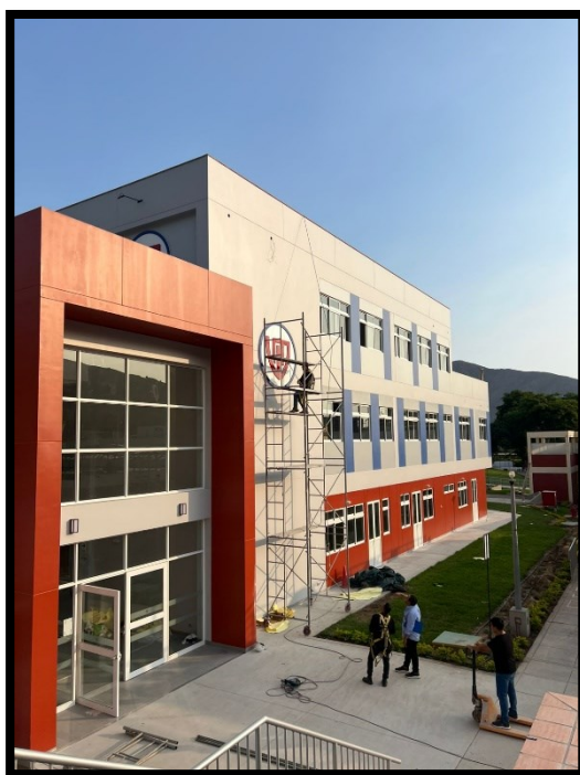
Fotografía 148 Vista de fachada principal del proyecto
