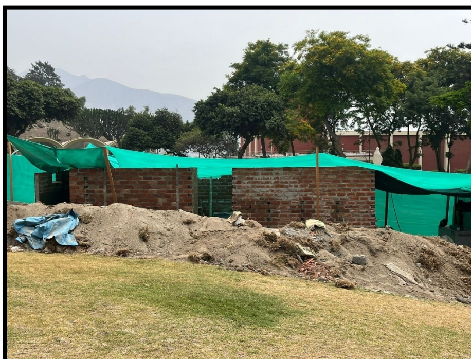
Fotografía 6 Construcción de baños provisionales
