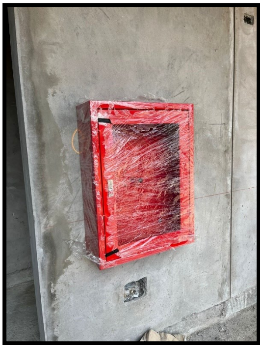
Fotografía 85 Colocación de gabinetes para mangueras de agua contra incendio
