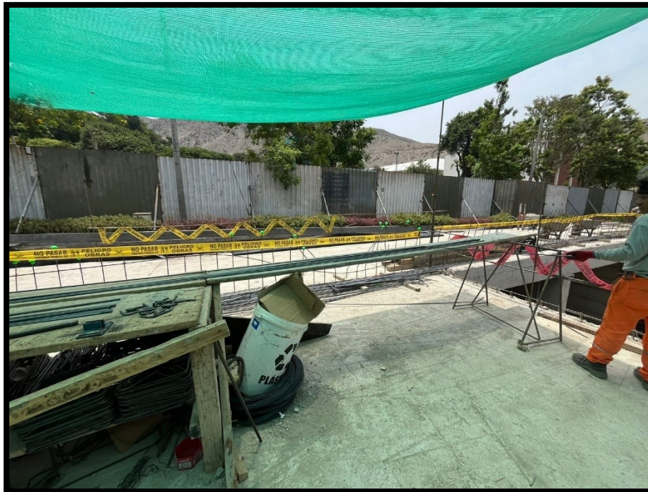
Fotografía 61 Se observa banco de herrería instalado en piso 1
