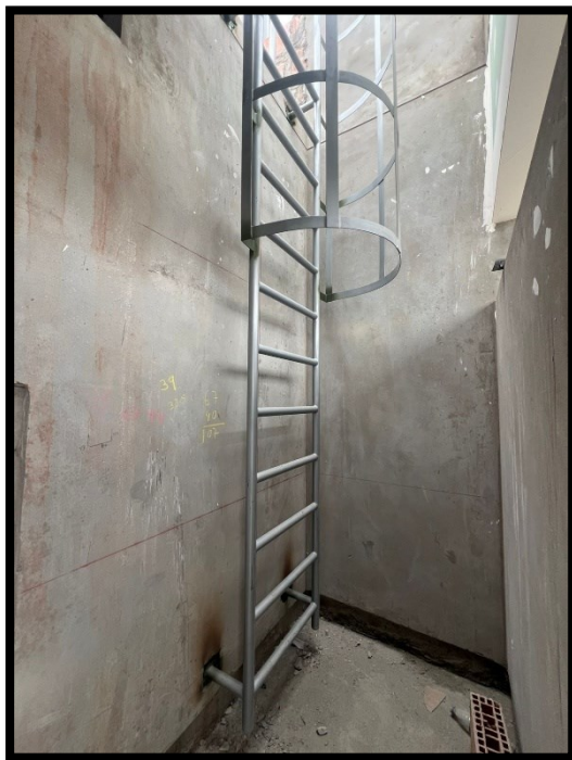
Fotografía 105 Instalación y pintado de escalera tipo gato, en acceso para azotea del proyecto
