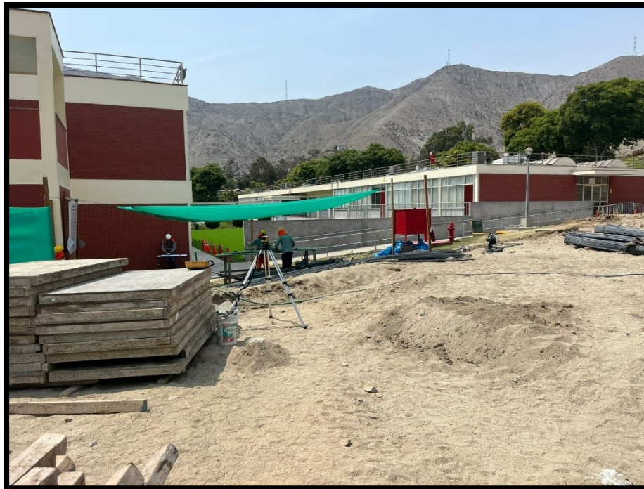
Fotografía 21 Verificación de niveles en excavaciones focalizadas
