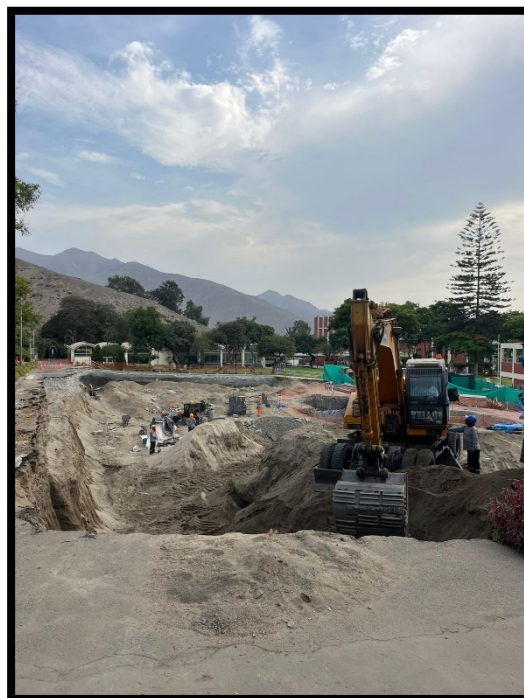
Fotografía 26 Vista panorámica de excavación masiva
