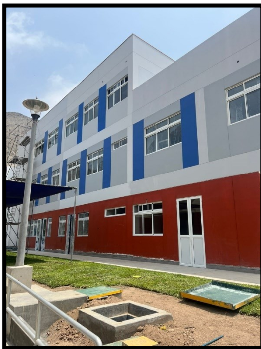
Fotografía 136 Vista de fachada principal, con dos manos de pintura
