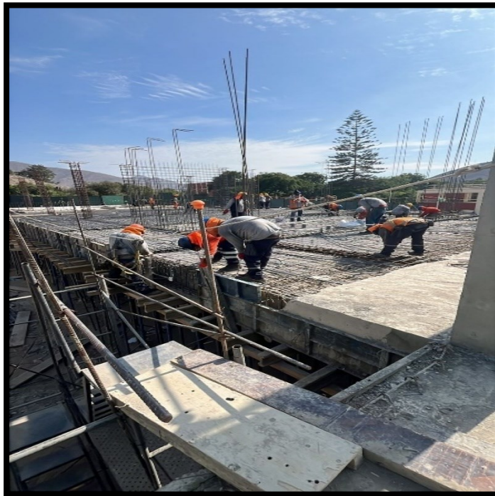
Fotografía 55 Colocación de encofrado metálico y armado de malla en losa de piso 1
