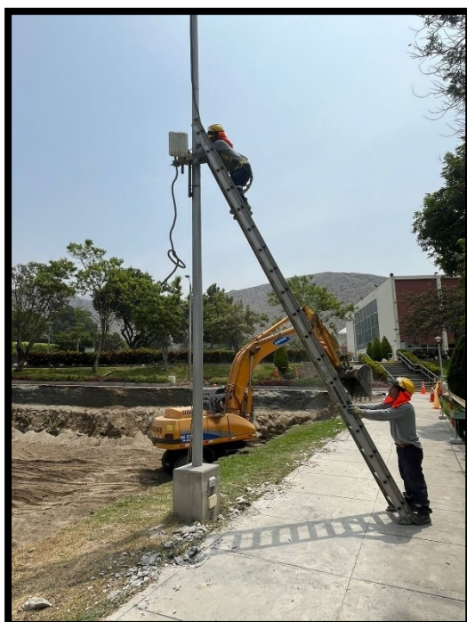
Fotografía 12 Desmontaje de equipos de internet y postes eléctricos
