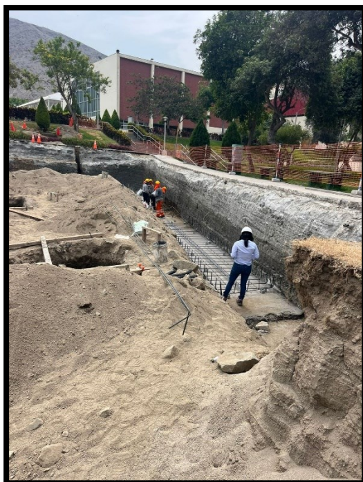
Fotografía 28 Arquitecta de calidad, verificando disposición de acero en malla para muro de contención
