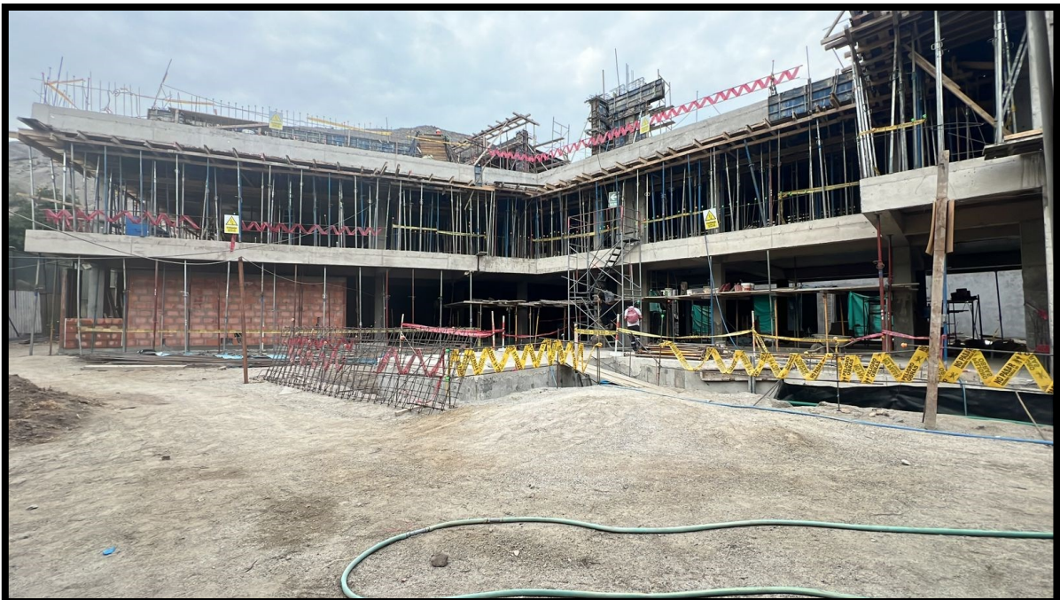
Fotografía 66 Avance de obra, vaciado de placas en piso 2 y asentado de muro block de arcilla en sótano 1
