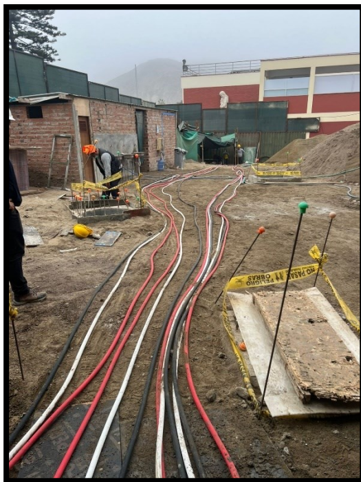
Fotografía 95 Tendido de ternas eléctrica provenientes de subestación 2 del pabellón de primaria baja
