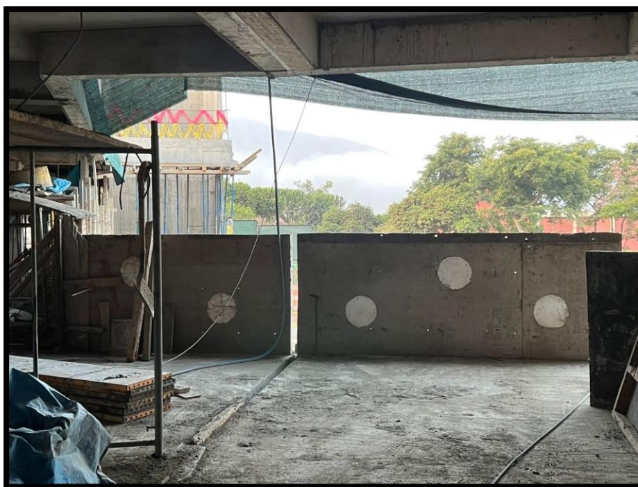
Fotografía 76 Construcción de parapetos de concreto armado con aperturas circulares en piso 1
