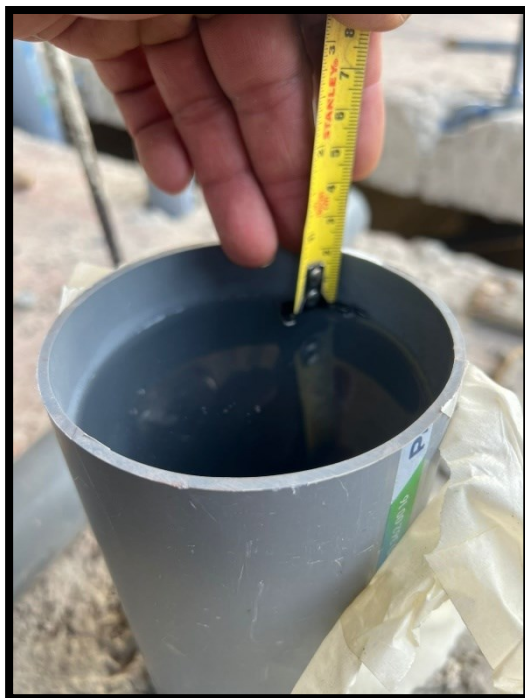
Fotografía 77 Prueba de estanqueidad en montantes de desagüe en todo sótano 1
