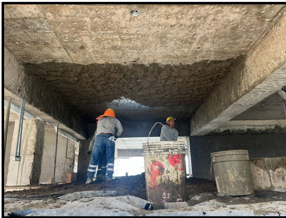
Fotografía 87 Se observa el tarrajeo de fondo de losa
