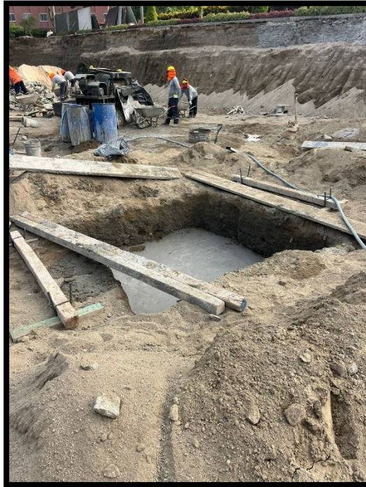
Fotografía 29 Vaciado de solado para zapatas aisladas del proyecto
