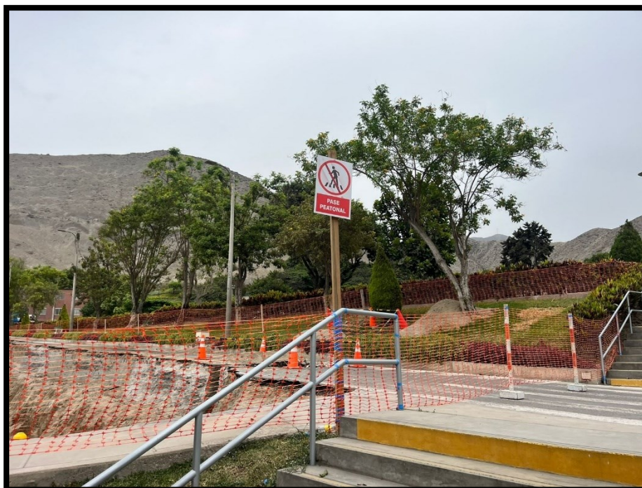
Fotografía 22 Cerramiento con malla HDPE en perímetro de área de intervención
