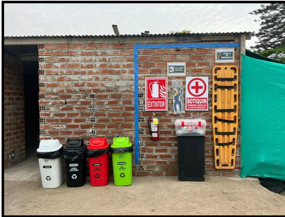
Fotografía 13 Panel de primeros auxilios, tachos para residuos para la obra
