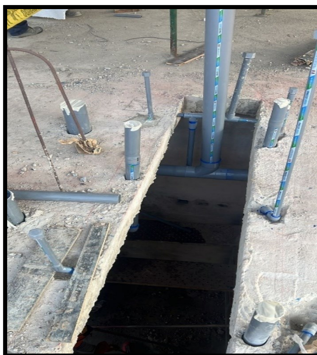
Fotografía 80 Se observa tuberías de instalaciones sanitarias en losa
