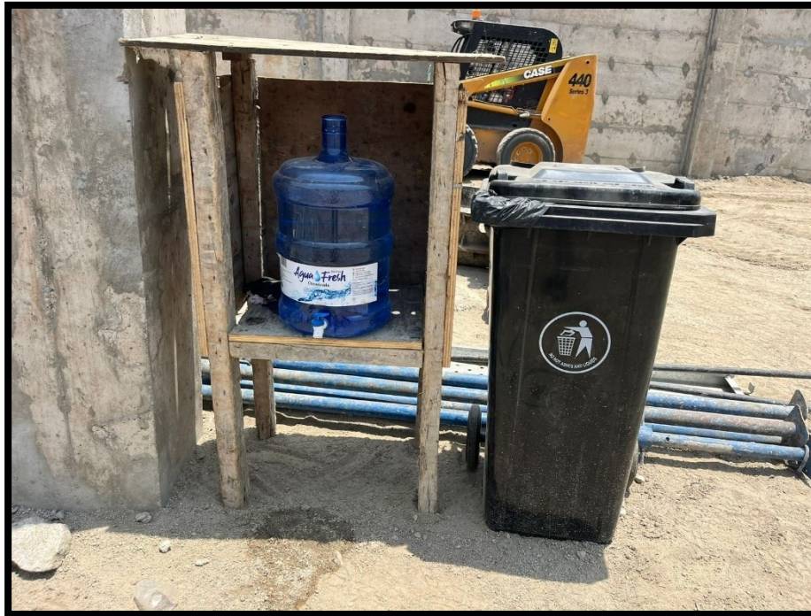
Fotografía 45 Puntos de hidratación y tachos para residuos en diversos puntos de la obra
