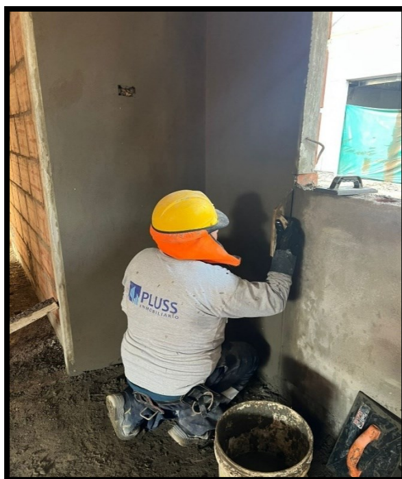
Fotografía 78 Bruñado en juntas de dilatación entre estructura, muros
