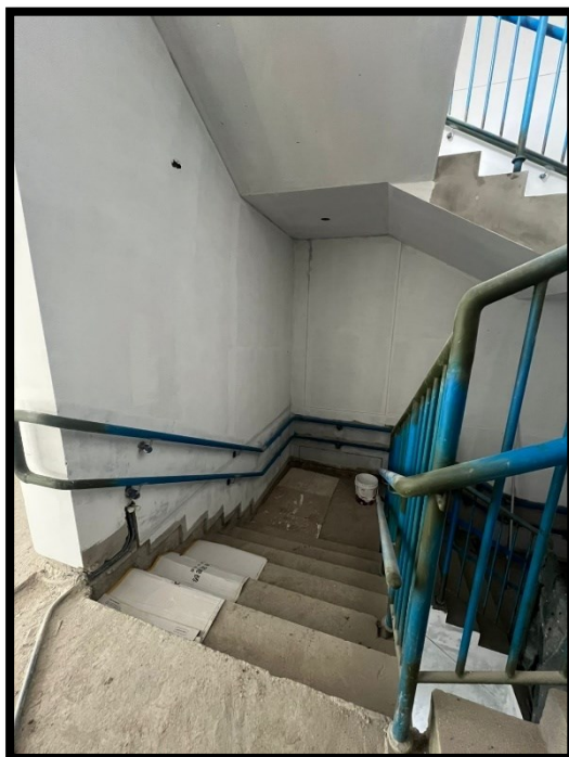
Fotografía 102 Instalación de baranda doble en escalera integrada 1
