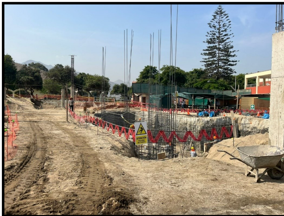
Fotografía 42 Señalización por excavación masiva y armado de elementos estructurales verticales en sótano 2
