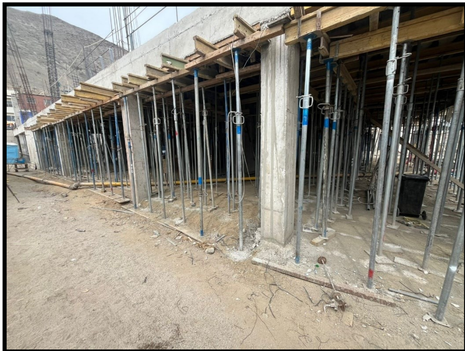
Fotografía 52 Verificación de correcta disposición de puntales para fondos de viga y losa
