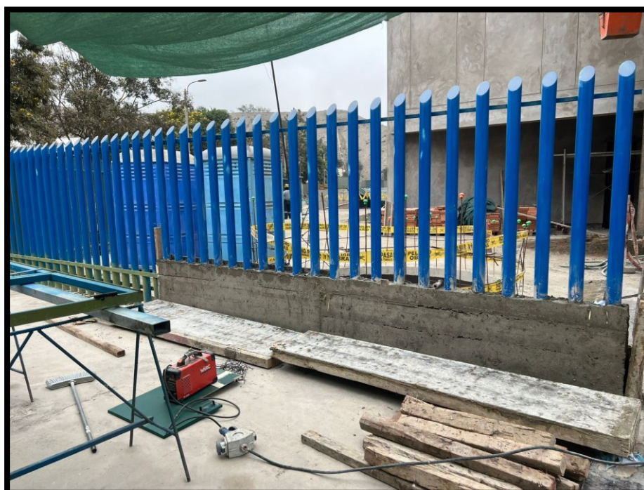
Fotografía 104 Colocación de tubos metálicos no escalables en cerco perimétrico en piso 1
