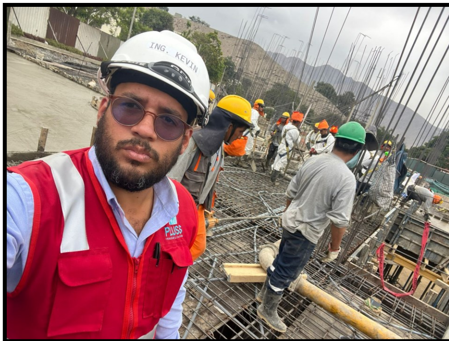
Fotografía 49 Verificación de frisos con capataz de encofrado de subcontrata
