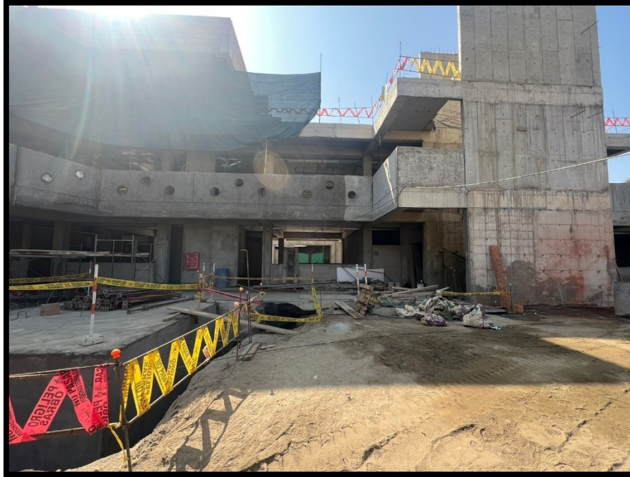
Fotografía 89 Avance de obra, casco estructural acabado al 100%
