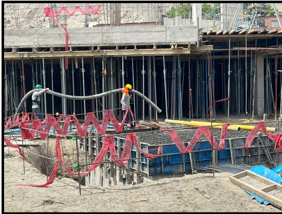
Fotografía 53 Vaciado de losa maciza en el área de cisterna de sótano 2
