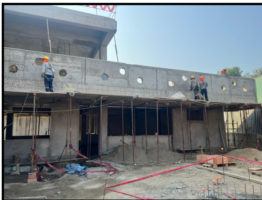
Fotografía 82 Tarrajeo de estructuras (parapetos, vigas, columnas)
