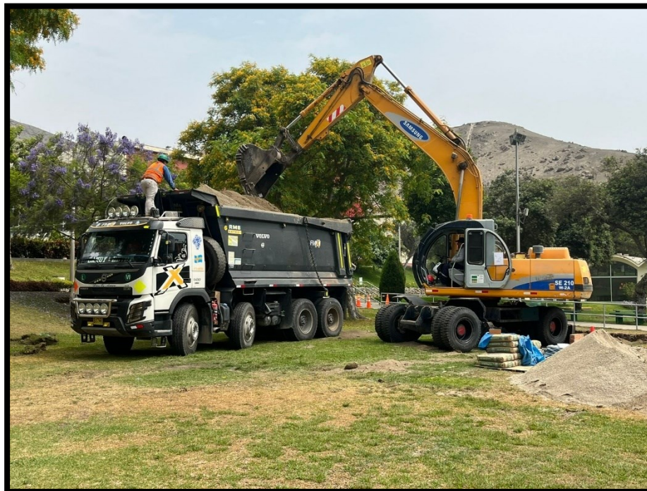
Fotografía 8 Eliminación de desmonte
