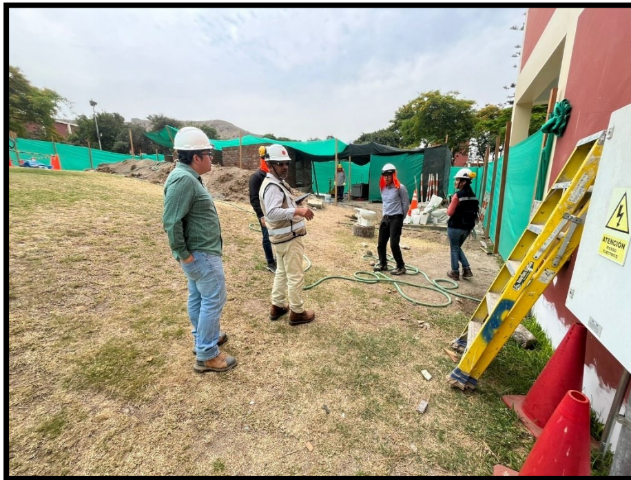
Fotografía 3 Visita de inspector municipal en obras provisionales del proyecto
