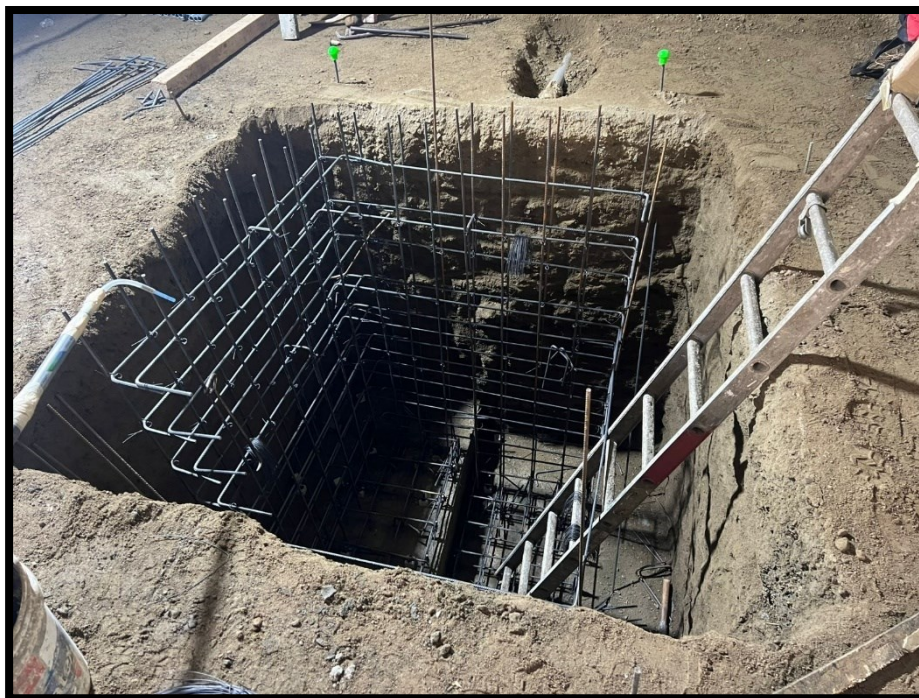
Fotografía 75 Se observa excavación y armado de parrilla de pozo sumidero en cuarto de bombas del sótano 2
