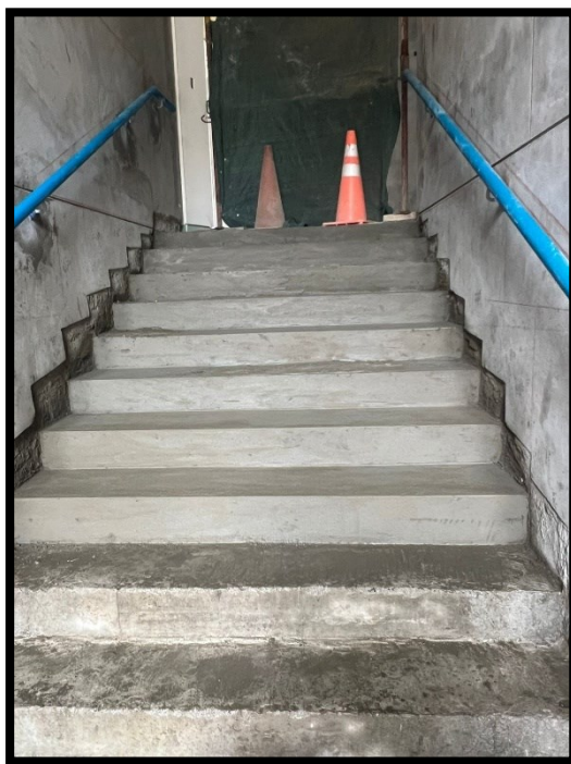
Fotografía 103 Instalación de baranda en escalera integrada 2
