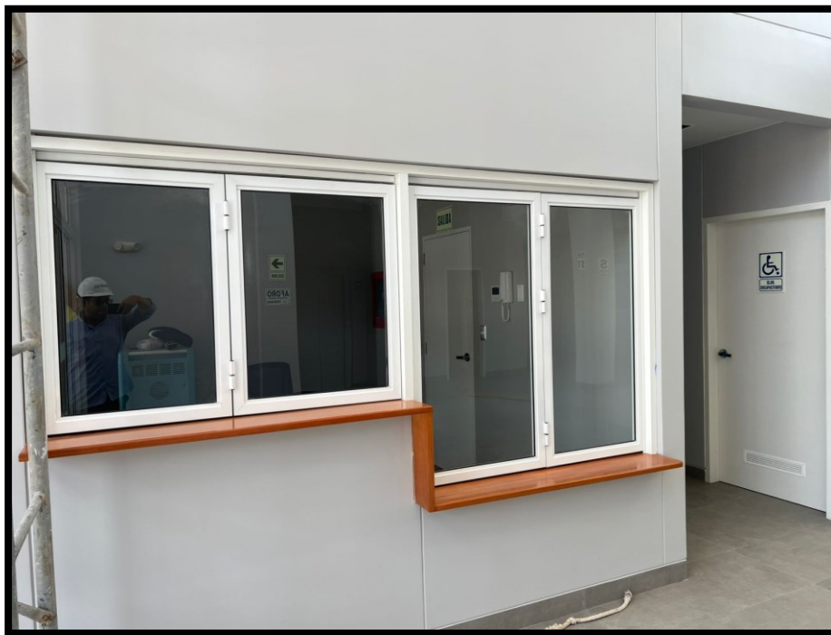
Fotografía 141 Vista frontal del ambiente de recepción de prekínder del sótano 1
