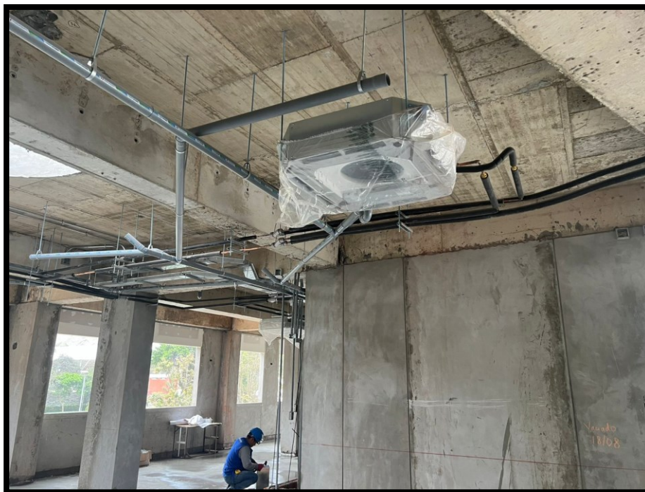
Fotografía 111 Se evidencia equipos de aire acondicionado tipo cassette, tubería de cobre, instalaciones sanitarias colgadas en losa
