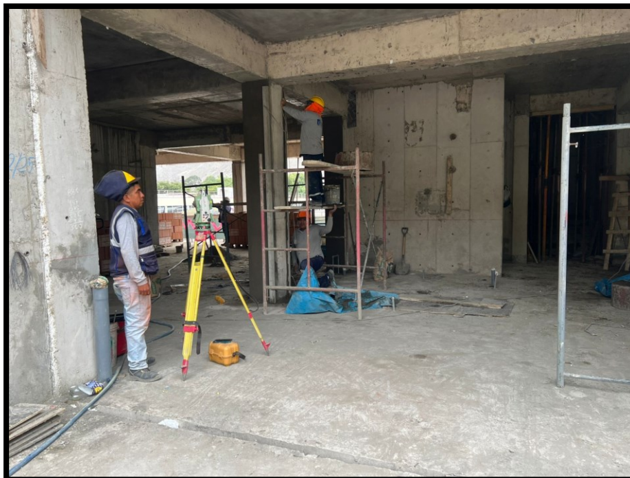
Fotografía 69 Nivelación y colocación de puntos para tarrajeo
