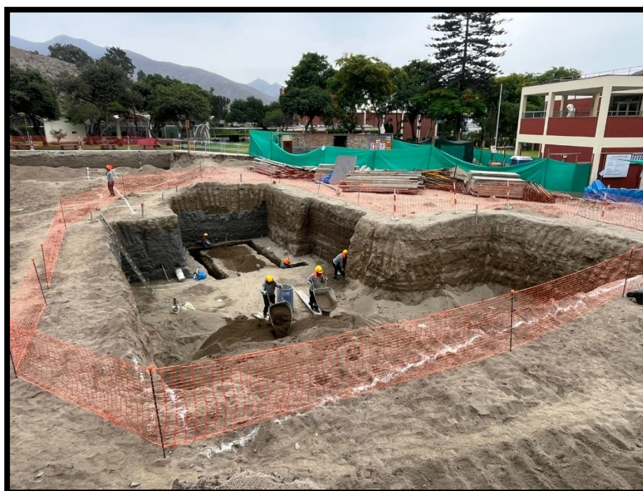
Fotografía 24 Excavación focalizada para cisterna, cuarto de grupo electrógeno y cuarto de bombas en sótano 2
