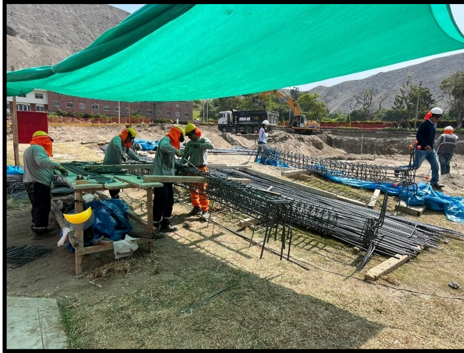
Fotografía 19 Banco de herrería en actividad de habilitación, corte y armado de estructuras
