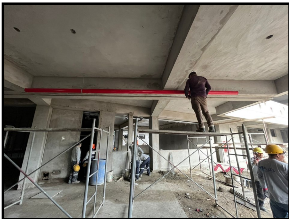
Fotografía 86 Se observa personal subcontratista de ACI instalando tubería roja de agua contra incendio
