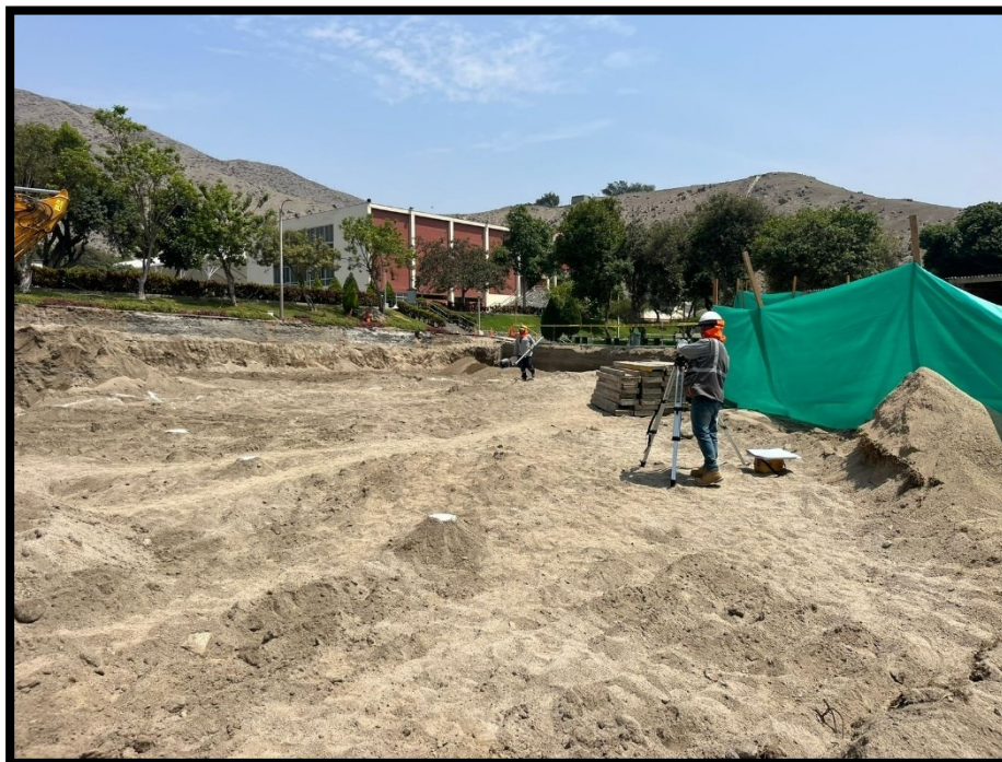
Fotografía 16 Emplantillado de niveles de sótano 1
