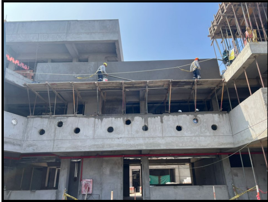
Fotografía 99 Se evidencia trabajos de tarrajeo en fachada del proyecto
