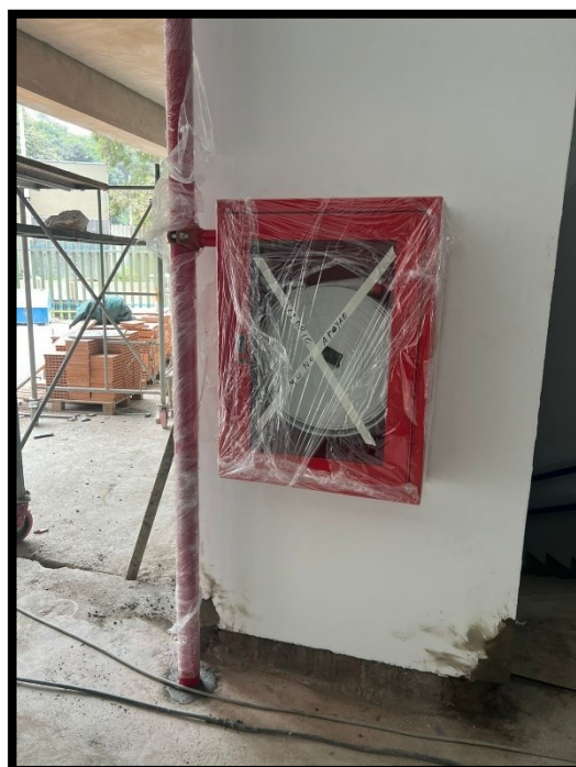
Fotografía 112 Instalación final de gabinete contra incendio equipado
