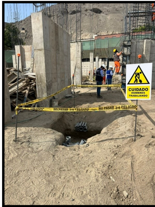
Fotografía 41 Señalización por excavación de buzón eléctrico
