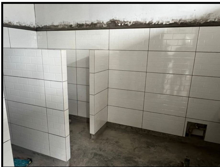
Fotografía 98 Se monitorea y controla cartaboneo de enchape de porcelanato en muros de baños niñas
