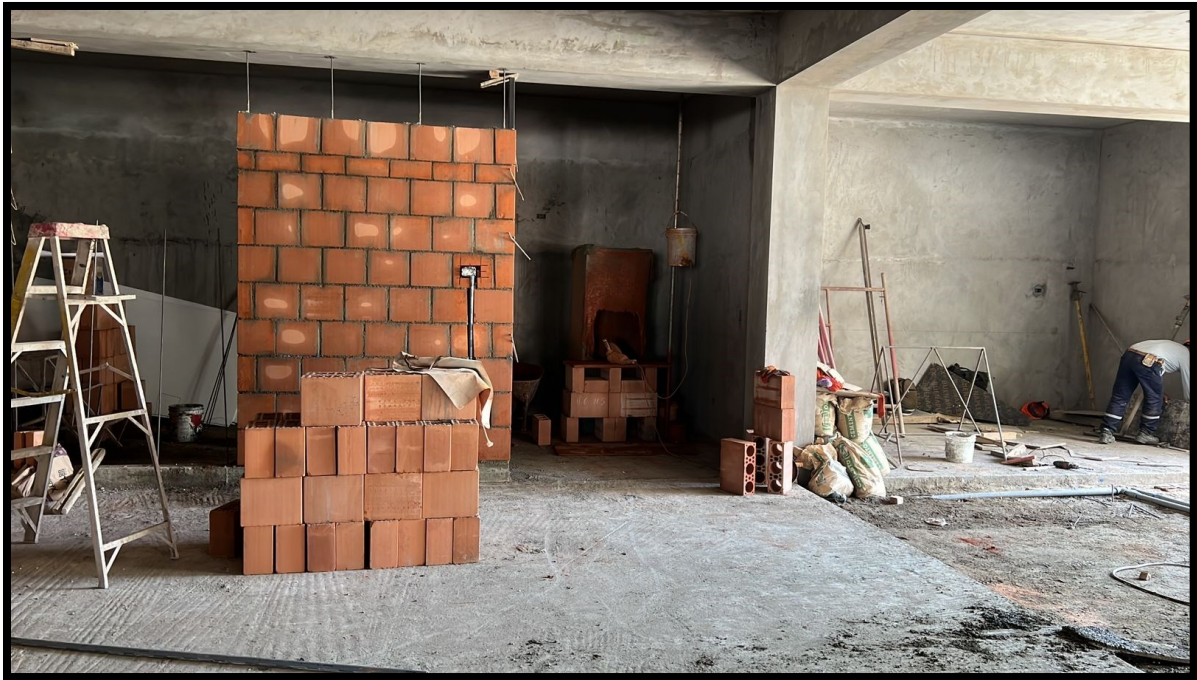
Fotografía 65 Se observa el asentado de block de arcilla e instalaciones eléctricas
