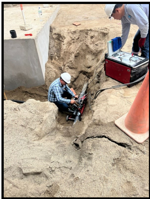
Fotografía 91 Se observa a personal de la especialidad ACI. realizando instalación de válvula por medio de termofusión
