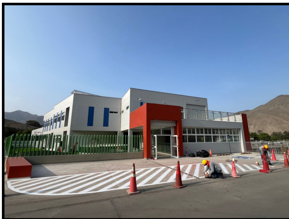
Fotografía 146 Se muestra ingreso a Kinder, pintado de líneas de bahía para vehículos, y estacionamientos para discapacitados con topes de llantas
