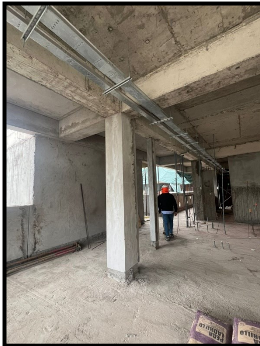
Fotografía 90 Montaje de bandejas y ductos eléctricos y de HVAC
