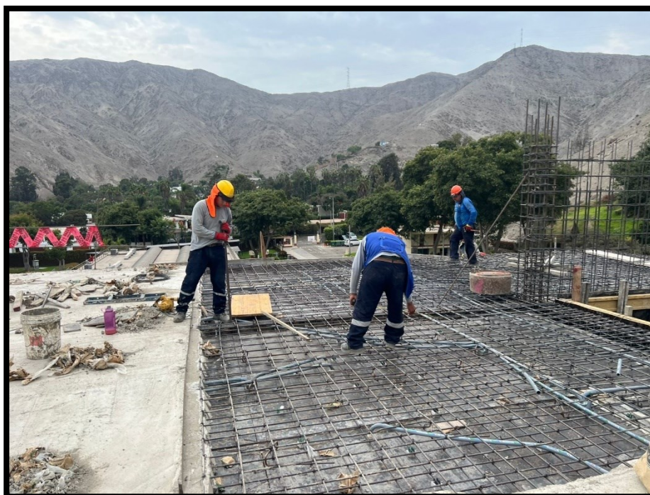
Fotografía 68 Verificación de correcto tendido de tubería sanitaria en losa
