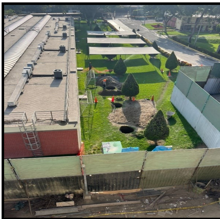
Fotografía 92 Personal de obra realizando pozos a tierra para el proyecto
