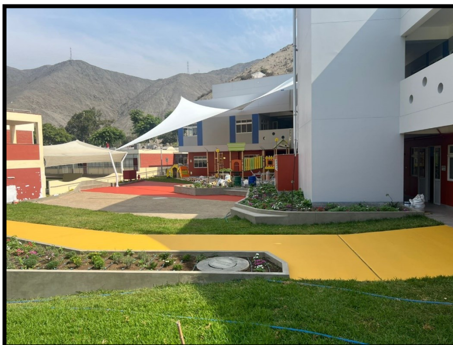
Fotografía 150 Vista panorámica de patio prekínder, se muestra piso de poliuretano, grass natural, juegos de PVC, toldos tensionados, jardineras
