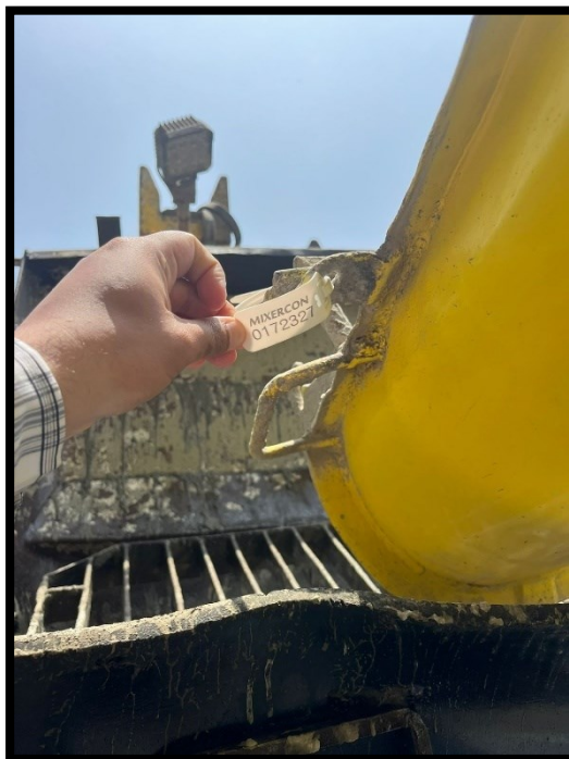
Fotografía 34 Verificación de calidad del concreto, precinto de seguridad y pruebas respectivas
