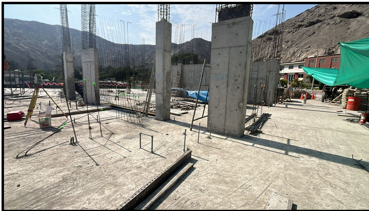
Fotografía 60 Se observan elementos estructurales como muros de corte y vigas, así como pases de instalaciones sanitarias
