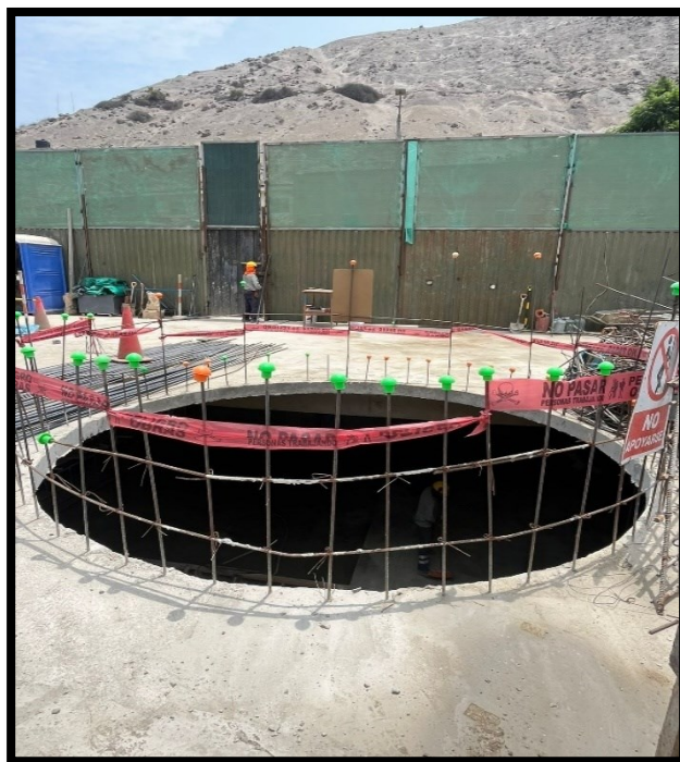
Fotografía 63 Señalización en mechas de teatina circular en losa de sótano 1
