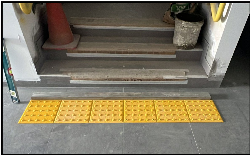
Fotografía 118 Instalación de podotáctiles en cambios de niveles en escaleras
