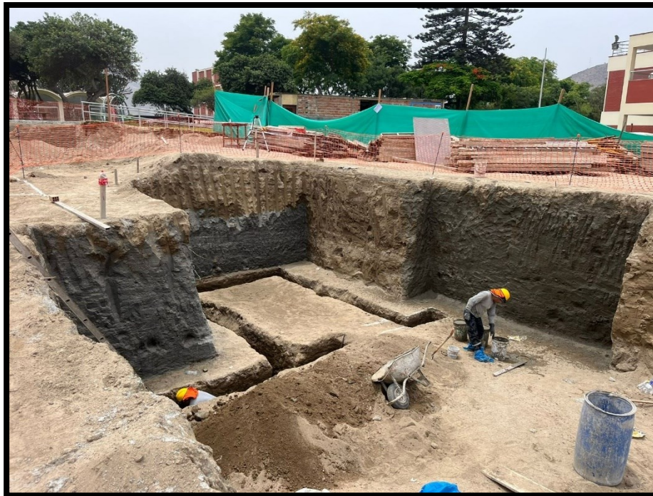
Fotografía 25 Excavación de cimiento para escalera desde sótano 2
