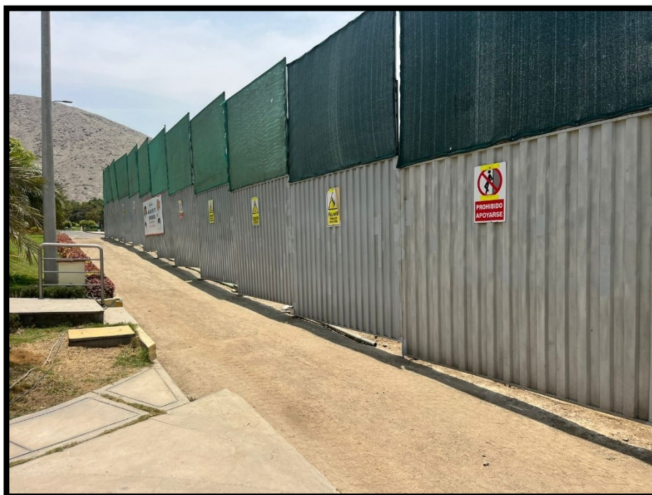
Fotografía 44 Se muestra cerco metálico perimétrico con malla raschell para mitigación de polvo, debidamente señalizado
