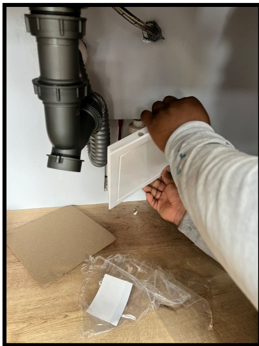
Fotografía 133 Instalación de trampas metálicas, tapas de PVC de válvulas
