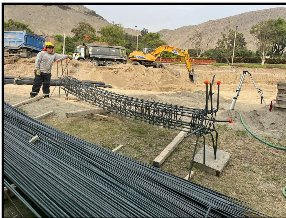
Fotografía 18 Armado de columna de acuerdo con distribución de plano estructural
