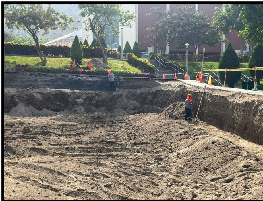
Fotografía 17 Perfilado de perímetro excavado
