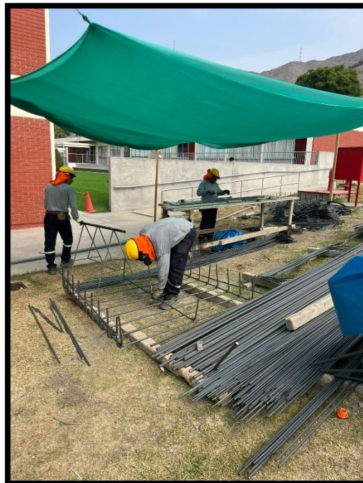
Fotografía 20 Armado de zapatas para cimentaciones de sótano 1
