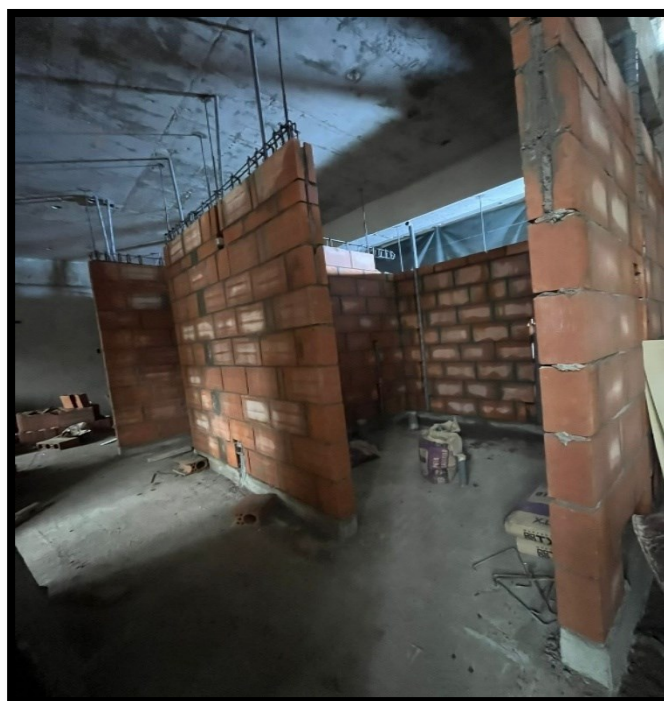
Fotografía 70 Se puede observar sobrecimiento, asentado de block arcilla y colocación de viga collarín en muros del proyecto
