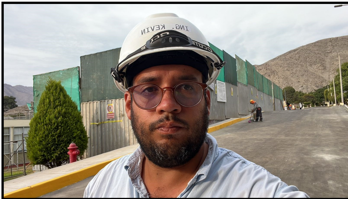
Fotografía 59 Control de calidad en carpeta asfáltica post compactación
