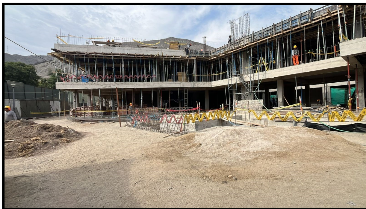
Fotografía 64 Vista panorámica de avance de obra, construido sótano 2, sótano 1 y piso 1
