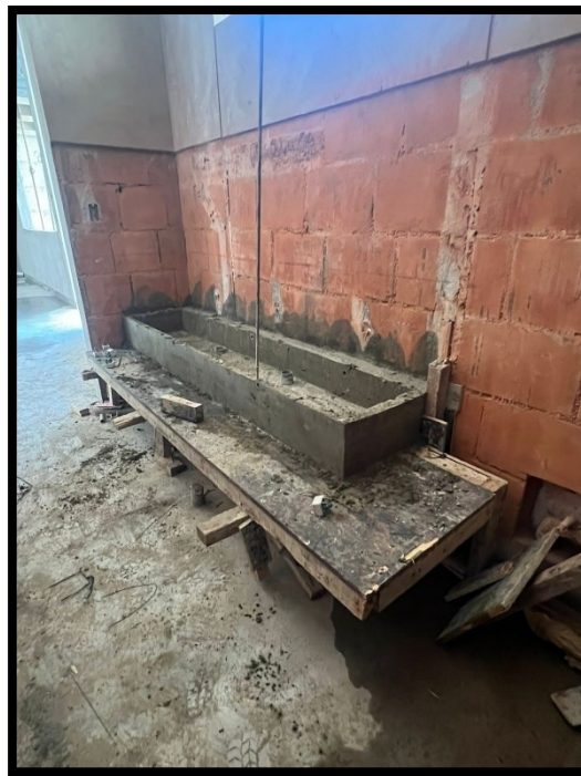
Fotografía 84 Construcción de mesada para lavamanos de baños niñas en salones del proyecto
