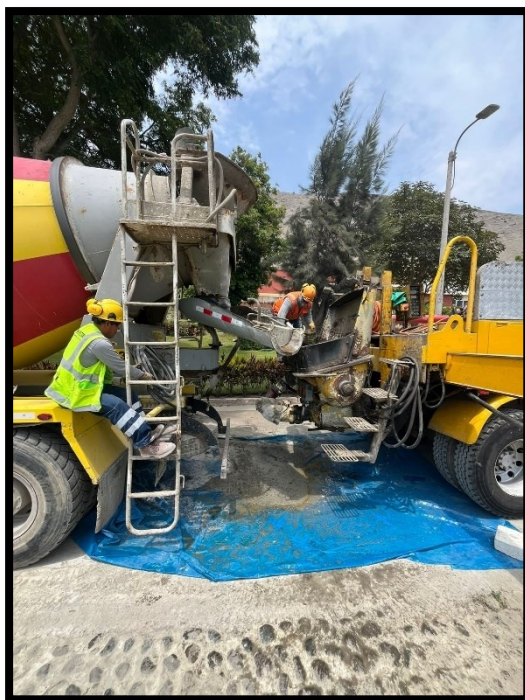
Fotografía 39 Llegada de mixer para vaciado de elementos verticales (columnas, muros de corte)
