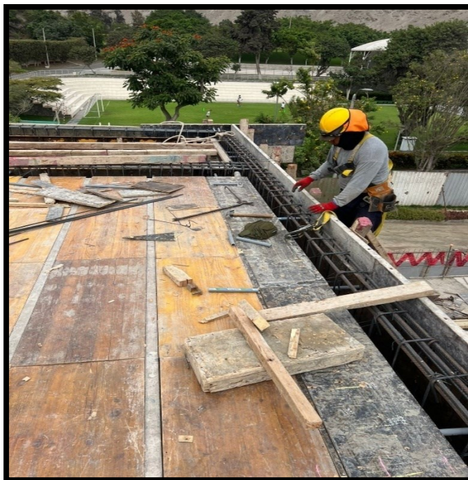
Fotografía 67 Colocación de fondos de losa y costados de viga en losa de piso 2
