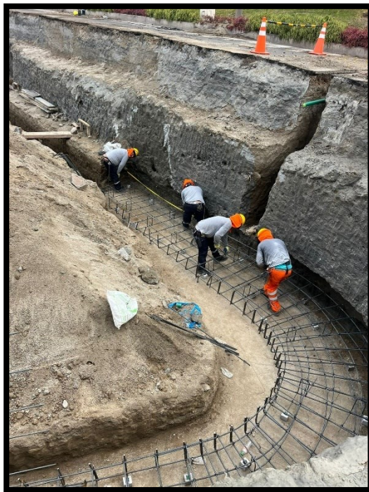
Fotografía 31 Armado de malla para muro de contención curvo
