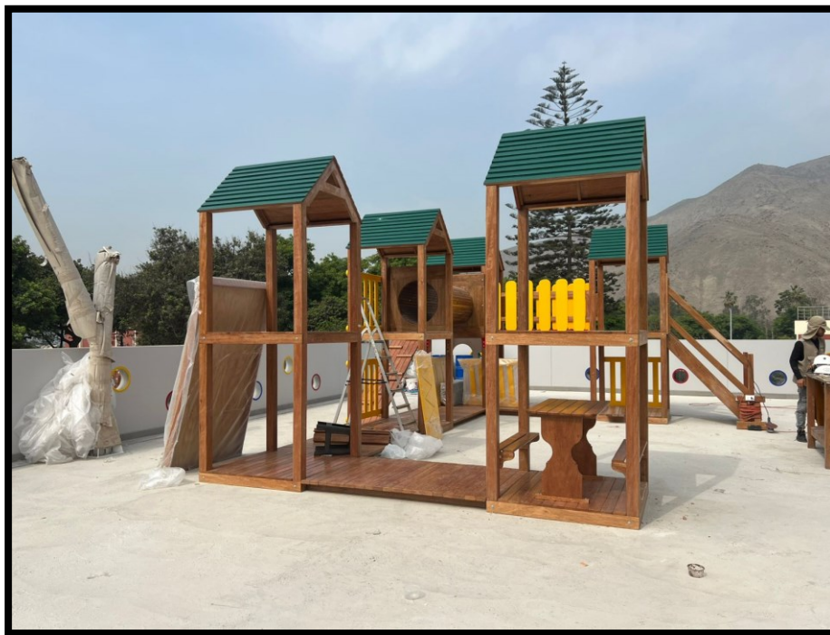
Fotografía 149 Instalación y montaje de postes metálicos para toldos tensionados y de juegos de madera para patio de kínder
