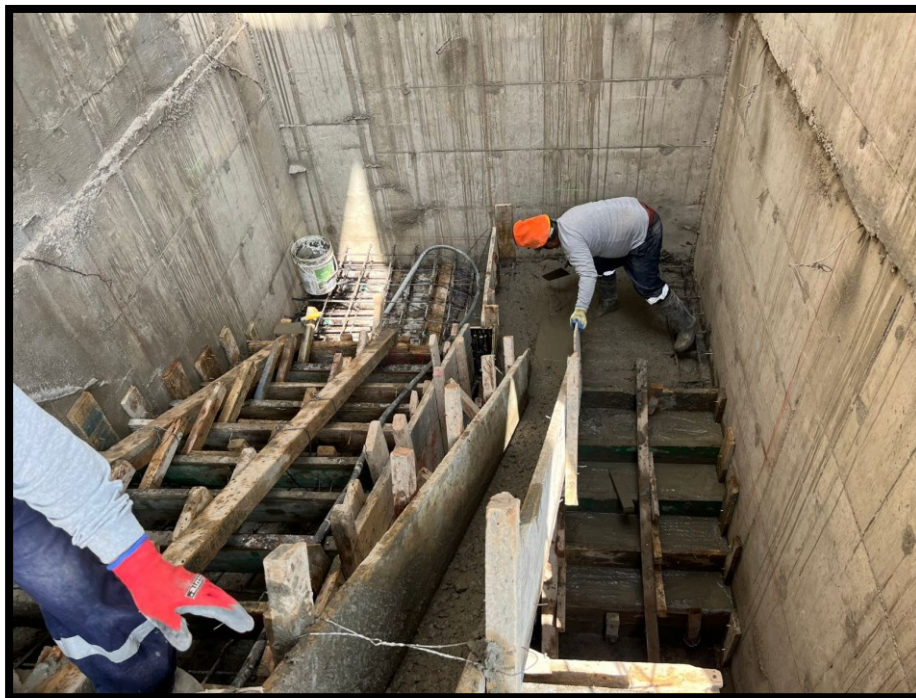
Fotografía 79 Vaciado de concreto en escaleras
