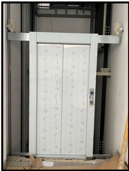
Fotografía 119 Instalación de elevador, realizado por empresa Embarba Elevadores
