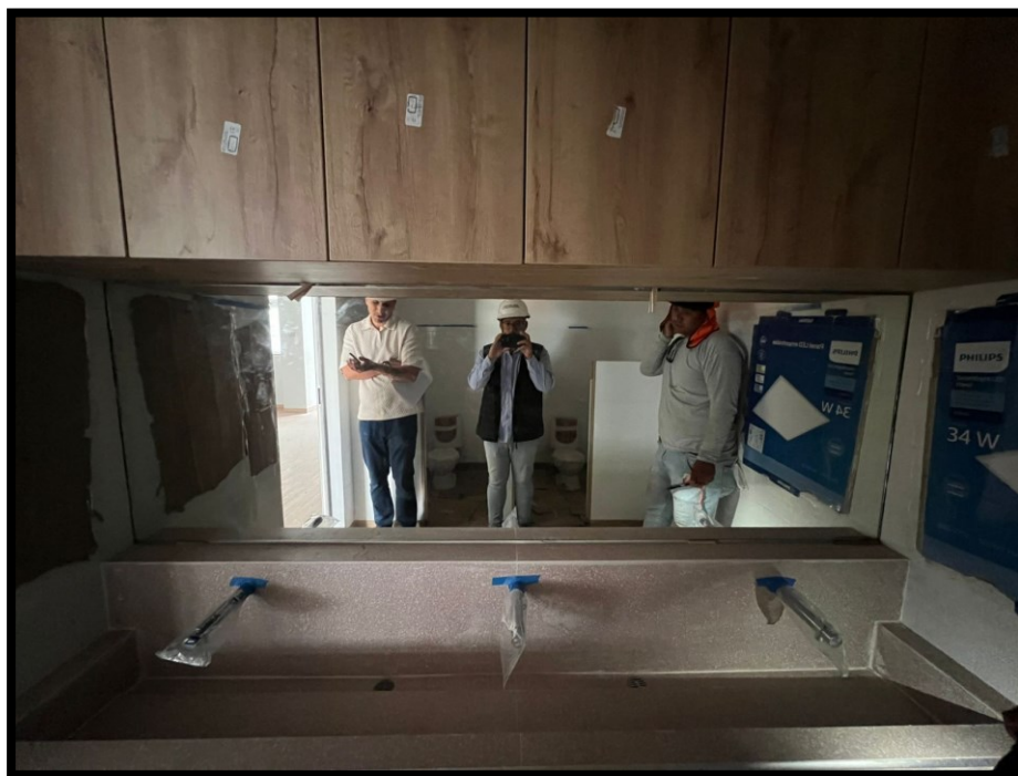
Fotografía 124 Implementación de mueble alto de melamina, espejo y grifería en baños de aulas
