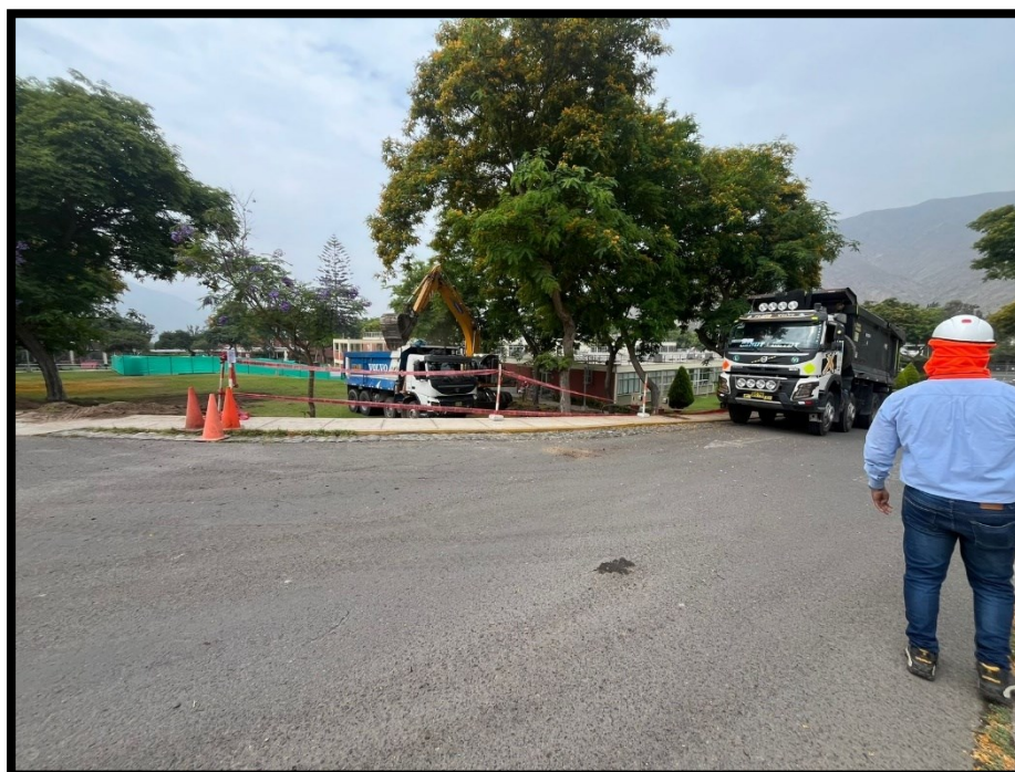
Fotografía 2 Inicio de labores de excavación masiva
