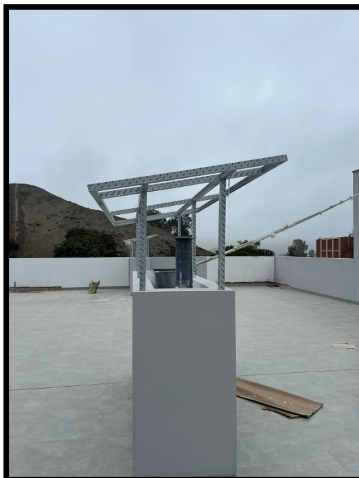
Fotografía 116 Instalación de teatina de aluminio en ductos de ventilación de piso 2 y azotea
