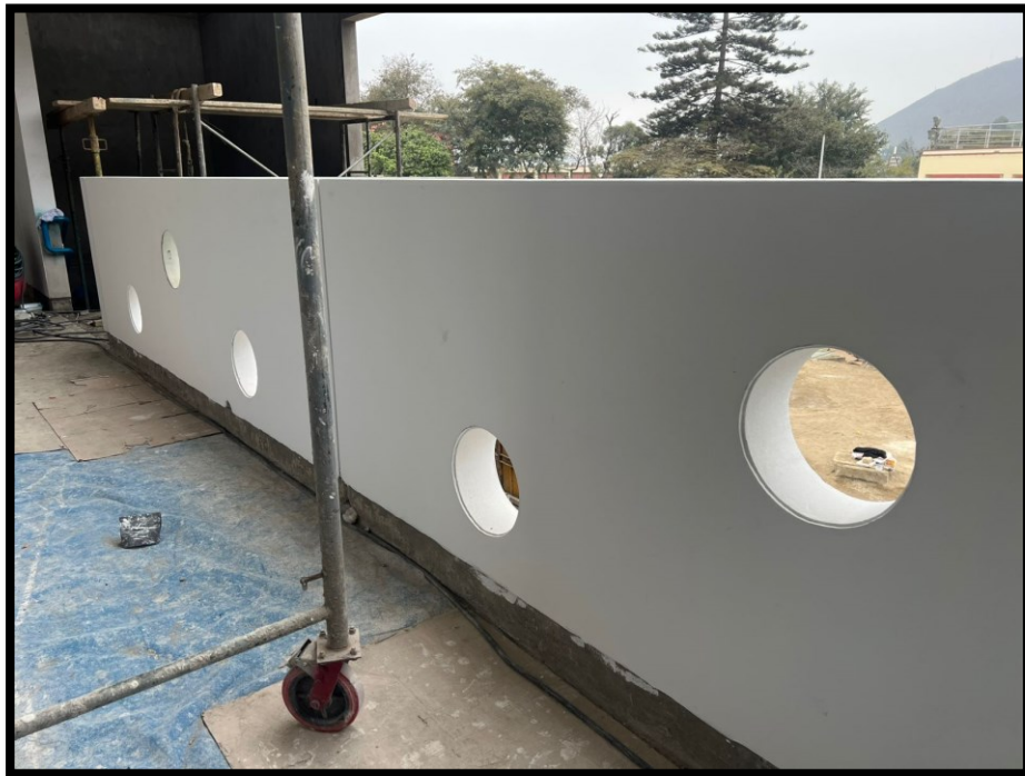
Fotografía 100 Trabajos de imprimado, empaste y blanqueado de muros, parapetos, fondos de losa
