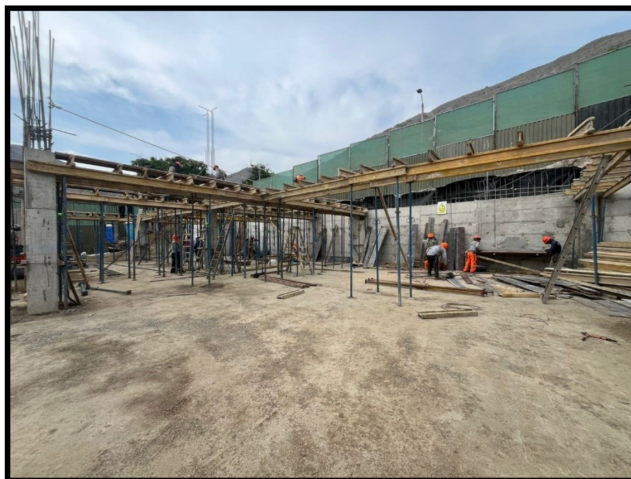
Fotografía 50 Se observa el apuntalamiento y encofrado de vigas en sótano 1
