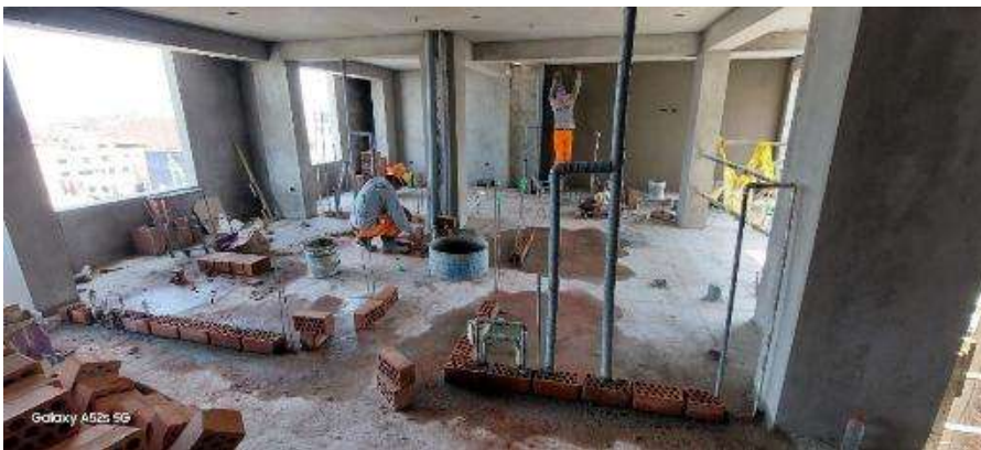
Figura 210: Emplantillado en asentado de tabiquería.
