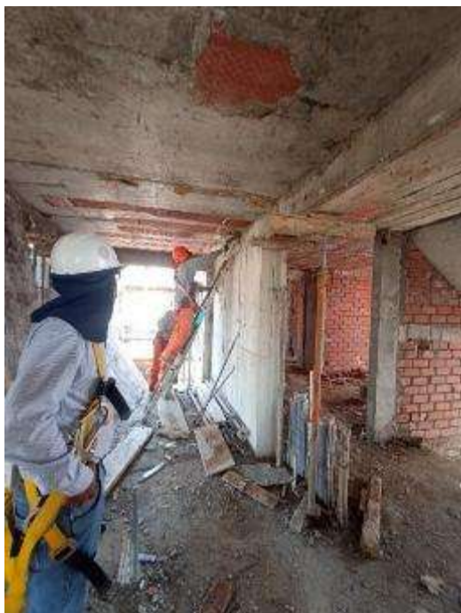
Figura 201: Desencofrado de losa aligerada.
