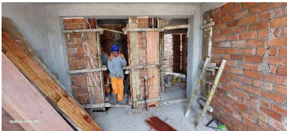
Figura 213: Encofrado de tabiquería en interior de departamentos.
