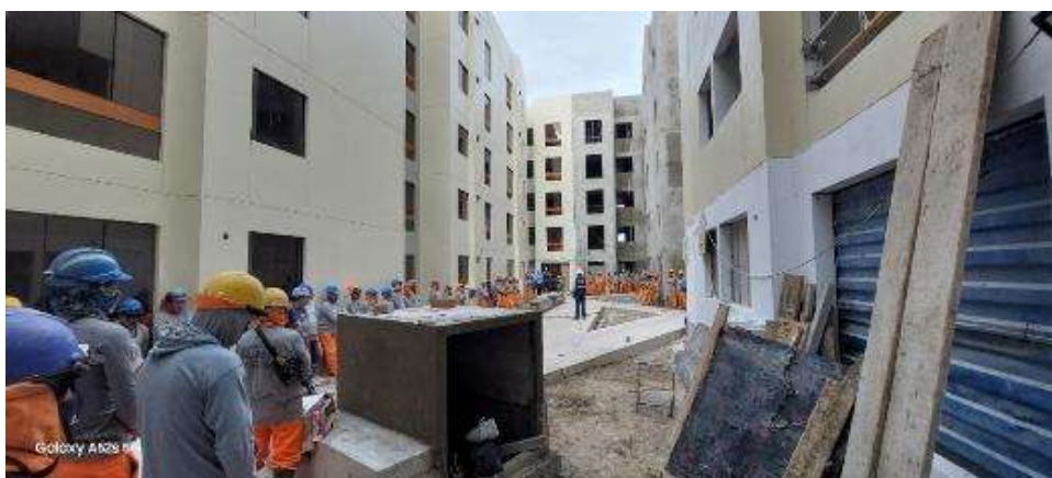
Figura 243: Charla de seguridad de 5 minutos antes de iniciar jornada laboral, en pleno acabado de plazoleta central.
