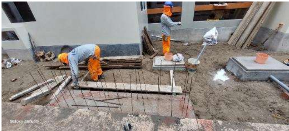
Figura 241: Realización de bancas en plazoleta central.
