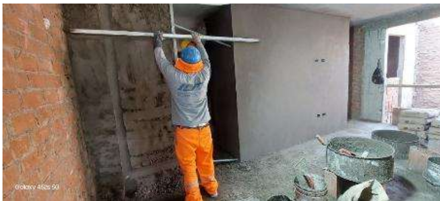
Figura 205: Tarrajeo de muros interiores.
