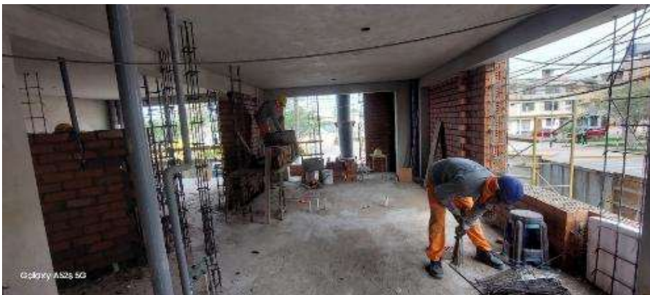
Figura 211: Asentado de tabiquería en zona aporticada.
