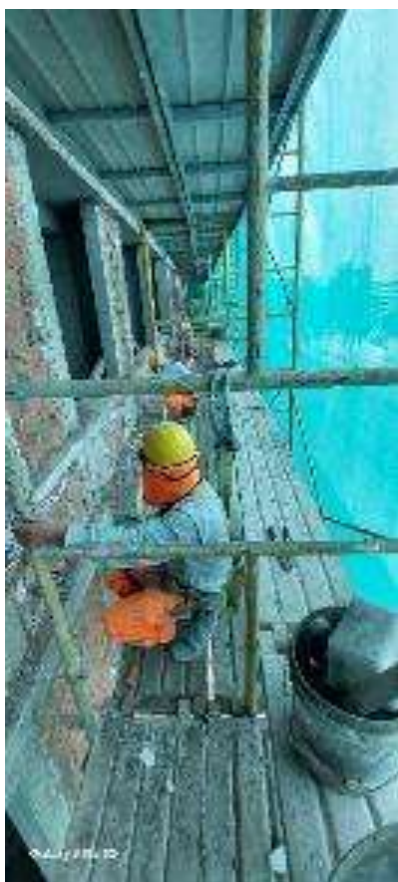
Figura 173: Proceso de tarrajeo de fachada.
