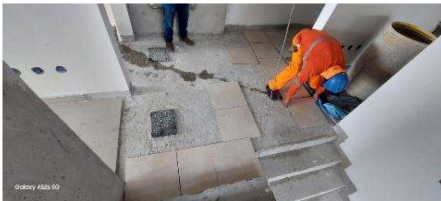
Figura 175: Proceso de enchape de escaleras.
