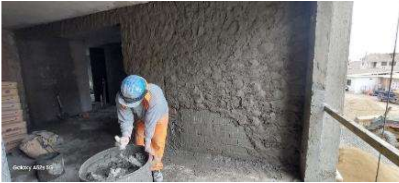
Figura 206: Proceso de tarrajeo interior.
