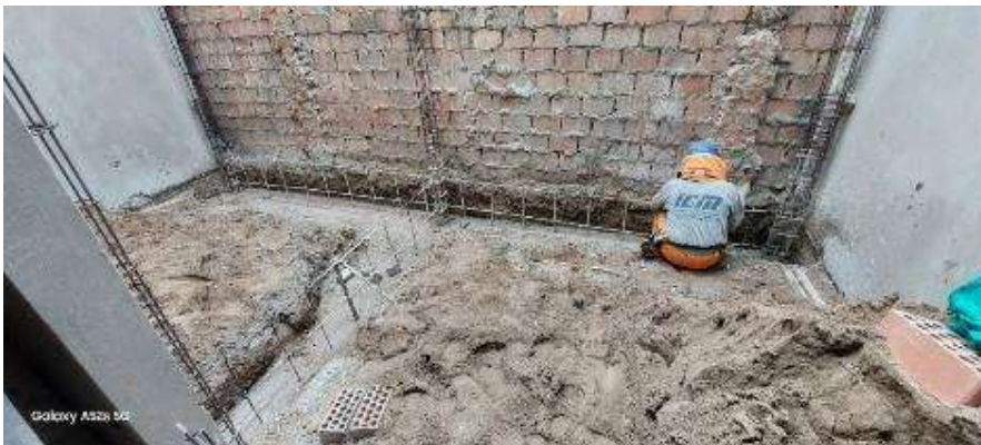
Figura 208: Acero reforzado en sobrecimientos para muros de cerco en patios de departamentos.
