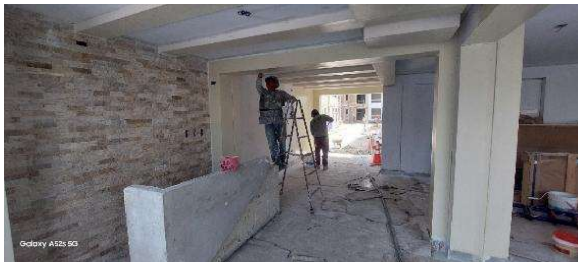
Figura 125: Trabajos de acabados en zona de recepción, etapa I.
