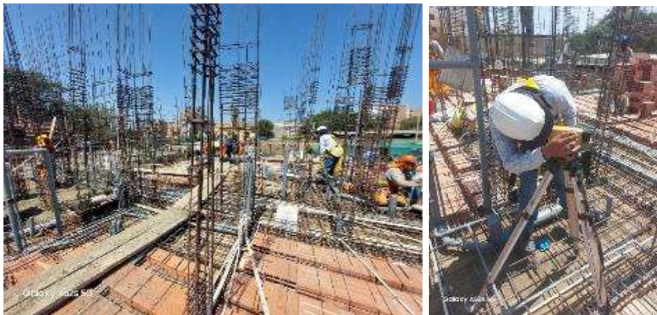
Figura 102: Verificación de niveles en vaciado de losa aligerada, etapa I.
