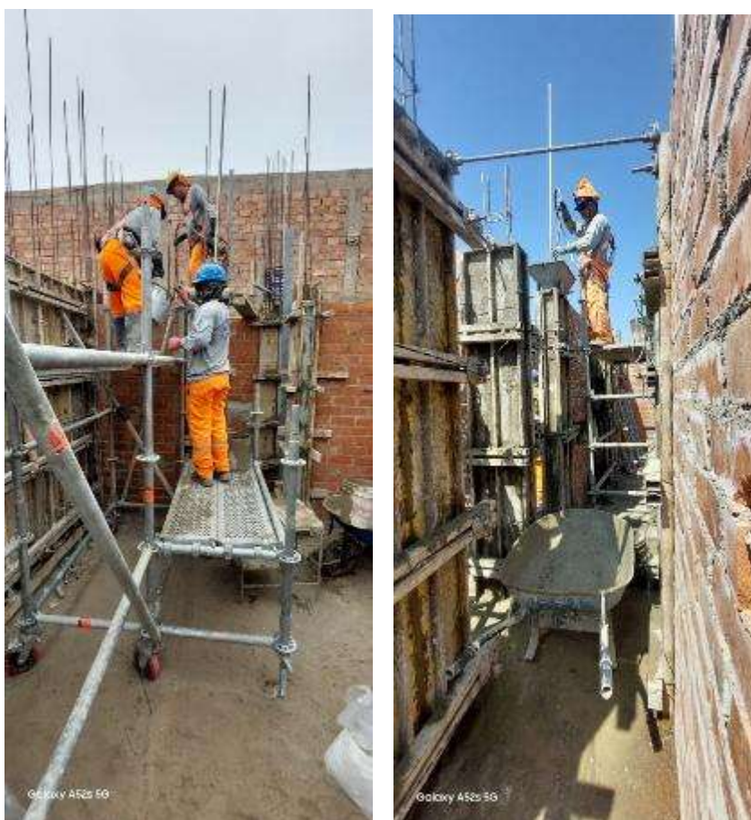
Figura 98: Vaciado de elementos verticales 1° nivel, etapa I.
