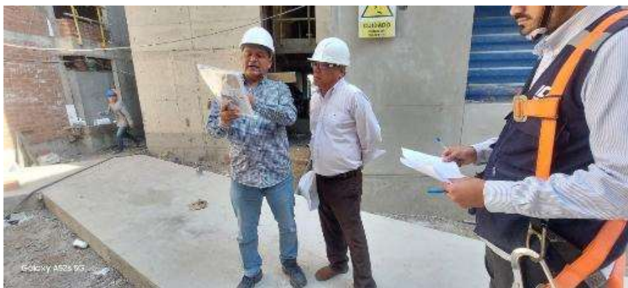
Figura 242: Verificación de detalles en plazoleta central en coordinación con el Gerente, Ingeniero Rodolfo Dávila, y el Arquitecto Wilder Chafloque.
