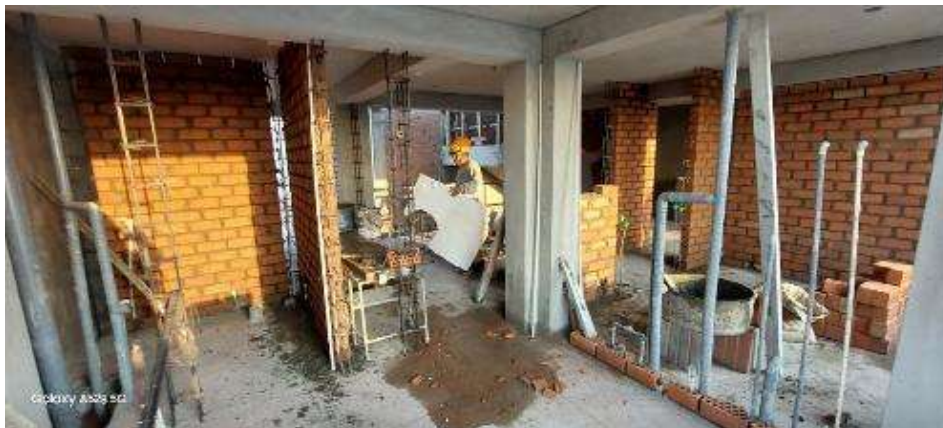
Figura 212: Proceso de asentado de ladrillo de tabiquería.
