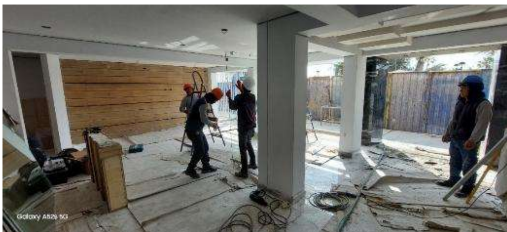
Figura 129: Continuación de trabajos de acabados en sala de usos múltiples, etapa I.
