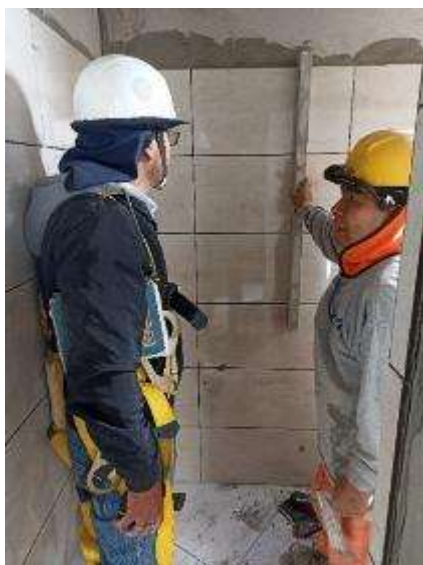
Figura 174: Verificación en enchape de baños.
