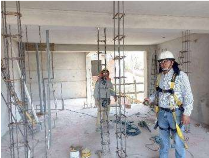
Figura 209: Habilitación de acero en columnetas para tabiquería.
