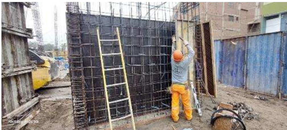
Figura 97: Encofrado de muros de corte 1° nivel, etapa I.
