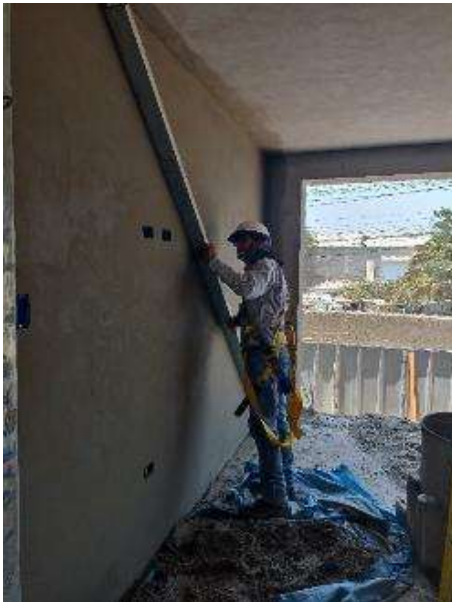
Figura 207: Verificación con regla de nivel de tarrajeo.
