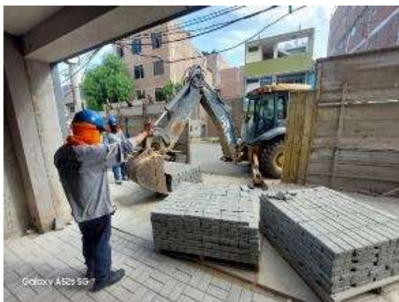
Figura 245: Descarga de adoquines para zonas de estacionamientos.
