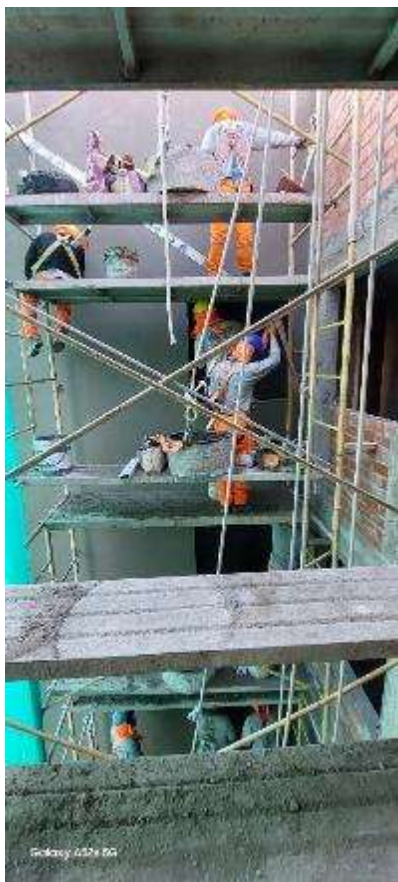
Figura 216: Tarrajeo de muros exteriores.
