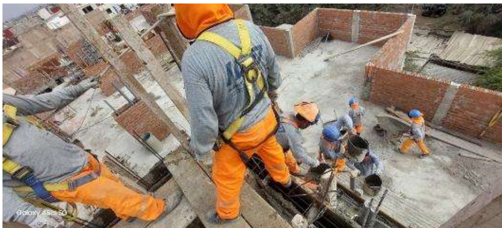
Figura 114: Vaciado de tanque elevado, etapa I.
