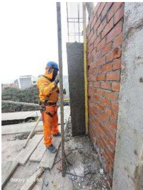
Figura 229: Desencofrado de elementos verticales.
