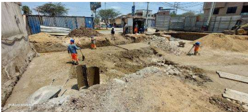
Figura 157: Vaciado de solado, sub bloque s4, bloque B-I, etapa II.
