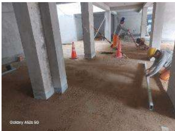
Figura 244: Colocación de afirmado en zona de estacionamientos.
