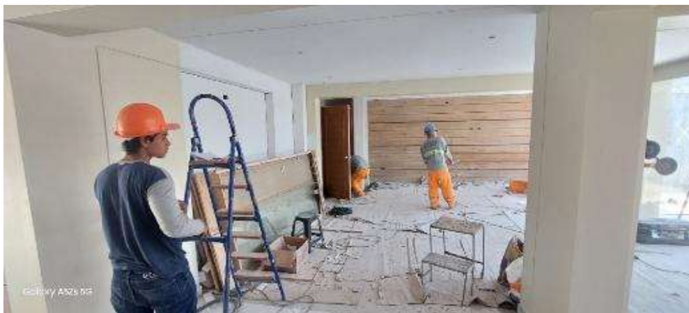
Figura 128: Trabajos de acabado en sala de usos múltiples, etapa I.
