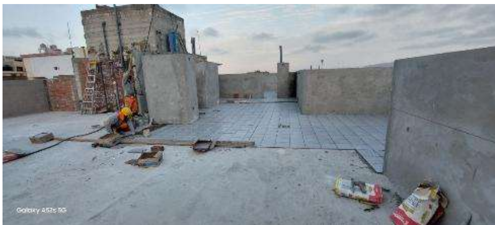
Figura 116: Enchape de azotea, etapa I.
