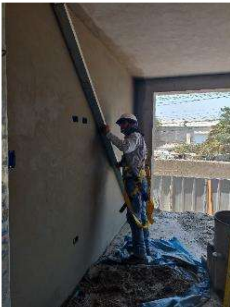
Figura 207: Verificación con regla de nivel de tarrajeo.
