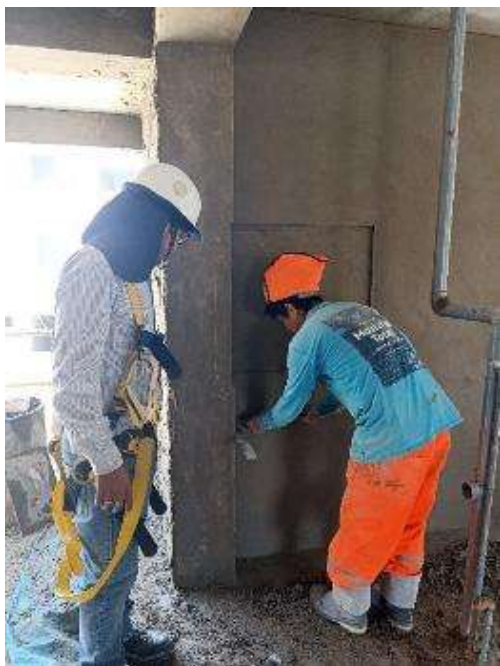
Figura 204: Verificación de escuadra en tarrajeo interior.
