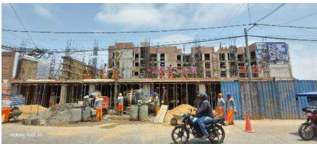
Figura 217: Proceso de vaciado de losa aligerada del 2° nivel del sub bloque s3, bloque B-II, etapa II.
