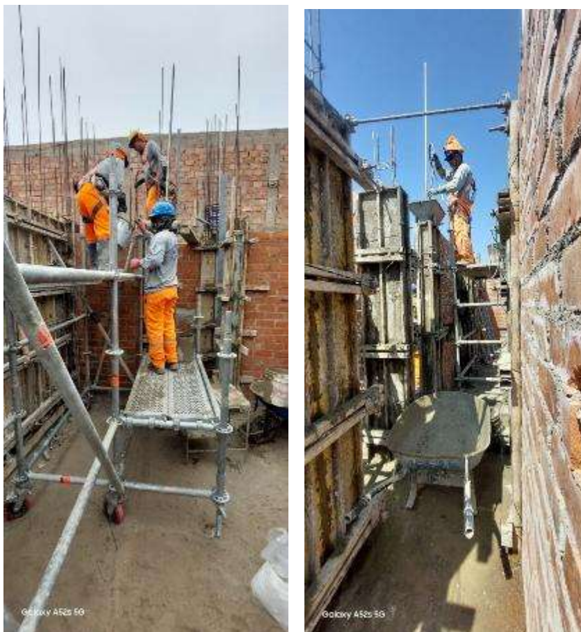
Figura 98: Vaciado de elementos verticales 1° nivel, etapa I.
