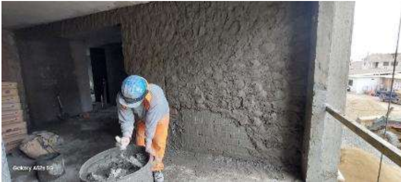
Figura 206: Proceso de tarrajeo interior.
