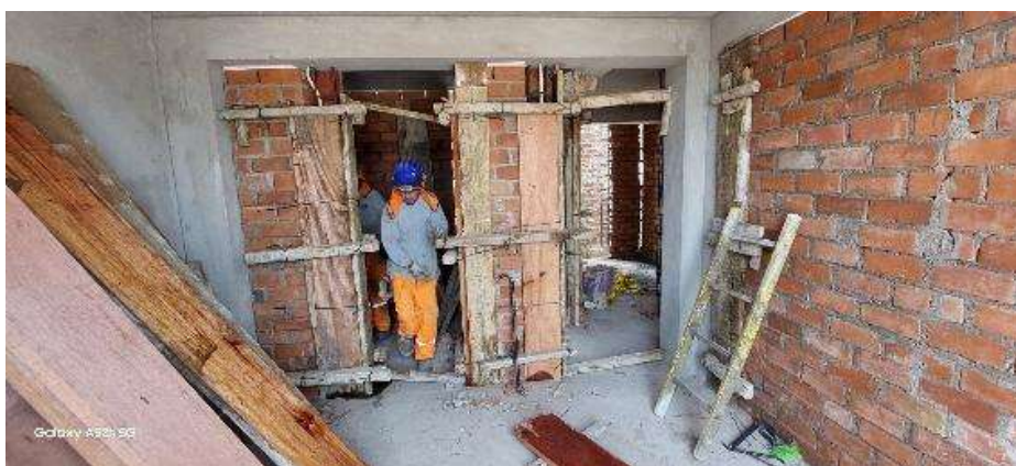
Figura 213: Encofrado de tabiquería en interior de departamentos.
