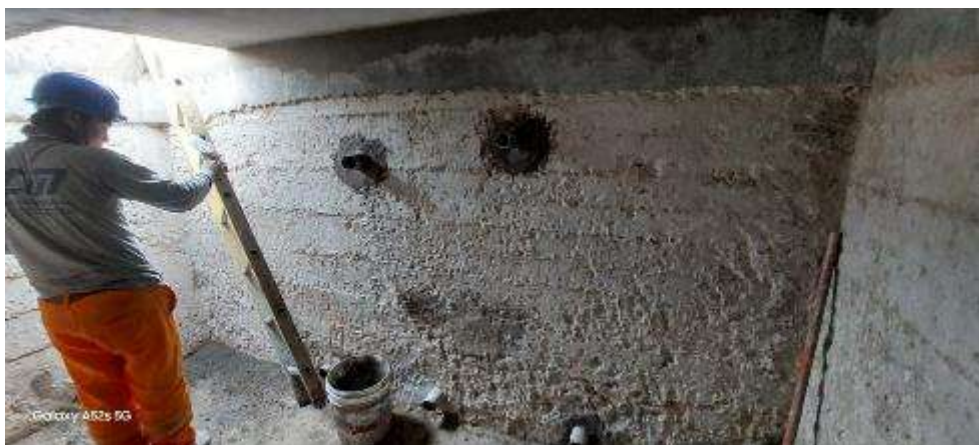
Figura 115: Tarrajeo interior de tanque elevado, etapa I.
