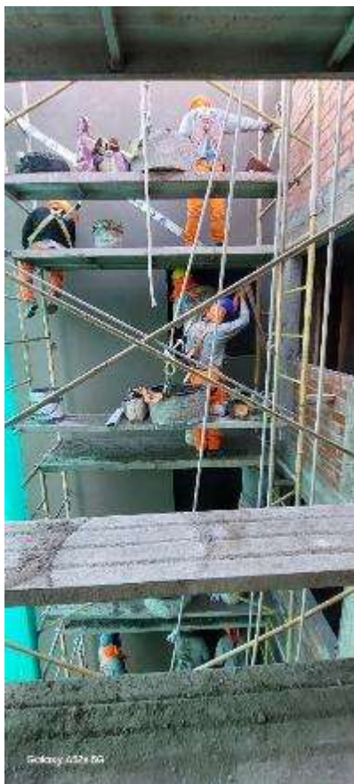
Figura 216: Tarrajeo de muros exteriores.
