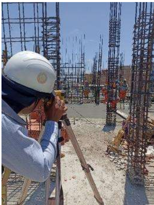
Figura 200: Dando niveles en el vaciado de losa aligerada.
