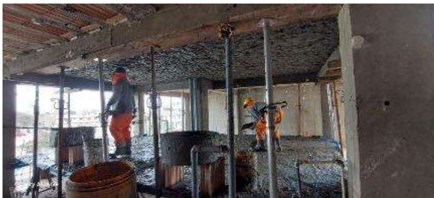
Figura 202: Tarrajeo de cielo raso.
