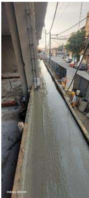
Figura 228: Vaciado de detalle de fachada.
