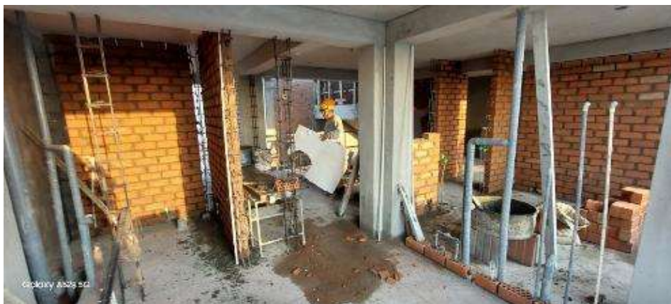
Figura 212: Proceso de asentado de ladrillo de tabiquería.
