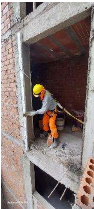
Figura 203: Tarrajeo de derrames.
