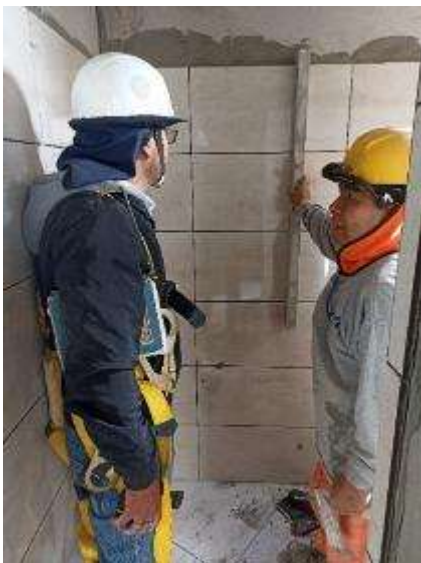
Figura 174: Verificación en enchape de baños.
