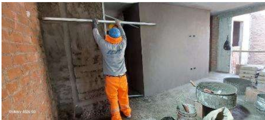
Figura 205: Tarrajeo de muros interiores.
