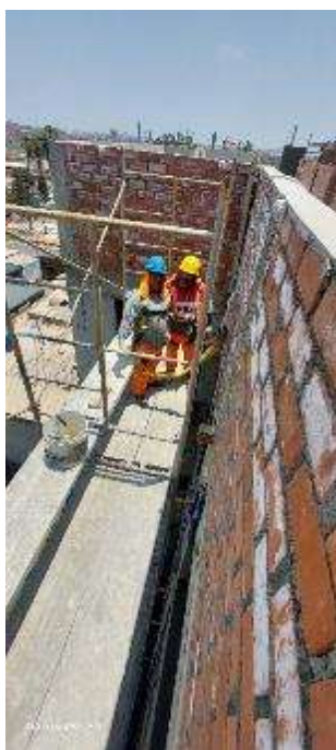
Figura 215: Armado de andamios y colocación de puntos para tarrajeo.
