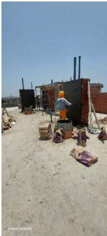
Figura 214: Tarrajeo interior en azotea.
