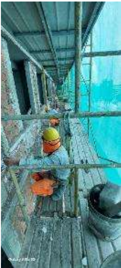
Figura 173: Proceso de tarrajeo de fachada.
