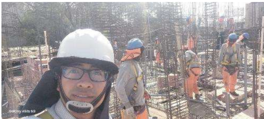
Figura 101: Habilitación de losa aligerada, etapa I.
