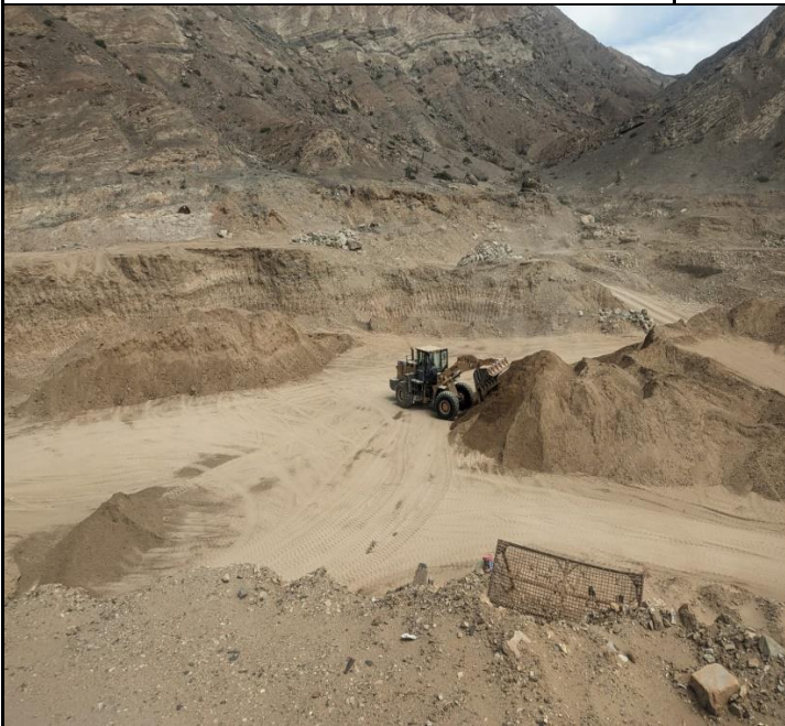
Extracción de la maquinaria en cantera – San Nicolas
