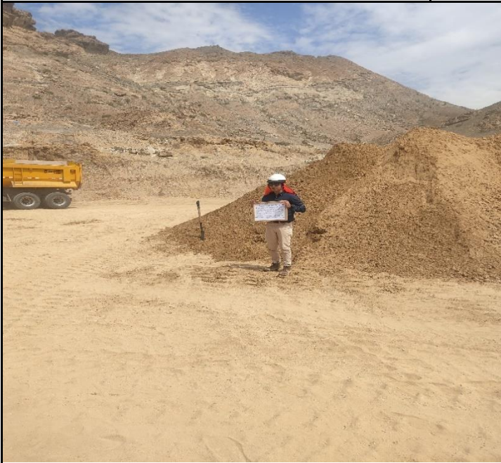
Material de afirmado cantera - Patapo La Victoria
