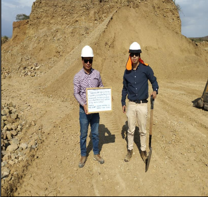
Extracción de afirmado material de cantera- Tres Tomas
