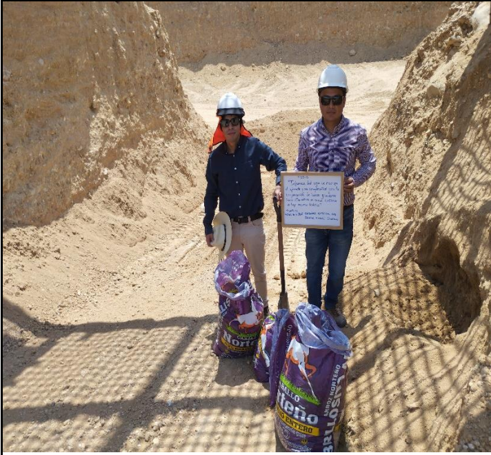
Extracción de muestra de material de – Cantera Patapo La Victoria
