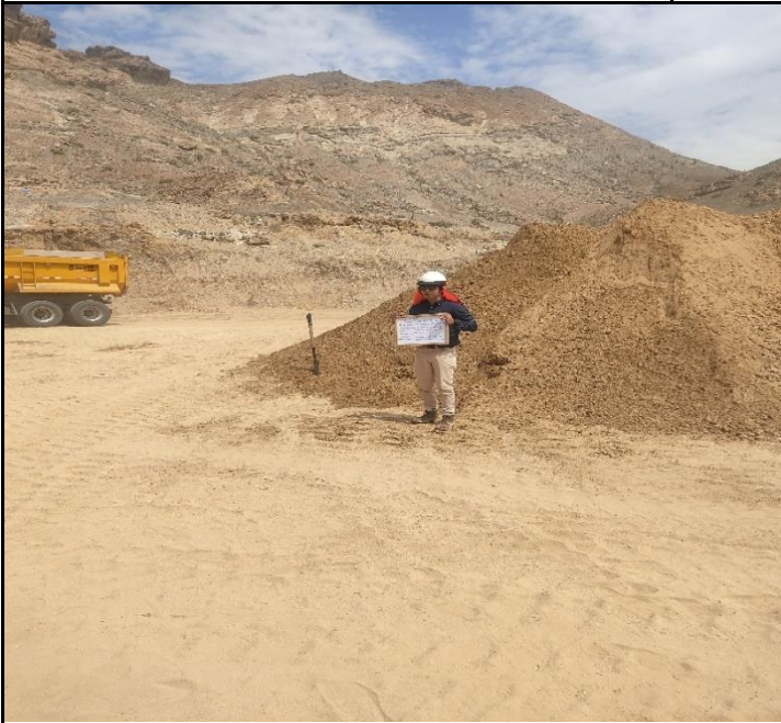
Material de afirmado cantera – Patapo La Victoria
