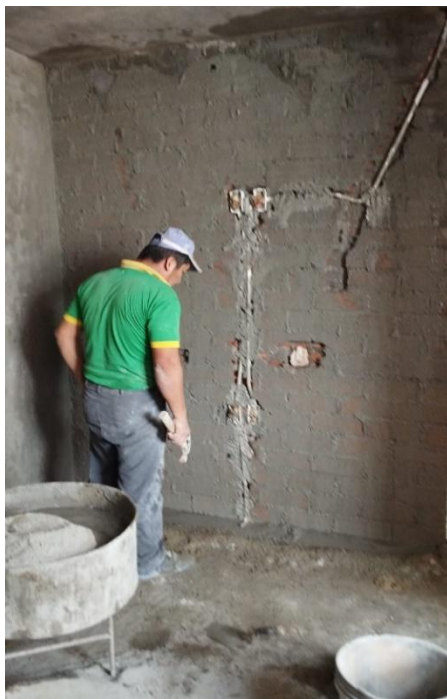
Fotografía 5: Picado de muros para IIEEE
