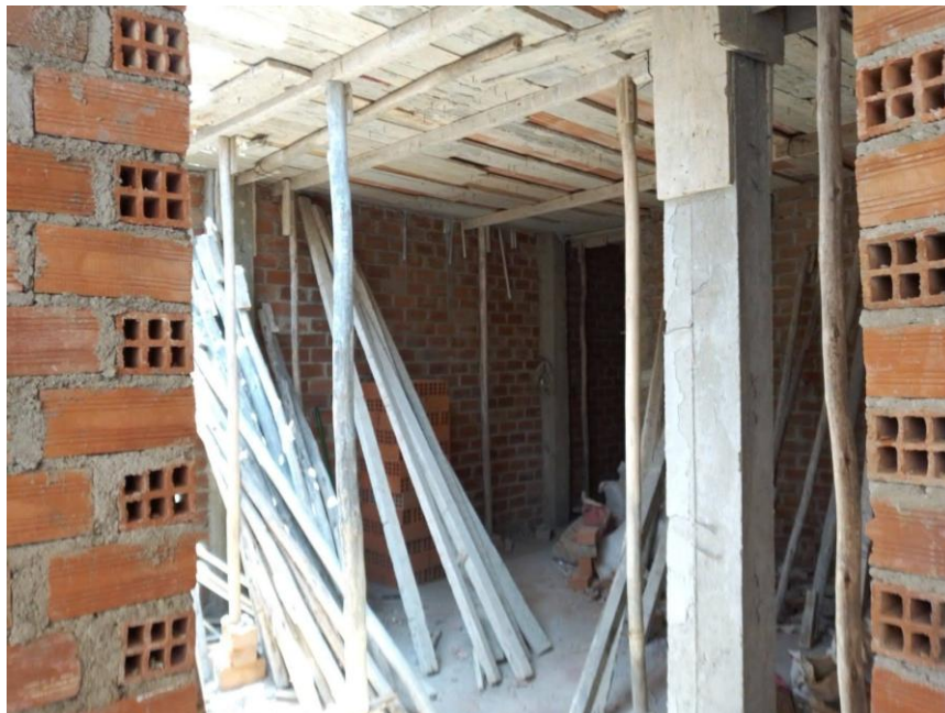
Fotografía 8: Columnas con cangrejas
