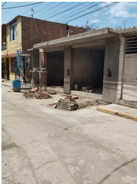
Fotografía 6: Tarrajeo realizado correctamente
