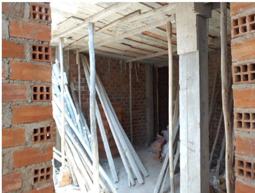
Fotografía 8: Columnas con cangrejas
