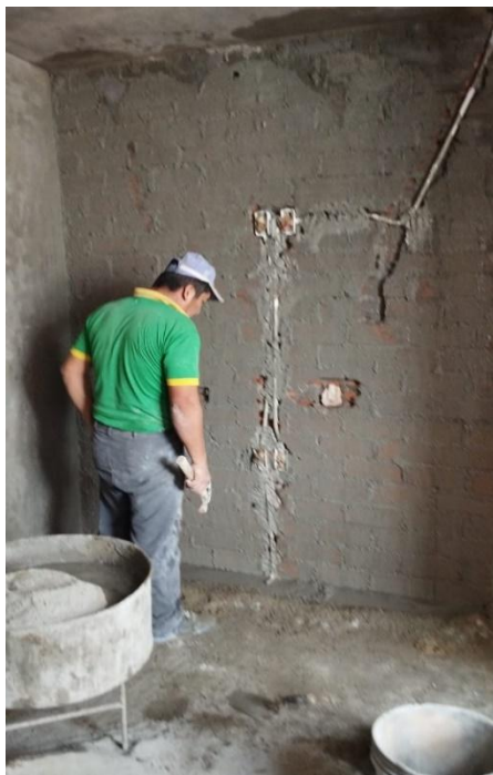
Fotografía 5: Picado de muros para IIEEE
