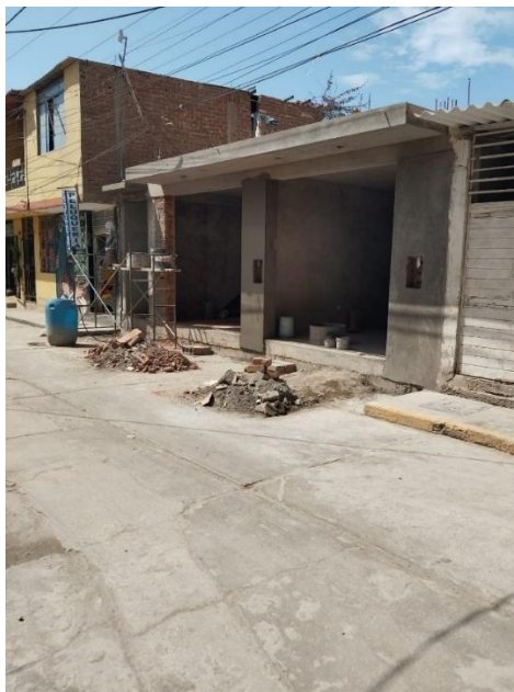
Fotografía 6: Tarrajeo realizado correctamente
