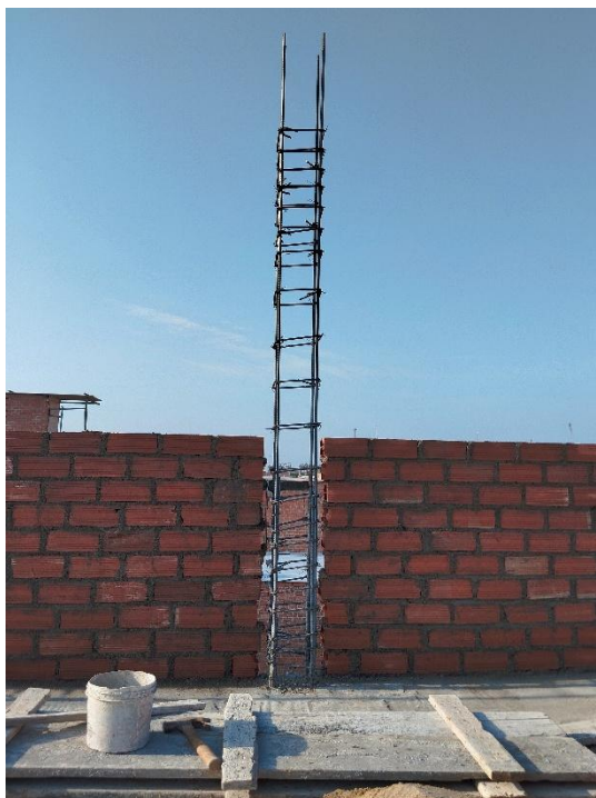
Fotografía 1: Confinamiento de columnas
