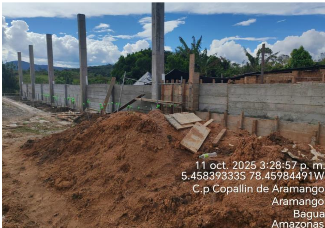
Foto 18. Verificación de colocación de capuchones en los terminales de acero corrugado
