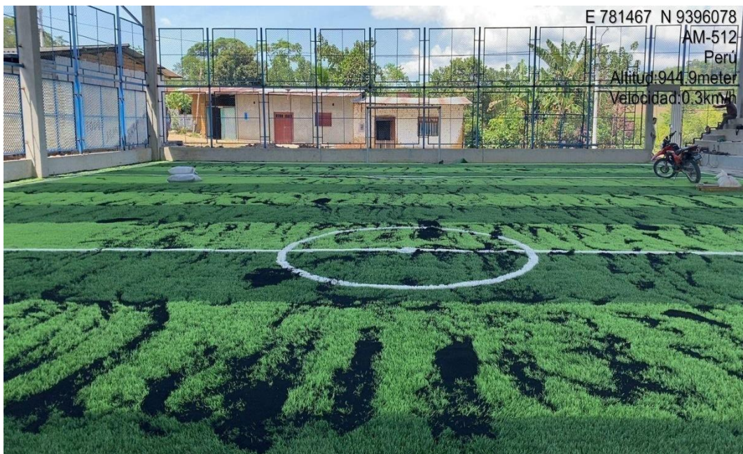
Foto 37. Verificación de la colocación de caucho, según la proporción indicada en las especificaciones técnicas
