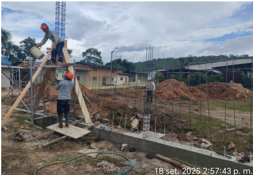
Foto 4 Verificación de vaciado de concreto f'c=210 \text{ kg/cm}^2 en columnas
