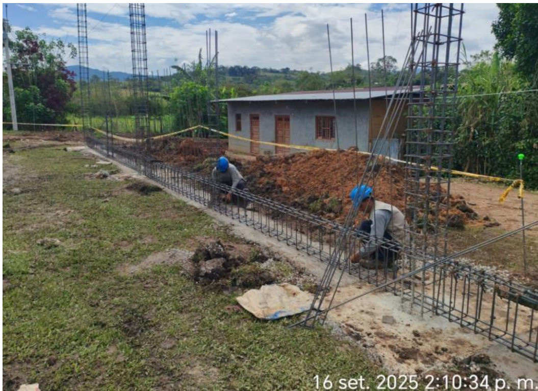
Foto 5 Verificación de habilitación de acero de vigas de cimentación
