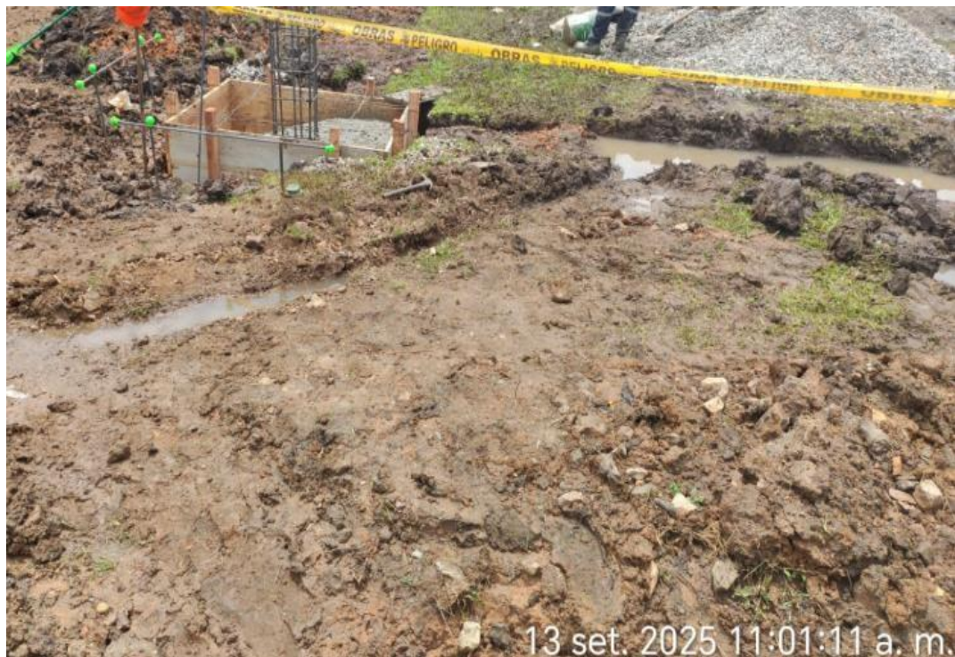
Foto 9. Verificación de vaciado de concreto f'c=210 \text{ kg/cm}^2 en zapatas
