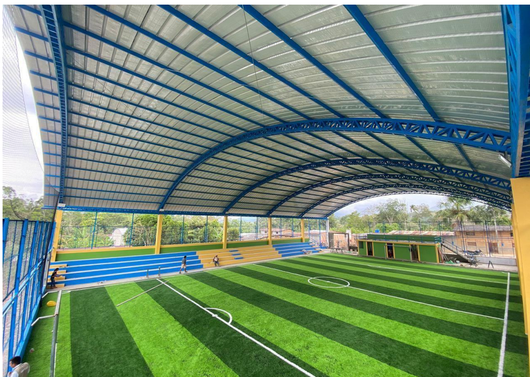
Foto 38. Vista panorámica de trabajos ejecutados en el complejo deportivo
