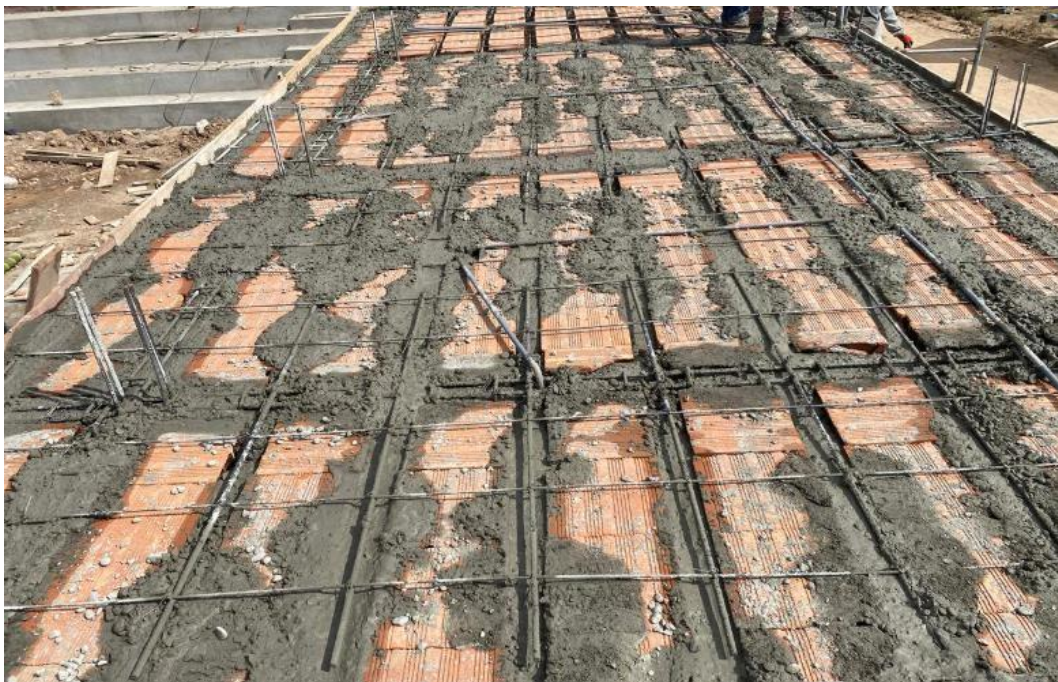
Foto 16 Control y verificación de vaciado de concreto f'c=210 \text{ kg/cm}^2 en losa aligerada de servicios higiénicos.
