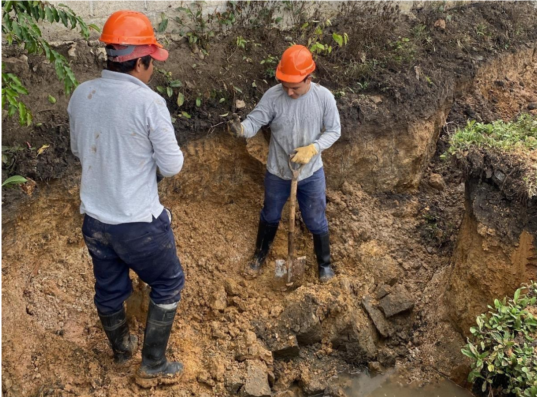
Foto 5. Excavación manual de zapatas de la cobertura metálica
