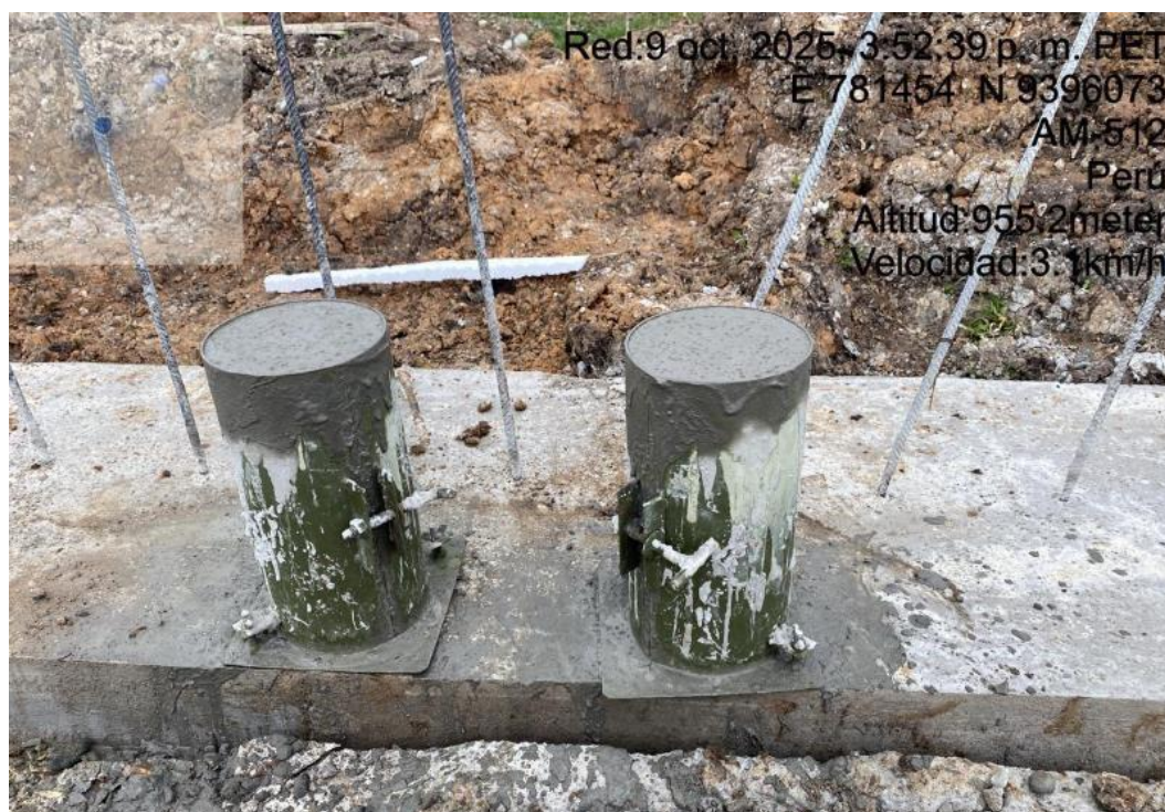
Foto 14. Extracción de testigos de concreto, para su posterior rotura a los 28 días
