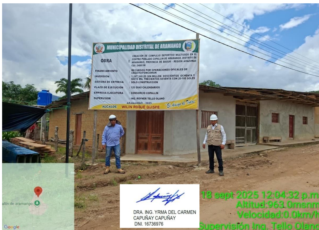
Foto 2. Instalación de carte de obra de 2.40x3.60m
