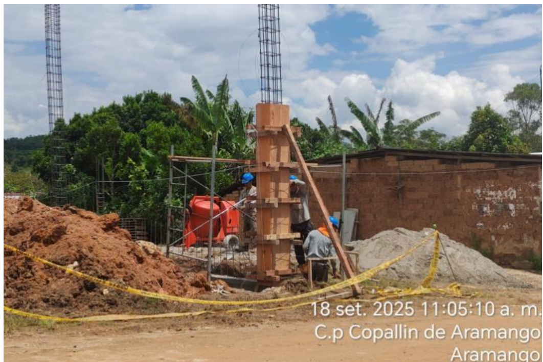
Foto 10. Control de encofrado de columnas de 30x40cm
