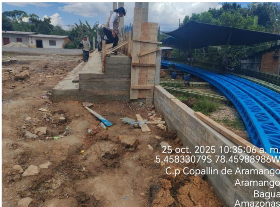
Foto 13. Verificación del acabado pulido en graderías
