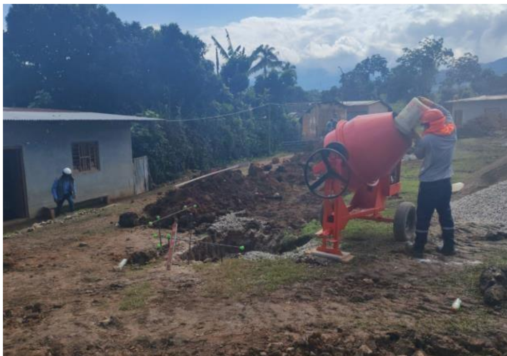
Foto 8. Verificación de vaciado de concreto en solado de zapatas
