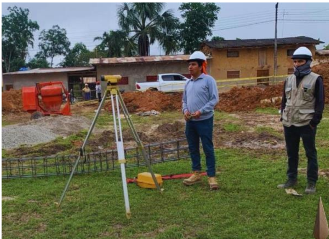
Figura 20. Control de los niveles durante la ejecución de la obra
