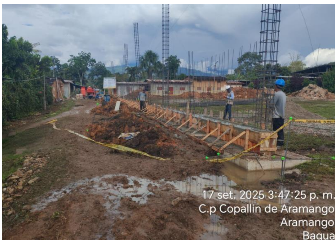
Foto 6 Vaciado de concreto f'_c=210 \text{ kg/cm}^2 en viga de cimentación de 30x50cm
