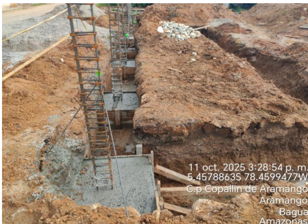
Foto 19. Verificación de vaciado de concreto f'c=210 \text{ kg/cm}^2 en zapatas de servicios higiénicos
