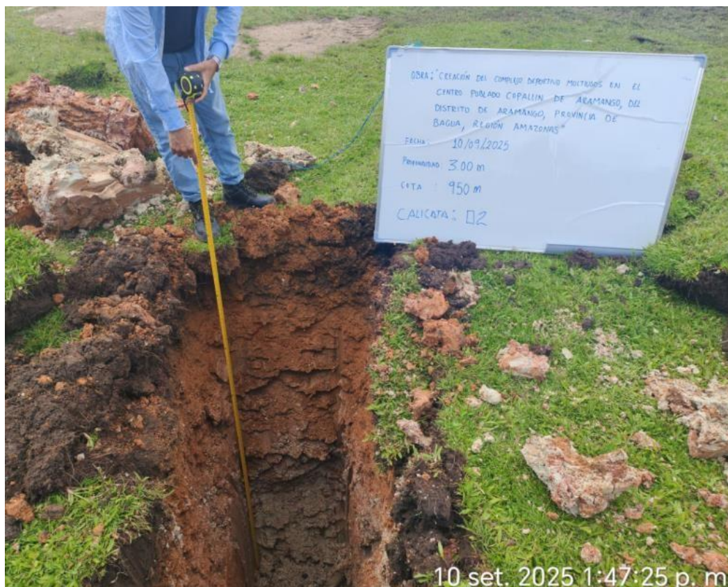
Foto 14. Exploración de calicatas para el estudio de mecánica de suelos
