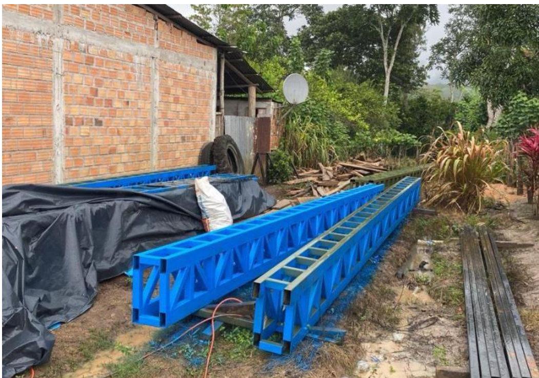
Foto 10 Verificación de la fabricación de armadura tipo II – Viga de la cobertura metálica.
