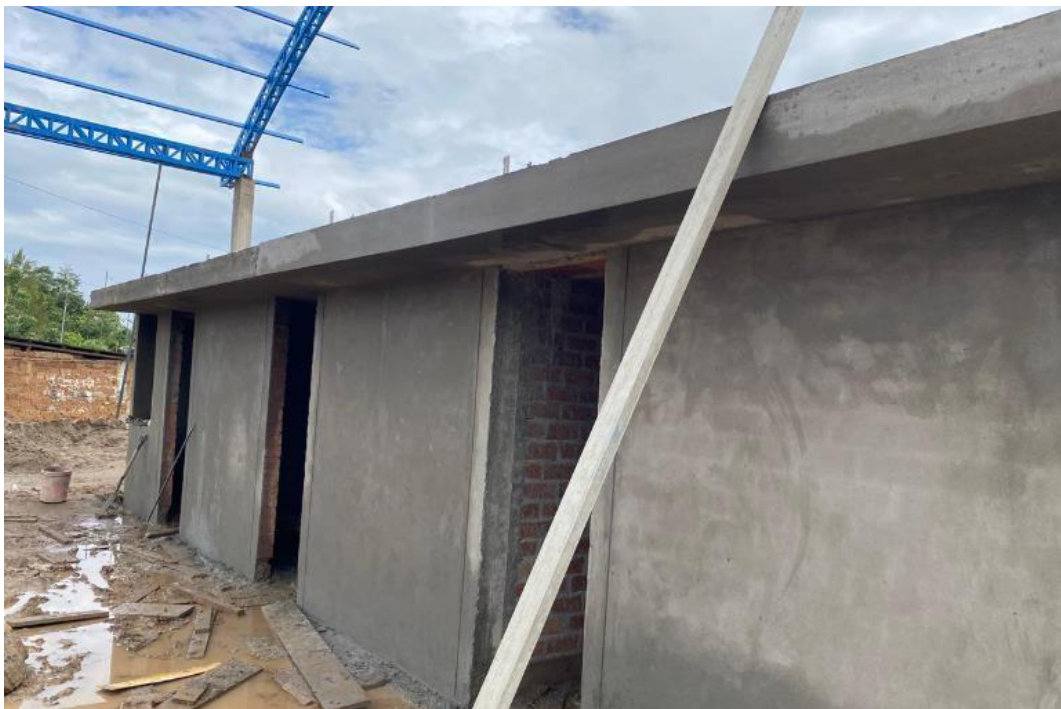
Foto 27. Control y verificación de tarrajeo exterior de servicios higiénicos
