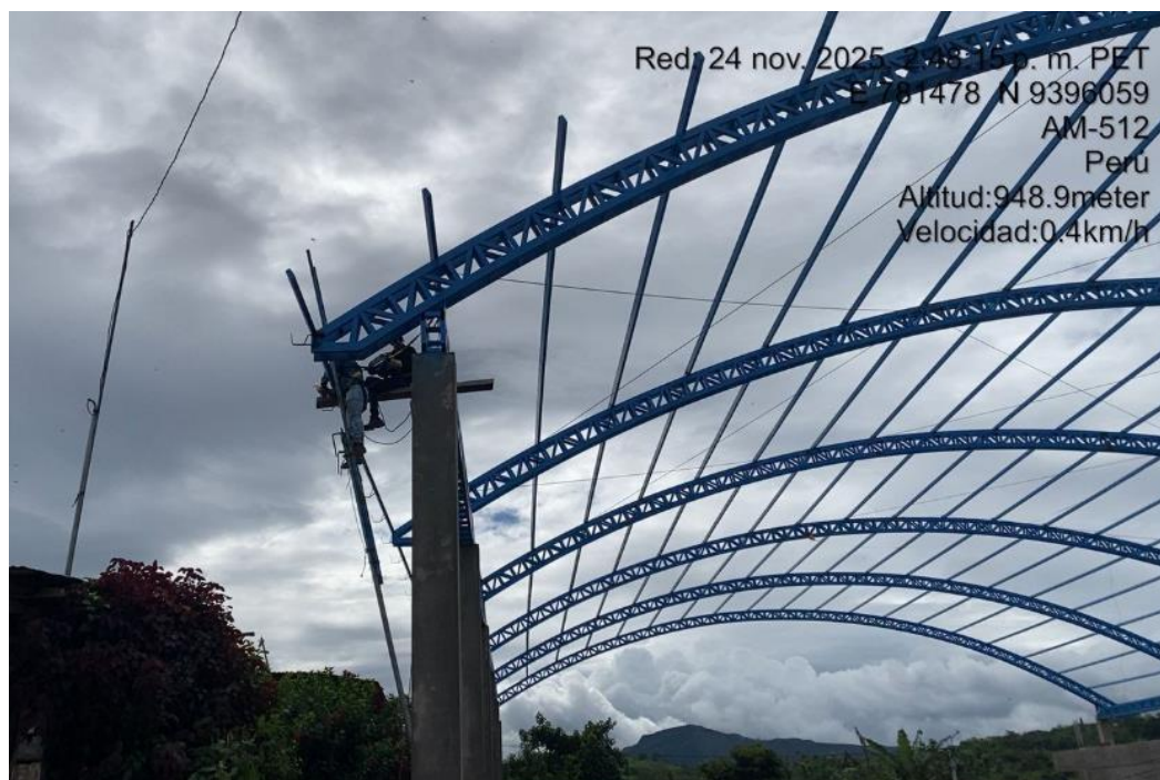
Foto 15 Verificación de la instalación de canaleta trapezoidal para la evacuación de aguas pluviales
