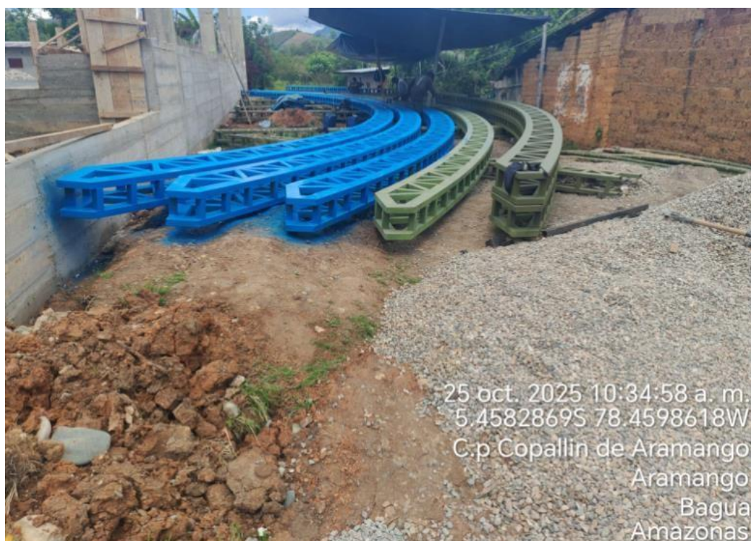
Foto 9 Verificación de fabricación de armadura Tipo I – Arcos de la cobertura metálica
