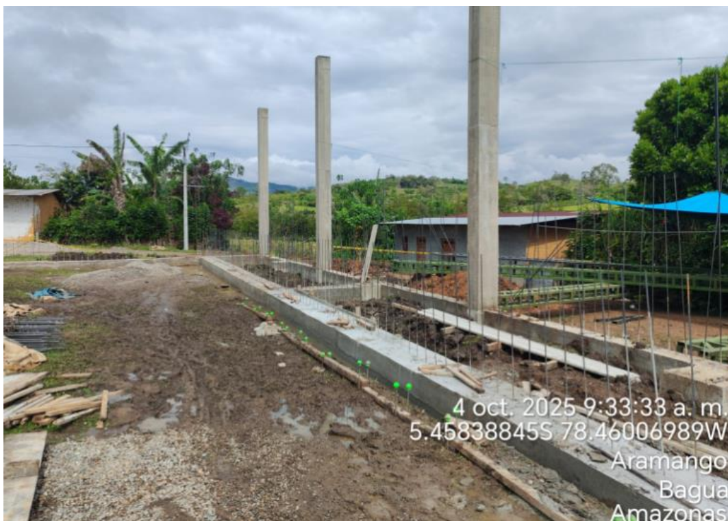
Foto 8 Verificación del vaciado de concreto de cimiento corrido en graderías.
