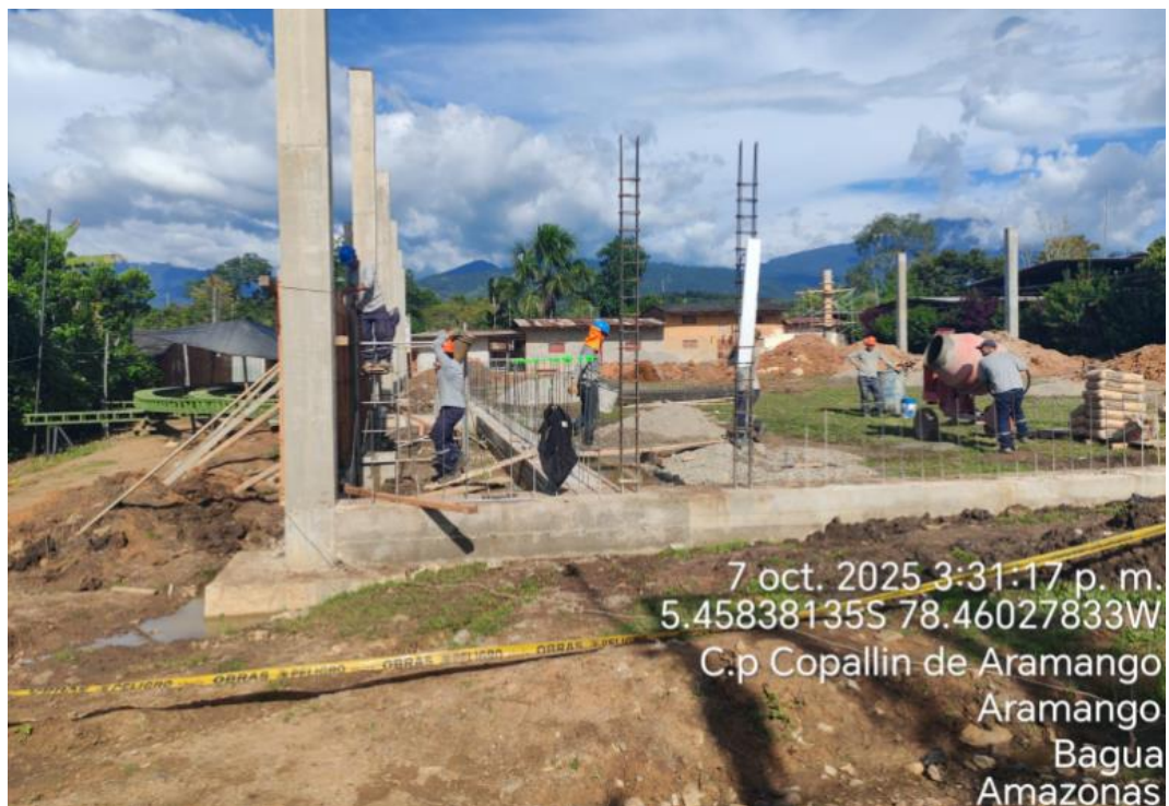
Foto 17. Verificación de vaciado de concreto f'c=175 \text{ kg/cm}^2 en muro de graderías
