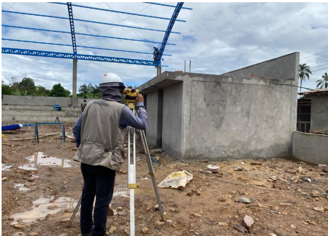
Foto 18 Control topográfico de los niveles establecidos en los planos del expediente técnico aprobado
