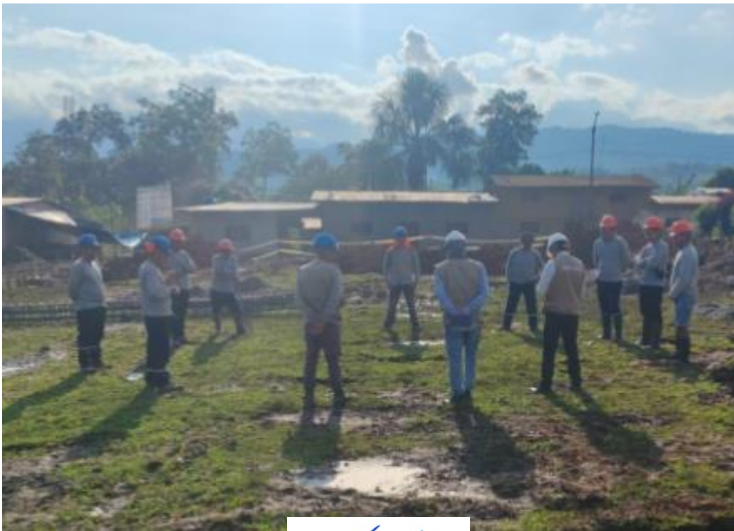
Foto 6. Charlas diarias de seguridad, previo al inicio de los trabajos programados
