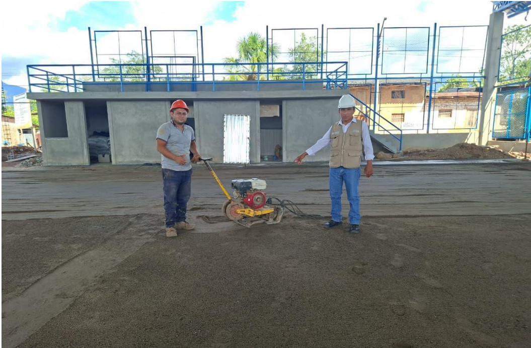
Foto 36. Control y verificación de instalación de Grass sintético, según lo especificado en los planos del expediente técnico aprobado
