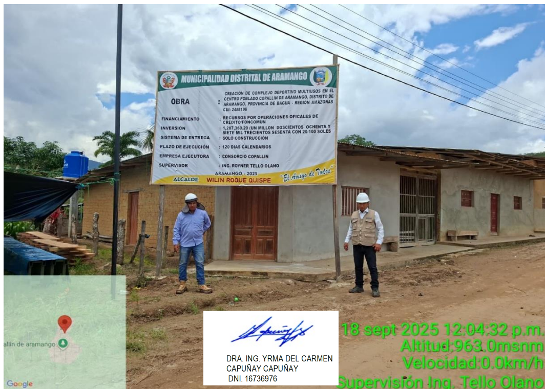
Foto 2. Instalación de carte de obra de 2.40x3.60m
