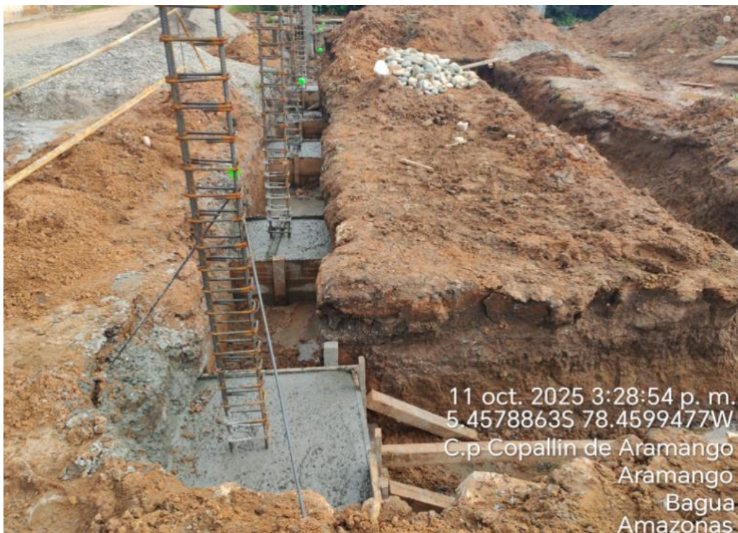
Foto 19. Verificación de vaciado de concreto f'c=210 \text{ kg/cm}^2 en zapatas de servicios higiénicos
