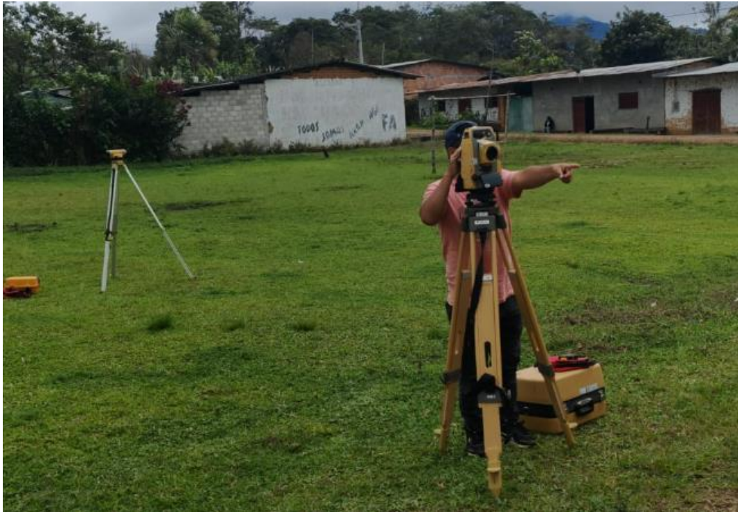
Foto 4. Control topográfico durante la ejecución de la obra.
