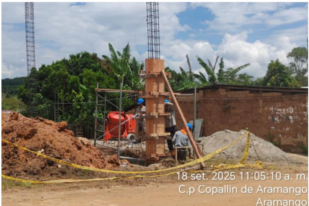
Foto 10. Control de encofrado de columnas de 30x40cm
