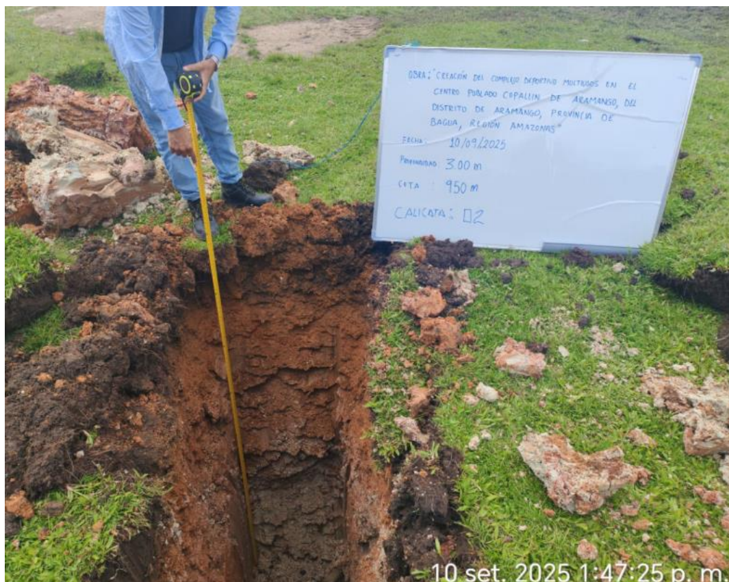
Foto 14. Exploración de calicatas para el estudio de mecánica de suelos
