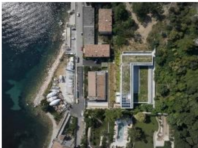
Figura 2: Vista Satelital de proyecto
