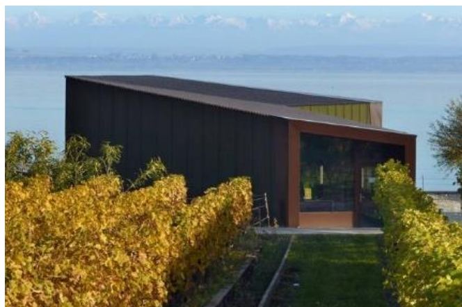
Figura 3: Vista exterior de proyecto
