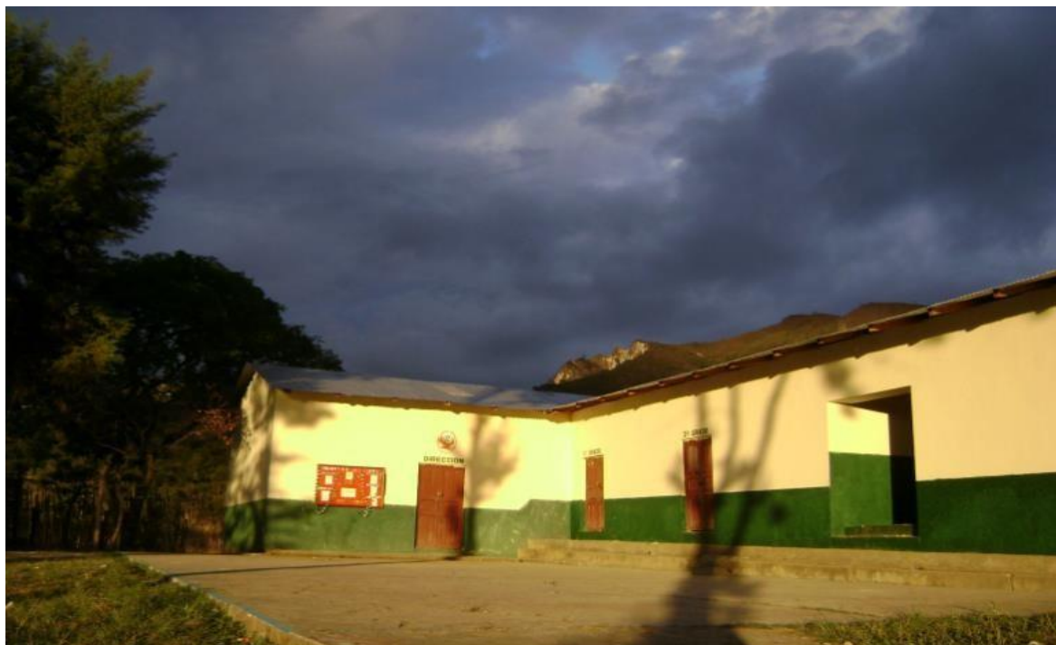
VISTA INTERIOR DE LA I.E. SAN FERNANDO DE CUJILLO
