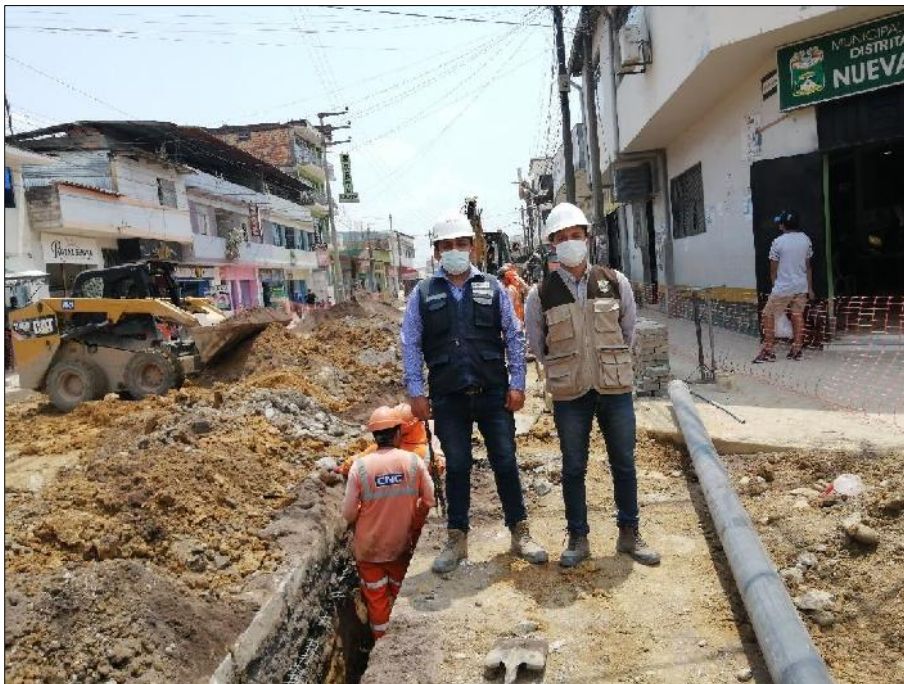
Foto 24 Verificación de trabajos de instalación de tuberías DN=110mm – 160 mm del sistema de agua potable en zona urbana de la ciudad
