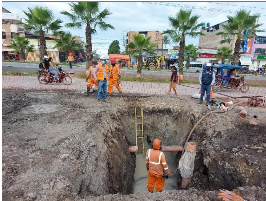
Foto 26 Inspección de actividades en frentes de trabajo ubicados al costado de la Carretera FBT, líneas de alcantarillado
