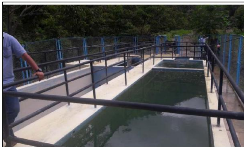
Figura 24. Estructura del Desarenador existente
