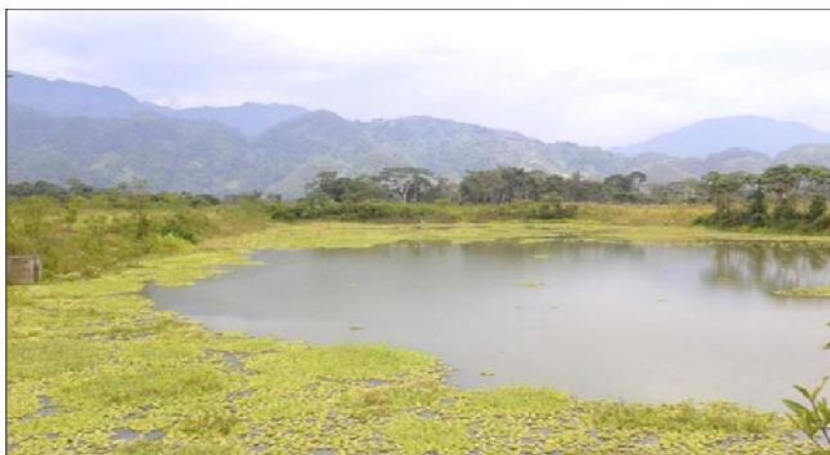
Figura 29. Laguna anaerobia en estado de abandono y colapso
