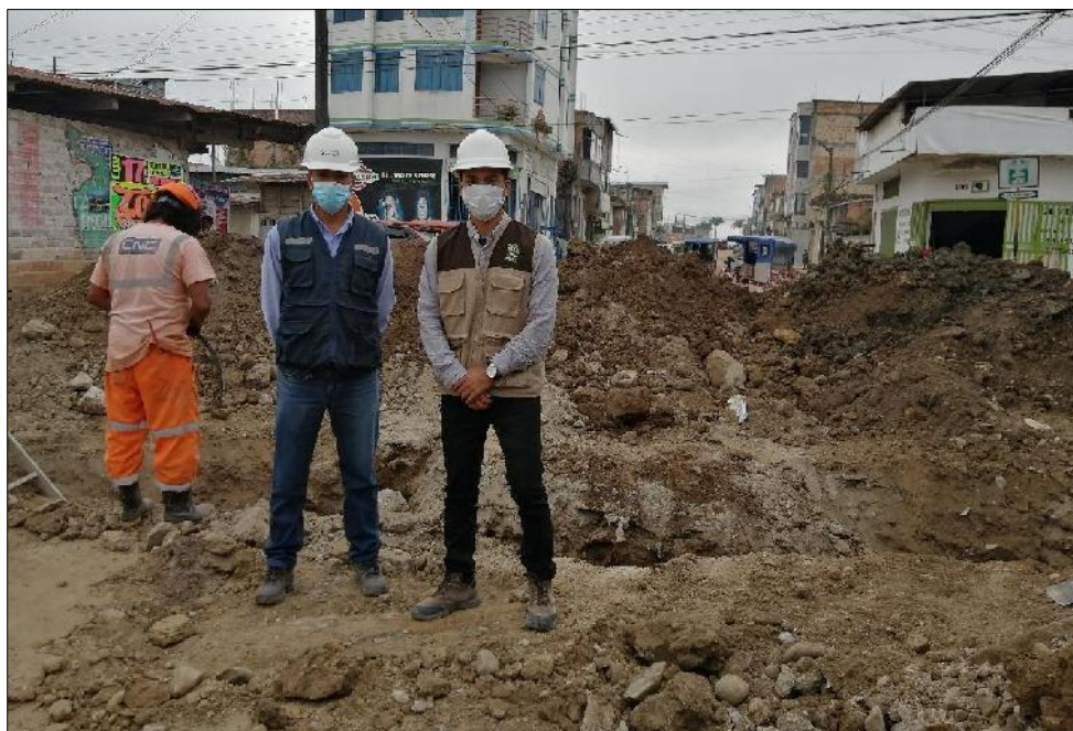
Foto 10 Monitoreo de actividades de instalación de conexiones domiciliarias del sistema de alcantarillado
