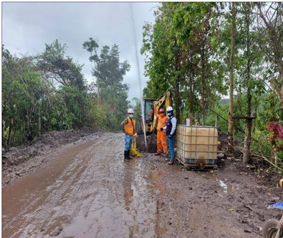
Foto 2 Presencia en ejecución de prueba hidráulica en la red de agua potable
