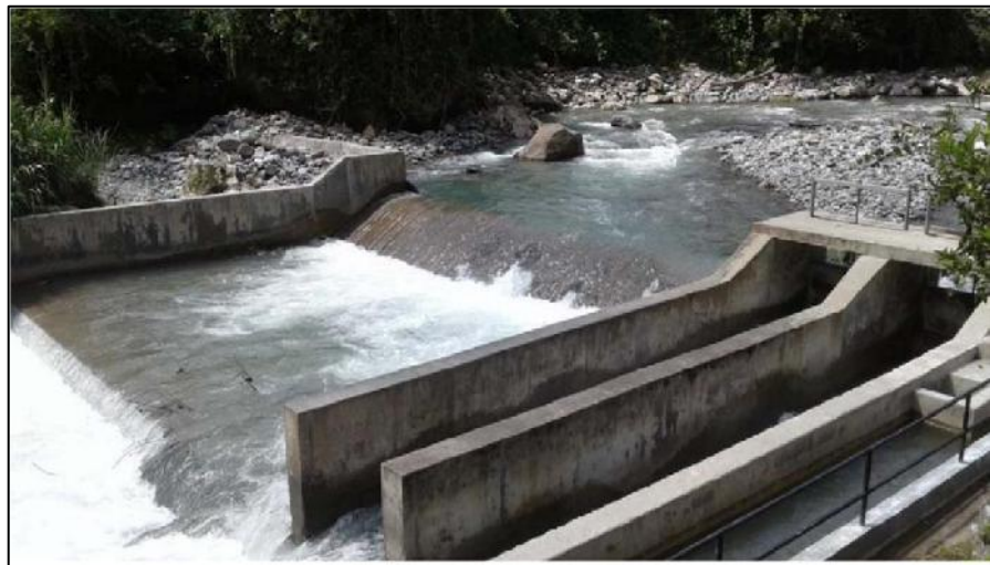
Figura 23. Estructura de Bocatoma existente
