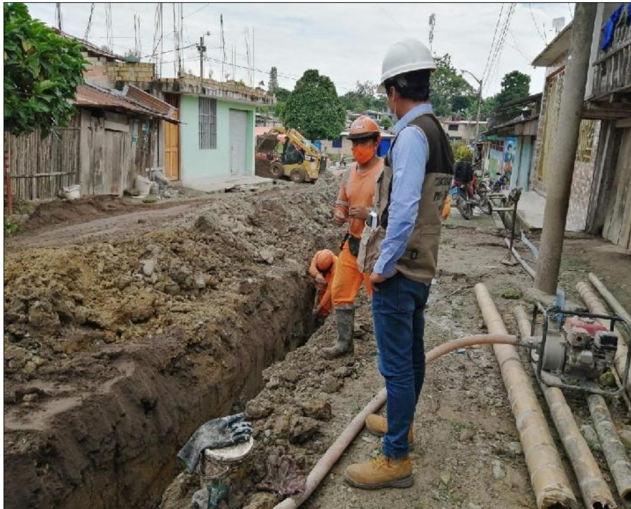
Foto 3 Monitoreo de trabajos de tendido de la red de distribución de agua potable.
