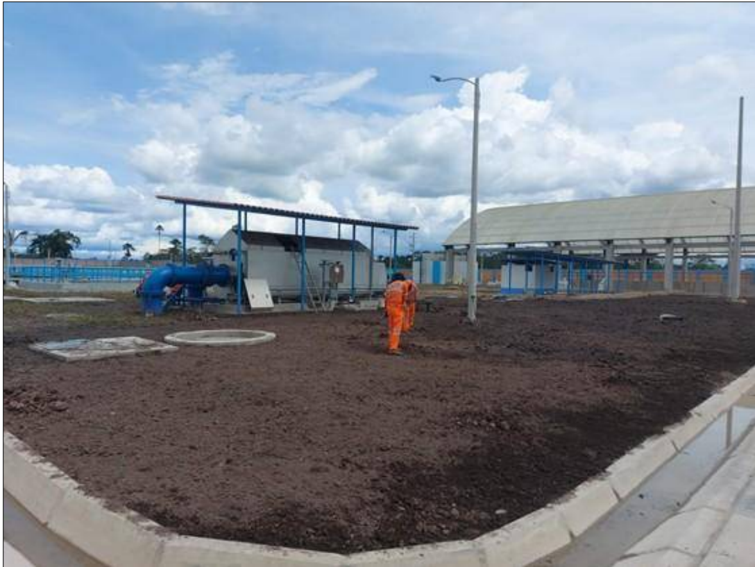
Foto 7 Verificación de trabajos de colocación de tierra de chacra en patio de Planta de Tratamiento de Aguas Residuales
