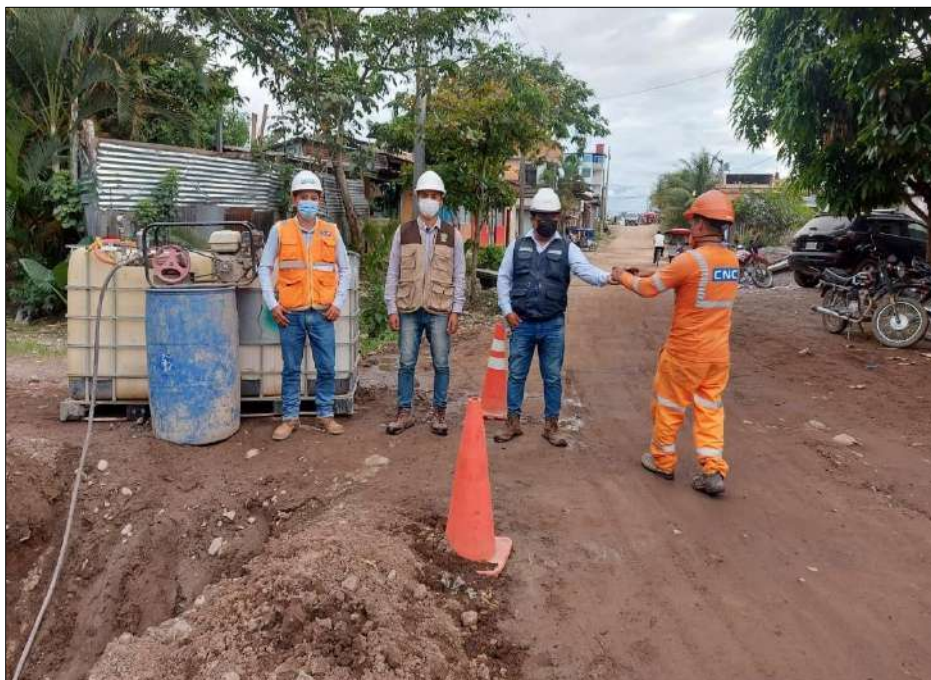
Foto 4 Presencia en ejecución de prueba hidráulica en la red de agua potable
