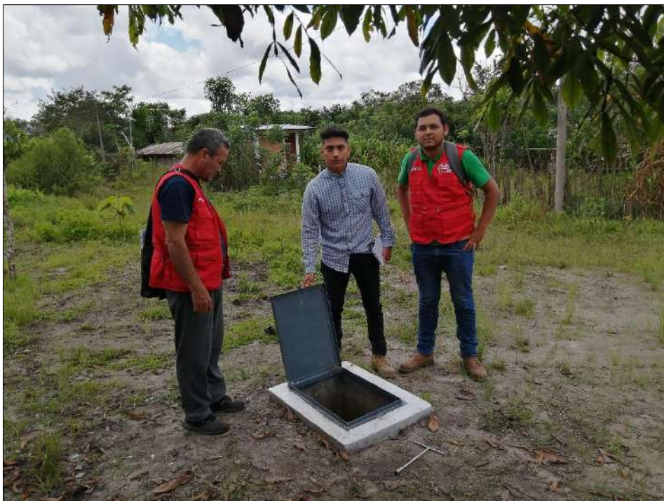
Foto 20 Recorrido por los componentes lineales ejecutados de la obra, conjuntamente con representantes de Vivienda
