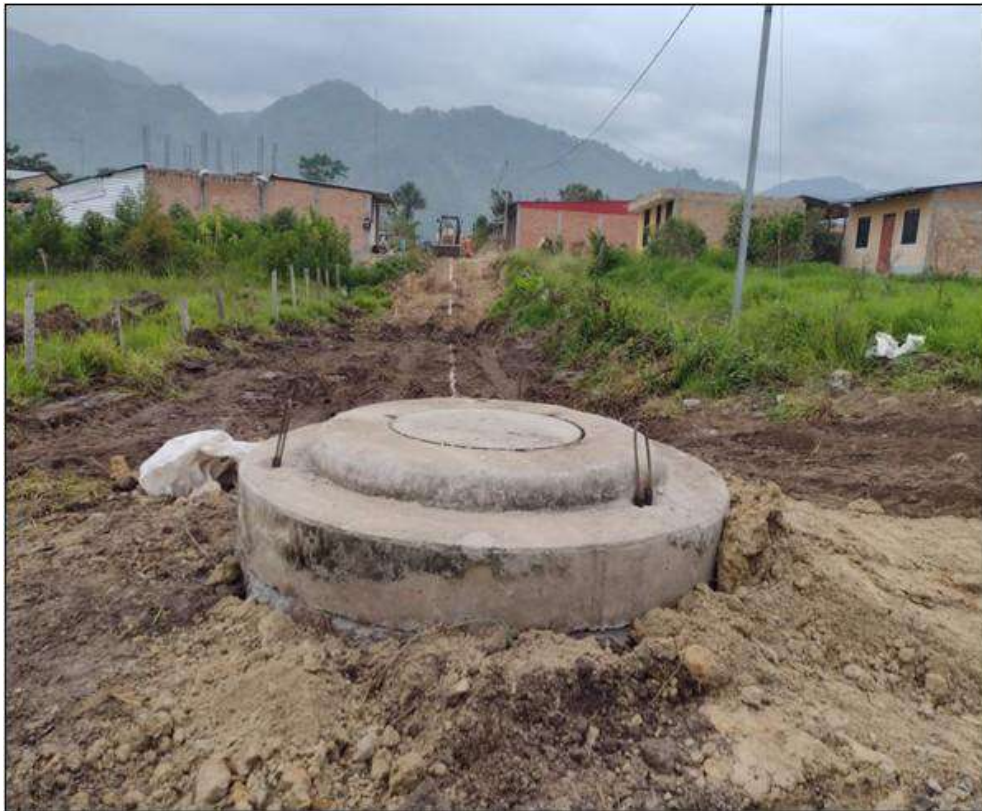
Foto 5 Verificación de trabajos de excavación para la red de alcantarillado
