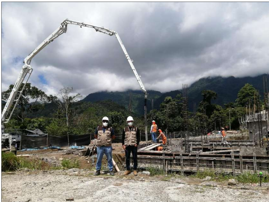
Foto 8 Presencia en actividades de vaciado de concreto en elementos estructurales.
