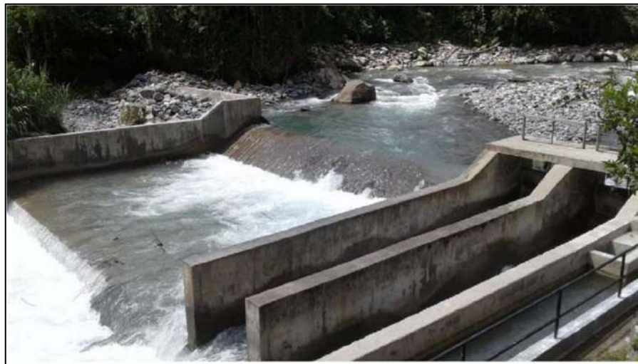
Figura 23. Estructura de Bocatoma existente
