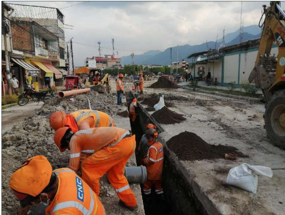
Foto 9 Monitoreo de la ejecución de partidas de excavación y colocación de tuberías en redes matrices de agua potable en el centro histórico de la ciudad.
