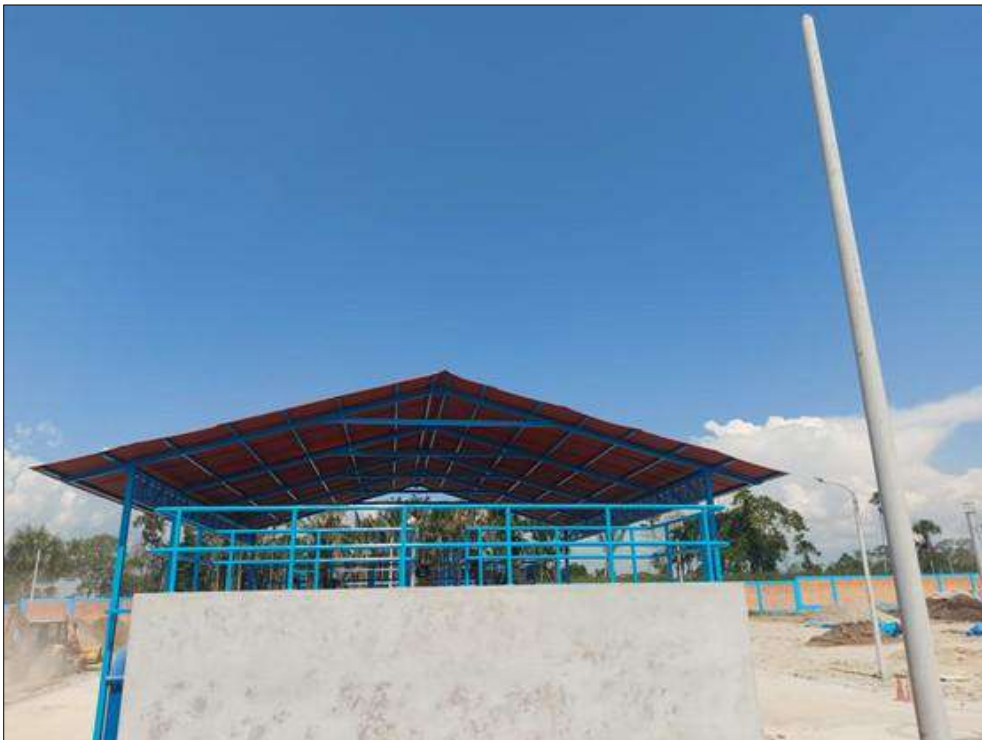
Foto 6 Verificación de partidas de pintura y acabado exterior en estructuras de Planta de Tratamiento de Aguas Residuales
