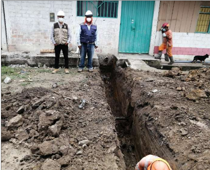
Foto 24 Verificación de trabajos de instalación de tuberías DN=110mm – 160 mm del sistema de agua potable en zona urbana de la ciudad
