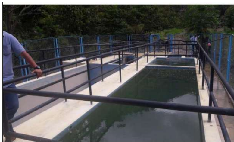
Figura 24. Estructura del Desarenador existente
