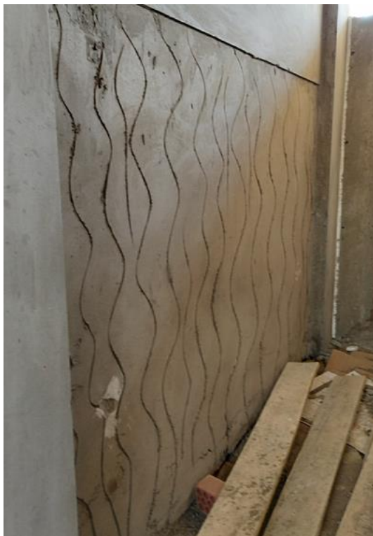
FOTOGRAFIA N°03: Tarrajeo Rayado Primario
