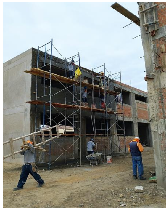
FOTOGRAFIA N°06: Tarrajeo de muros exteriores
