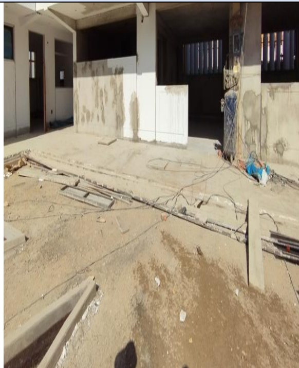
FOTOGRAFIA N°06: Tarrajeo de Columnas y muros exteriores que tuvieron que ser resanados
