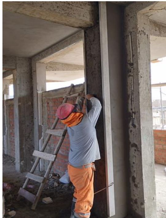
FOTOGRAFIA N°06: Tarrajeo de Columnas
