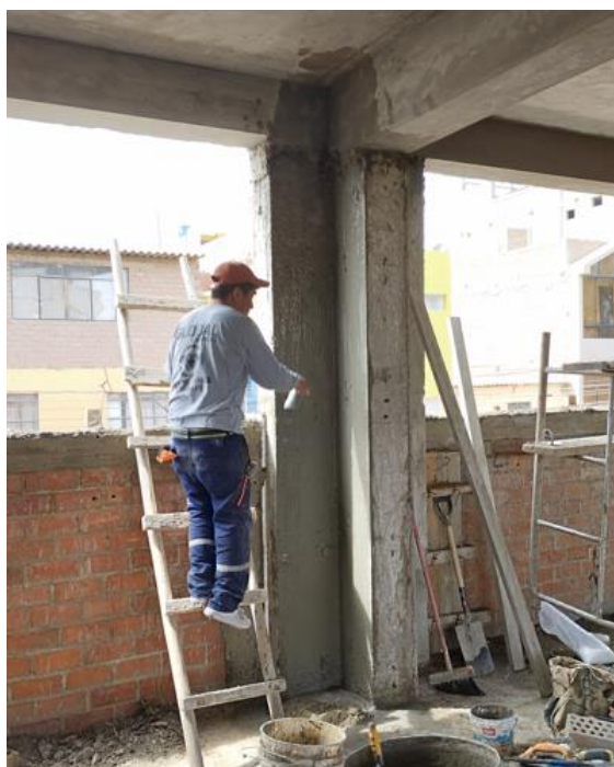
FOTOGRAFIA N°05: Tarrajeo de muros interiores
