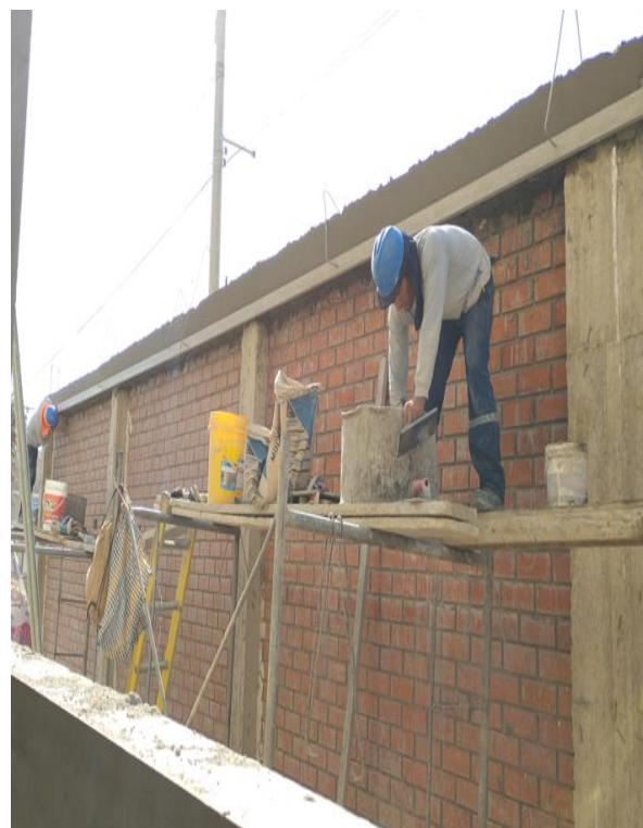
FOTOGRAFIA N°08: Tarrajeo de vigas
