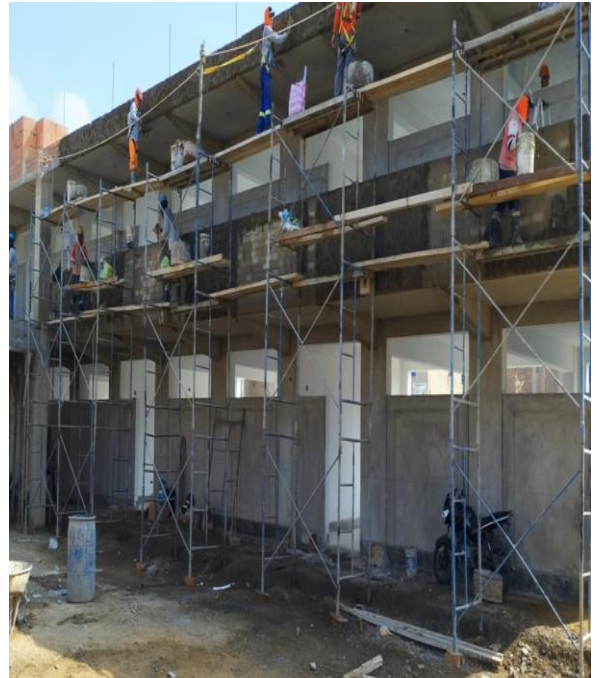
FOTOGRAFIA N°02: Tarrajeo de muros exteriores
