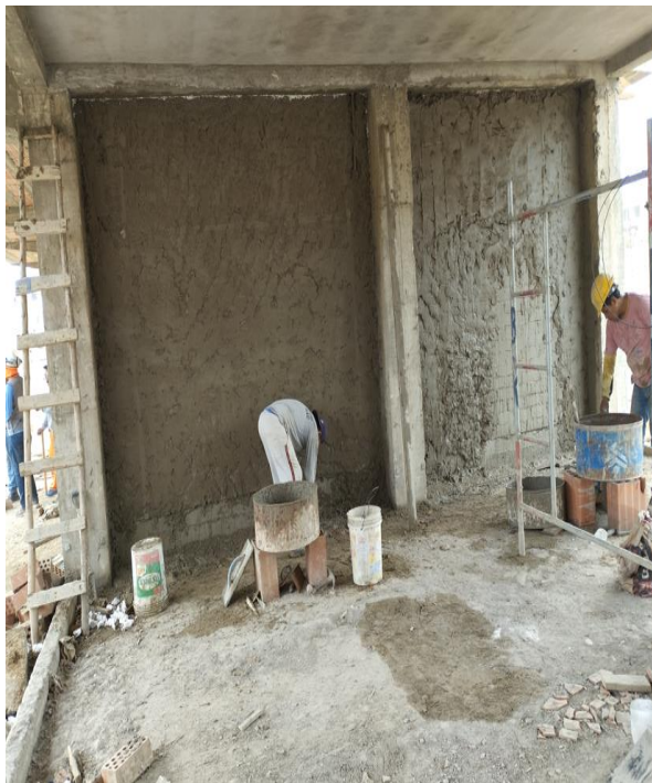
FOTOGRAFIA N°05: Tarrajeo de muros interiores
