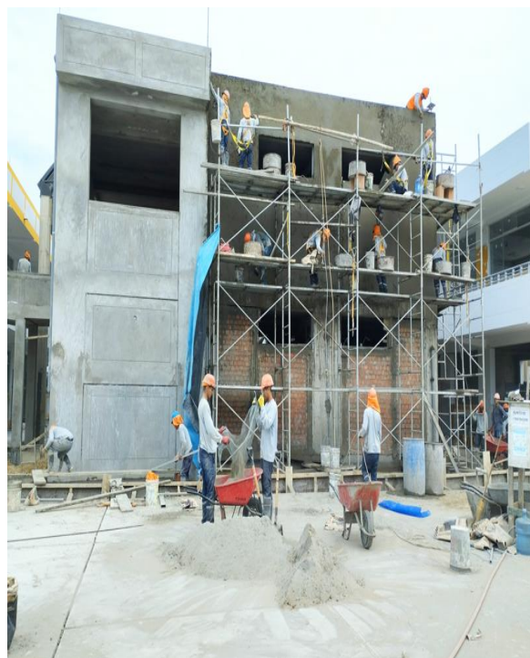
FOTOGRAFIA N°05: Tarrajeo de muros exteriores y bruñas
