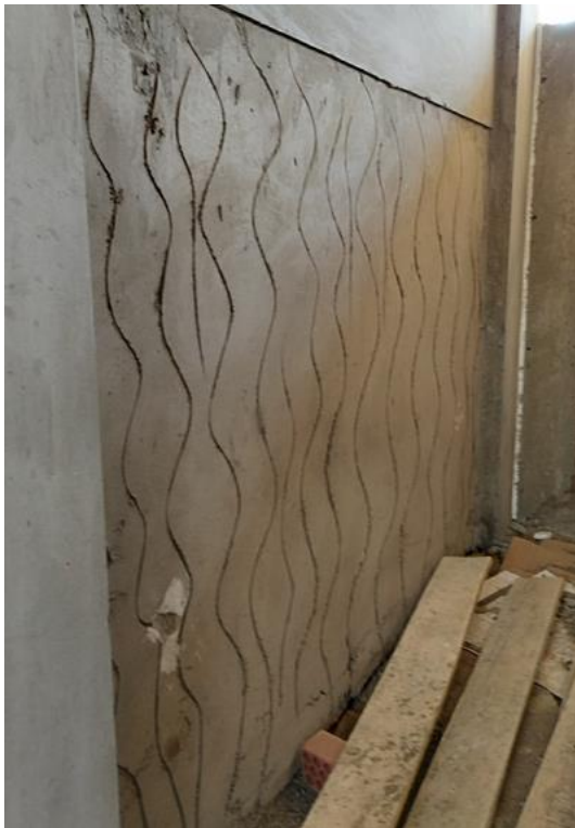
FOTOGRAFIA N°03: Tarrajeo Rayado Primario
