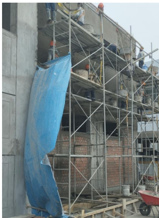
FOTOGRAFIA N°08: Tarrajeo de muros exteriores
