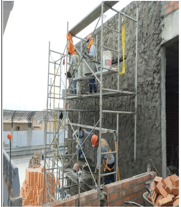
FOTOGRAFIA N°02: Tarrajeo de muros exteriores
