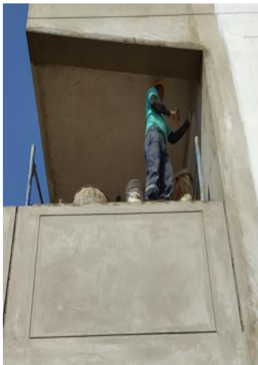
FOTOGRAFIA N°07: Tarrajeo de vigas
