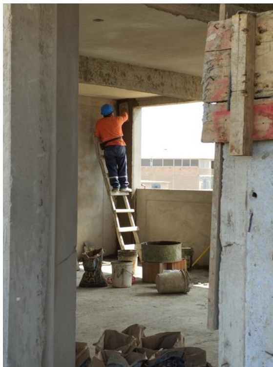
FOTOGRAFIA N°07: Tarrajeo de Columnas
