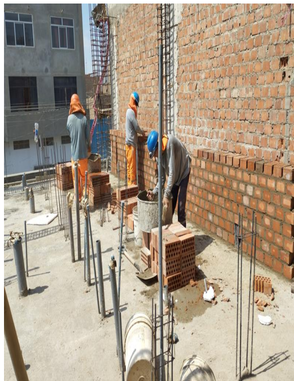
FOTOGRAFIA N°01: Asentamiento de muros de sogá
