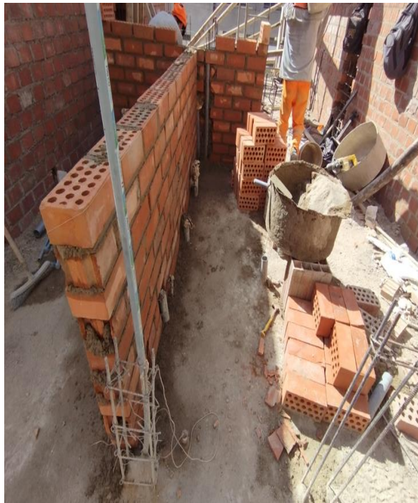
FOTOGRAFIA N°01: Asentamiento de muros de sogá
