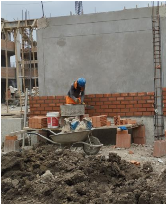
FOTOGRAFIA N°01: Asentamiento de muros de sogá
