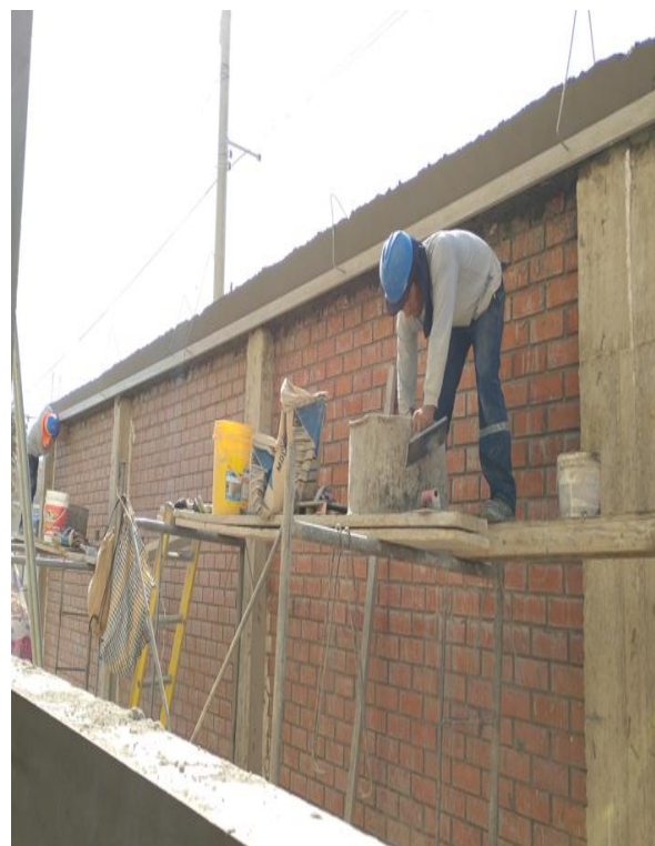
FOTOGRAFIA N°08: Tarrajeo de vigas
