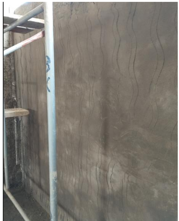
FOTOGRAFIA N°02: Asentamiento de muros de sogá
