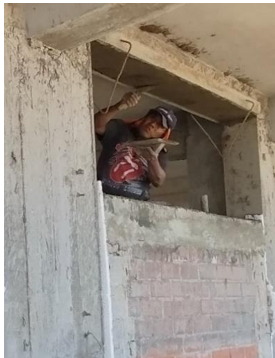
FOTOGRAFIA N°06: Tarrajeo de muros exteriores
