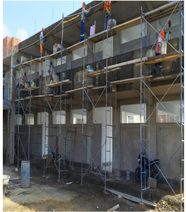
FOTOGRAFIA N°02: Tarrajeo de muros exteriores
