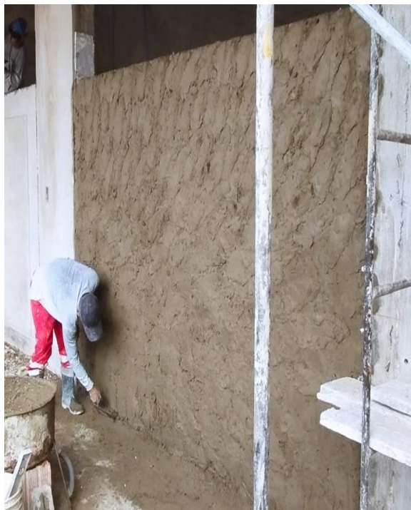
FOTOGRAFIA N°05: Tarrajeo de muros exteriores
