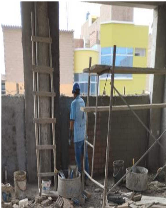
FOTOGRAFIA N°05: Tarrajeo de muros interiores
