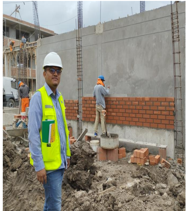
FOTOGRAFIA N°02: Asentamiento de muros de sogá
