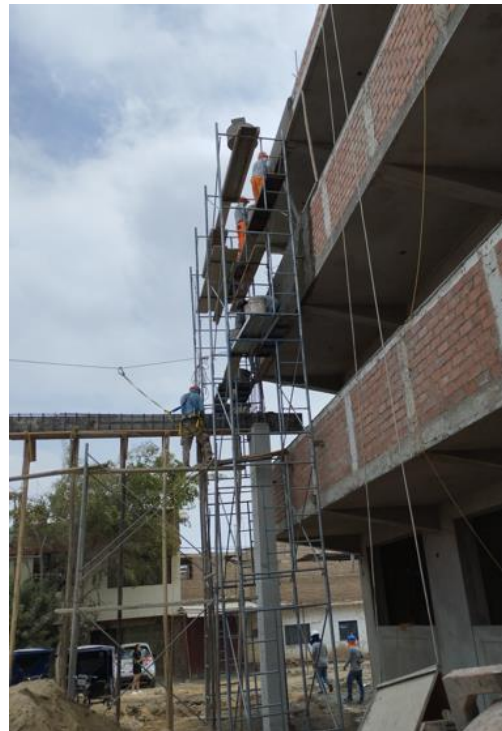
FOTOGRAFIA N°06: Tarrajeo de muros exteriores
