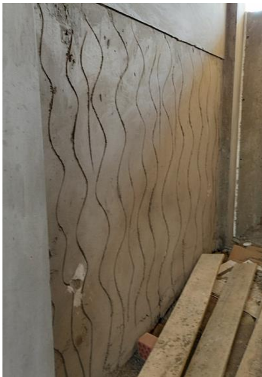
FOTOGRAFIA N°03: Tarrajeo Rayado Primario
