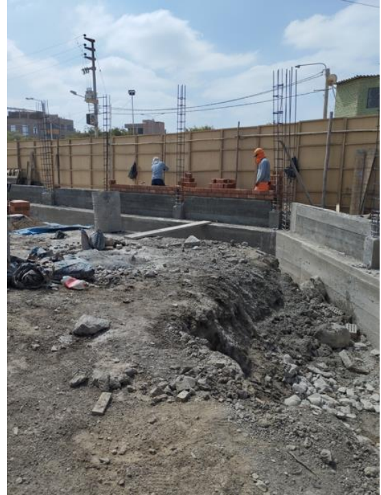
FOTOGRAFIA N°02: Asentamiento de muros de sogá
