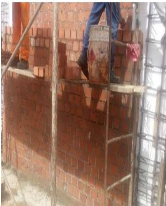
FOTOGRAFIA N°01: Asentamiento de muros de sogá
