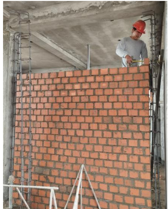
FOTOGRAFIA N°02: Asentamiento de muros de cabeza
