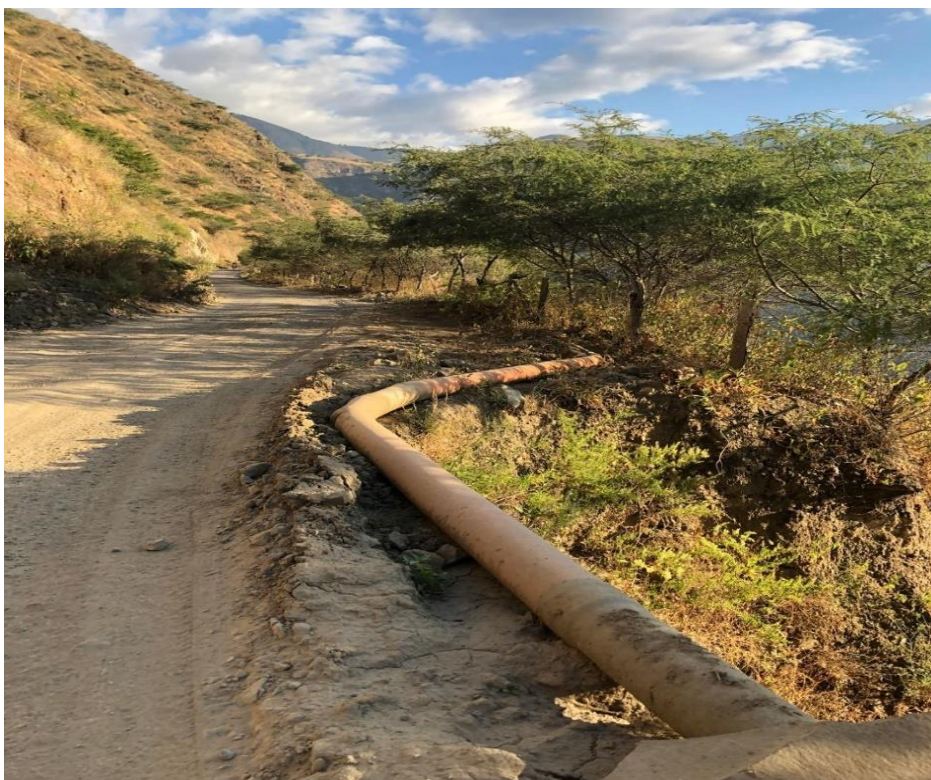
Fotografía 4. Tramos del canal con tubería de 8".
