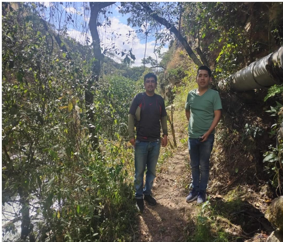
Fotografía 2. Tramos del canal con tubería de 12".
