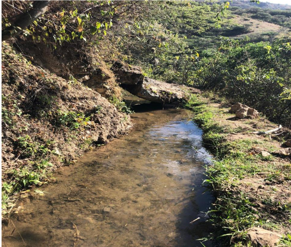
Fotografía 3. Tramos del canal no revestido.
