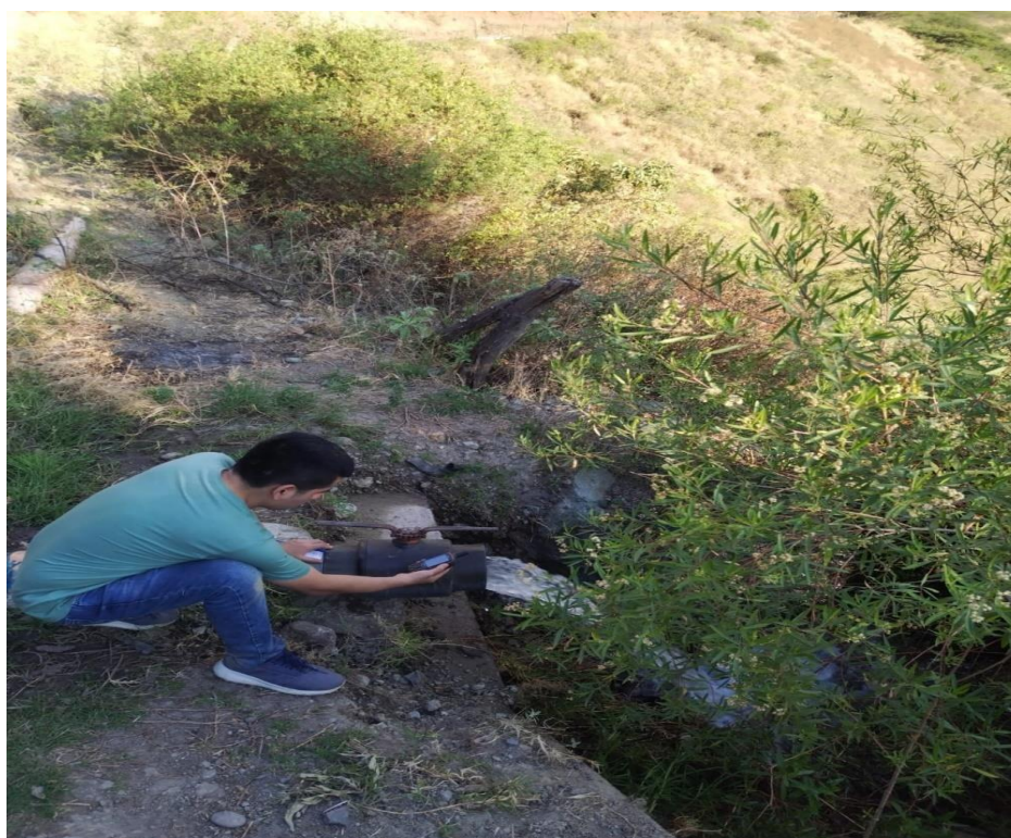
Fotografía 8. Toma 3 (Mamashive) una de las llaves que distribuye el agua hacia los predios.
