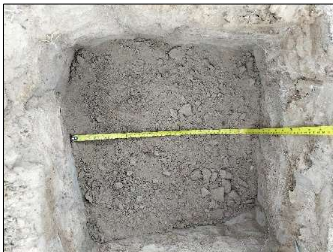
Figura 16. Verificación de profundidad
