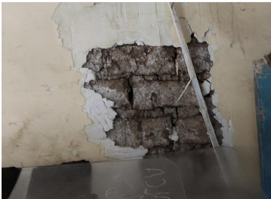
Muro interno del depósito de armas
