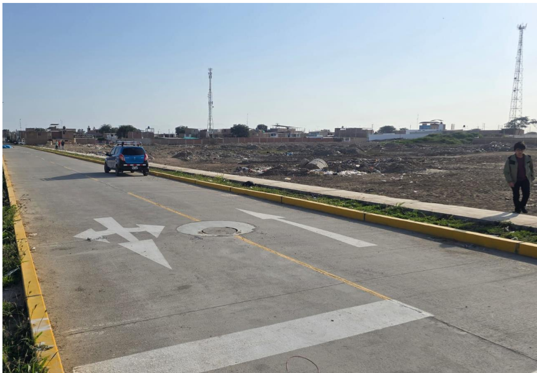
Vista desde la esquina nor-este
