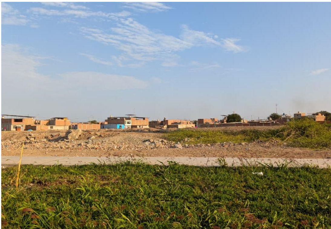
Vista desde la esquina nor-oeste
