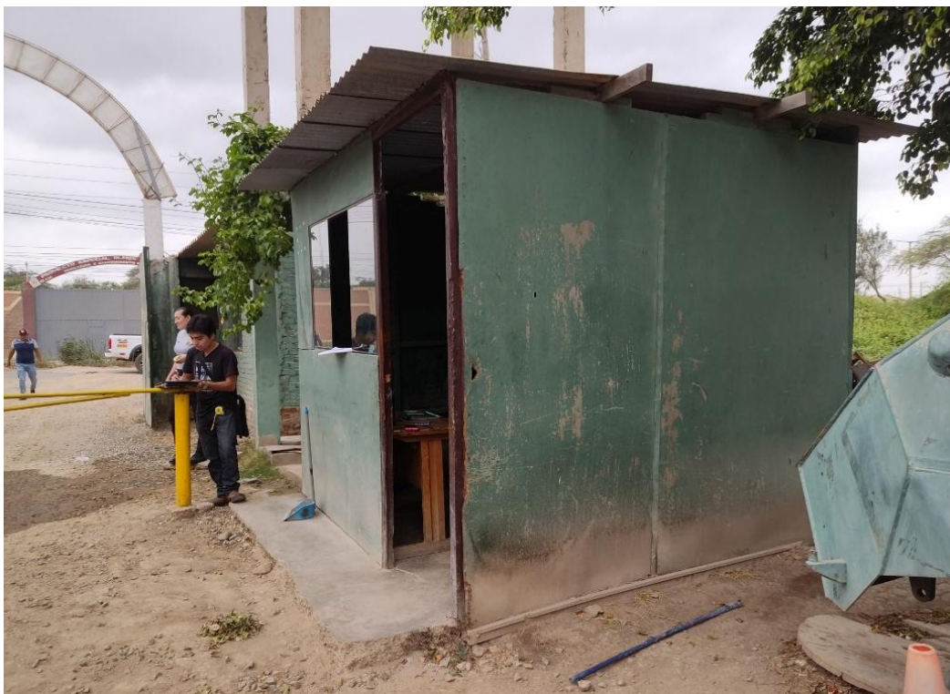
Caseta de vigilancia y garita de control - Entrada
