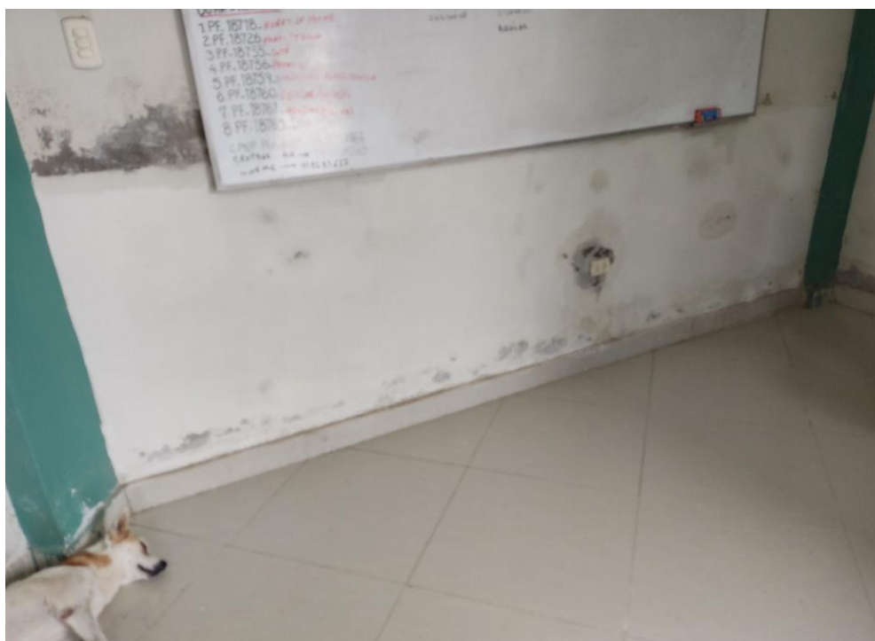
Sala de espera de la Unidad de Operaciones Especiales - Escuadrón Verde
