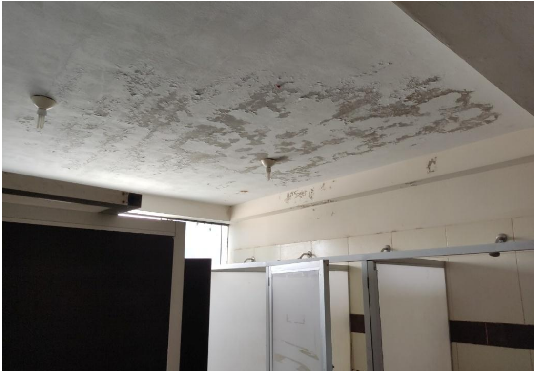
Baño del dormitorio de suboficiales varones
