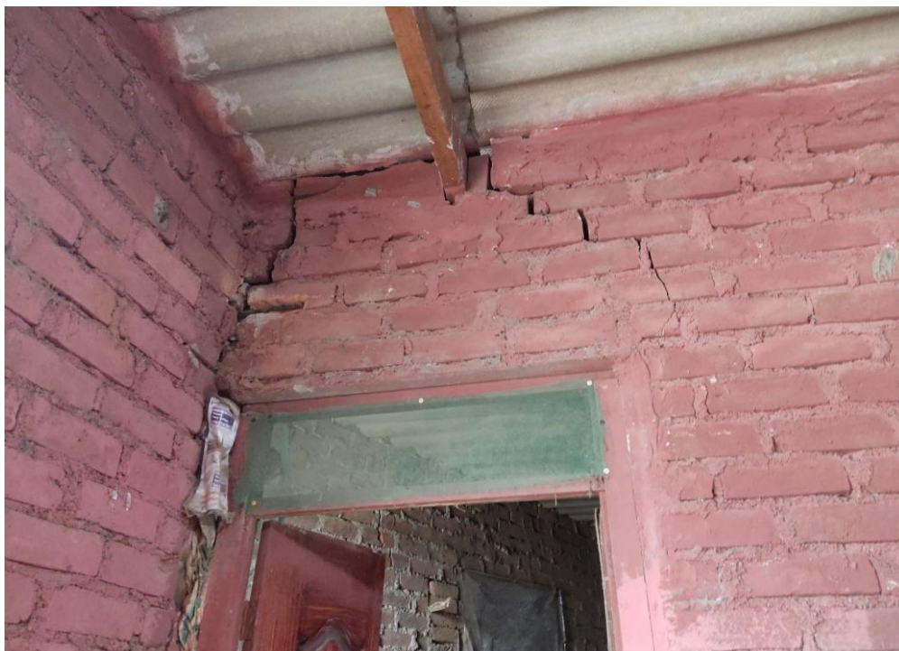
Cuarto de mantenimiento de Armas
