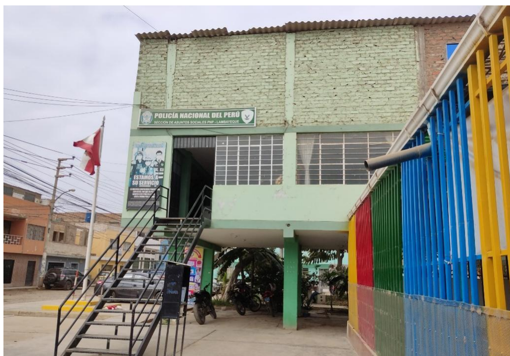
Vista exterior del ingreso a la Sección de Asuntos Sociales y Obras Civiles
