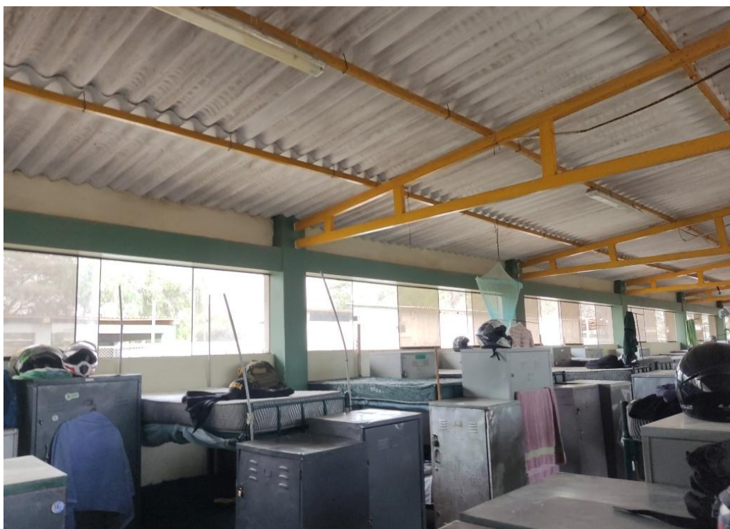
Dormitorio de Suboficiales
