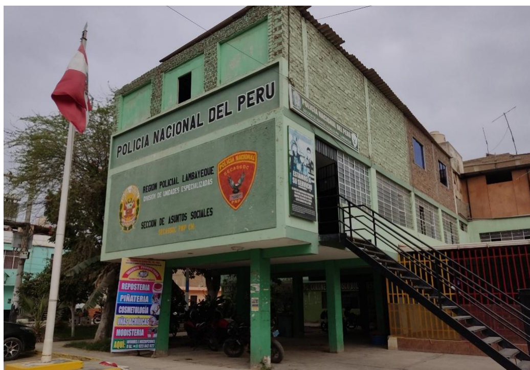
Vista exterior de la Sección de Asuntos Sociales y Obras Civiles
