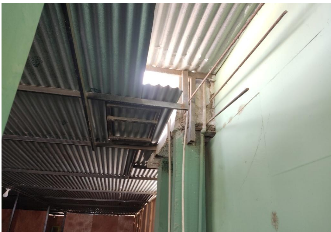
Techo de calamina metálica del patio interno
