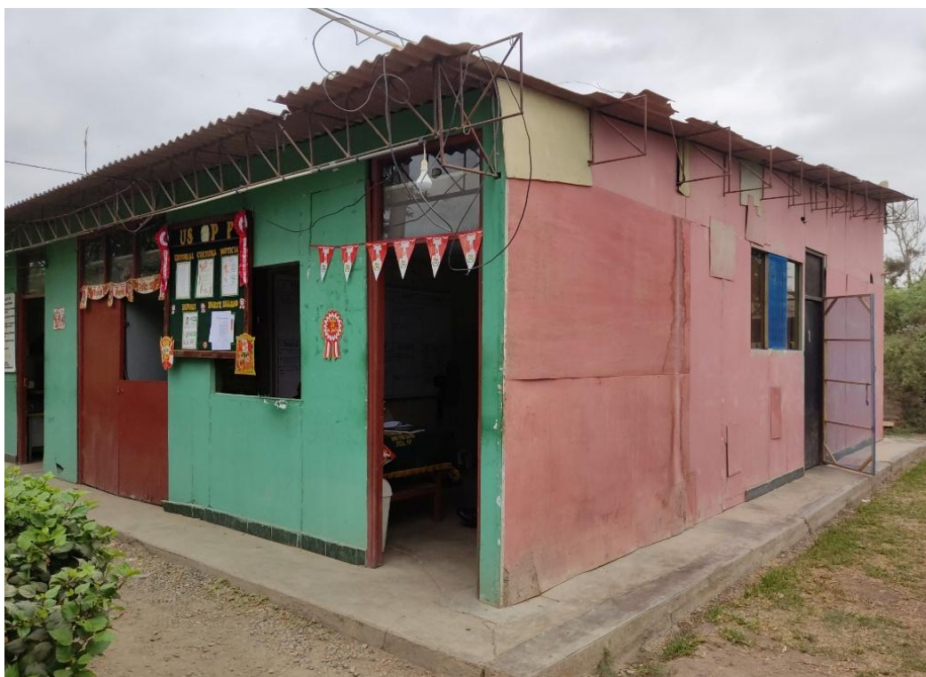
Exterior del área administrativa de la USE
