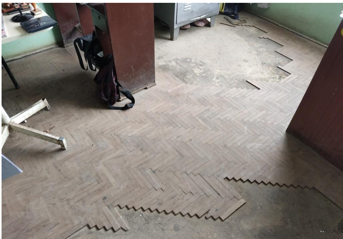
Piso de la oficina de administración
