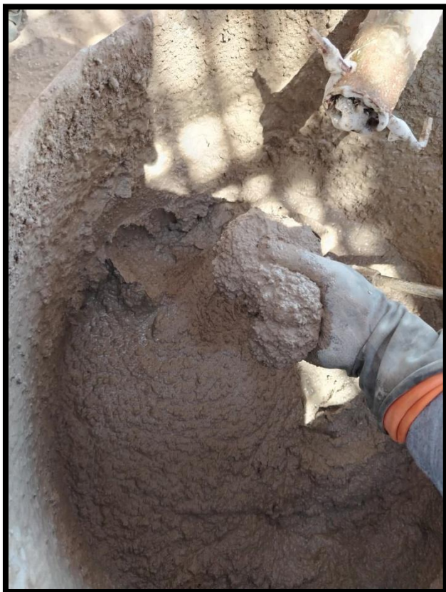
Imagen N° 36: Se obtiene una mezcla de alta consistencia (fluida)
