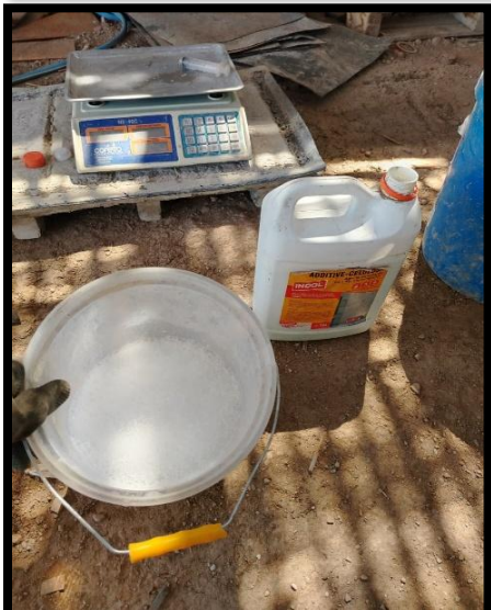
Imagen N° 28: Dosificación y preparación del aditivo
