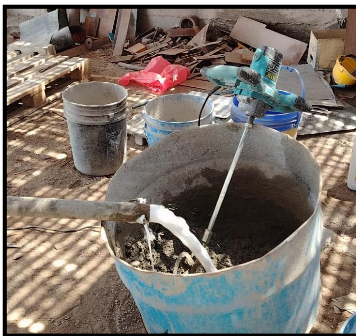
Imagen N° 34: Adición de la espuma generada + 1/3 del confitillo faltante.
