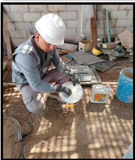
Imagen N° 28: Dosificación y preparación del aditivo
