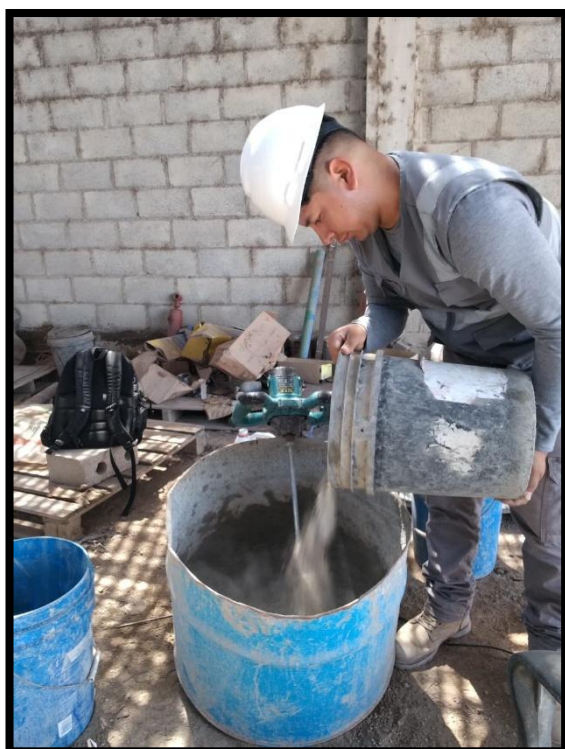
Imagen N° 32: Adición de los 2/3 de confitillo.
