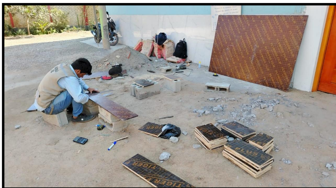
Imagen N° 26: Elaboración de moldes de madera (30x12x19) para la elaboración de bloques.
