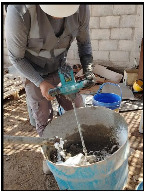
Imagen N° 34: Adición de la espuma generada + 1/3 del confitillo faltante.
