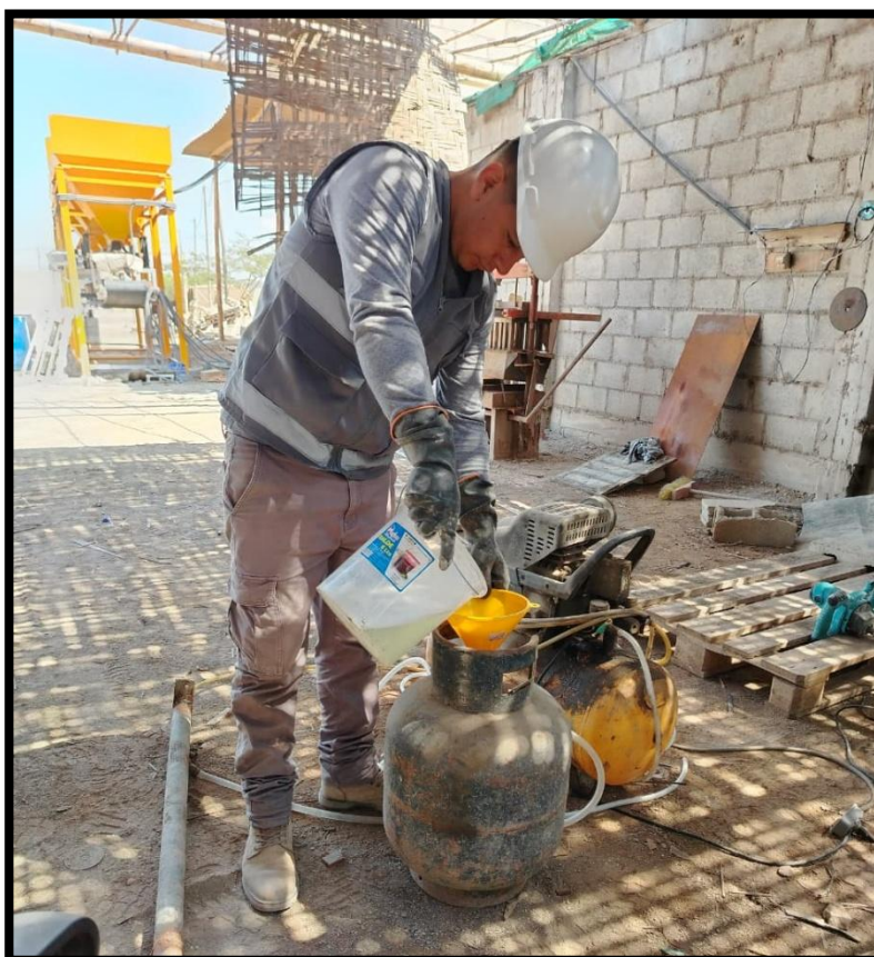
Imagen N° 30: Colocación del aditivo espumante al equipo generador de espuma
