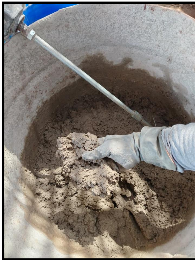
Imagen N° 33: Se obtiene una mezcla de baja consistencia (seca).
