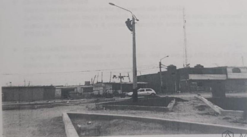
FOTO N° 05: SE OBSERVA LA INSTALACION DE CABLEADO PARA SU EMPALME CORRESPONDIENTE
