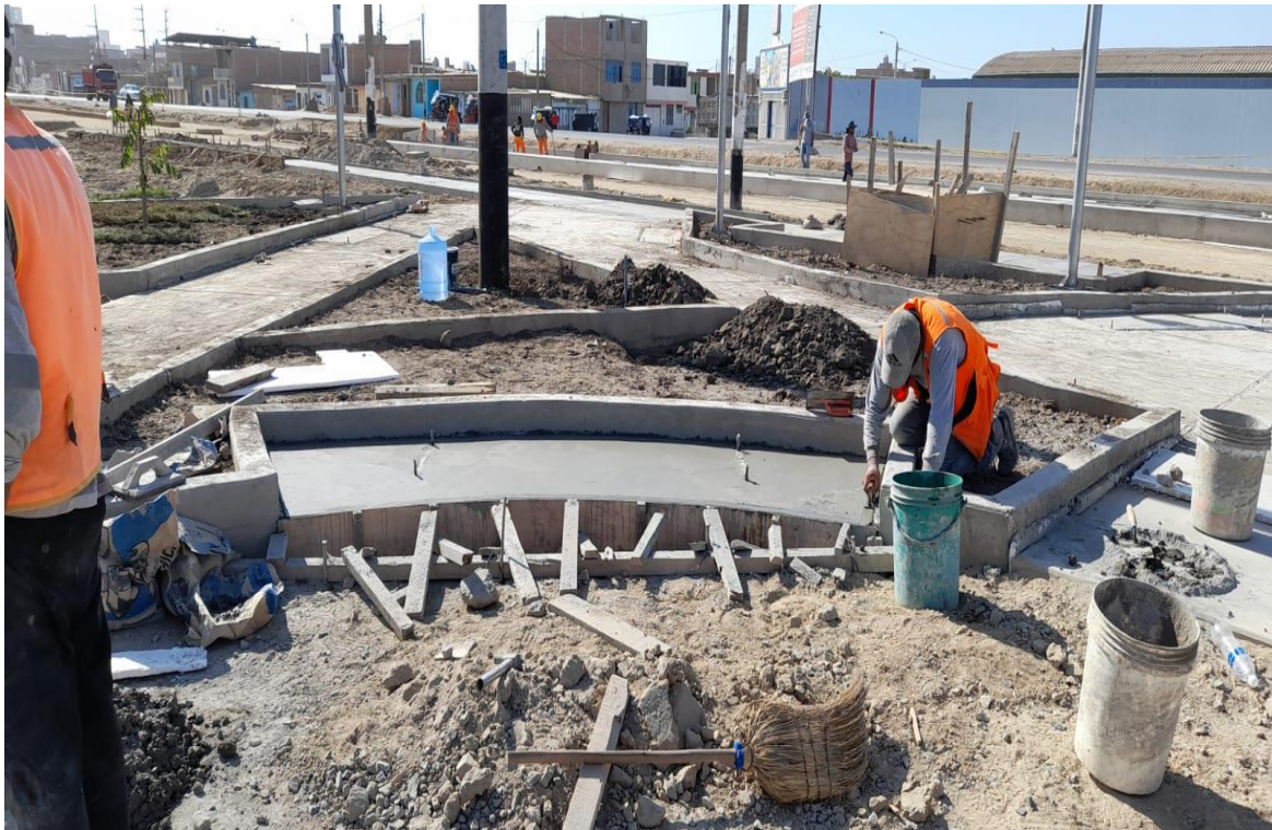
FOTO N° 05: COLOCACION DE CONCRETO BASE PARA EL ANCLAJE DE LAS BANCAS DE HIERRO FUNDIDO
