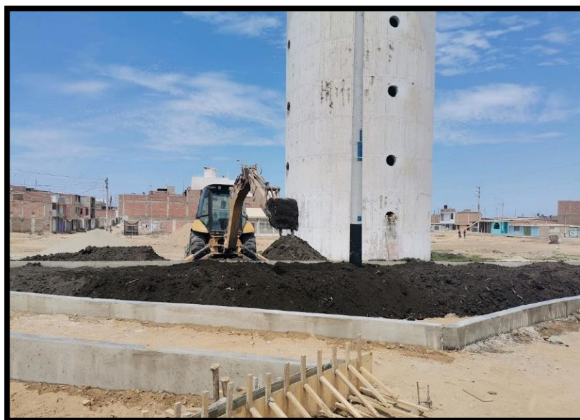
Foto N° 12: Relleno con tierra de chacra para sembrado de grass
