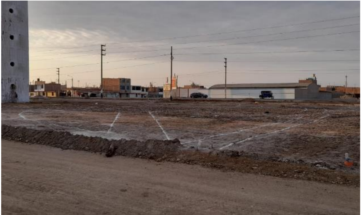
FOTO N° 04: SE OBSERVA EL TRAZO Y REPLANTE DURANTE LA EJECUCION DE OBRA A NIVEL DE SUB RASANTE.
