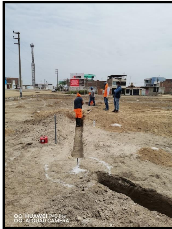
Foto N° 05: Excavación manual para colocación de tuberías
