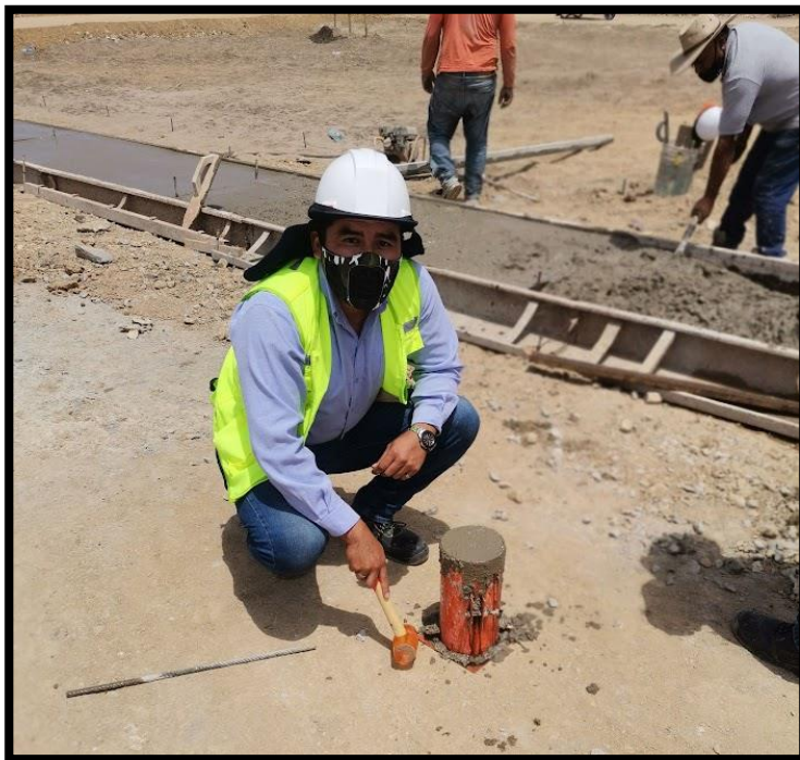
Foto N° 09: Toma de muestra para ensayo de resistencia
