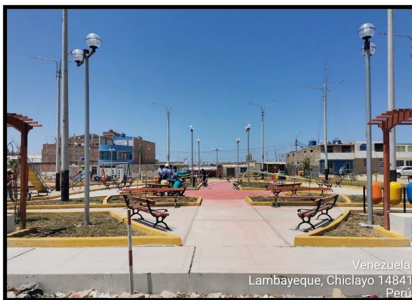
Foto N° 20: Trabajos finalizados según el expediente técnico. Quedando el parque arborizado e iluminado.
