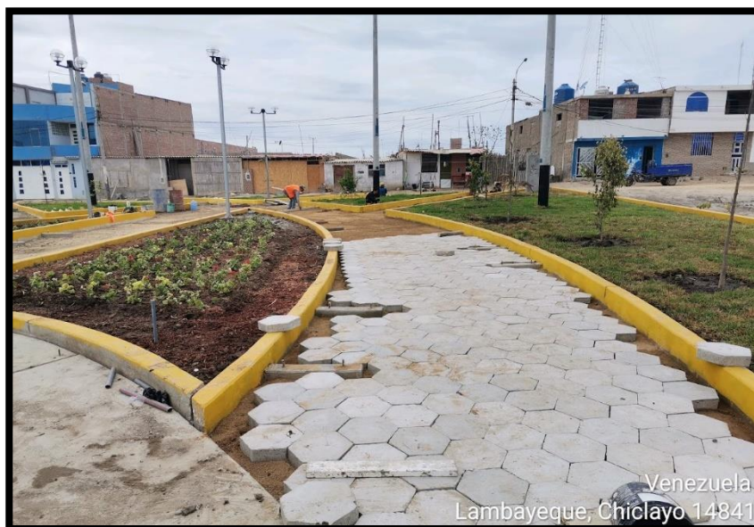
Foto N° 14: Verificación de la colocación de bloquetas hexagonal
