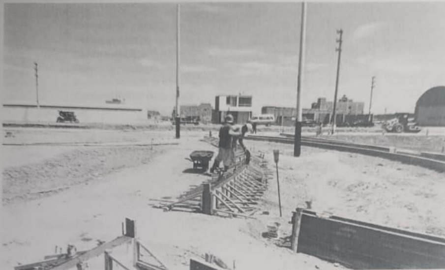
FOTO N° 04: SE OBSERVA VACIADO Y NIVELACION DE CONCRETO PARA SARDINELES F' C 175KG/CM2
