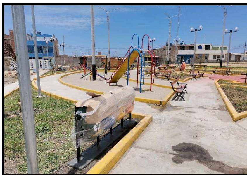
Foto N° 16: Verificación de la instalación de tachos de residuos solidos
