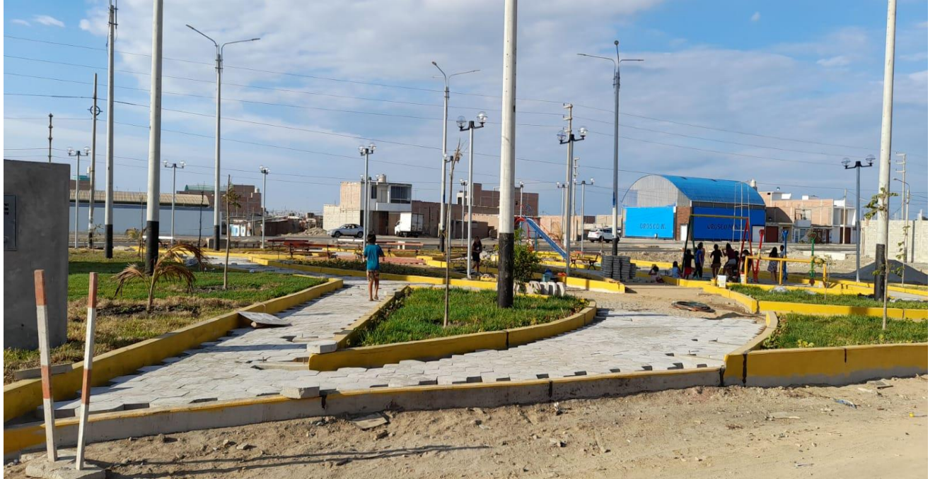
FOTO N° 01: COLACION DE ADOQUIEN EN OBRA PARA SU POSTERIOR COLOCACION
