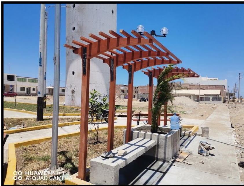
Foto N° 17: Verificación de las pérgolas de material tornillo
