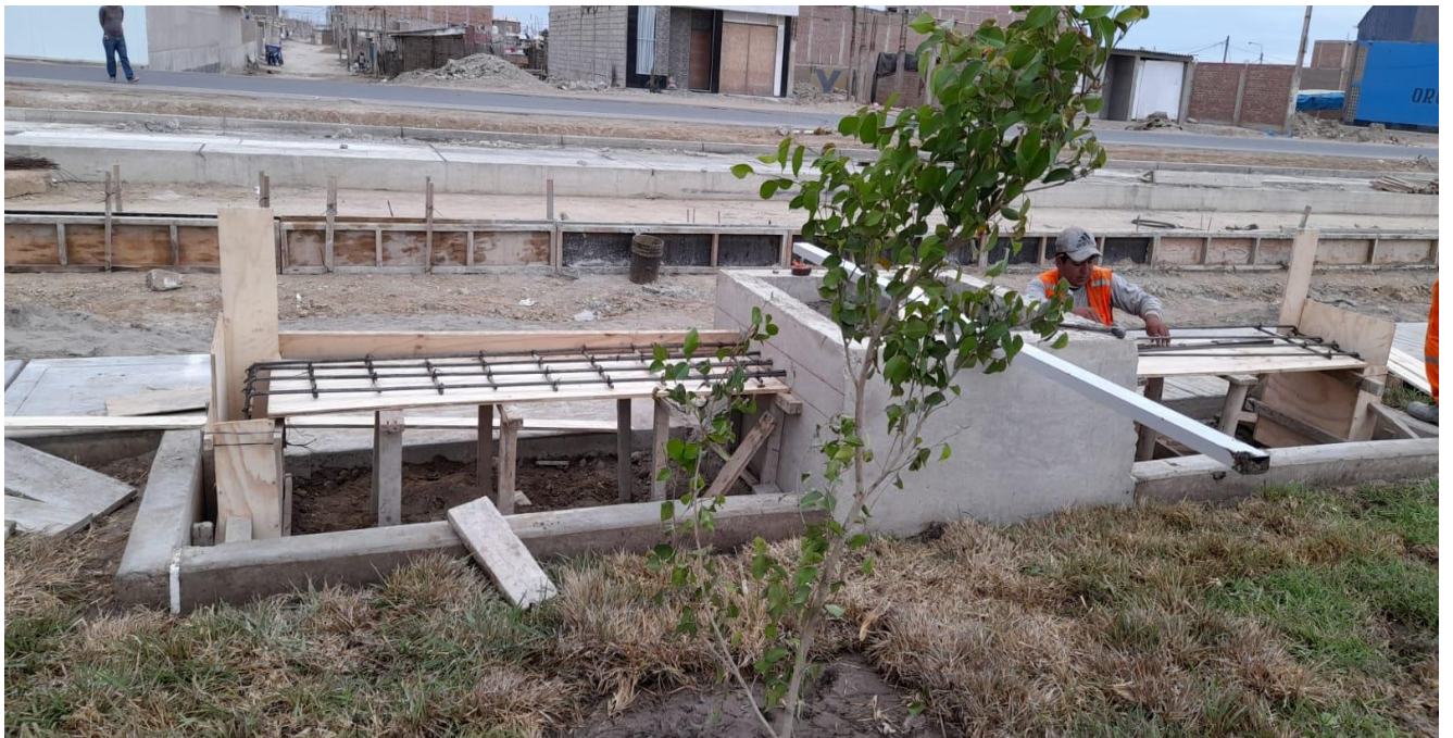
FOTO N° 02: ENCOFRADO Y HABILITACION DE ACERO DE BANCAS DE CONCRETO
