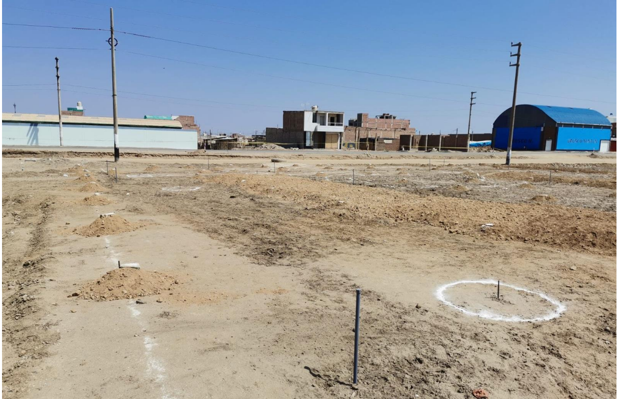
FOTO N° 03: SE OBSERVA EL TRAZADO DE LAS TUBERIAS DE INSTALACIONES ELECTRICAS Y LOS POSTES
