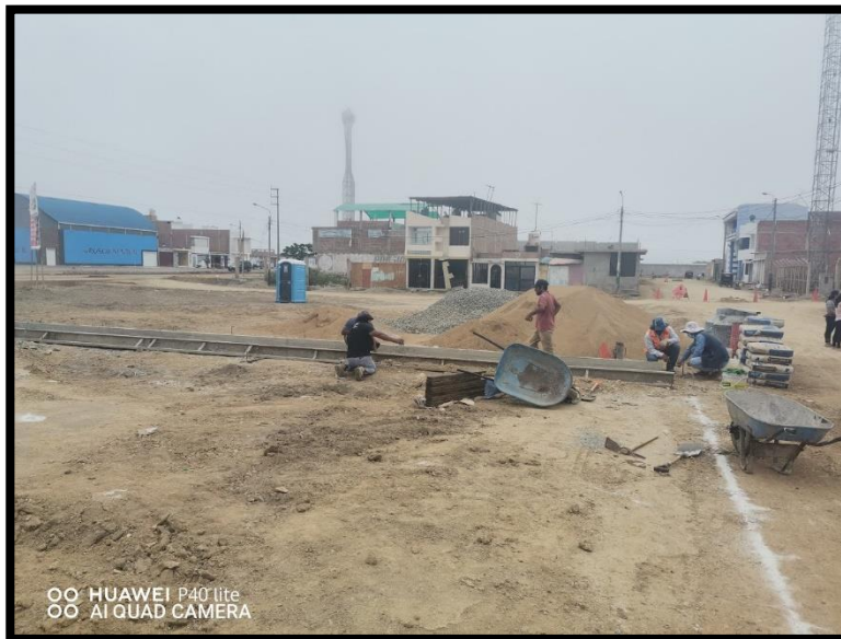
Foto N° 06: Nivelación y encofrado de veredas
