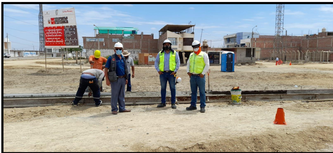
Foto N° 10: Se observa la presencia de ingeniero residente, ingeniero de seguridad y asistente de supervisión en la ejecución de la partida del vaciado de concreto en veredas
