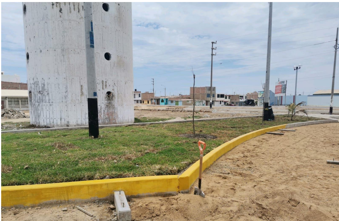
FOTO N° 06: PINTADO DE SARDINELES Y COLOCACION DE JUNTAS ASFALTICAS
