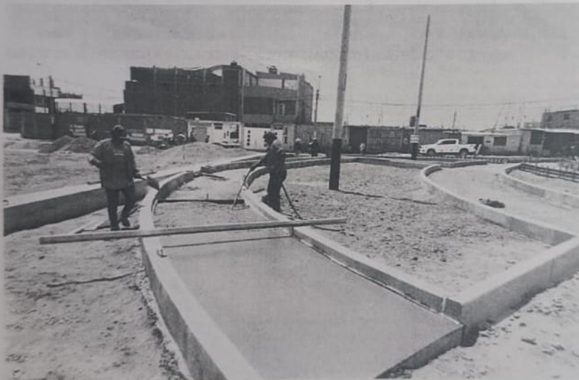
FOTO N° 01: SE OBSERVA VACIADO Y SU CORRESPONDIENTE VIBRACION EN VEREDAS DE CONCRETO F' C 175KG/CM 2
