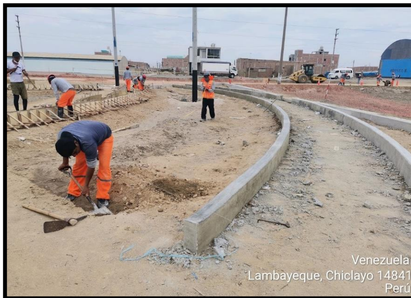
Foto N° 11: Se observa excavación de zanjas para sardineles
