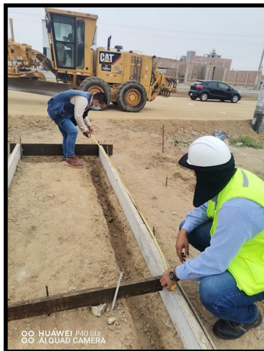
Foto N° 07: Verificación de niveles para el encofrado de veredas
