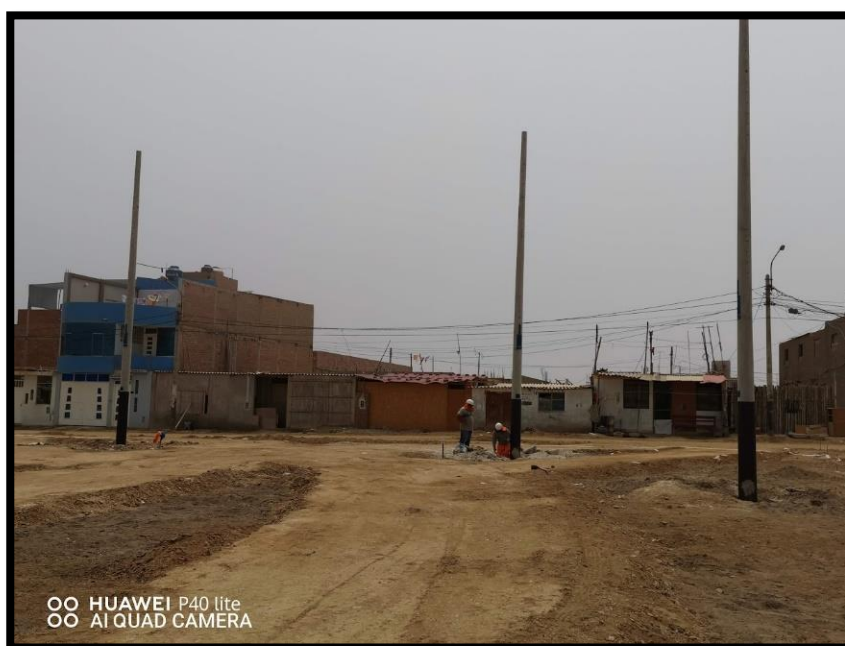
Foto N° 04: Suministro e instalación de postes de C°A°
