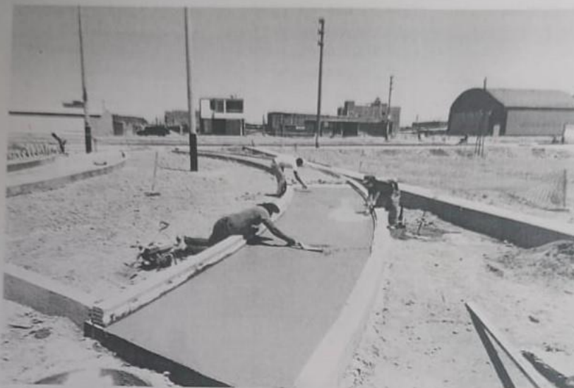
FOTO N° 02: SE OBSERVA LA NIVELACION Y PULIDO DE CONCRETO EN VEREDAS F'C 175KG/CM2
