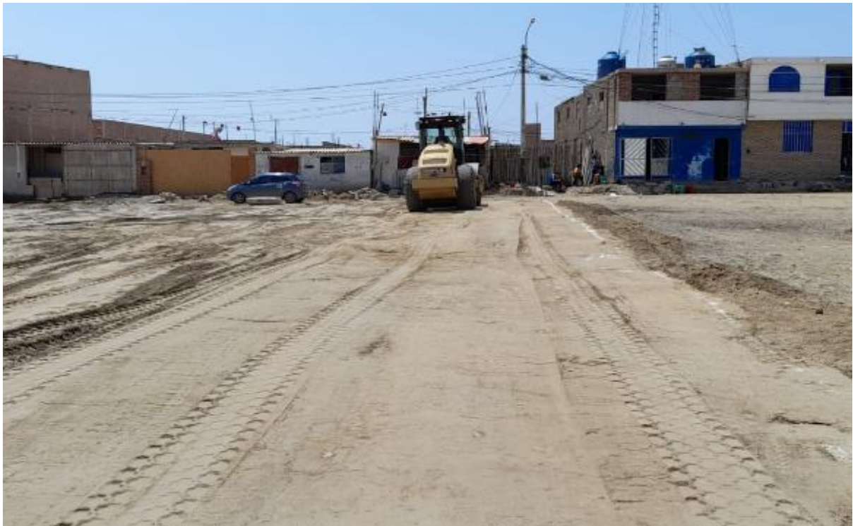
FOTO N° 05: SE OBSERVA LA CONFORMACION DE LA CAPA DE ARENILLA E=0.10M , POSTERIORMENTE SU COMPACTACION CON RODILLO LISO VIBRATORIO.
