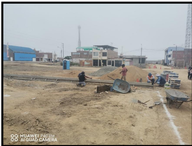
Foto N° 06: Nivelación y encofrado de veredas
