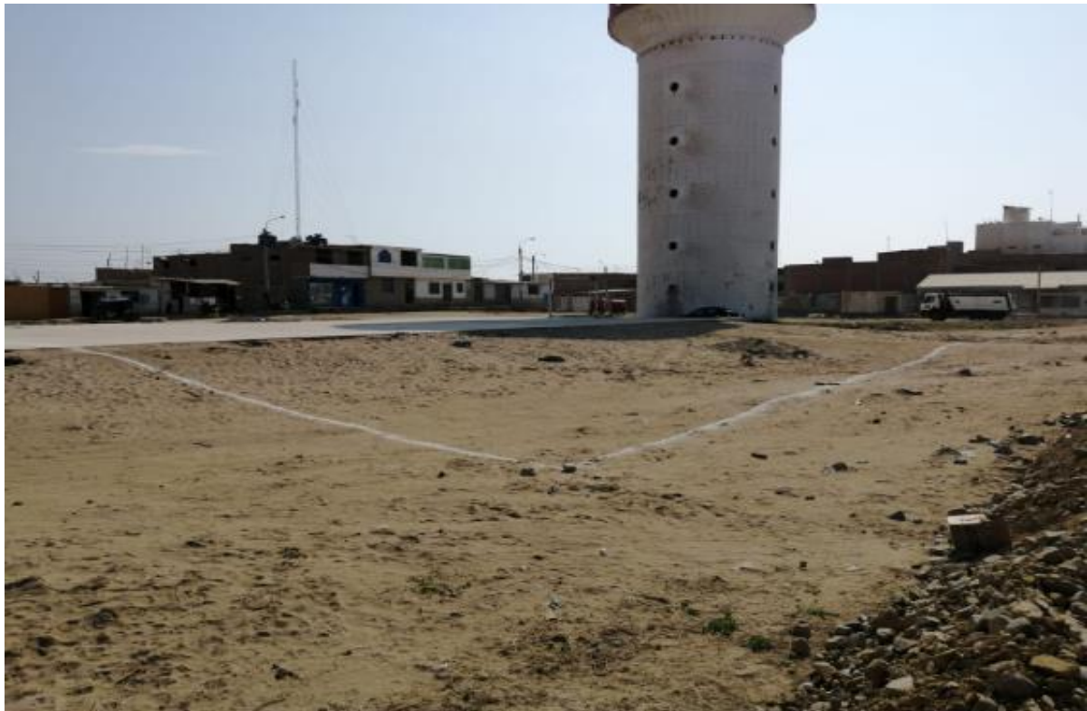
FOTO N° 02: SE OBSERVA EL TRAZO Y REPLANTEO DURANTE LA EJECUCION DE LA OBRA.
