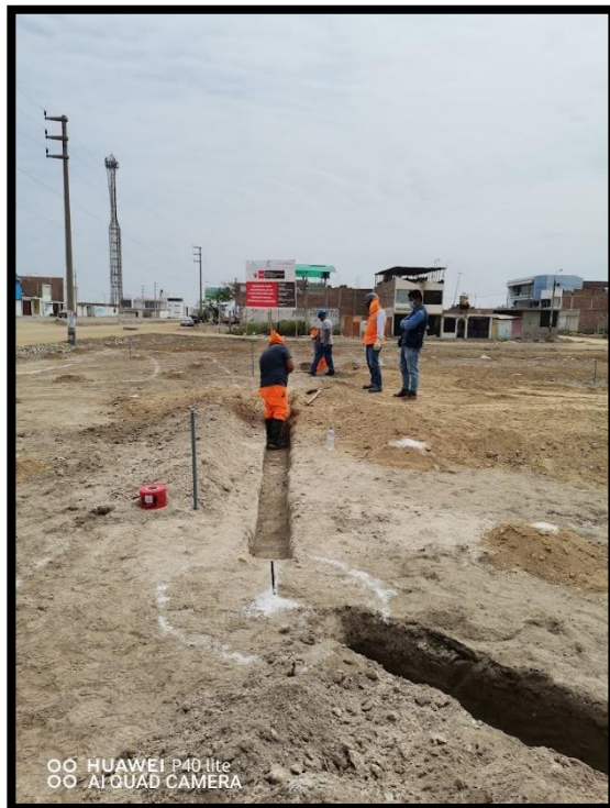
Foto N° 05: Excavación manual para colocación de tuberías
