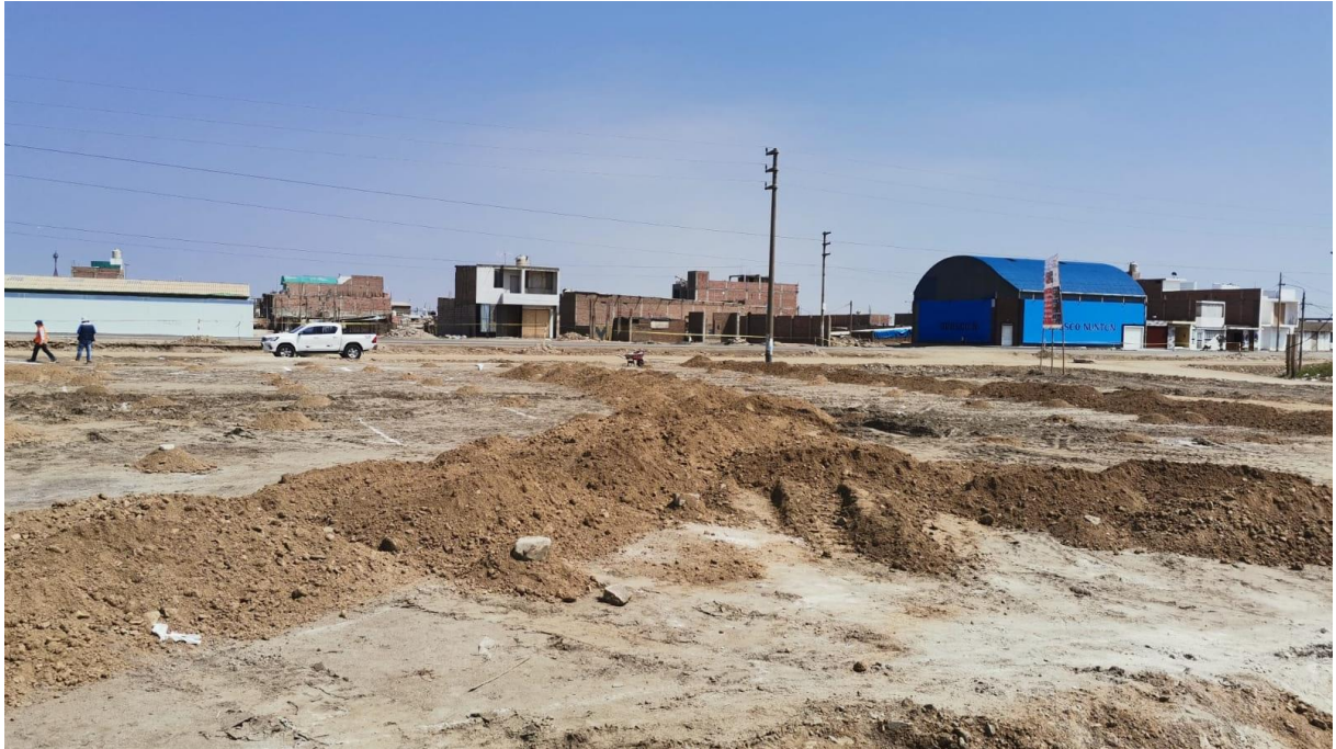
FOTO N° 01: SE OBSERVA COLOCACION DEL MATERIAL PARA SU COMPACTADO CORRESPONDIENTE.
