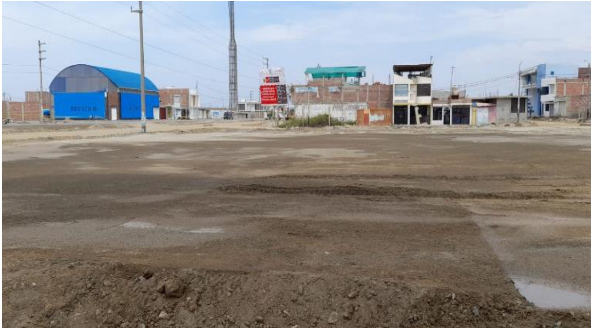
FOTO N° 06: SE OBSERVA LA CONFORMACION DEL TERRENO A NIVEL DE RASANTE.
