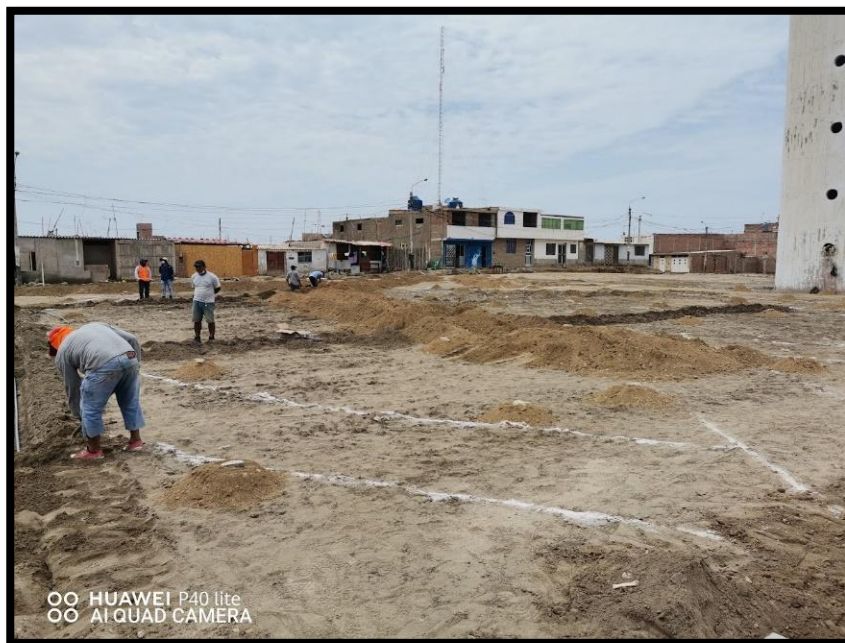
Foto N° 03: Trazo y replanteo de instalaciones eléctricas y sanitarias
