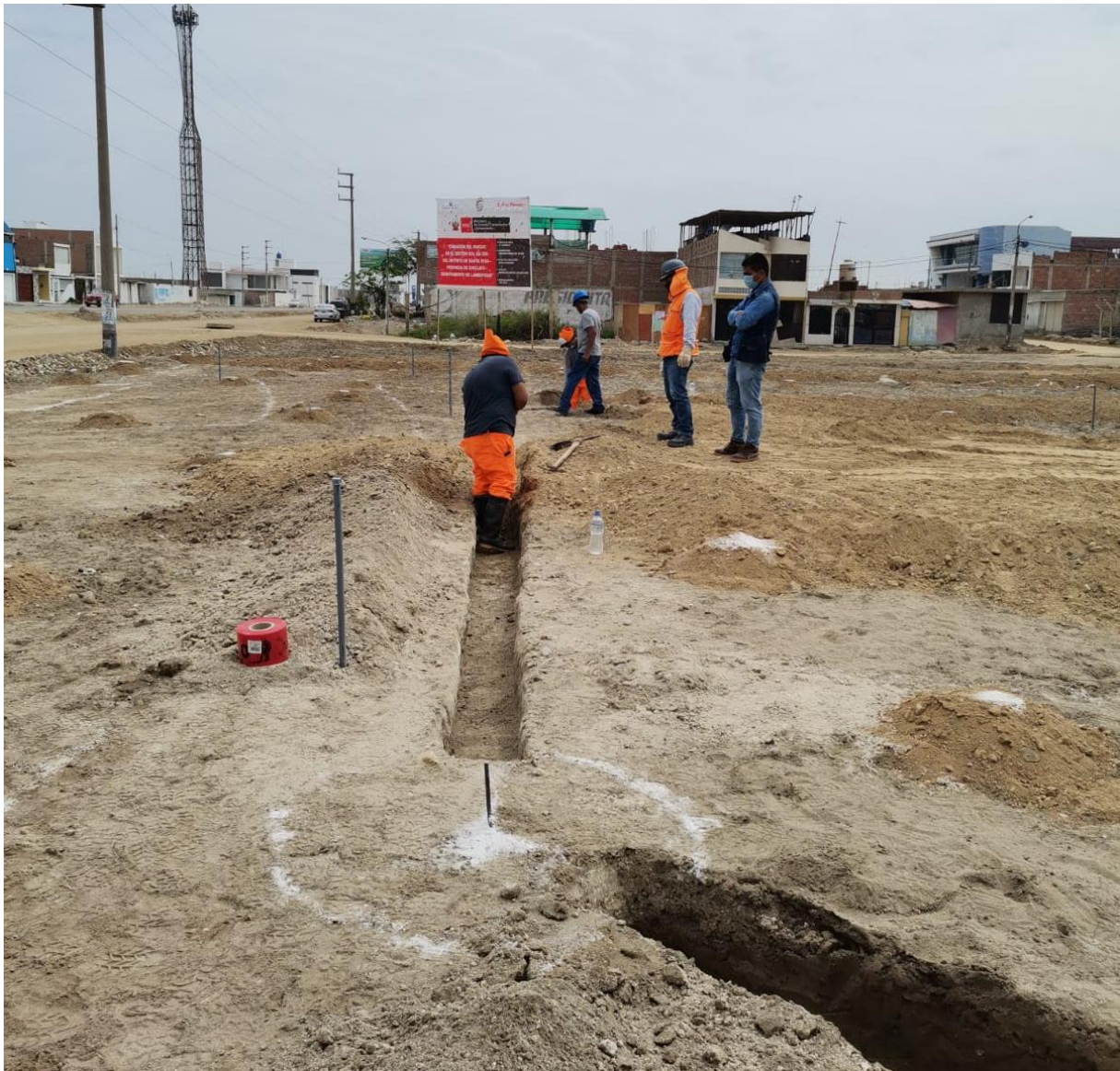
FOTO N° 04: SE OBSERVA LA EXCAVACION PARA LA POSTERIOR COLOCACION DE TUBERIAS DE INSTALACIONES ELECTRICAS Y LOS POSTES
