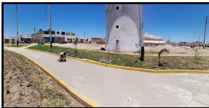
Foto N° 18: Verificación de relleno con arena fina en bloquetas y su correspondiente compactado para su nivelación
