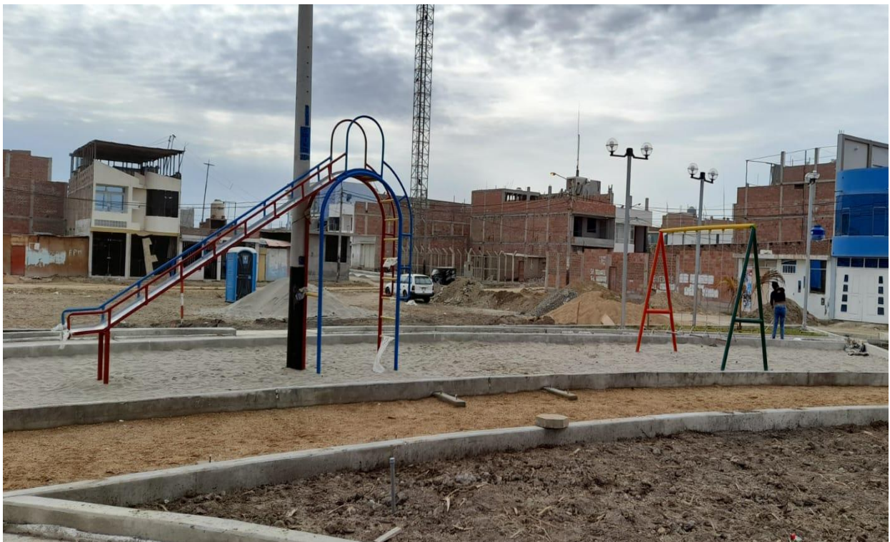
FOTO N° 04: COLOCACION DE LOS JUEGOS INFANTILES
