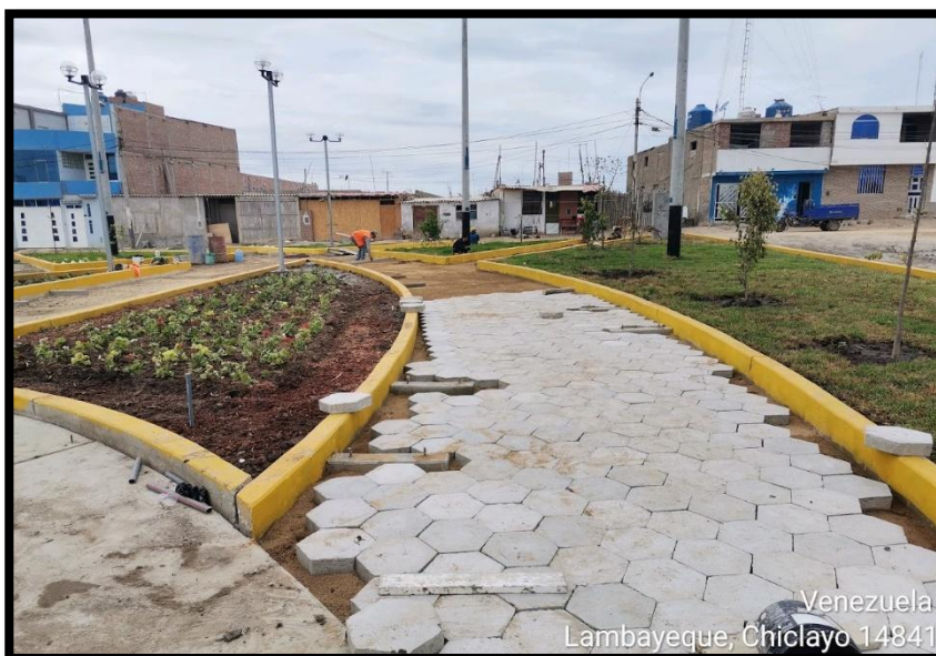
Foto N° 14: Verificación de la colocación de bloquetas hexagonal
