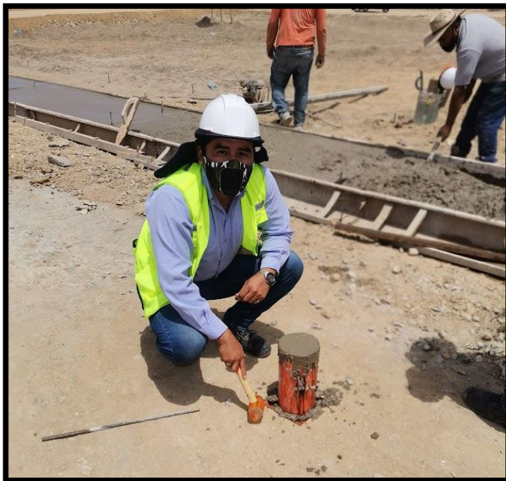
Foto N° 09: Toma de muestra para ensayo de resistencia
