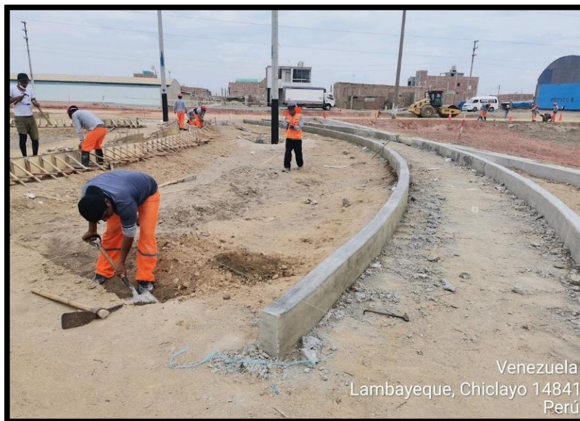
Foto N° 11: Se observa excavación de zanjas para sardineles
