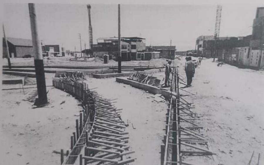
FOTO N° 03: SE OBSERVA EL ENCOFRADO Y DESENCOFRADO PARA SARDINELES
