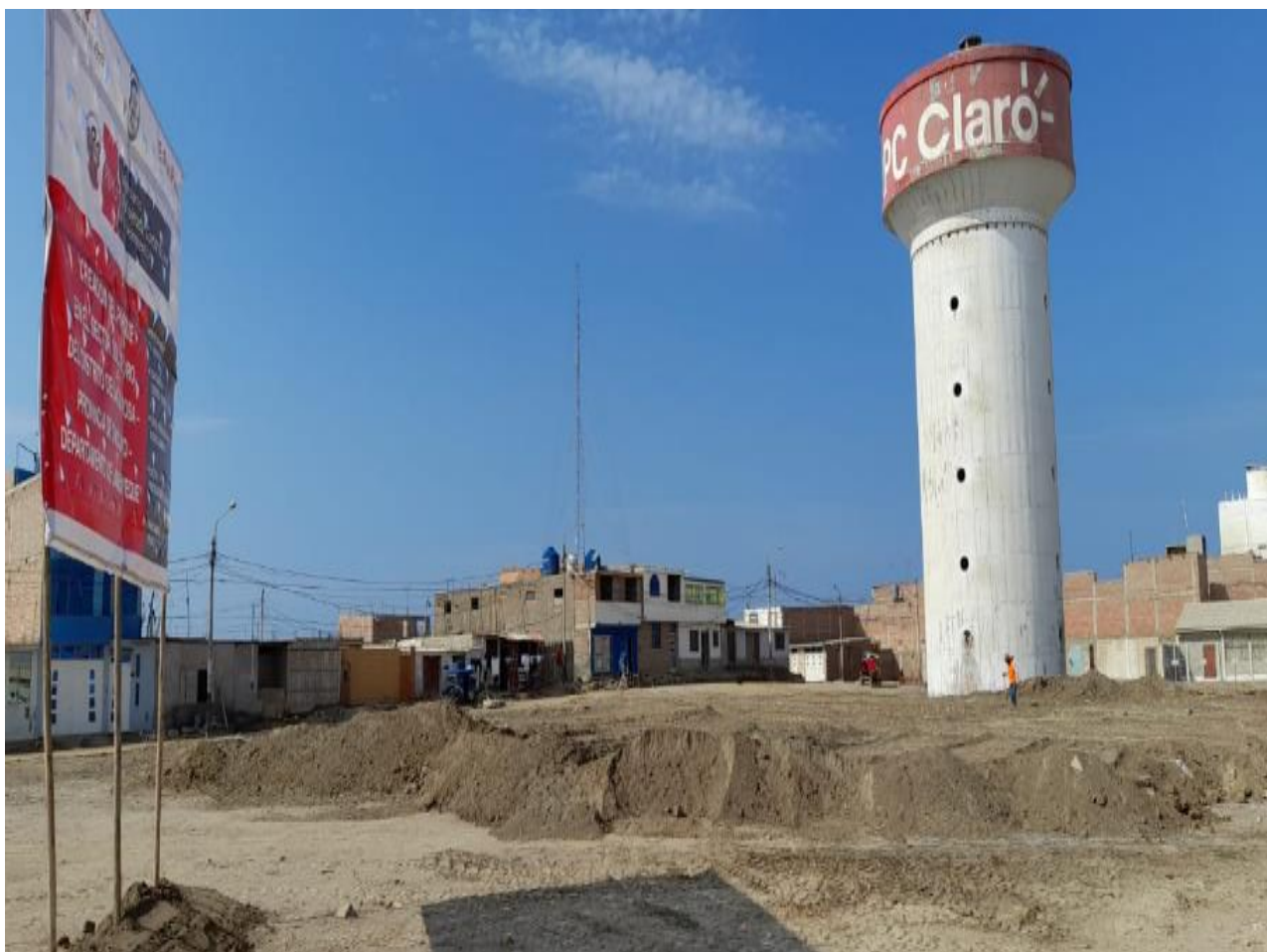
FOTO N° 01: SE OBSERVA EL CARTEL DE IDENTIFICACION DE LA OBRA DE 4.80 X 3.60 m.
