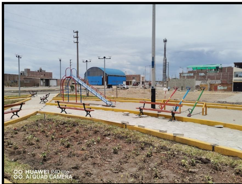
Foto N° 15: Verificación de la instalación de juegos infantiles
