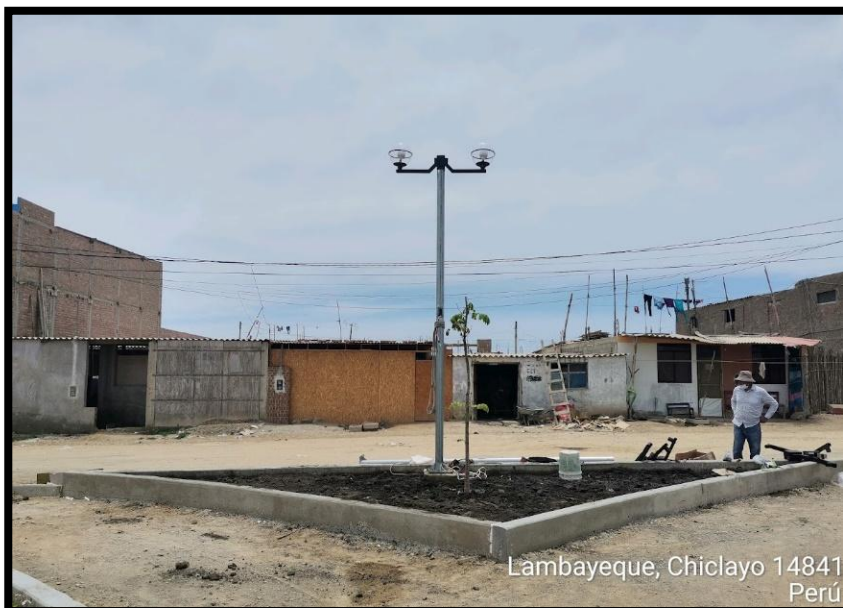
Foto N° 13: Verificación de la colocación de poste de F°G°
