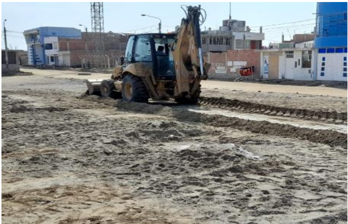
FOTO N° 03: SE OBSERVA EL CORTE DE TERRENO A NIVEL DE SUBRASANTE.
