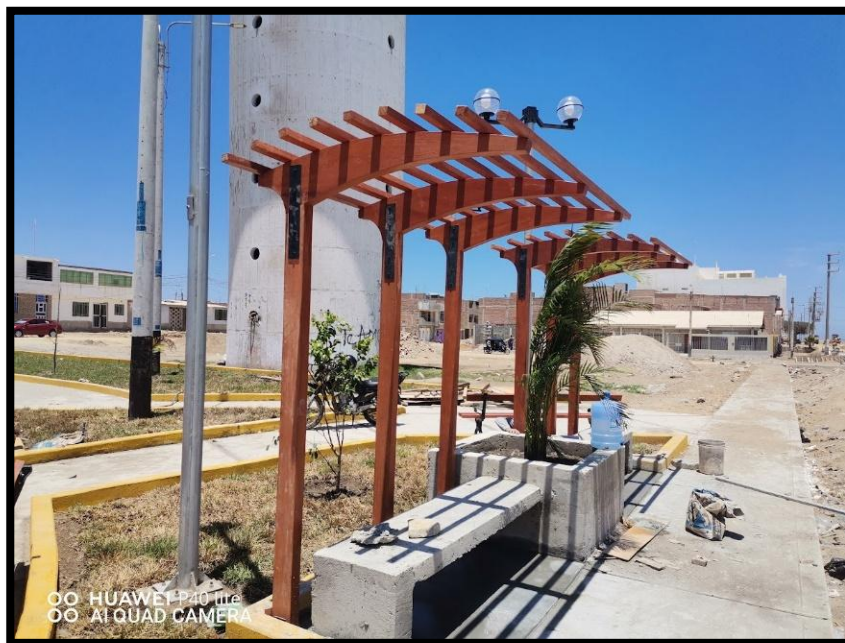
Foto N° 17: Verificación de las pérgolas de material tornillo
