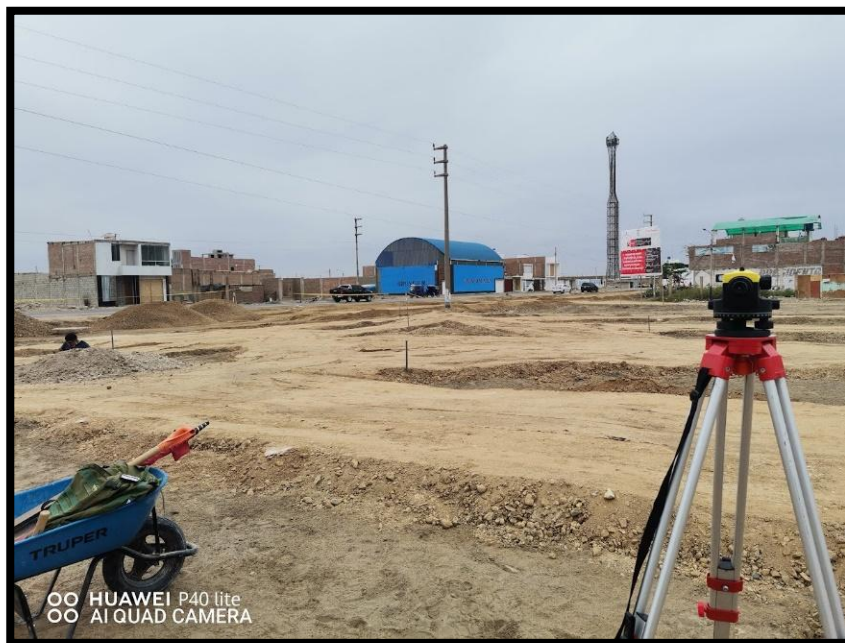
Foto N° 01: Se observa en la foto, los trabajos de levantamiento topográfico.
