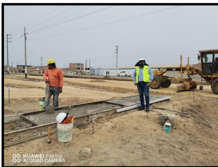
Foto N° 08: Verificación de vaciado de concreto y vibrado para veredas
