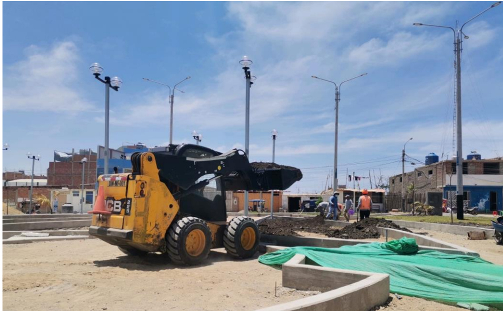
FOTO N° 03: COLOCACION DE TIERRA DE CHACRA EN LAS JARDINERAS
