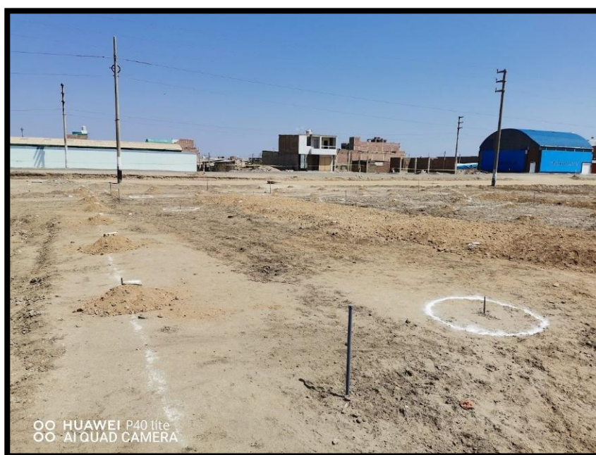
Foto N° 02: Se verifica la realización de los niveles en campo
