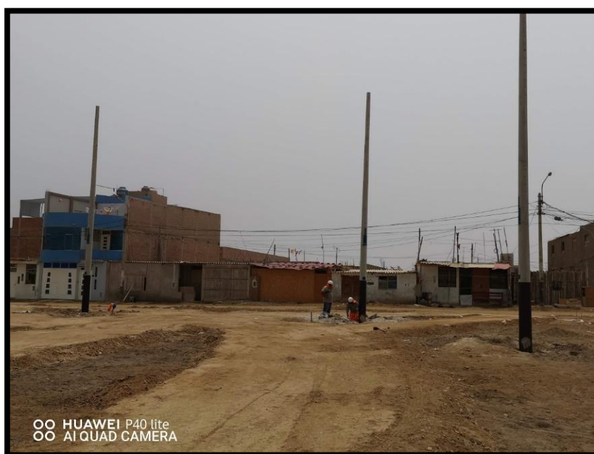
Foto N° 04: Suministro e instalación de postes de C°A°
