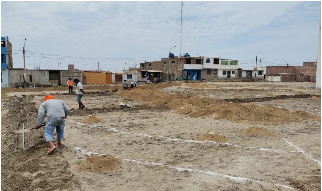
FOTO N° 02: SE OBSERVA COLOCACION DE TUBERIA DE AGUA Y RELLENO CON MATERIAL PROPIO.
