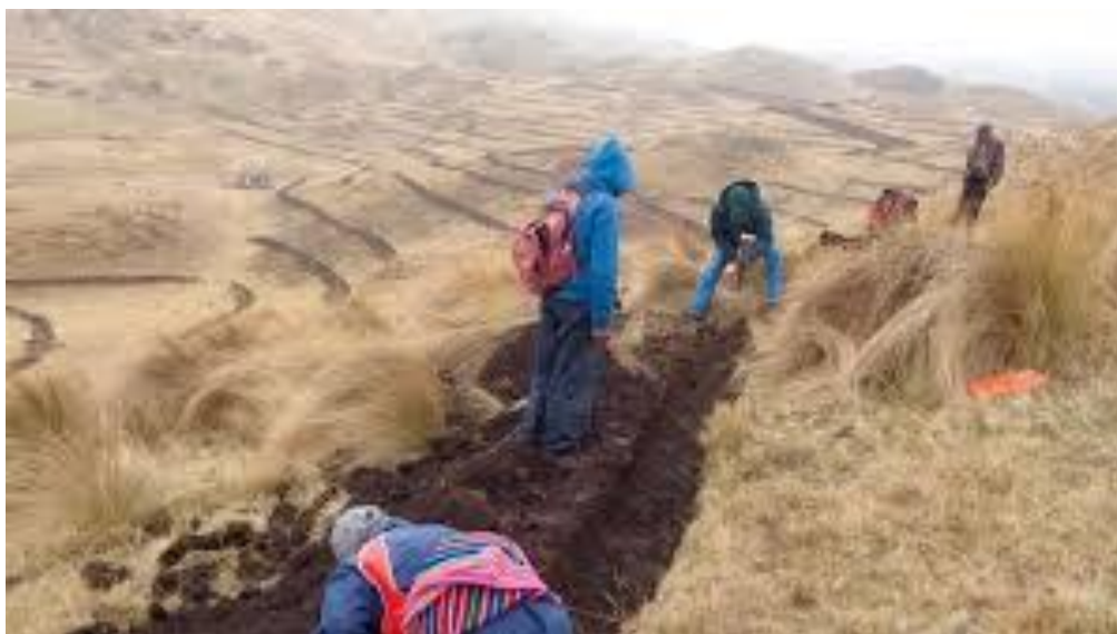
Figura 5: Construcción de zanja de infiltración
