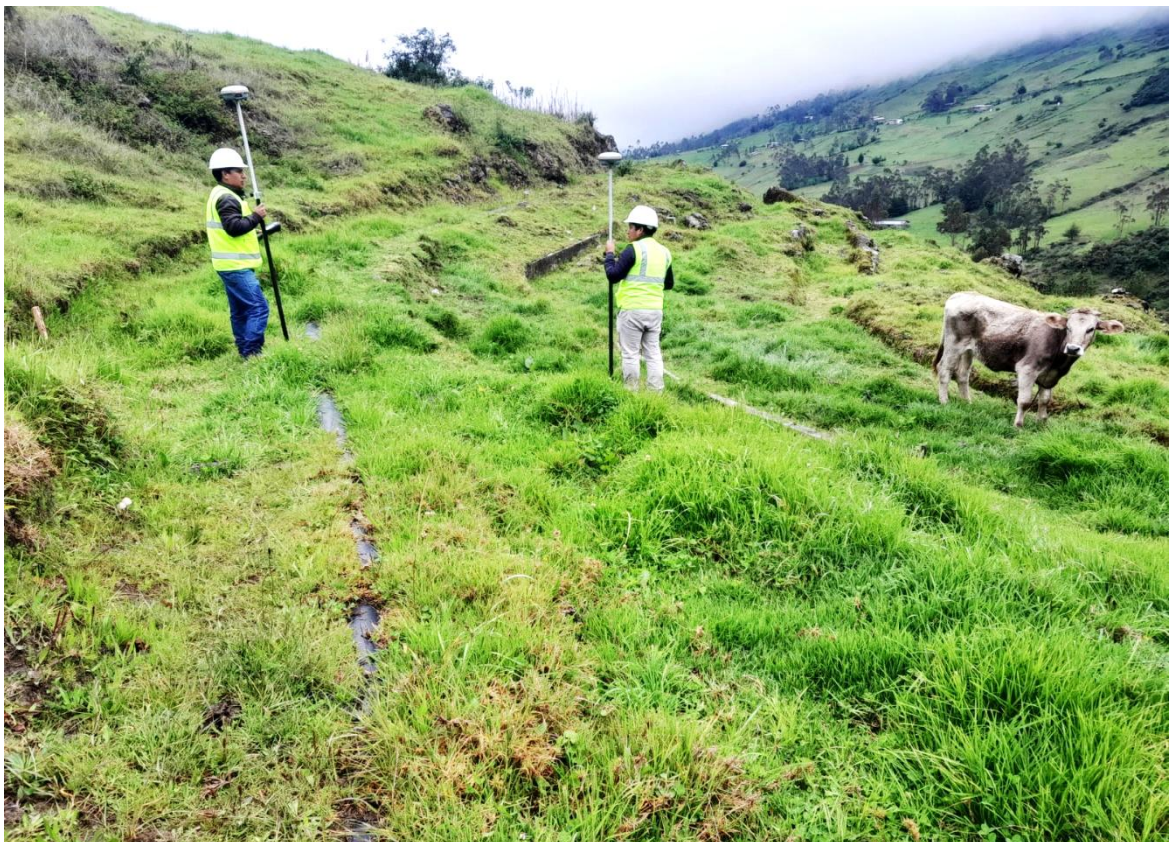
Iniciando el trabajo topográfico de la línea de conducción a las parcelas – El Tambo
