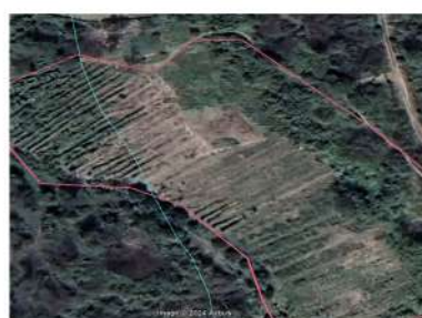
Canal de JUO pasando por el área irrigada
