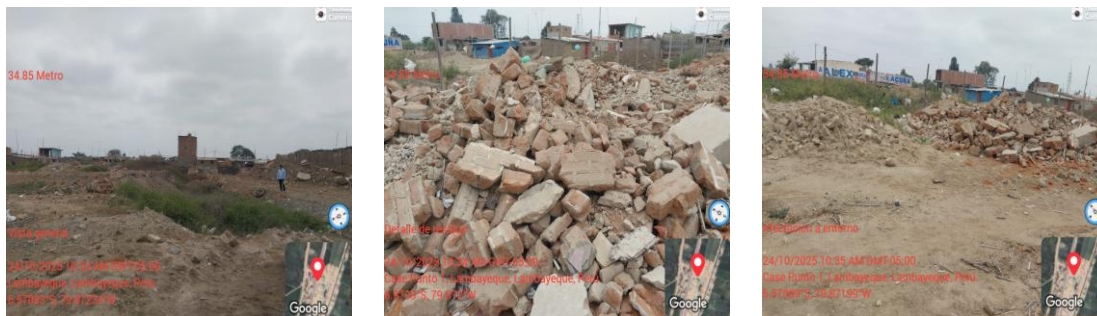
Fotografía 3. a) Vista general. b) Detalle de residuo. c) Afectación al entorno.
