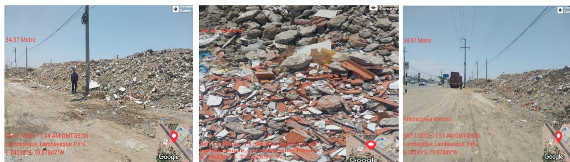
Fotografía 23. a) Vista general. b) Detalle de residuo. c) Afectación al entorno.
