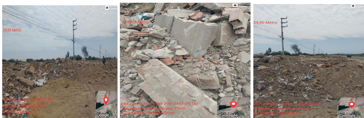
Fotografía 24. a) Vista general. b) Detalle de residuo. c) Afectación al entorno
