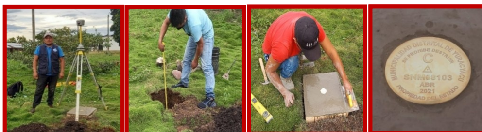
Imagen 15: Instalación de la losa de concreto con la placa del punto SNM08103.
