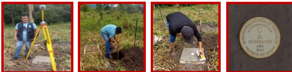
Imagen 14: Vistas fotográficas que se muestra la instalación de la losa de concreto con la placa del punto SNM08102.
