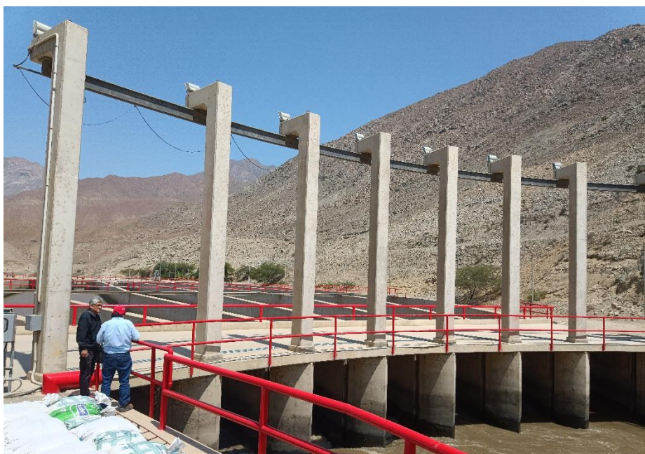
FOTOGRAFÍA 2: VISTA COMPUERTAS DE INGRESO AL DESARENADOR Y LAS NAVES DE ESTA ESTRUCTURA
