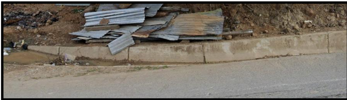
Item N° 5: Cuneta Km 10+194 – 13+020
