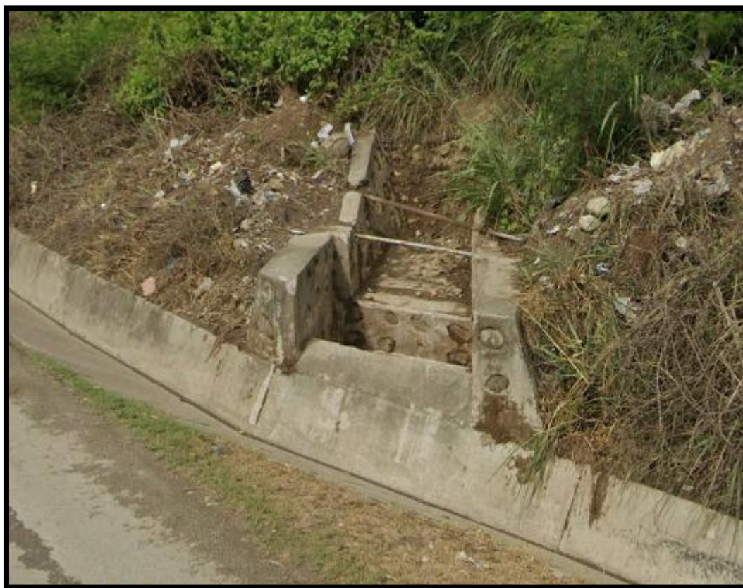
Item N° 9: Caída Km 13+439
