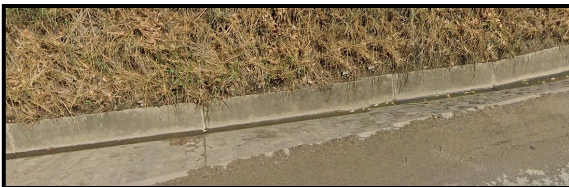
Item N° 10: Cuneta Km 13+625 – 14+026
