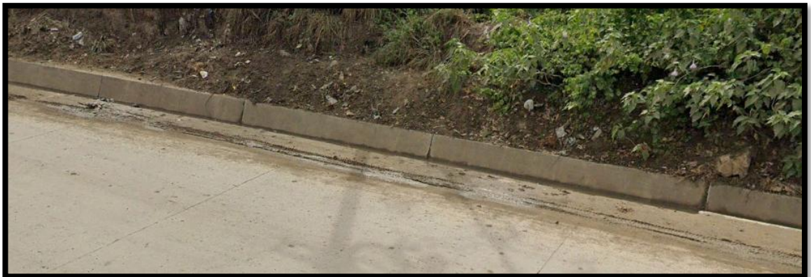
Item N° 12: Cuneta Km 14+806 – 15+000
