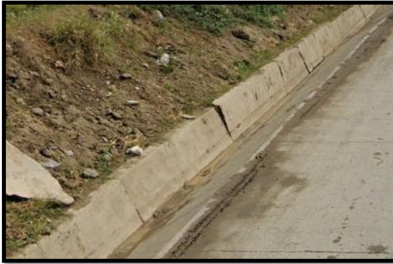
Item N° 11: Cuneta Km 14+731 – 15+000
