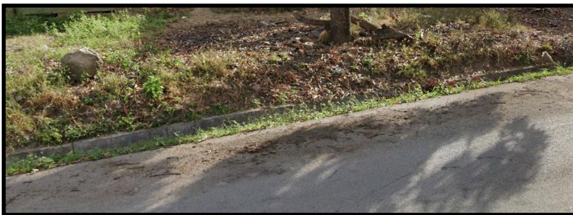
Item N° 1: Cuneta Km 8+190 – Km 8+274
