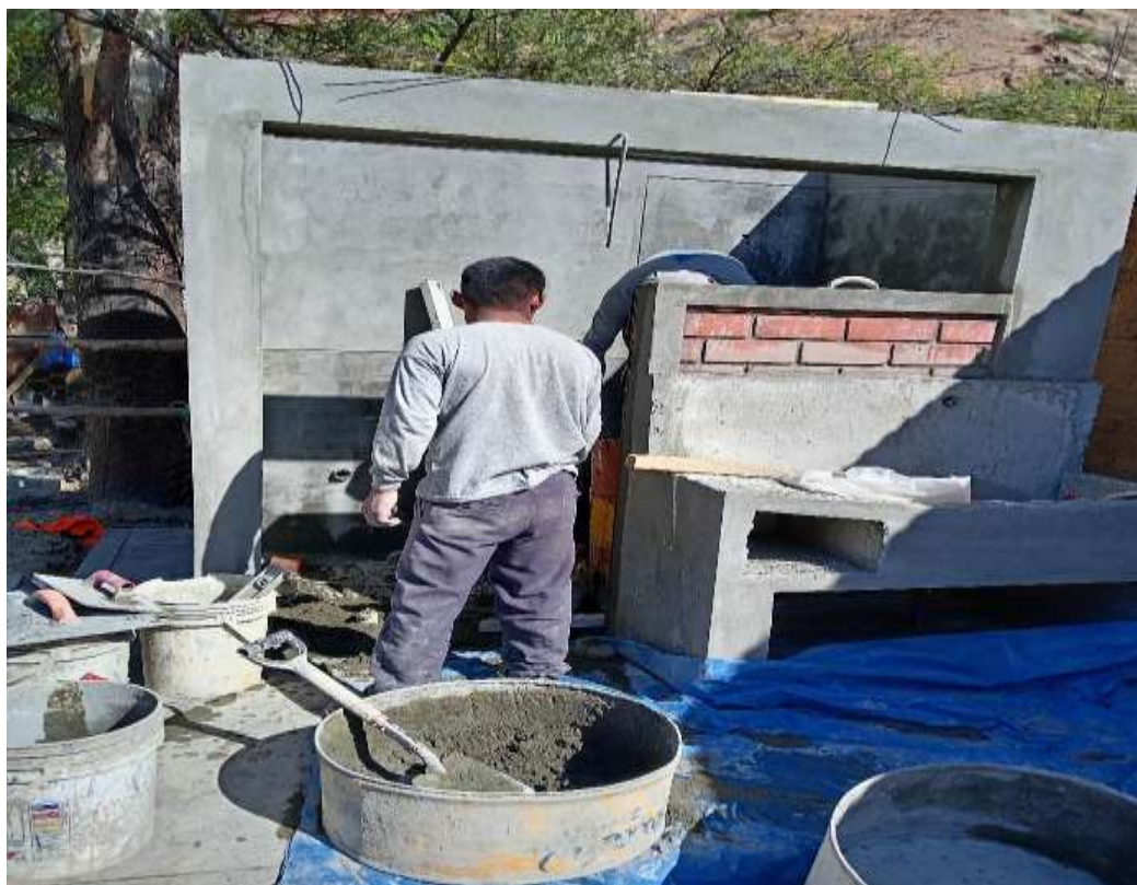
Supervisión de la ejecución de las obras de las Unidades Básicas de Saneamiento. (Personal obrero trabajando)
