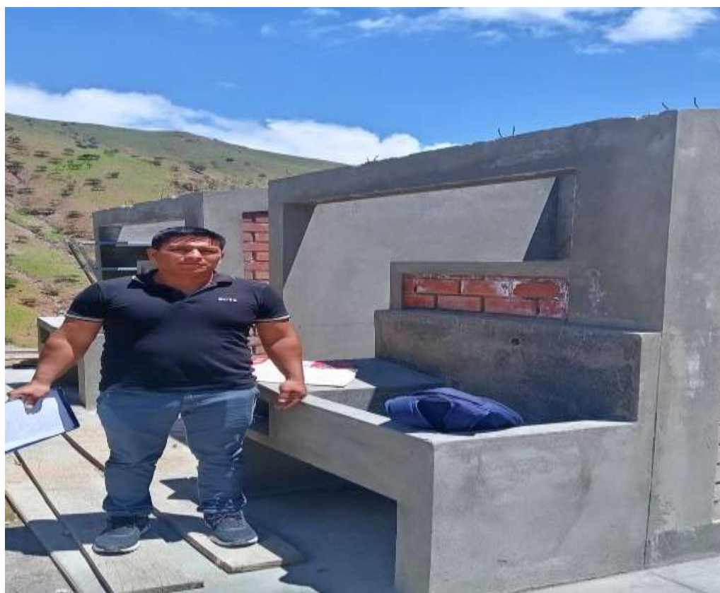
Visita a campo para supervisar el avance en la construcción de las unidades básicas de saneamiento.
