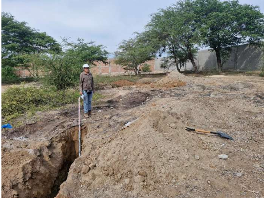
Fotografía 01: Vista de material extraído de calicata. Visualizándose el contenido de grava, color de la muestra beige, compactidad medianamente densa y contenido de humedad natural.
