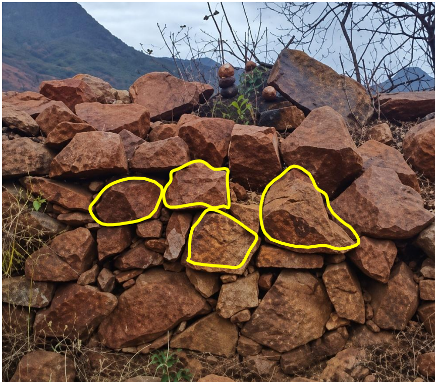
Figura 38. Material de la muralla de restricción en el sector sur.
