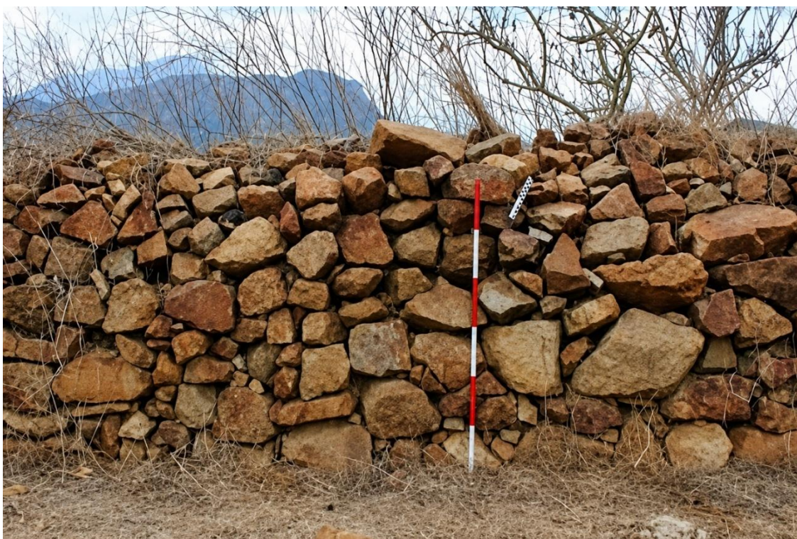
Figura 88. Vista frontal de la muralla de restricción en el Sector sur.
