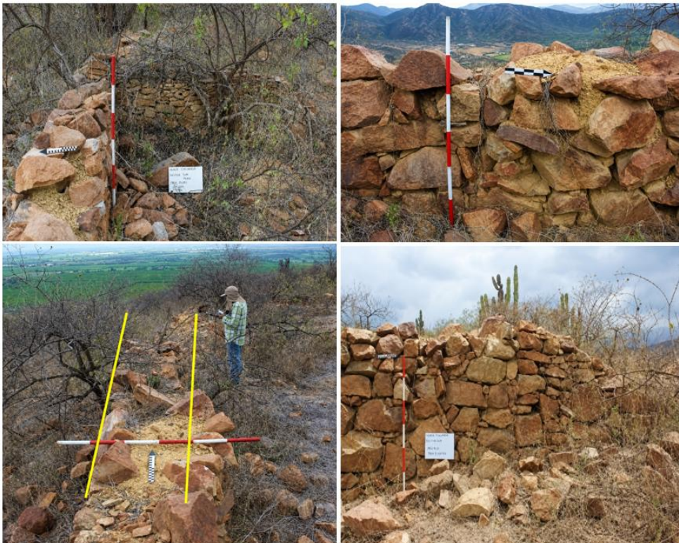
Figura 47. Material y técnica empleada en la estructura arquitectónica 9.
