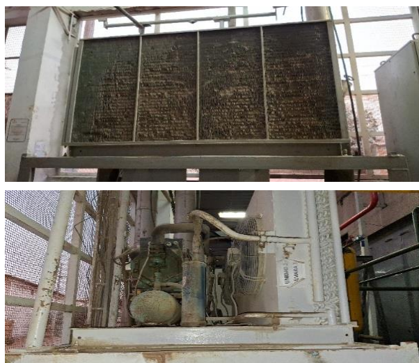
Figura 7. Unidad 1 de la Cámara 3.
