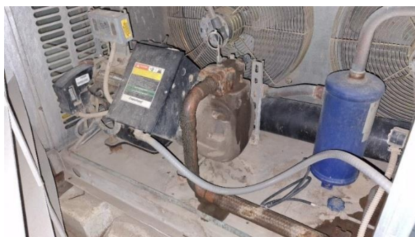
Figura 9. Unidad 3 de la Cámara 3.
