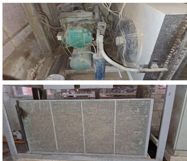
Figura 8. Unidad 2 de la Cámara 3.
