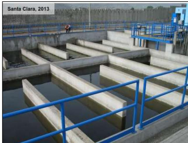
**Figura VIII-23:** Cámara de contacto de cloro
