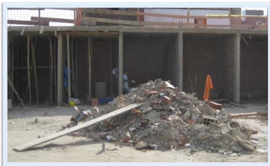
*Figura 2.* Residuos de obras de construcción. Elaboración propia.
